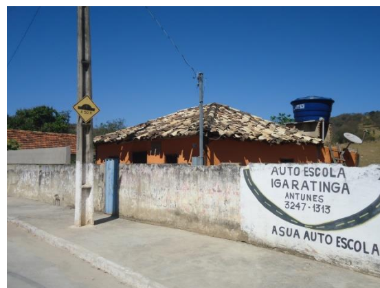
Pará de Minas Núcleo Histórico Urbano do Distrito de Carioca Praça Nossa Senhora de Lourdes, 99 (foto 54) Imagem: Álisson Margotti – 25/08/2016
