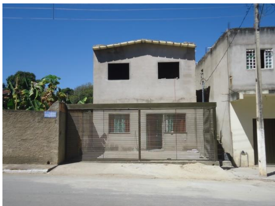
Pará de Minas Núcleo Histórico Urbano do Distrito de Carioca Praça Nossa Senhora de Lourdes, 120 (foto 55) Imagem: Álisson Margotti – 25/08/2016
