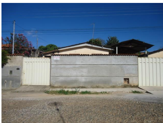
Pará de Minas Núcleo Histórico Urbano do Distrito de Ascensão Edificação à Avenida Presidente Kubitschek, 072. (foto 63)
