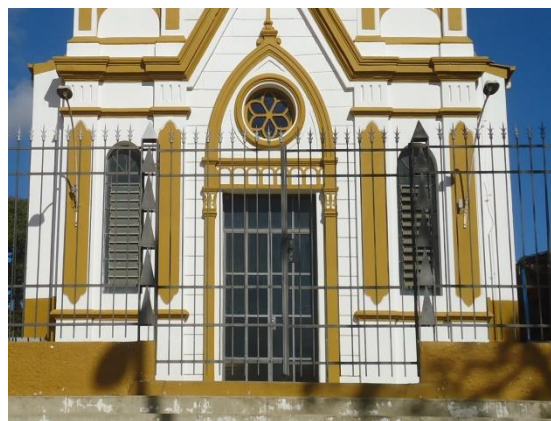
Pará de Minas Núcleo Histórico Urbano do Distrito de Ascensão Detalhes do pórtico e dos altos e baixos relevos, bem conservados. (foto 46)
