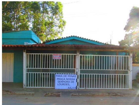
Pará de Minas Núcleo Histórico Urbano do Distrito de Carioca Praça Nossa Senhora de Lourdes, 03 (foto 44) Imagem: Álisson Margotti – 25/08/2016
