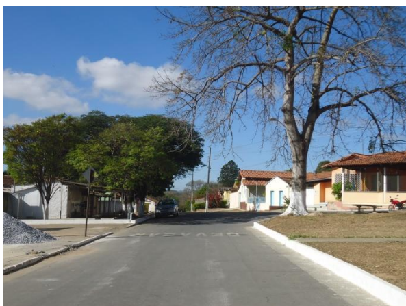
Pará de Minas Núcleo Histórico Urbano do Distrito de Ascensão Trecho da via Praça Santo Antônio em bom estado de conservação, exibe apenas fissuras no asfalto. (Foto 02)
