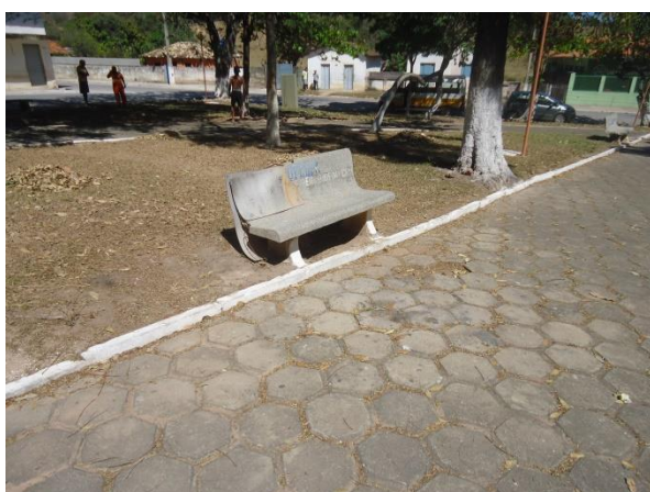
Núcleo Histórico Urbano do Distrito de Carioca Banco em concreto exibindo remendo em compensado em seu encosto com considerável perda de matéria.
