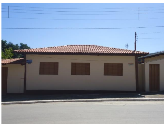
Pará de Minas Núcleo Histórico Urbano do Distrito de Carioca Praça Nossa Senhora de Lourdes, 75 (foto 51) Imagem: Álisson Margotti – 25/08/2016
