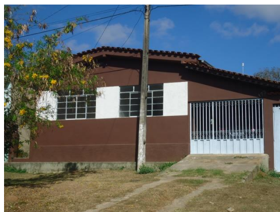
Pará de Minas Núcleo Histórico Urbano do Distrito de Ascensão Edificação à Rua Raimundo Penaforte de Araújo, 173. (foto 102)
