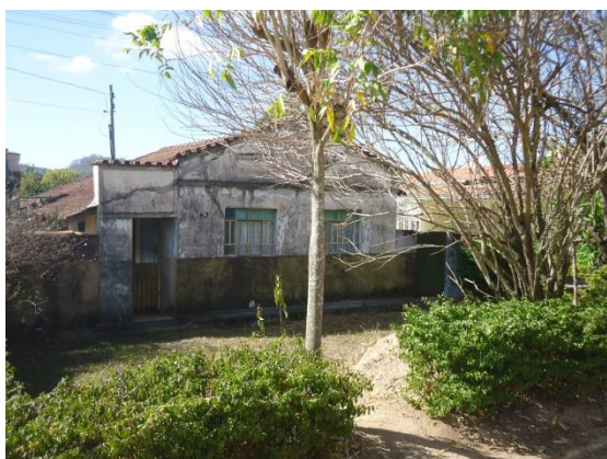
Pará de Minas Núcleo Histórico Urbano do Distrito de Ascensão Edificação à Rua Raimundo Penaforte de Araújo, 074. (foto 95)
