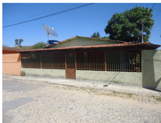
Pará de Minas Núcleo Histórico Urbano do Distrito de Carioca Rua Nossa Senhora da Piedade, 55 (foto 76) Imagem: Álisson Margotti – 25/08/2016
