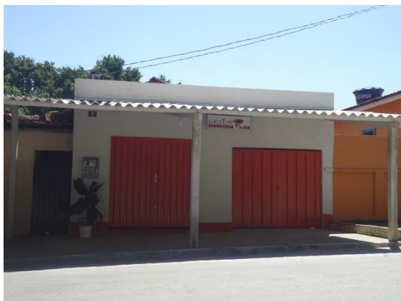
Pará de Minas Núcleo Histórico Urbano do Distrito de Carioca Praça Nossa Senhora de Lourdes, 41 (foto 49) Imagem: Álisson Margotti – 25/08/2016
