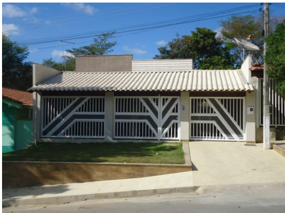
Pará de Minas Núcleo Histórico Urbano do Distrito de Ascensão Edificação à Avenida Abdon Senem de Araújo, 048. (foto 49)
