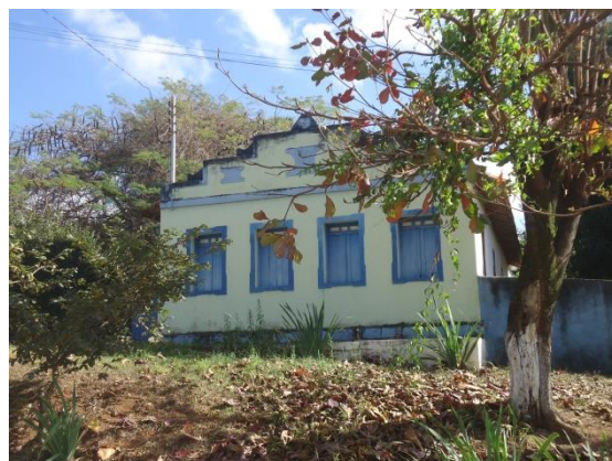
Pará de Minas Núcleo Histórico Urbano do Distrito de Ascensão Edificação à Avenida Abdon Senem de Araújo, 087. (foto 52)
