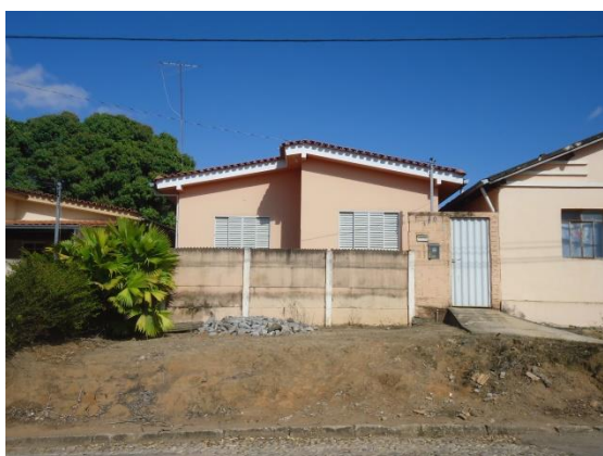
Pará de Minas Núcleo Histórico Urbano do Distrito de Ascensão Edificação à Avenida Presidente Kubitschek, 180. (foto 69)
