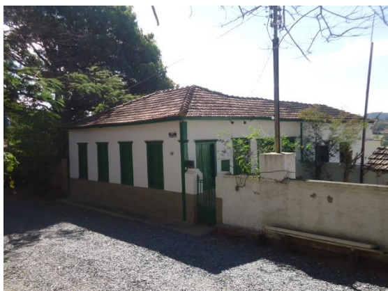
Pará de Minas Núcleo Histórico Urbano do Distrito de Ascensão Edificação à Avenida Presidente Kubitschek, 321. (foto 75)
