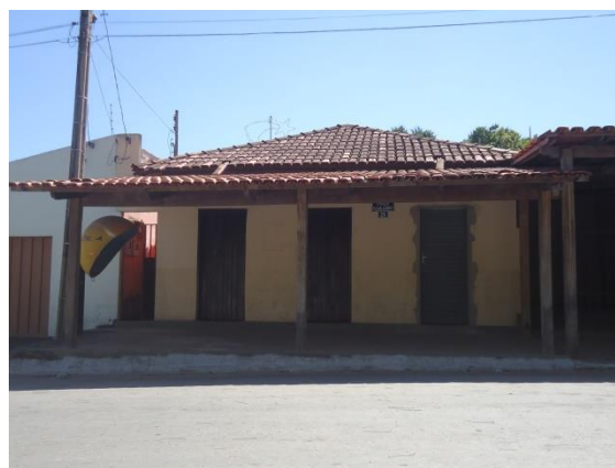
Pará de Minas Núcleo Histórico Urbano do Distrito de Carioca Praça Nossa Senhora de Lourdes, 29 (foto 48) Imagem: Álisson Margotti – 25/08/2016
