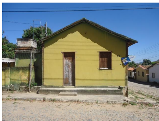
Pará de Minas Núcleo Histórico Urbano do Distrito de Carioca Rua Nossa Senhora da Piedade, 79 (foto 78) Imagem: Álisson Margotti – 25/08/2016
