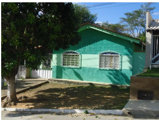
Pará de Minas Núcleo Histórico Urbano do Distrito de Ascensão Edificação à Avenida Abdon Senem de Araújo, 066. (foto 51)
