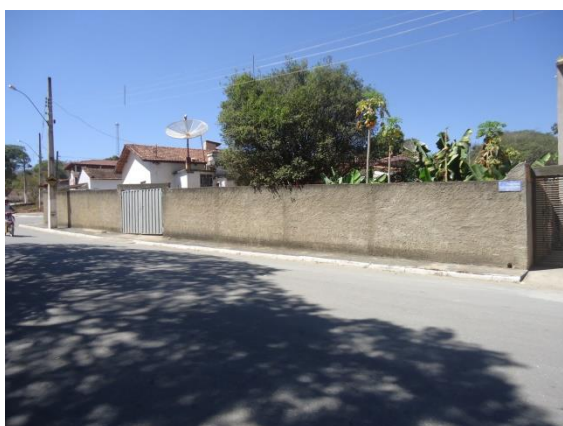
Pará de Minas Núcleo Histórico Urbano do Distrito de Carioca Praça Nossa Senhora de Lourdes, 08 (foto 45) Imagem: Álisson Margotti – 25/08/2016
