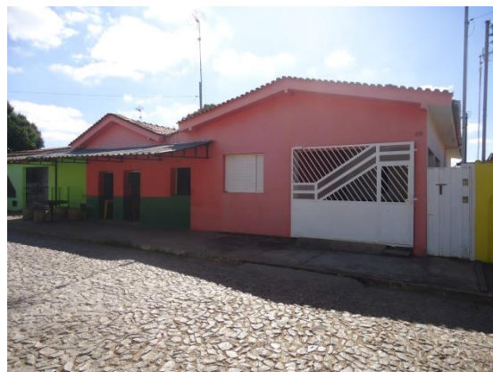
Pará de Minas Núcleo Histórico Urbano do Distrito de Ascensão Edificação à Avenida Presidente Kubitschek, 069. (foto 62)
