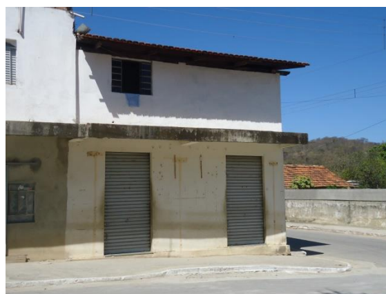
Pará de Minas Núcleo Histórico Urbano do Distrito de Carioca Praça Nossa Senhora de Lourdes, 15 (foto 46) Imagem: Álisson Margotti – 25/08/2016
