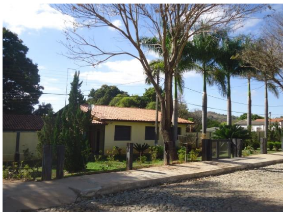
Pará de Minas Núcleo Histórico Urbano do Distrito de Ascensão Edificação à Rua Raimundo Penaforte, de Araújo, 182. (foto 103)
