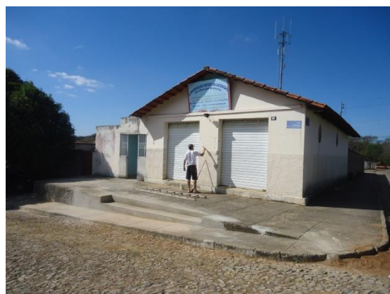
Pará de Minas Núcleo Histórico Urbano do Distrito de Ascensão Edificação à Pompéu, 049. (foto 90)
