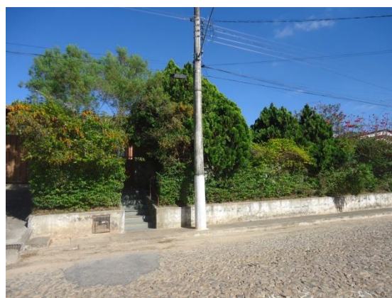
Pará de Minas Núcleo Histórico Urbano do Distrito de Ascensão Edificação à Avenida Presidente Kubitschek, 086. (foto 64)
