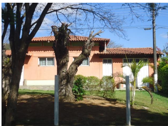
Pará de Minas Núcleo Histórico Urbano do Distrito de Ascensão Edificação à Rua Raimundo Penaforte de Araújo, 231. (foto 107)
