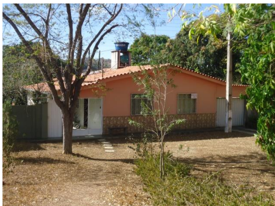
Pará de Minas Núcleo Histórico Urbano do Distrito de Ascensão Edificação à Rua Raimundo Penaforte, de Araújo, 020. (foto 91)
