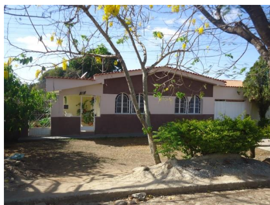
Pará de Minas Núcleo Histórico Urbano do Distrito de Ascensão Edificação à Rua Raimundo Penaforte, de Araújo, 060. (foto 94)
