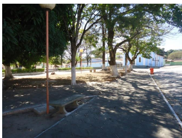
Pará de Minas Núcleo Histórico Urbano do Distrito de Carioca Bancos em concreto exibindo bom estado de conservação.
