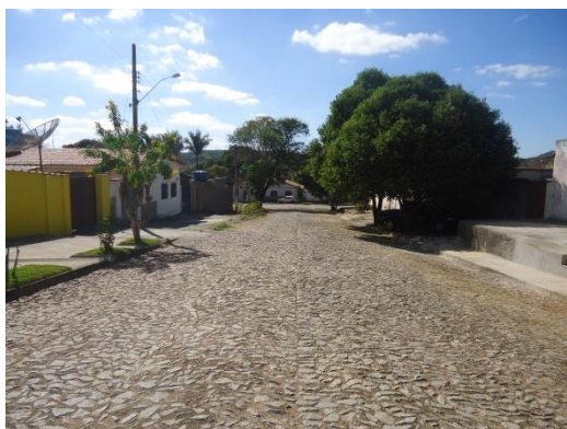
Pará de Minas Núcleo Histórico Urbano do Distrito de Ascensão Trecho da Rua Pompéu apresentando pé de moleque em bom estado de conservação.
