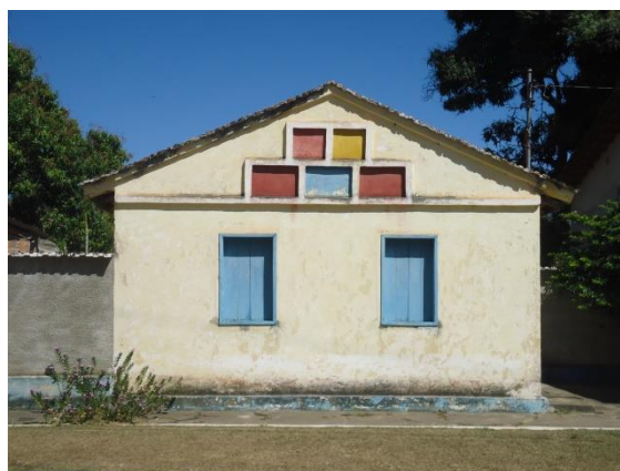
Pará de Minas Núcleo Histórico Urbano do Distrito de Carioca Rua São Francisco, SN (foto 89) Imagem: Álisson Margotti – 25/08/2016
