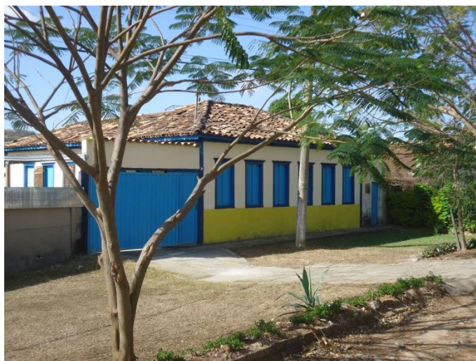
Pará de Minas Núcleo Histórico Urbano do Distrito de Ascensão Edificação neocolonial da Rua Raimundo Penaforte de Araújo. (Foto 01)
