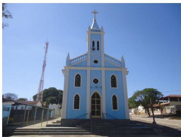
Pará de Minas Núcleo Histórico Urbano do Distrito de Carioca Vista da fachada frontal da Igreja de Nossa Senhora Lourdes, bem conservada.
