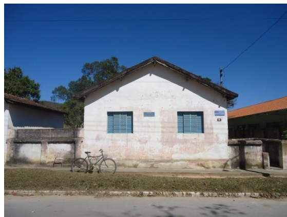
Pará de Minas Núcleo Histórico Urbano do Distrito de Carioca Praça Nossa Senhora de Lourdes, 66 (foto 50) Imagem: Álisson Margotti – 25/08/2016
