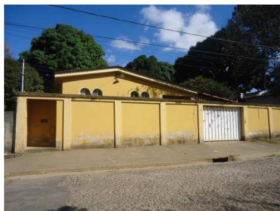
Pará de Minas Núcleo Histórico Urbano do Distrito de Ascensão Edificação à Avenida Presidente Kubitschek, 230. (foto 72)
