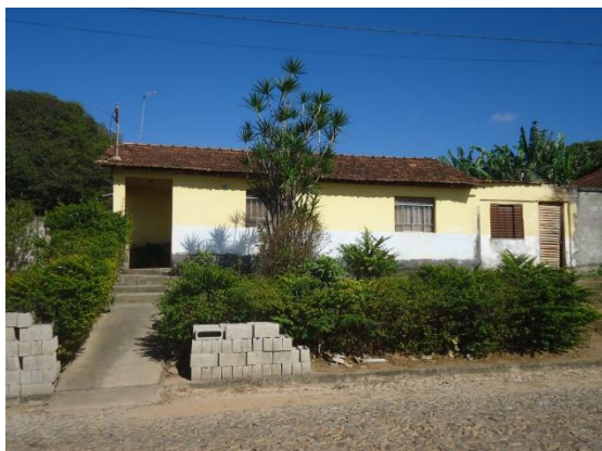
Pará de Minas Núcleo Histórico Urbano do Distrito de Ascensão Edificação à Avenida Presidente Kubitschek, 126. (foto 67)
