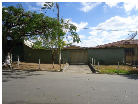
Pará de Minas Núcleo Histórico Urbano do Distrito de Ascensão Edificação à Avenida Abdon Senem de Araújo, 116. (foto 54)
