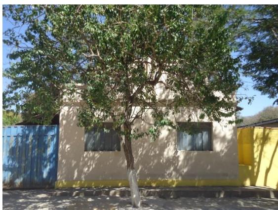
Pará de Minas Núcleo Histórico Urbano do Distrito de Carioca Praça Nossa Senhora de Lourdes, 18 (foto 47) Imagem: Álisson Margotti – 25/08/2016
