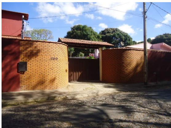
Pará de Minas Núcleo Histórico Urbano do Distrito de Ascensão Edificação à Avenida Presidente Kubitschek, 300. (foto 73)
