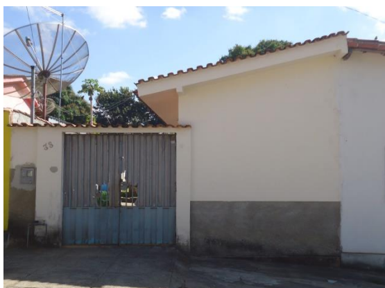
Pará de Minas Núcleo Histórico Urbano do Distrito de Ascensão Edificação à Pompéu, 038. (foto 89)
