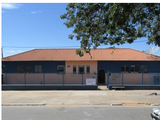
Pará de Minas Núcleo Histórico Urbano do Distrito de Ascensão Edificação à Praça Santo Antônio, 052. (foto 81) Imagem: Álisson Margotti – 25/08/2016
