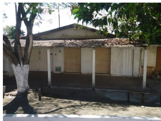
Pará de Minas Núcleo Histórico Urbano do Distrito de Ascensão Edificação à Avenida Presidente Kubitschek, 007 (foto 59)
