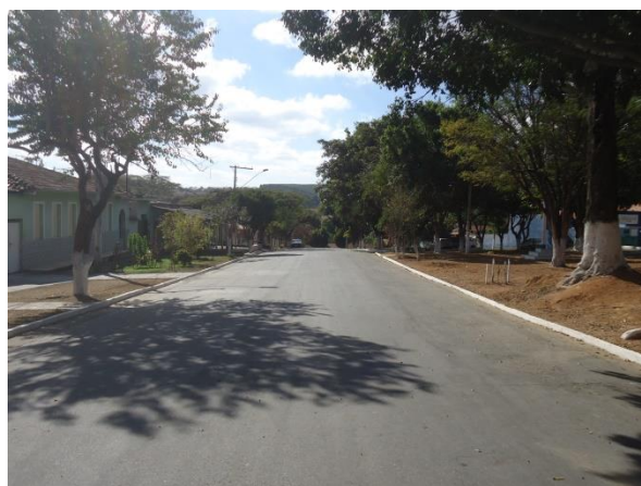
Pará de Minas Núcleo Histórico Urbano do Distrito de Ascensão Trecho da Rua Abdon Senem de Araújo exibe bom estado de conservação. (Foto 03)
