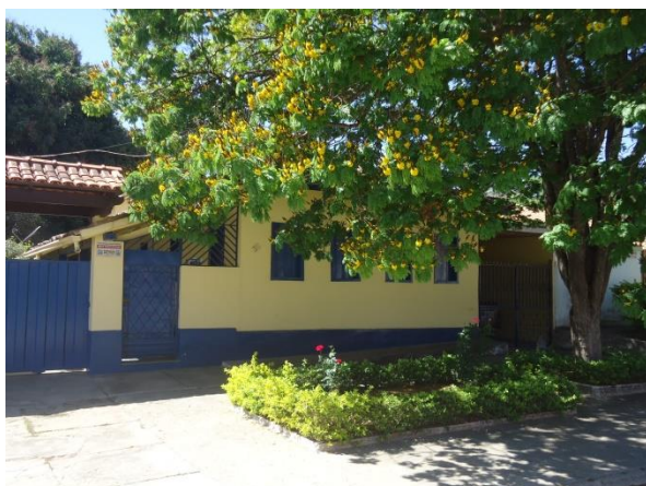
Pará de Minas Núcleo Histórico Urbano do Distrito de Carioca Residência à Rua São Francisco em estilo neocolonial. (foto 33)
