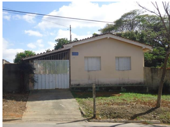
Pará de Minas Núcleo Histórico Urbano do Distrito de Ascensão Edificação à Avenida Abdon Senem de Araújo, 049. (foto 50)
