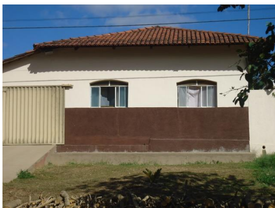
Pará de Minas Núcleo Histórico Urbano do Distrito de Ascensão Edificação à Rua Raimundo Penaforte de Araújo, 161. (foto 101)
