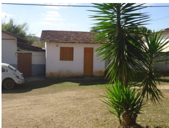
Pará de Minas Núcleo Histórico Urbano do Distrito de Ascensão Edificação à Rua Raimundo Penaforte, de Araújo, 134. (foto 99)
