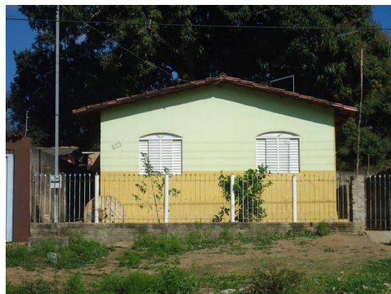
Pará de Minas Núcleo Histórico Urbano do Distrito de Ascensão Edificação à Rua Raimundo Penaforte, de Araújo, 195. (foto 104)
