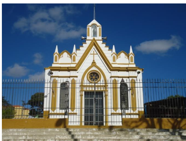
Pará de Minas Núcleo Histórico Urbano do Distrito de Ascensão Vista frontal da Igreja de Santo Antônio, bem conservada.
