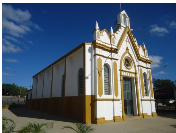
Pará de Minas Núcleo Histórico Urbano do Distrito de Ascensão Vista da fachada lateral direita da Igreja, exibe bom estado de conservação.
