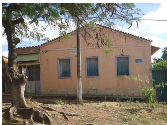
Pará de Minas Núcleo Histórico Urbano do Distrito de Ascensão Edificação à Avenida Abdon Senem de Araújo, 039. (foto 47)
