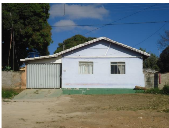
Pará de Minas Núcleo Histórico Urbano do Distrito de Ascensão Edificação à Rua Raimundo Penaforte, de Araújo, 203. (foto 105)
