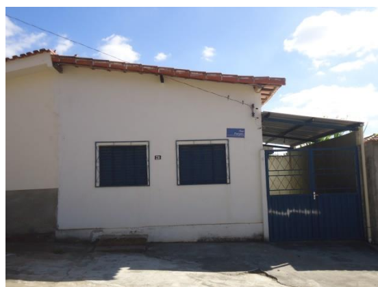
Pará de Minas Núcleo Histórico Urbano do Distrito de Ascensão Edificação à Rua Pompéu, 028 . (foto 88)
