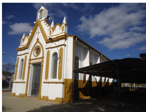
Pará de Minas Núcleo Histórico Urbano do Distrito de Ascensão Vista da fachada lateral esquerda da Igreja de Santo Antônio, bem conservada.
