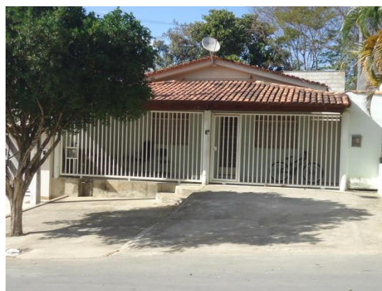
Pará de Minas Núcleo Histórico Urbano do Distrito de Ascensão Edificação à Avenida Abdon Senem de Araújo, 040. (foto 48)
