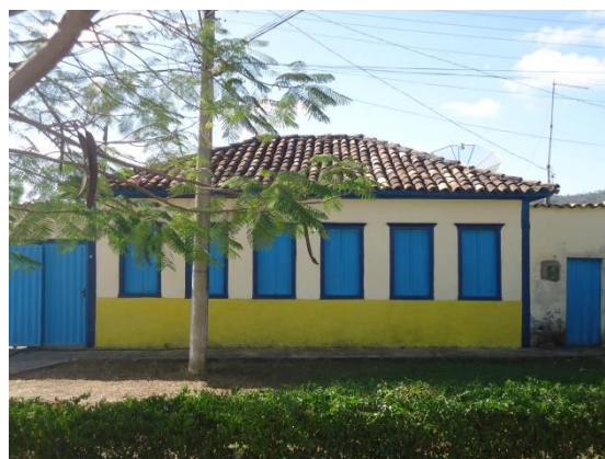
Pará de Minas Núcleo Histórico Urbano do Distrito de Ascensão Edificação à Rua Raimundo Penaforte de Araújo, 090. (foto 96)
