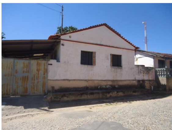
Pará de Minas Núcleo Histórico Urbano do Distrito de Carioca Rua Nossa Senhora da Piedade, 48 (foto 75) Imagem: Álisson Margotti – 25/08/2016
