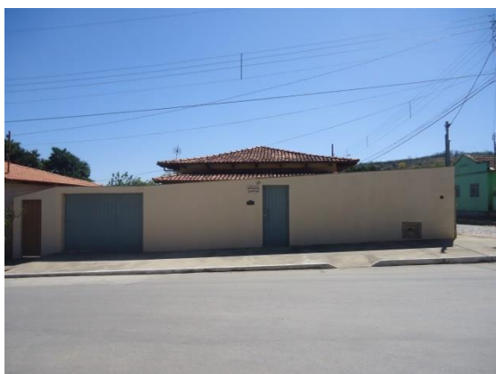
Pará de Minas Núcleo Histórico Urbano do Distrito de Carioca Praça Nossa Senhora de Lourdes, 81 (foto 53) Imagem: Álisson Margotti – 25/08/2016
