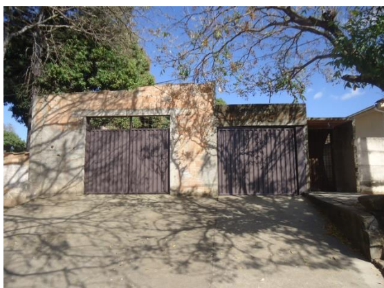
Pará de Minas Núcleo Histórico Urbano do Distrito de Ascensão Edificação à Avenida Presidente Kubitschek, 210. (foto 71)
