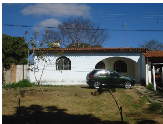
Pará de Minas Núcleo Histórico Urbano do Distrito de Ascensão Edificação à Rua Raimundo Penaforte, de Araújo, 205. (foto 106)
