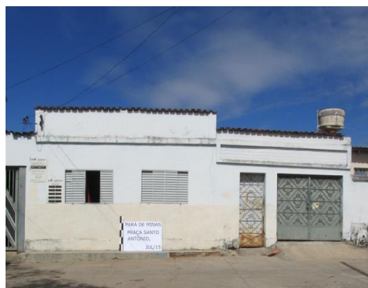
Pará de Minas Núcleo Histórico Urbano do Distrito de Ascensão Edificação à Praça Santo Antônio, 039. (foto 80) Imagem: Álisson Margotti – 25/08/2016
