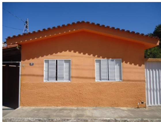
Pará de Minas Núcleo Histórico Urbano do Distrito de Carioca Rua Nossa Senhora da Piedade, 39 (foto 74) Imagem: Álisson Margotti – 25/08/2016
