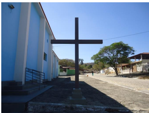
Pará de Minas Núcleo Histórico Urbano do Distrito de Carioca Rampas para acessibilidade para a entrada na lateral direita da Igreja de Nossa Senhora de Lourdes. (foto 19)
