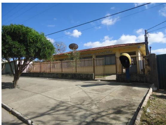
Pará de Minas Núcleo Histórico Urbano do Distrito de Ascensão Edificação à Avenida Abdon Senem de Araújo, 100. (foto 53)
