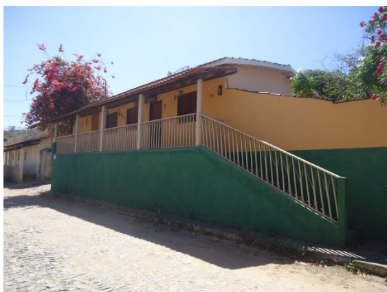
Pará de Minas Núcleo Histórico Urbano do Distrito de Carioca Rua Nossa Senhora da Piedade, 78 (foto 77) Imagem: Álisson Margotti – 25/08/2016
