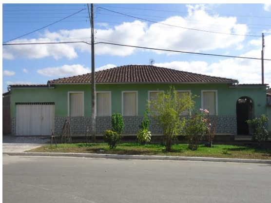
Pará de Minas Núcleo Histórico Urbano do Distrito de Ascensão Edificação à Avenida Abdon Senem de Araújo, 130. (foto 55)
