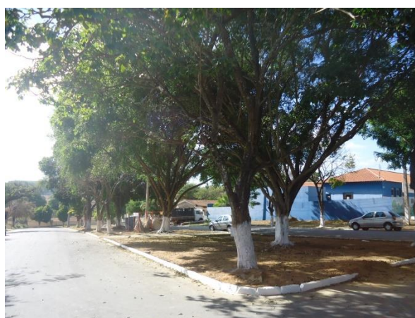
Pará de Minas Núcleo Histórico Urbano do Distrito de Ascensão Na Praça Santo Antônio são verificadas sarjetas rasas e com acúmulo de sujidades.
