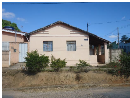
Pará de Minas Núcleo Histórico Urbano do Distrito de Ascensão Edificação à Avenida Presidente Kubitschek, 160. (foto 68)
