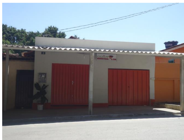
Pará de Minas Núcleo Histórico Urbano do Distrito de Carioca Sorveteria que também utiliza a calçada para dispor suas mesas e cadeiras, no horário a mesma estava fechada. (foto 30)
