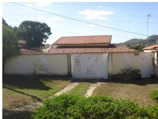
Pará de Minas Núcleo Histórico Urbano do Distrito de Ascensão Edificação à Rua Raimundo Penaforte, de Araújo, 040. (foto 92)
