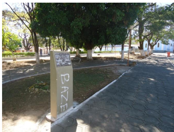
Pará de Minas Núcleo Histórico Urbano do Distrito de Carioca Piso em concreto revestindo os caminhos e calçadas com textura assemelhando-se ao intertravado na Pç N. Sra. de Lourdes. (foto 95)
