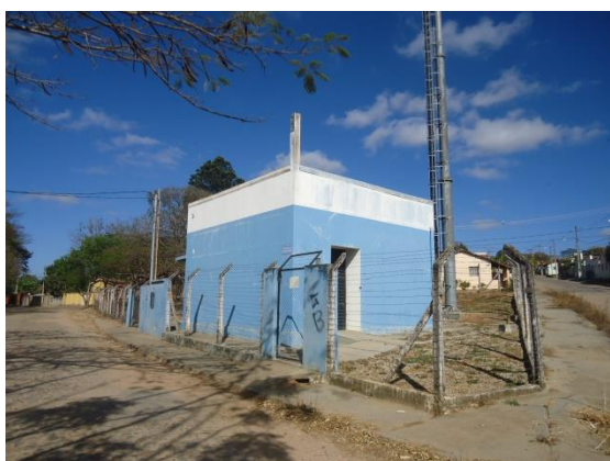
Pará de Minas Núcleo Histórico Urbano do Distrito de Ascensão Edificação à Rua Raimundo Penaforte, de Araújo, 045. (foto 93)
