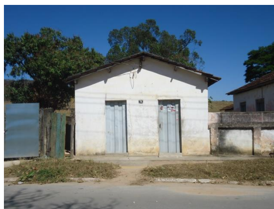
Pará de Minas Núcleo Histórico Urbano do Distrito de Carioca Praça Nossa Senhora de Lourdes, 76 (foto 52) Imagem: Álisson Margotti – 25/08/2016
