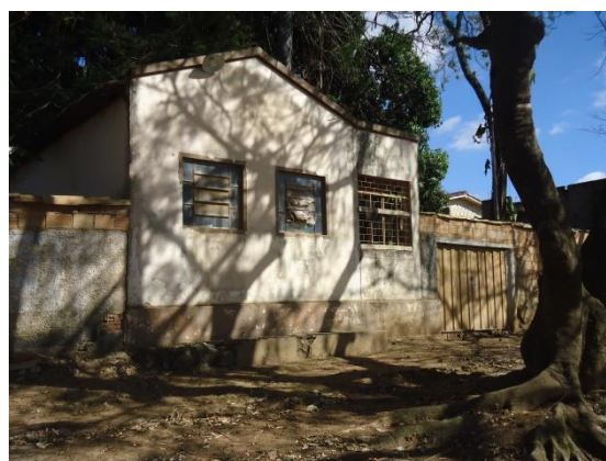
Pará de Minas Núcleo Histórico Urbano do Distrito de Ascensão Edificação à Avenida Presidente Kubitschek, 190. (foto 70)
