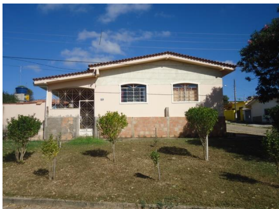
Pará de Minas Núcleo Histórico Urbano do Distrito de Ascensão Edificação à Rua Raimundo Penaforte, de Araújo, 121. (foto 97)
