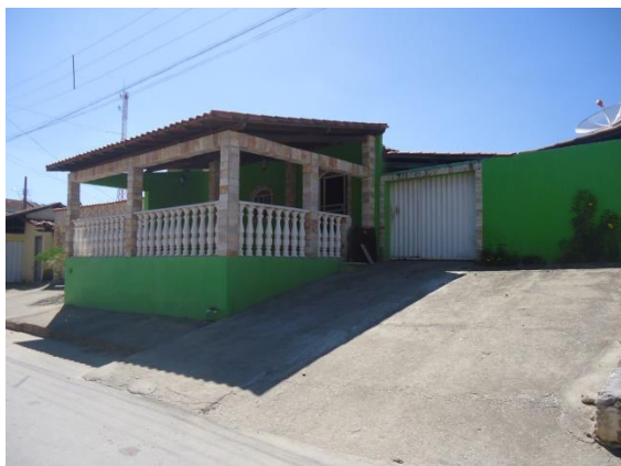
Pará de Minas Núcleo Histórico Urbano do Distrito de Carioca Rua Nossa Senhora da Piedade, 36 (foto 73) Imagem: Álisson Margotti – 25/08/2016
