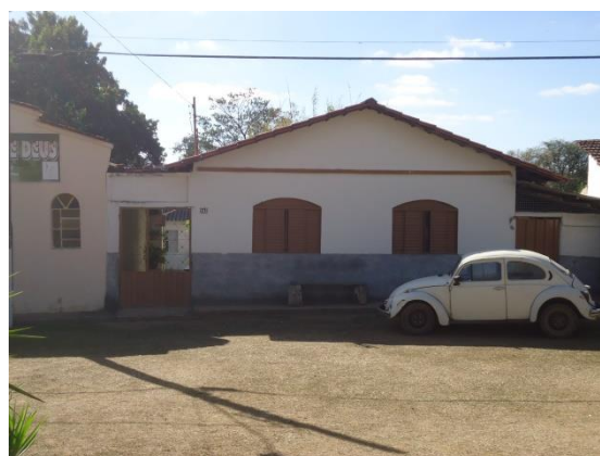
Pará de Minas Núcleo Histórico Urbano do Distrito de Ascensão Edificação à Rua Raimundo Penaforte, de Araújo, 142. (foto 100)
