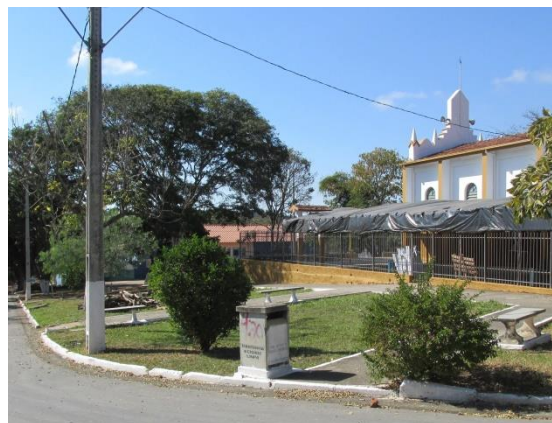
Pará de Minas Núcleo Histórico Urbano do Distrito de Ascensão Lixeira em concreto na Praça Santo Antônio exibindo bom estado de conservação. (foto 120)
