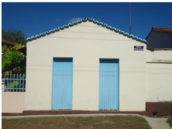
Pará de Minas Núcleo Histórico Urbano do Distrito de Ascensão Edificação à Avenida Presidente Kubitschek, 055. (foto 61)
