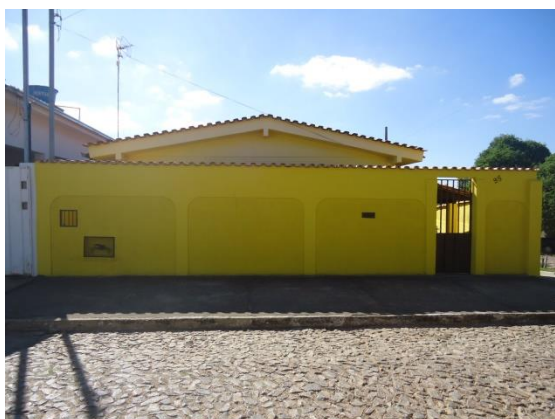
Pará de Minas Núcleo Histórico Urbano do Distrito de Ascensão Edificação à Avenida Presidente Kubitschek, 095. (foto 65)
