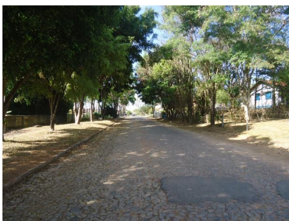
Pará de Minas Núcleo Histórico Urbano do Distrito de Ascensão A Rua Raimundo Penaforte de Araújo não exibe sarjetas nem bocas de lobo.
