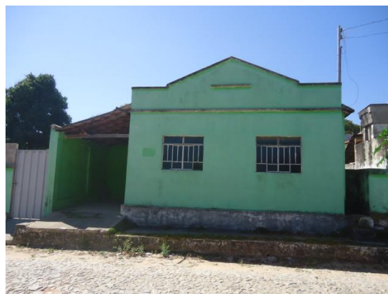
Pará de Minas Núcleo Histórico Urbano do Distrito de Carioca Rua Nossa Senhora da Piedade, 30 (foto 72) Imagem: Álisson Margotti – 25/08/2016
