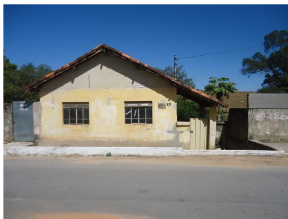
Pará de Minas Núcleo Histórico Urbano do Distrito de Carioca Desnível do passeio impossibilita a acessibilidade na Rua Dona Maria Lopes Cançado. (foto 20)
