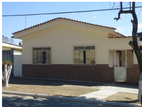
Pará de Minas Núcleo Histórico Urbano do Distrito de Ascensão Edificação à Avenida Abdon Senem de Araújo, 150. (foto 56)
