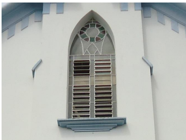
Pará de Minas Igreja de Nossa Senhora das Graças Janela em ferro e vidro da torre. (Foto 03)
