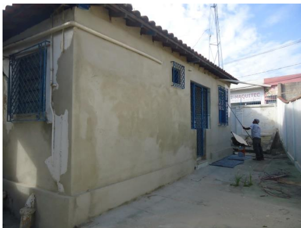
Pará de Minas Casa Maria Capanema Paredes da fachada posterior com reboco refeito. (foto 02)
