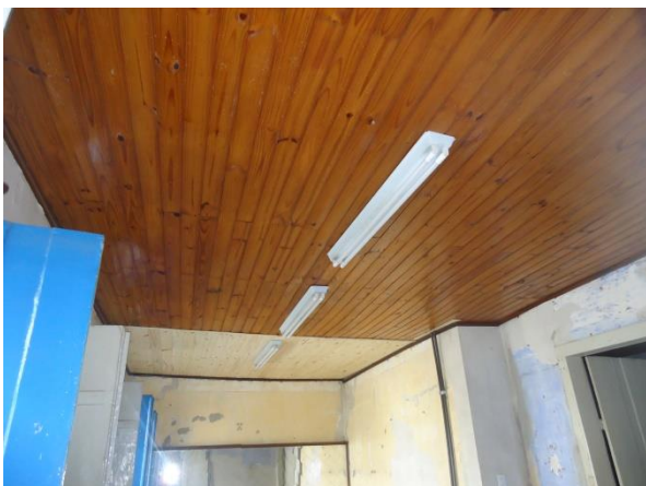
Pará de Minas Casa Maria Capanema Restauração e reforma dos forros em andamento. (foto 04)
