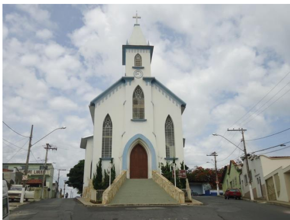
Pará de Minas Igreja de Nossa Senhora das Graças Vista do bem tombado em bom estado. (Foto 01)
