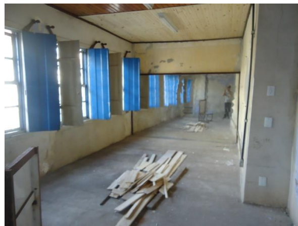
Pará de Minas Casa Maria Capanema Piso de laje recém-executado na futura sala de reuniões. (foto 03)
