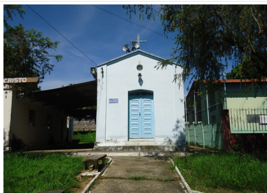
Pará de Minas Gorduras – Capela Nossa Senhora da Conceição (foto 08) Imagem: Acervo digital da Secretaria de Cultura e Comunicação Institucional (2018)
