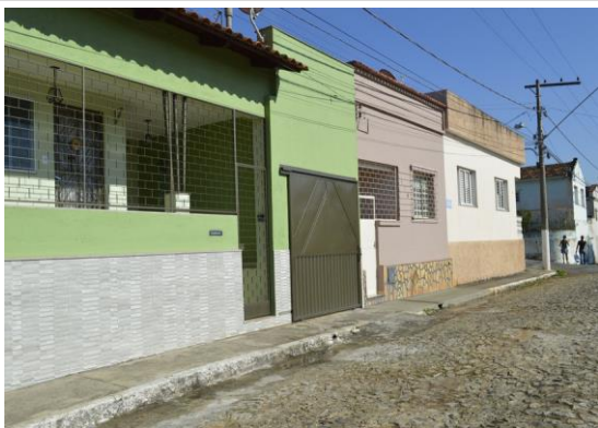
Pará de Minas Gruta de Nossa Senhora de Lourdes Edificações sem afastamento frontal e lateral na Via Praça Francisco Valadares exibindo camada pictórica em bom estado. (foto 52) Imagem: Mateus Fonseca – 10/07/2020
