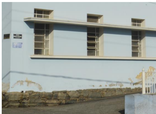
Pará de Minas Irmandade Nossa Senhora da Conceição – Hospital Pedra que marca o baldrame do edifício. (foto 15) Imagem: Mateus Fonseca – 18/09/2020
