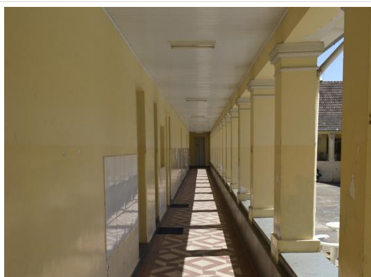
Pará de Minas Escola Estadual Governador Valadares Forro em pvc nos corredores que conformam o pátio interno. (foto 37) Imagem: Mateus Fonseca – 19/08/2020
