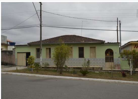
Pará de Minas Núcleo Histórico Urbano do Distrito de Ascensão Edificação à Avenida Abdon Senem de Araújo, 130. (foto 42)
