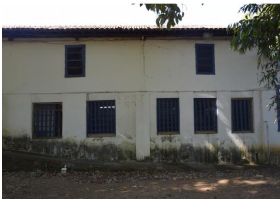
Pará de Minas Escola Municipal de Artes e Ofícios Raimundo Nogueira de Faria - SICA Alvenaria externa, fachada posterior, com limo na base. (foto 13) Imagem: Mateus Fonseca – 04/09/2020
