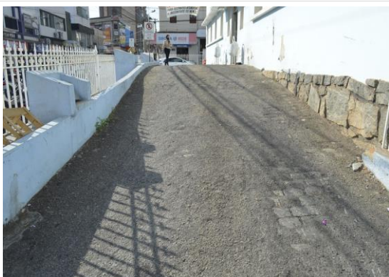
Pará de Minas Irmandade Nossa Senhora da Conceição – Hospital Rampa de acesso à maternidade. (foto 43) Imagem: Mateus Fonseca – 18/09/2020
