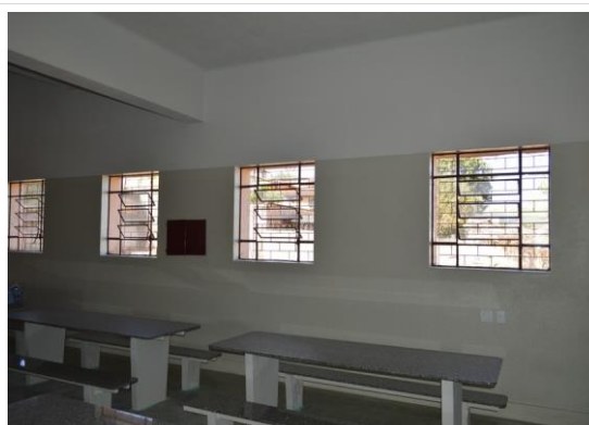
Pará de Minas Escola Estadual Fernando Otávio Janelas basculantes em metal e vidro do refeitório. (foto 24) Imagem: Mateus Fonseca – 28/08/2020
