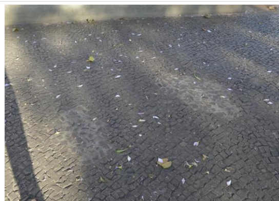
Pará de Minas Praças Torquato de Almeida e Francisco Torquato Remendos em cimento. (foto 15) Imagem: Mateus Fonseca – 29/07/2020
