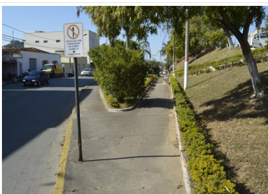
Pará de Minas Gruta de Nossa Senhora de Lourdes Piso cimentado na Rua Fernando Otávio em bom estado mas não possui acessibilidade. (foto 17) Imagem: Mateus Fonseca – 10/07/2020
