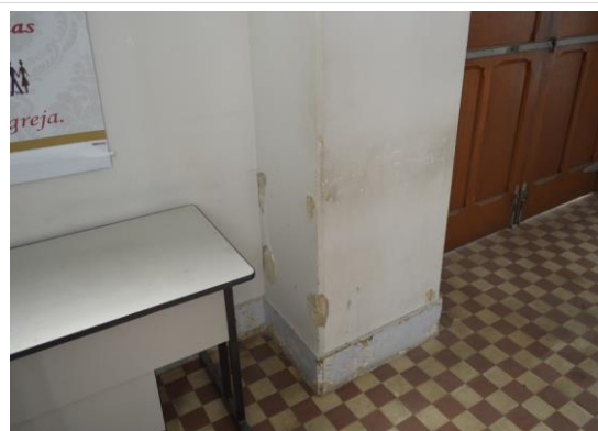
Pará de Minas Igreja Nossa Senhora das Graças Desprendimento da pintura interna. (foto 13) Imagem: Mateus Fonseca – 04/09/2020
