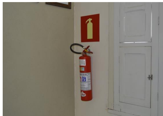
Pará de Minas Telas da Antiga Matriz de Nossa Senhora da Piedade Instalações de combate a incêndio no prédio. (foto 58) Imagem: Mateus Fonseca – 23/09/2020
