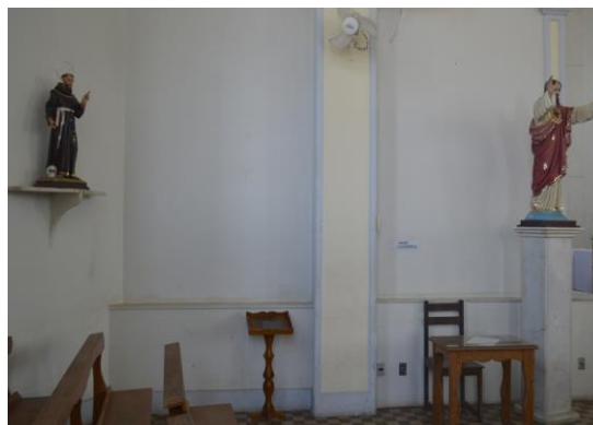
Pará de Minas Igreja Nossa Senhora das Graças A estrutura de concreto armado do bem se apresenta íntegra. (foto 06) Imagem: Mateus Fonseca – 04/09/2020
