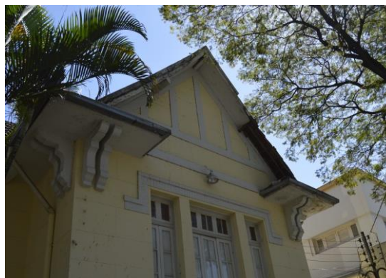
Pará de Minas Escola Estadual Governador Valadares Beiral sofreu perda de material por excesso de umidade. (foto 11) Imagem: Mateus Fonseca – 19/08/2020
