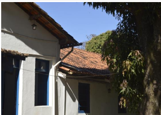
Pará de Minas Escola Municipal de Artes e Ofícios Raimundo Nogueira de Faria - SICA Coletor de águas pluviais. (foto 11) Imagem: Mateus Fonseca – 04/09/2020
