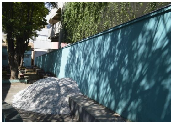
Pará de Minas Escola Estadual Torquato de Almeida Muro lateral direito da edificação. (foto 38) Imagem: Mateus Fonseca – 11/11/2020
