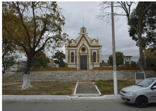
Pará de Minas Núcleo Histórico Urbano do Distrito de Ascensão Vegetação da Praça Santo Antônio. (foto 115) Imagem: Mateus Fonseca – 24/08/2020
