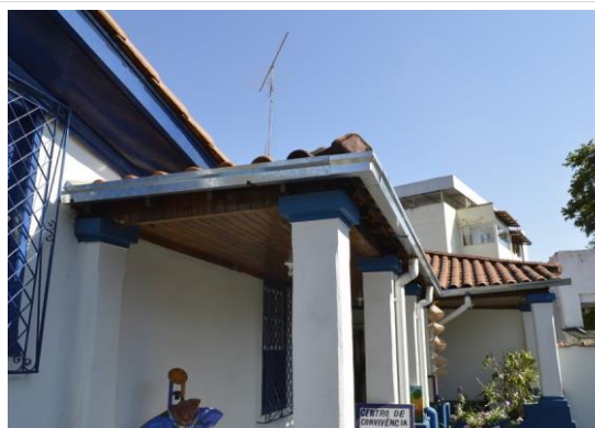
Pará de Minas Casa Maria Capanema O sistema de condução de águas pluviais exhibe bom estado de conservação. (foto 09) Imagem: Mateus Fonseca – 10/07/2020
