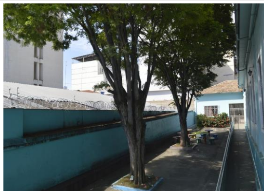
Pará de Minas Escola Estadual Torquato de Almeida Jardim lateral esquerda. (foto 34) Imagem: Mateus Fonseca – 11/11/2020
