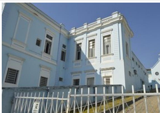
Pará de Minas Irmandade Nossa Senhora da Conceição – Hospital Fachada lateral direita. (foto 02) Imagem: Mateus Fonseca – 18/09/2020
