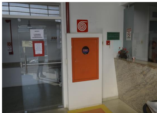
Pará de Minas Irmandade Nossa Senhora da Conceição – Hospital Equipamento de combate a incêndio. (foto 52) Imagem: Mateus Fonseca – 18/09/2020
