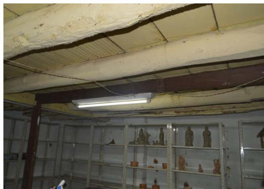
Pará de Minas Escola Municipal de Artes e Ofícios Raimundo Nogueira de Faria - SICA Madeiramento visto do porão. (foto 06) Imagem: Mateus Fonseca – 04/09/2020
