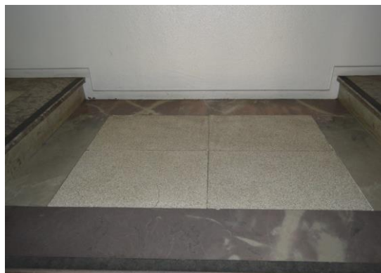
Pará de Minas Fórum Desembargador Pedro Nestor Mármore e marmorite nos pisos e espelhos da escadaria. (foto 28) Imagem: Mateus Fonseca – 06/08/2020
