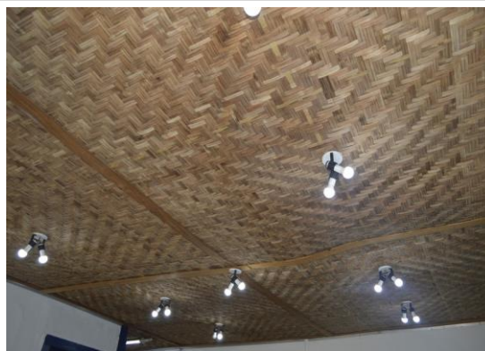
Pará de Minas Escola Municipal de Artes e Ofícios Raimundo Nogueira de Faria - SICA Forro em esteira trançada com certo abaulamento. (foto 39) Imagem: Mateus Fonseca – 04/09/2020
