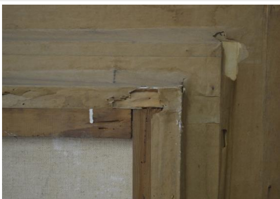
Pará de Minas Telas da Antiga Matriz de Nossa Senhora da Piedade Chassi sob ataque de insetos xilófagos, especialmente em suas porções inferiores. (foto 35) Imagem: Mateus Fonseca – 23/09/2020
