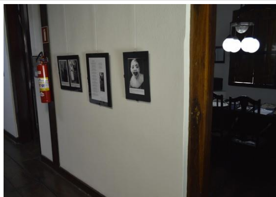
Pará de Minas MUSPAM Detalhe das alvenarias internas do bem apresentando bom estado de conservação. (foto 12) Imagem: Mateus Fonseca – 09/07/2020
