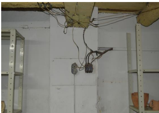
Pará de Minas Escola Municipal de Artes e Ofícios Raimundo Nogueira de Faria - SICA Instalações elétricas da oficina com fiação exposta. (foto 51) Imagem: Mateus Fonseca – 04/09/2020
