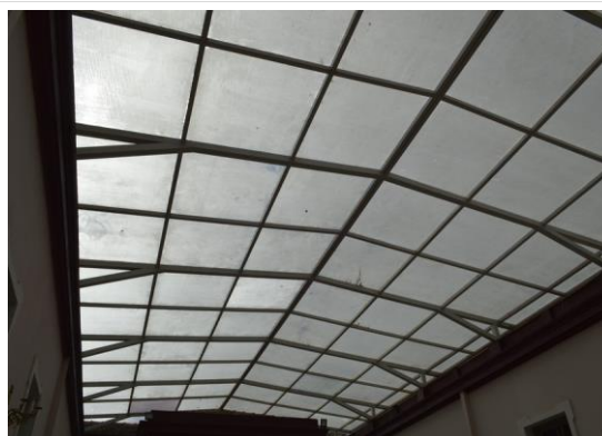
Pará de Minas Prédio Juscelino Kubitschek de Oliveira – Casa da Cultura Cobertura em policarbonato estruturado em perfil metálico. (foto 07) Imagem: Mateus Fonseca – 27/10/2020
