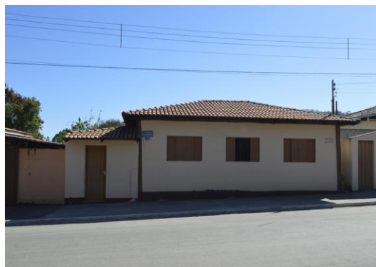
Pará de Minas Núcleo Histórico Urbano do Distrito de Carioca Edificação à via Praça Nossa Senhora de Lourdes, 75 (foto 38) Imagem: Mateus Fonseca – 07/08/2020
