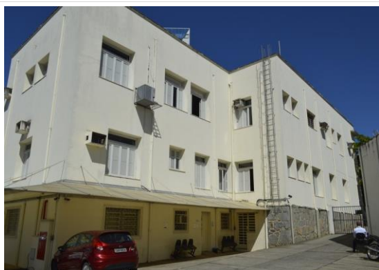
Pará de Minas Fórum Desembargador Pedro Nestor Fachada lateral esquerda da edificação. (foto 02) Imagem: Mateus Fonseca – 06/08/2020
