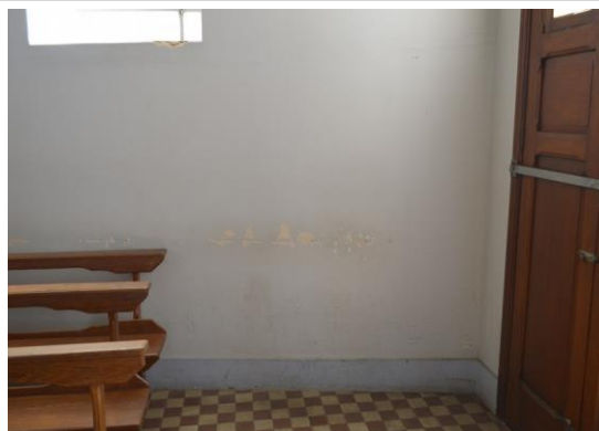
Pará de Minas Igreja Nossa Senhora das Graças Detalhe da alvenaria interna. (foto 10) Imagem: Mateus Fonseca – 04/09/2020
