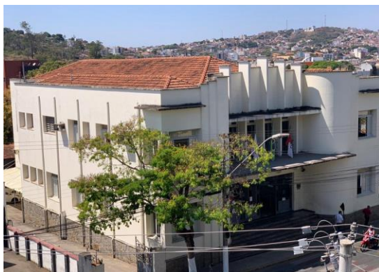
Pará de Minas Fórum Desembargador Pedro Nestor Manto de cobertura em telhas francesas. (foto 08) Imagem: Mateus Fonseca – 06/08/2020
