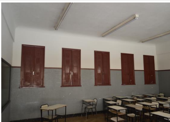
Pará de Minas Escola Estadual Fernando Otávio Pintura a base de água e barrado em tinta a óleo nas salas de aula. (foto 19) Imagem: Mateus Fonseca – 28/08/2020
