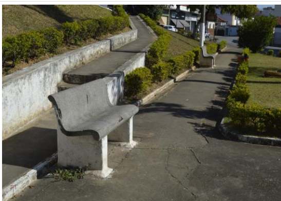
Pará de Minas Gruta de Nossa Senhora de Lourdes Banco em concreto exibindo bom estado de conservação. (foto 48) Imagem: Mateus Fonseca – 10/07/2020
