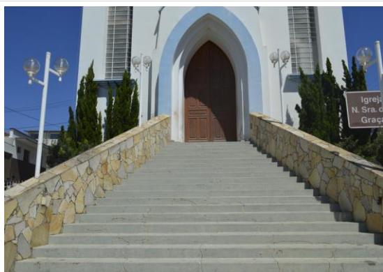
Pará de Minas Igreja Nossa Senhora das Graças Porta principal em madeira. (foto 16) Imagem: Mateus Fonseca – 04/09/2020
