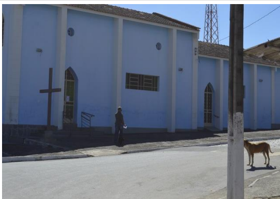
Pará de Minas Núcleo Histórico Urbano do Distrito de Carioca Rampa de acessibilidade para a entrada na lateral direita da Igreja de Nossa Senhora de Lourdes. (foto 20) Imagem: Mateus Fonseca – 07/08/2020
