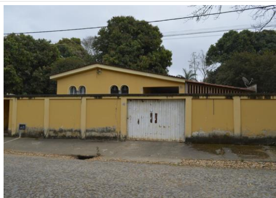
Par  de Minas N cleo Hist rico Urbano do Distrito de Ascens o Edifica o   Avenida Presidente Kubitschek, 230. (foto 61) Imagem: Mateus Fonseca – 24/08/2020
