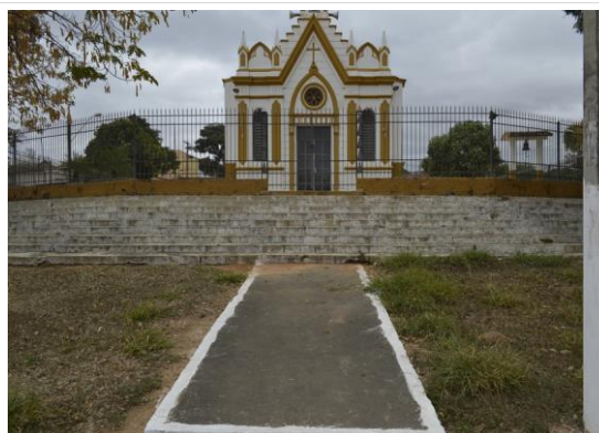
Pará de Minas Núcleo Histórico Urbano do Distrito de Ascensão Passarela em concreto que leva à Igreja de Santo Antônio. (foto 113) Imagem: Mateus Fonseca – 24/08/2020
