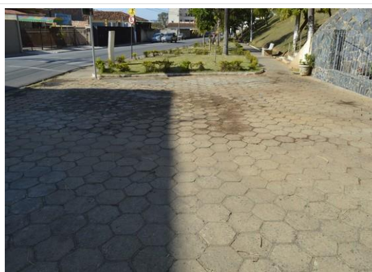
Pará de Minas Gruta de Nossa Senhora de Lourdes Piso de concreto intertravado apresenta algumas fissuras e pequenos desníveis devido a compactação irregular do terreno. (foto 18) Imagem: Mateus Fonseca – 10/07/2020
