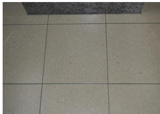
Pará de Minas Prédio Juscelino Kubitschek de Oliveira – Casa da Cultura Piso cerâmico comum aos banheiros do bem. (foto 34) Imagem: Mateus Fonseca – 27/10/2020
