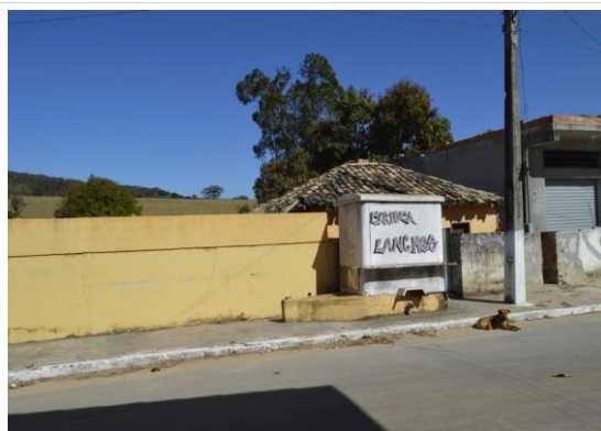
Pará de Minas Núcleo Histórico Urbano do Distrito de Carioca Edificação à via Praça Nossa Senhora de Lourdes, 99 (foto 40) Imagem: Mateus Fonseca – 07/08/2020
