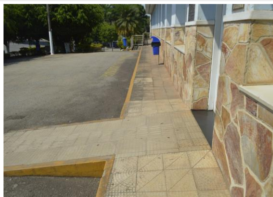
Pará de Minas Asilo Padre José Pereira Coelho Piso em concreto no passeio da fachada frontal bem conservado. (foto 42) Imagem: Mateus Fonseca – 30/09/2020
