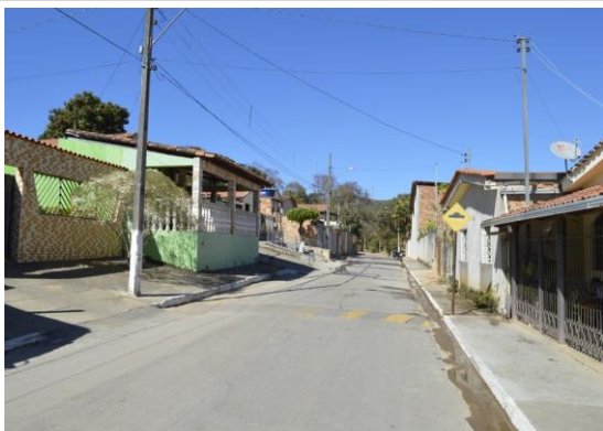
Pará de Minas Núcleo Histórico Urbano do Distrito de Carioca Vista da via Nossa Senhora da Piedade com pavimentação asfáltica em bom estado. (foto 02) Imagem: Mateus Fonseca – 07/08/2020
