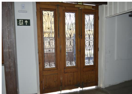
Pará de Minas Estação Ferroviária Porta de madeira que dá acesso à varanda exibindo remendos no material anteriormente degradado. (foto 26) Imagem: Mateus Fonseca – 27/07/2020
