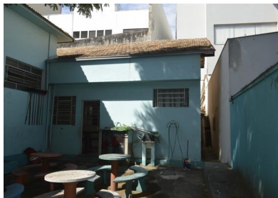
Pará de Minas Escola Estadual Torquato de Almeida Janelas em metal e vidro e enquadramento em massa na cozinha. (foto 21) Imagem: Mateus Fonseca – 11/11/2020
