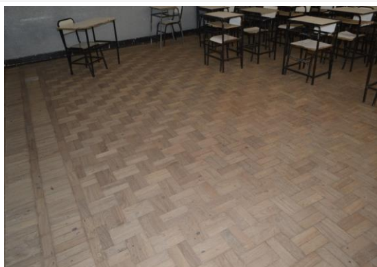
Pará de Minas Escola Estadual Fernando Otávio Piso em parquet de madeira comum às salas de aula. (foto 33) Imagem: Mateus Fonseca – 28/08/2020
