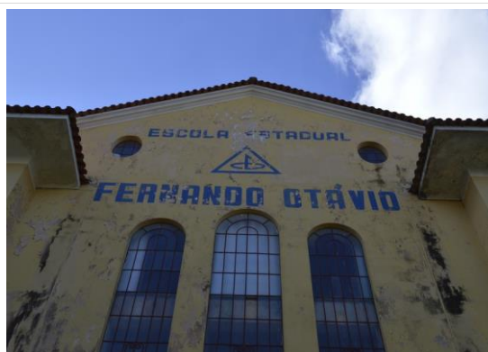
Pará de Minas Escola Estadual Fernando Otávio Frontão e cimalhas na fachada frontal. (foto 08) Imagem: Mateus Fonseca – 28/08/2020
