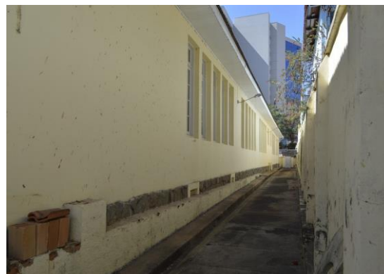
Pará de Minas Escola Estadual Governador Valadares Muro lateral esquerdo. (foto 45) Imagem: Mateus Fonseca – 19/08/2020
