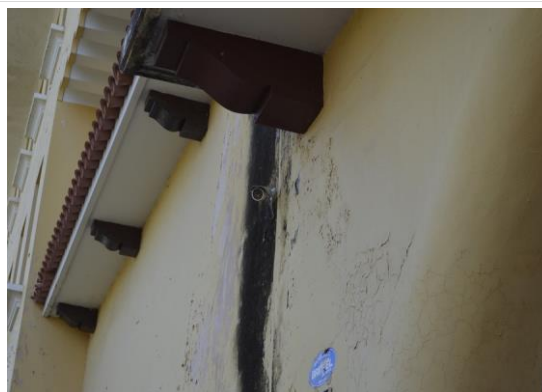
Pará de Minas Escola Estadual Fernando Otávio Detalhe dos cachorros que compõem a fachada. (foto 44) Imagem: Mateus Fonseca – 28/08/2020
