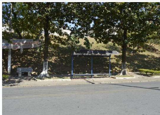
Pará de Minas Gruta de Nossa Senhora de Lourdes Parada de ônibus com abrigo em bom estado de conservação exibindo apenas desgaste da camada pictórica em seu assento. (foto 26) Imagem: Mateus Fonseca – 10/07/2020
