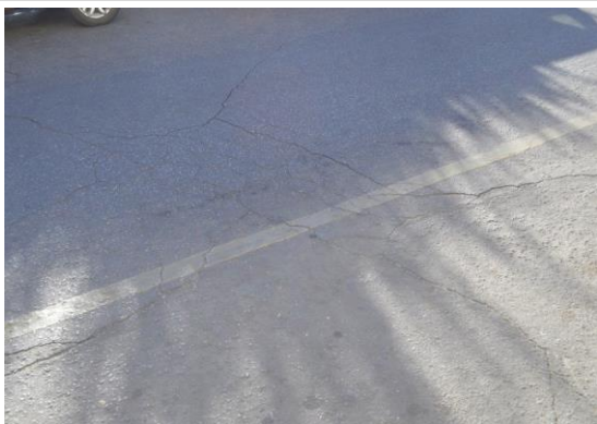
Pará de Minas Praças Torquato de Almeida e Francisco Torquato Asfalto apresentando algumas trincas naturais do impacto constante. (foto 06) Imagem: Mateus Fonseca – 29/07/2020
