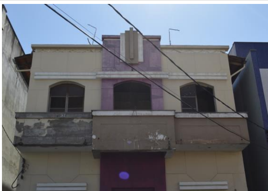
Pará de Minas Centro Literário Pedro Nestor Sacada necessitando de pintura. (foto 29) Imagem: Mateus Fonseca – 03/09/2020
