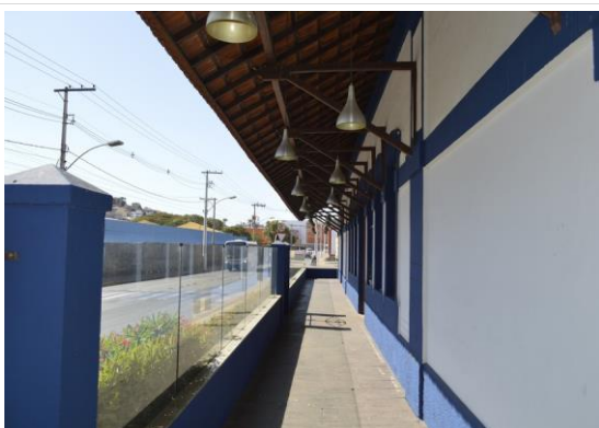
Pará de Minas Estação Ferroviária Varanda externa na fachada posterior em bom estado, mas apresenta desgaste nos pisos, a pintura em perfeito estado. (foto 55) Imagem: Mateus Fonseca – 27/07/2020
