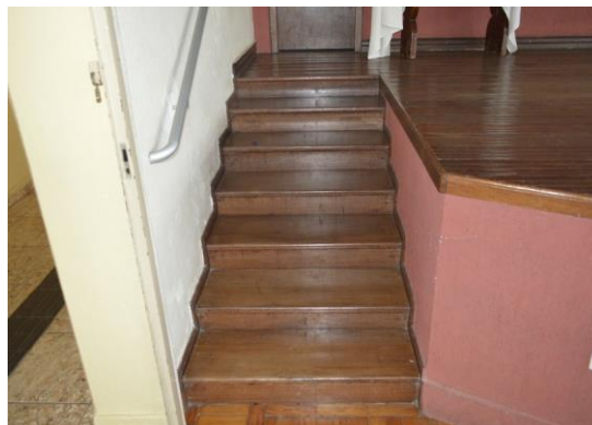
Pará de Minas Asilo Padre José Pereira Coelho Escada de acesso ao palco em madeira em bom estado de conservação. (foto 35) Imagem: Mateus Fonseca – 30/09/2020
