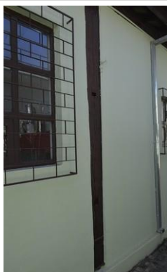
Pará de Minas MUSPAM Alvenarias externas do bem tombado exibindo bom estado de conservação. (foto 11) Imagem: Mateus Fonseca – 09/07/2020
