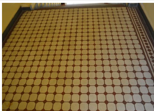
Pará de Minas Escola Estadual Governador Valadares Ladrilho do patamar da escada de acesso ao refeitório. (foto 34) Imagem: Mateus Fonseca – 19/08/2020
