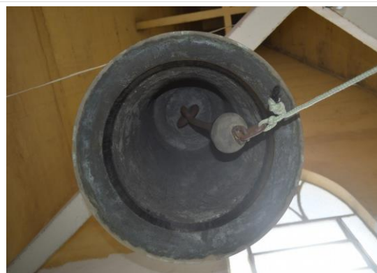
Pará de Minas Igreja Nossa Senhora das Graças Vista do badalo. (foto 41)
