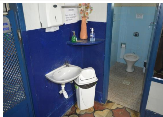
Pará de Minas Escola Municipal de Artes e Ofícios Raimundo Nogueira de Faria - SICA Instalações hidráulicas dos banheiros do bem. (foto 54) Imagem: Mateus Fonseca – 04/09/2020
