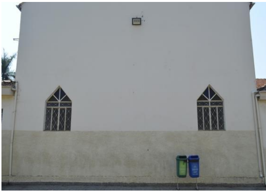
Pará de Minas Asilo Padre José Pereira Coelho Vista externa das janelas do altar da capela, feitas em metal e vidro e enquadramento em massa. (foto 26) Imagem: Mateus Fonseca – 30/09/2020
