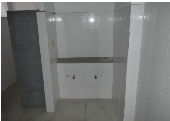
Pará de Minas Centro Literário Pedro Nestor Cerâmicas de um dos banheiros. (foto 15)
