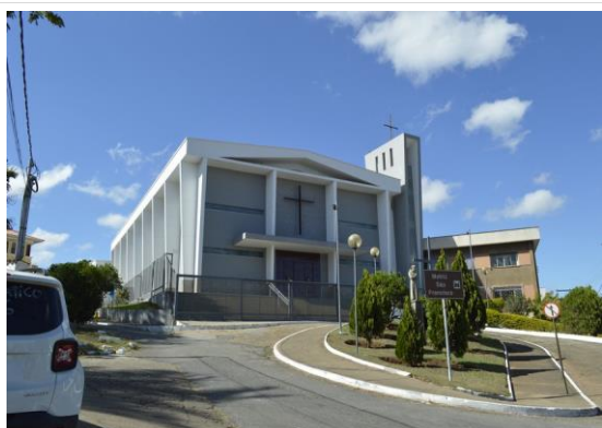
Pará de Minas Escola Estadual Fernando Otávio Paisagem do entorno conformada pela Praça Frei Concórdio e Igreja de São Francisco de Assis. (foto 53) Imagem: Mateus Fonseca – 28/08/2020
