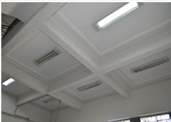
Pará de Minas Fórum Desembargador Pedro Nestor Artesoado no salão de entrada do pavimento térreo. (foto 37) Imagem: Mateus Fonseca – 06/08/2020
