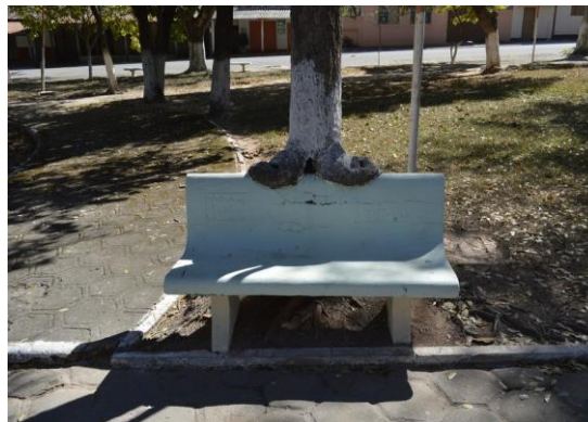
Pará de Minas Núcleo Histórico Urbano do Distrito de Carioca Banco em concreto exibindo algumas trincas devido ao esforço que a árvore está exercendo sobre o concreto.
