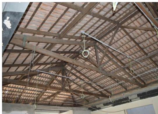
Pará de Minas Centro Literário Pedro Nestor Instalação do forro ainda não iniciada. (foto 28) Imagem: Mateus Fonseca – 03/09/2020
