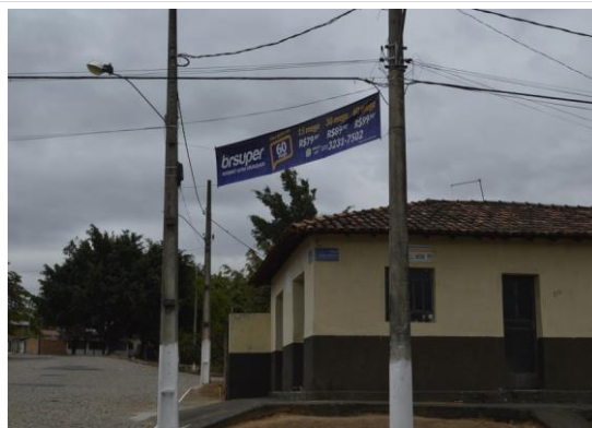
Pará de Minas Núcleo Histórico Urbano do Distrito de Ascensão Faixa afixada em postes, e fiação aparente em todo o Núcleo Histórico, detalhe da via Praça Santo Antônio. (foto 33) Imagem: Mateus Fonseca – 24/08/2020
