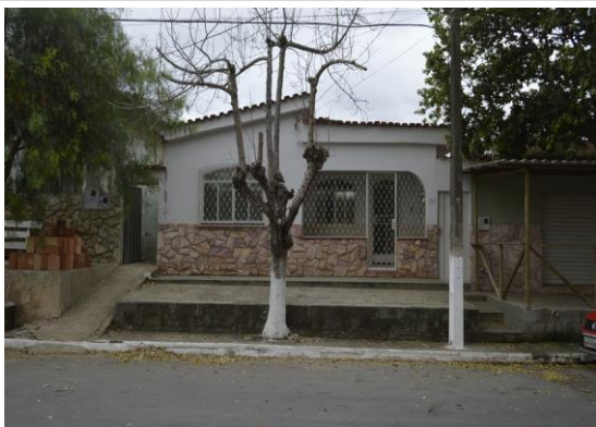
Pará de Minas Núcleo Histórico Urbano do Distrito de Ascensão Calçada em diferentes níveis na via Praça Santo Antônio. (foto 20) Imagem: Mateus Fonseca – 24/08/2020
