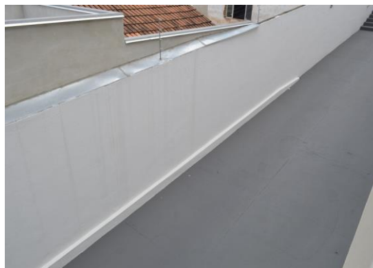
Pará de Minas Prédio Juscelino Kubitschek de Oliveira – Casa da Cultura Rampa na lateral esquerda do bem. (foto 42) Imagem: Mateus Fonseca – 27/10/2020
