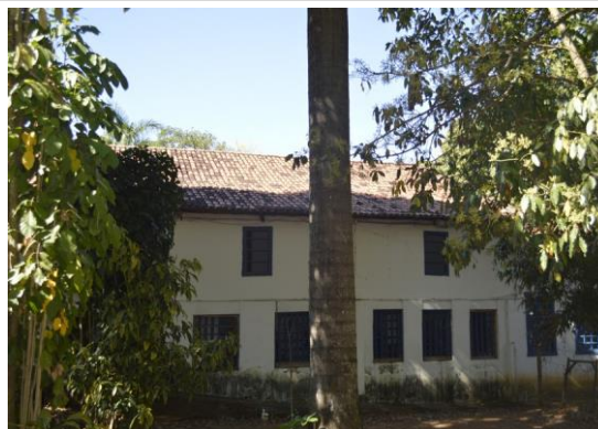
Pará de Minas Escola Municipal de Artes e Ofícios Raimundo Nogueira de Faria - SICA Vista do manto de cobertura em telhas francesas. (foto 12) Imagem: Mateus Fonseca – 04/09/2020
