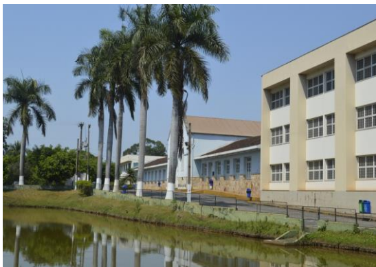
Pará de Minas Asilo Padre José Pereira Coelho Fachada lateral direita recebeu anexo. (foto 02) Imagem: Mateus Fonseca – 30/09/2020
