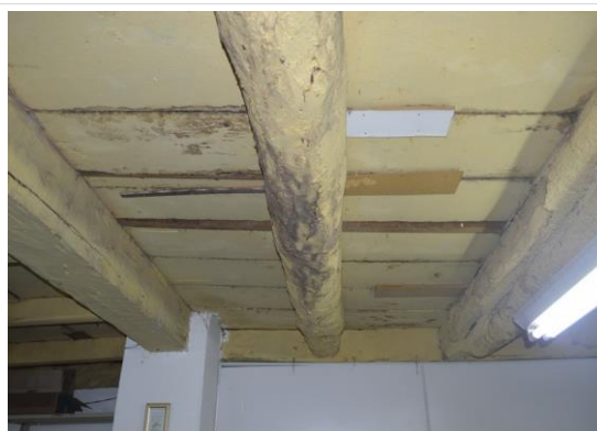
Pará de Minas Escola Municipal de Artes e Ofícios Raimundo Nogueira de Faria - SICA Intervenção paleativa nas frestas do assoalho de madeira. (foto 32) Imagem: Mateus Fonseca – 04/09/2020
