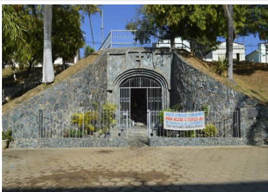
Pará de Minas Gruta de Nossa Senhora de Lourdes Fachada frontal da Gruta Nossa Senhora de Lourdes implantada em declive natural do terreno, com volumetria encontrando o nível da via Praça Francisco Valadares. (foto 32) Imagem: Mateus Fonseca – 10/07/2020
