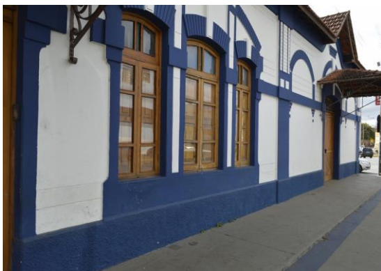
Pará de Minas Estação Ferroviária Fachada frontal sem aparentar danos estruturais. (foto 05) Imagem: Mateus Fonseca – 27/07/2020
