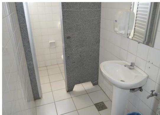
Pará de Minas Fórum Desembargador Pedro Nestor Instalações hidráulicas em bom estado. (foto 48) Imagem: Mateus Fonseca – 06/08/2020
