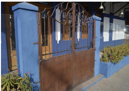
Pará de Minas Estação Ferroviária Portão de ferro que dá acesso à varanda em bom estado. (foto 61) Imagem: Mateus Fonseca – 27/07/2020
