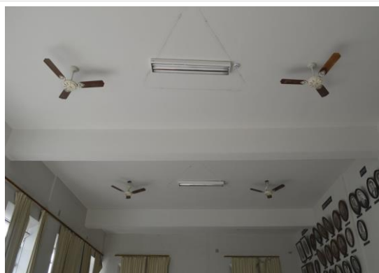
Pará de Minas Irmandade Nossa Senhora da Conceição – Hospital Laje com vigamento no salão. (foto 40) Imagem: Mateus Fonseca – 18/09/2020
