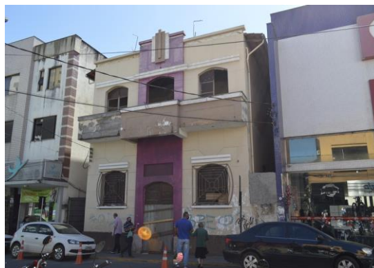
Pará de Minas Centro Literário Pedro Nestor Fachada lateral direita. (foto 03)
