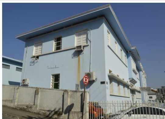
Pará de Minas Irmandade Nossa Senhora da Conceição – Hospital Fachada lateral esquerda. (foto 03) Imagem: Mateus Fonseca – 18/09/2020
