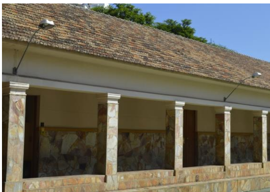
Pará de Minas Escola Estadual Torquato de Almeida Pilares e vigas dos corredores que conformam o pátio central. (foto 05) Imagem: Mateus Fonseca – 11/11/2020
