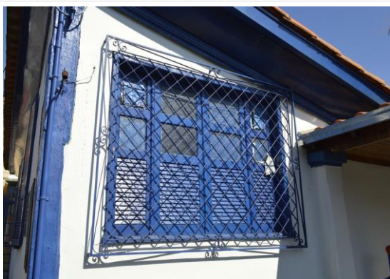
Pará de Minas Casa Maria Capanema Janela francesa em madeira e vidro na lateral esquerda apresenta pintura em bom estado de conservação. (foto 28) Imagem: Mateus Fonseca – 10/07/2020
