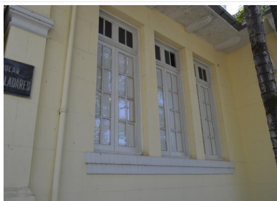
Pará de Minas Escola Estadual Governador Valadares Vista externa Janela com enquadramento e ornamentos em estuque. (foto 23) Imagem: Mateus Fonseca – 19/08/2020
