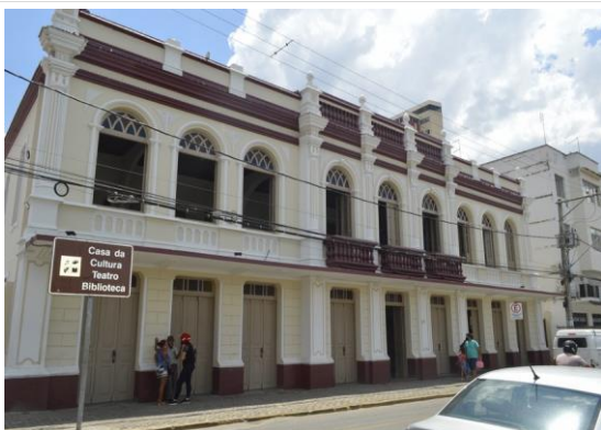
Pará de Minas Prédio Juscelino Kubitschek de Oliveira – Casa da Cultura Alvenarias externas. (foto 09) Imagem: Mateus Fonseca – 27/10/2020
