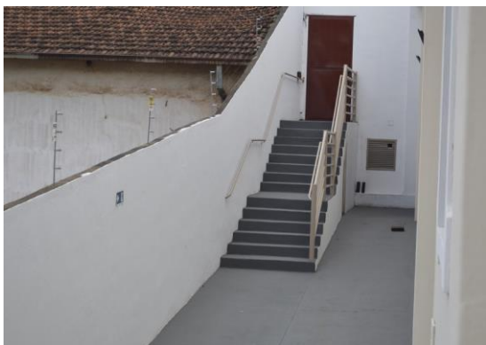
Pará de Minas Prédio Juscelino Kubitschek de Oliveira – Casa da Cultura Escada de acesso secundário ao teatro. (foto 41) Imagem: Mateus Fonseca – 27/10/2020
