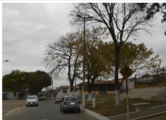
Pará de Minas Núcleo Histórico Urbano do Distrito de Ascensão Iluminação pública na praça. (foto 119) Imagem: Mateus Fonseca – 24/08/2020
