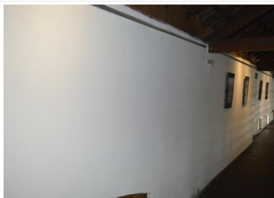
Pará de Minas Estação Ferroviária Detalhe da alvenaria interna. (foto 14) Imagem: Mateus Fonseca – 27/07/2020
