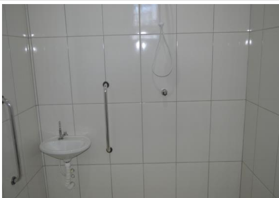
Pará de Minas Escola Estadual Fernando Otávio Revestimento cerâmico nos banheiros acessíveis. (foto 17) Imagem: Mateus Fonseca – 28/08/2020
