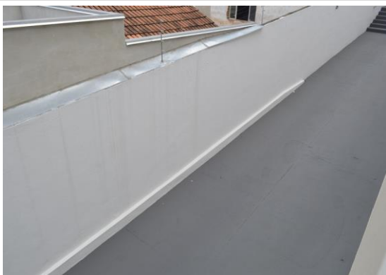
Pará de Minas Prédio Juscelino Kubitschek de Oliveira – Casa da Cultura Acesso lateral rampado de piso cimentado. (foto 35) Imagem: Mateus Fonseca – 27/10/2020
