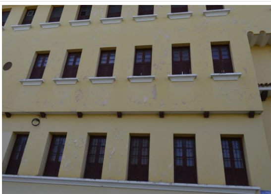
Pará de Minas Escola Estadual Fernando Otávio Alvenarias externas na fachada frontal. (foto 11) Imagem: Mateus Fonseca – 28/08/2020
