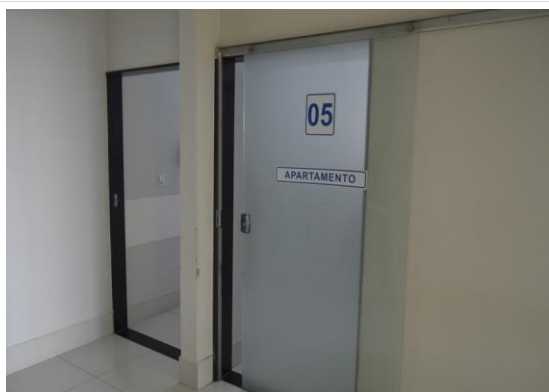
Pará de Minas Irmandade Nossa Senhora da Conceição – Hospital Porta de vidro dos apartamentos. (foto 23) Imagem: Mateus Fonseca – 18/09/2020
