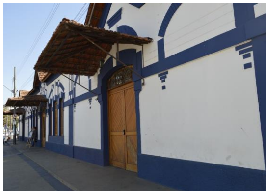
Pará de Minas Estação Ferroviária Fachada frontal sem aparentar danos estruturais. (foto 06) Imagem: Mateus Fonseca – 27/07/2020
