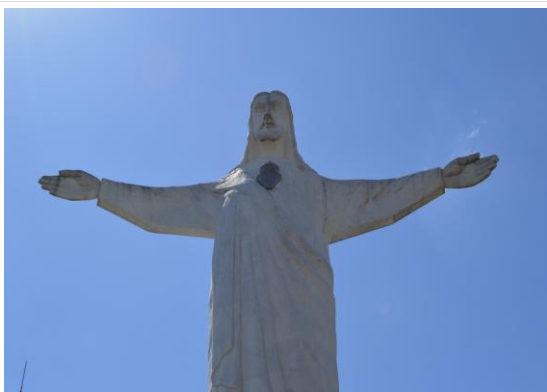
Pará de Minas Cristo Redentor Reboco e pintura da estátua exibem algumas sujidades por exposição as intempéries. (foto 07) Imagem: Mateus Fonseca – 03/08/2020
