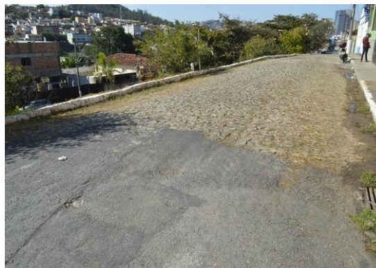
Pará de Minas Gruta de Nossa Senhora de Lourdes Trecho de transição entre camada asfáltica e pé de moleque na via Praça Francisco Valadares. (foto 05) Imagem: Mateus Fonseca – 10/07/2020
