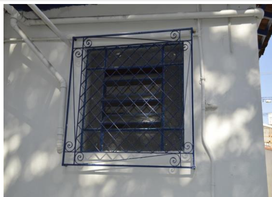
Pará de Minas Casa Maria Capanema Janelas em basculante em metal e vidro e grade na fachada lateral esquerda. (foto 31) Imagem: Mateus Fonseca – 10/07/2020
