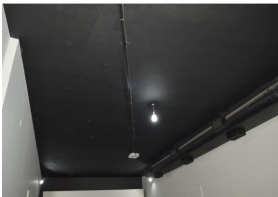
Pará de Minas Estação Ferroviária Forro de gesso na sala de cinema em bom estado de conservação. (foto 53) Imagem: Mateus Fonseca – 27/07/2020
