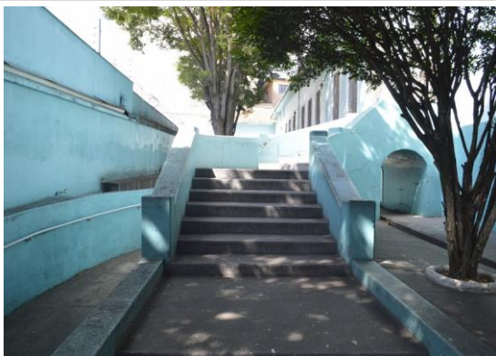
Pará de Minas Escola Estadual Torquato de Almeida Escadaria de acesso lateral. (foto 33) Imagem: Mateus Fonseca – 11/11/2020
