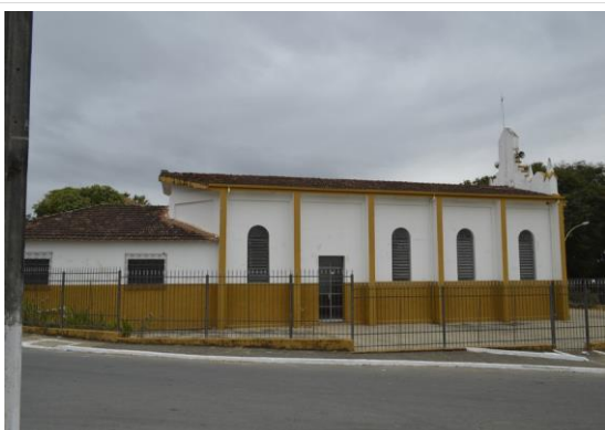
Pará de Minas Núcleo Histórico Urbano do Distrito de Ascensão Vista da fachada lateral esquerda da Igreja de Santo Antônio. (foto 104) Imagem: Mateus Fonseca – 24/08/2020
