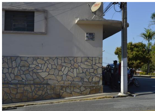
Pará de Minas Gruta de Nossa Senhora de Lourdes Placa de logradouro em bom estado de conservação na Praça Francisco Valadares. (foto 07) Imagem: Mateus Fonseca – 10/07/2020
