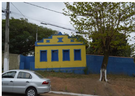
Pará de Minas Núcleo Histórico Urbano do Distrito de Ascensão Edificação à Avenida Abdon Senen e Araújo, 087. (foto 39)
