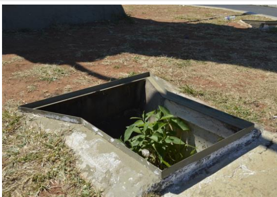
Pará de Minas Cristo Redentor Instalações elétricas sem funcionamento no bem tombado. (foto 21) Imagem: Mateus Fonseca – 03/08/2020
