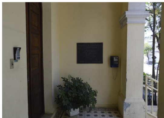
Pará de Minas Escola Estadual Governador Valadares Alvenarias externas. (foto 13) Imagem: Mateus Fonseca – 19/08/2020
