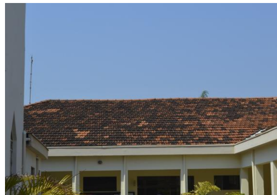
Pará de Minas Asilo Padre José Pereira Coelho Condutores de águas pluviais bem conservados. (foto 07) Imagem: Mateus Fonseca – 30/09/2020
