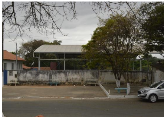
Pará de Minas Núcleo Histórico Urbano do Distrito de Ascensão Edificação à Praça Santo Antônio, SN. (foto 75)
