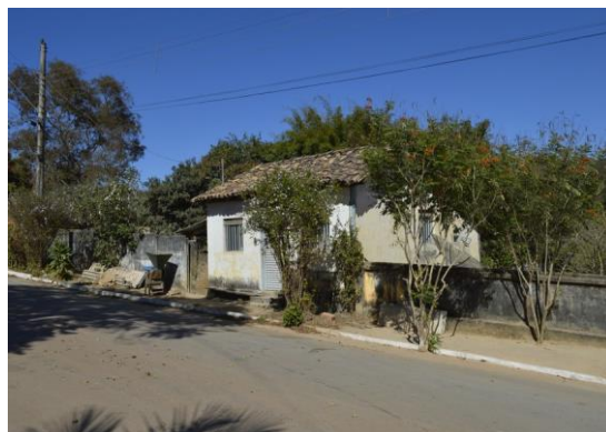
Pará de Minas Núcleo Histórico Urbano do Distrito de Carioca Edificação à Rua Dona Maria Lopes Cançado, 100 (foto 44) Imagem: Mateus Fonseca – 07/08/2020
