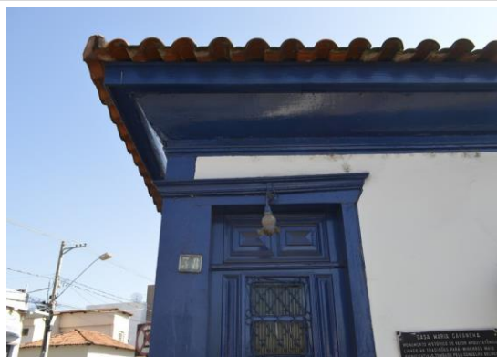
Pará de Minas Casa Maria Capanema Cimalhas restauradas apresentando bom estado de conservação. (foto 10) Imagem: Mateus Fonseca – 10/07/2020
