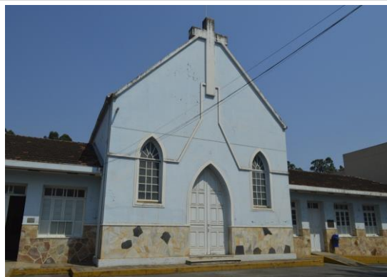
Pará de Minas Asilo Padre José Pereira Coelho Alvenarias externas à direita da capela apresentam boa conservação. (foto 10) Imagem: Mateus Fonseca – 30/09/2020
