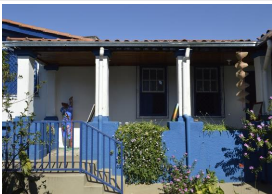
Pará de Minas Casa Maria Capanema Detalhe da varanda que dá acesso ao bem pela fachada lateral esquerda da edificação. (foto 43) Imagem: Mateus Fonseca – 10/07/2020
