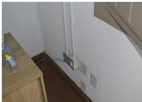
Pará de Minas Prédio Juscelino Kubitschek de Oliveira – Casa da Cultura Instalações elétricas. (foto 49) Imagem: Mateus Fonseca – 27/10/2020
