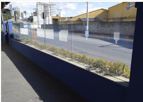
Pará de Minas Estação Ferroviária Muro em alvenaria e vidro com jardim na fachada posterior em bom estado de conservação. (foto 57) Imagem: Mateus Fonseca – 27/07/2020
