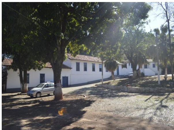
Pará de Minas Escola Municipal de Artes e Ofícios Raimundo Nogueira de Faria - SICA Fachada Frontal. (foto 01) Imagem: Mateus Fonseca – 04/09/2020
