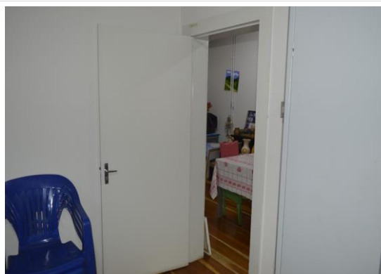
Pará de Minas Casa Maria Capanema Vista interna da porta de uma sala em bom estado de conservação. (foto 25) Imagem: Mateus Fonseca – 10/07/2020
