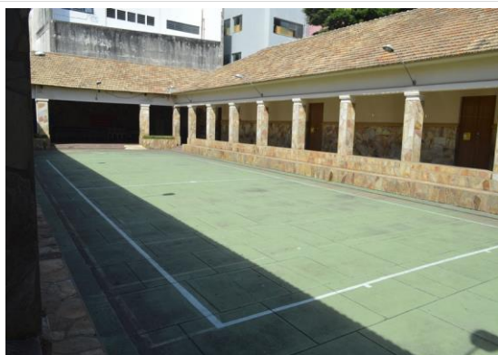
Pará de Minas Escola Estadual Torquato de Almeida Cimentado do pátio interno. (foto 25) Imagem: Mateus Fonseca – 11/11/2020
