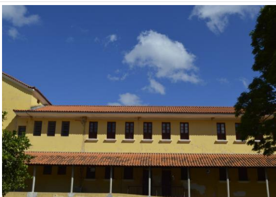
Pará de Minas Escola Estadual Fernando Otávio Manto de cobertura em telhas cerâmicas. (foto 07) Imagem: Mateus Fonseca – 28/08/2020
