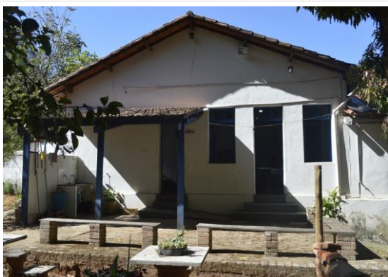
Pará de Minas Escola Municipal de Artes e Ofícios Raimundo Nogueira de Faria - SICA Varanda na fachada frontal em estrutura de madeira e cobertura em telhas cerâmicas.. (foto 42) Imagem: Mateus Fonseca – 04/09/2020
