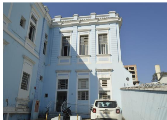
Pará de Minas Irmandade Nossa Senhora da Conceição – Hospital Alvenarias externas. (foto 10) Imagem: Mateus Fonseca – 18/09/2020
