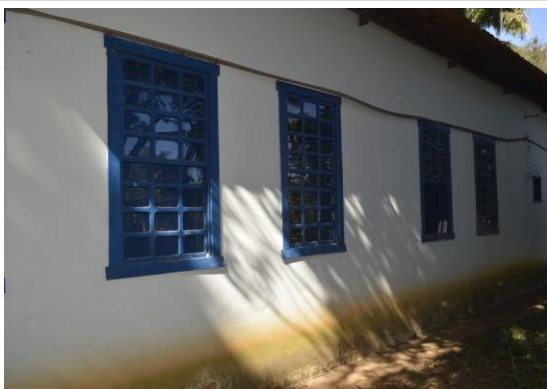
Pará de Minas Escola Municipal de Artes e Ofícios Raimundo Nogueira de Faria - SICA Manchas de sujidades e limo na pintura da fachada posterior. (foto 19) Imagem: Mateus Fonseca – 04/09/2020
