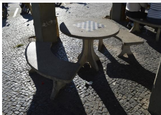
Pará de Minas Praças Torquato de Almeida e Francisco Torquato Bancos e mesas de jogos em concreto pré-moldado. (foto 52) Imagem: Mateus Fonseca – 29/07/2020
