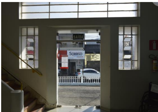
Pará de Minas Irmandade Nossa Senhora da Conceição – Hospital Porta de vidro com enquadramento em massa de acesso à maternidade.
