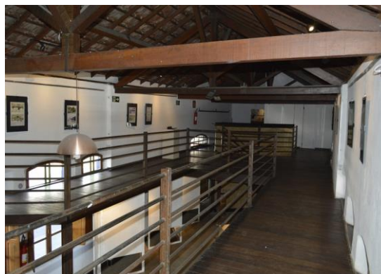
Pará de Minas Estação Ferroviária Alvenarias internas em bom estado de conservação. (foto 13) Imagem: Mateus Fonseca – 27/07/2020
