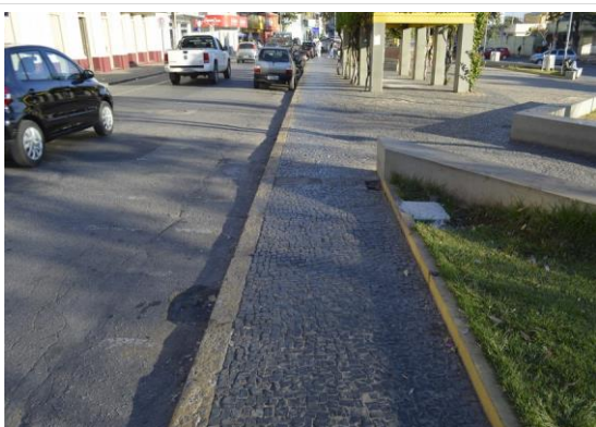
Pará de Minas Praças Torquato de Almeida e Francisco Torquato Vista do passeio revestida por pedra portuguesa. (foto 16) Imagem: Mateus Fonseca – 29/07/2020
