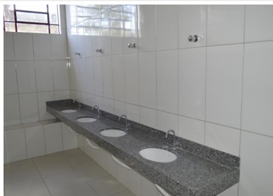
Pará de Minas Escola Estadual Fernando Otávio Instalações hidráulicas em funcionamento. (foto 48) Imagem: Mateus Fonseca – 28/08/2020
