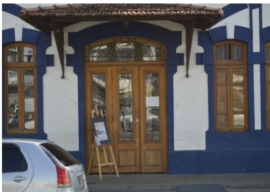
Pará de Minas Estação Ferroviária Porta de acesso principal exibindo algum desgaste na madeira porém no geral aparenta bom estado (foto 25) Imagem: Mateus Fonseca – 27/07/2020
