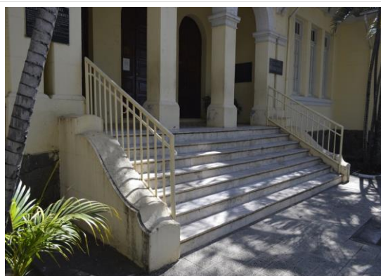
Pará de Minas Escola Estadual Governador Valadares Escadas do acesso principal a edificação. (foto 41)
