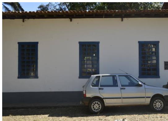
Pará de Minas Escola Municipal de Artes e Ofícios Raimundo Nogueira de Faria - SICA Janelas guilhotina em madeira e vidro localizadas no porão. (foto 26) Imagem: Mateus Fonseca – 04/09/2020
