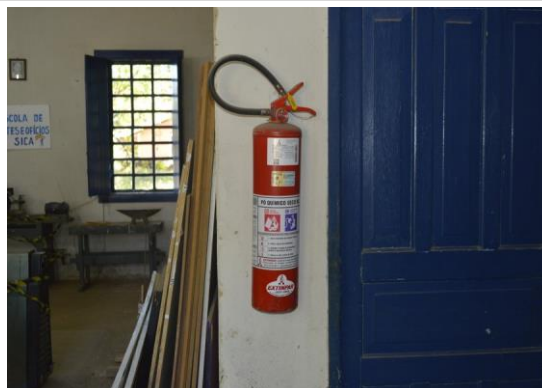
Pará de Minas Escola Municipal de Artes e Ofícios Raimundo Nogueira de Faria - SICA Extintor de incêndio instalado na oficina. (foto 56) Imagem: Mateus Fonseca – 04/09/2020
