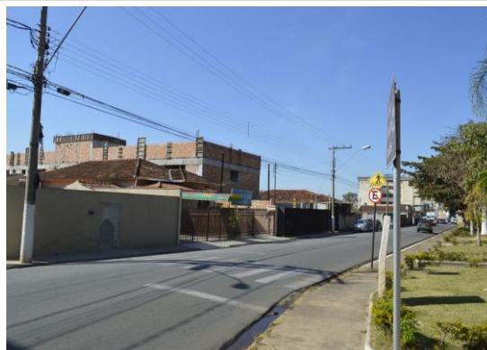
Pará de Minas Gruta de Nossa Senhora de Lourdes Edificação em construção na Rua Fernando Otávio (foto 30) Imagem: Mateus Fonseca – 10/07/2020
