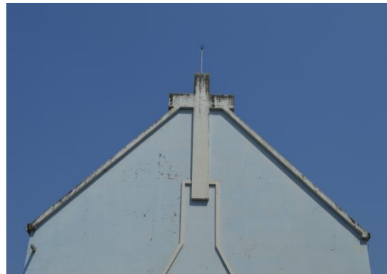
Pará de Minas Asilo Padre José Pereira Coelho Proteção contra descargas elétricas. (foto 59) Imagem: Mateus Fonseca – 30/09/2020
