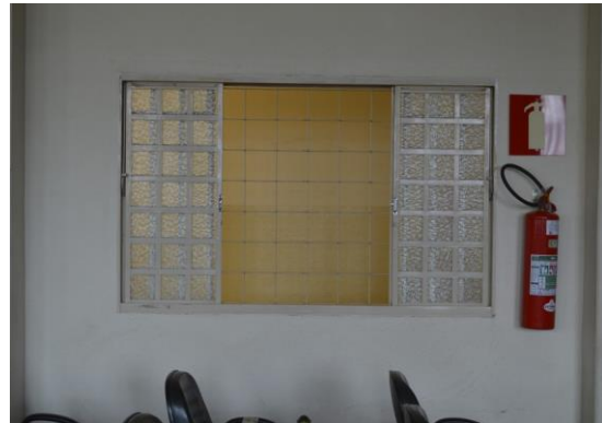
Pará de Minas Asilo Padre José Pereira Coelho Janela em metal e vidro existente no auditório. (foto 25) Imagem: Mateus Fonseca – 30/09/2020
