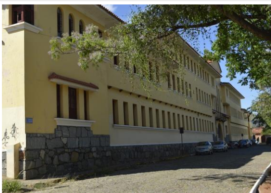
Pará de Minas Escola Estadual Fernando Otávio A estrutura em concreto armado. (foto 05) Imagem: Mateus Fonseca – 28/08/2020
