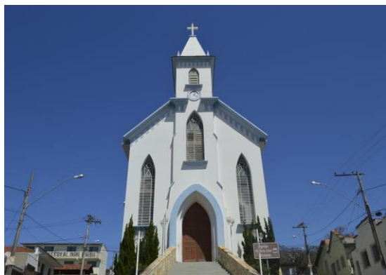
Pará de Minas Igreja Nossa Senhora das Graças Torre central da igreja. (foto 38)
