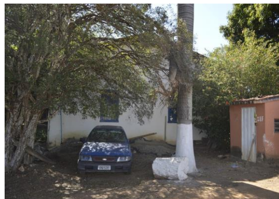
Pará de Minas Escola Municipal de Artes e Ofícios Raimundo Nogueira de Faria - SICA Fachada lateral esquerda. (foto 03) Imagem: Mateus Fonseca – 04/09/2020
