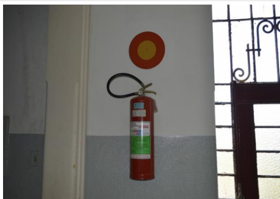
Pará de Minas Escola Estadual Fernando Otávio Extintor de incêndio. (foto 51) Imagem: Mateus Fonseca – 28/08/2020
