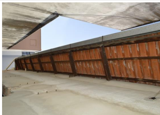
Pará de Minas Centro Literário Pedro Nestor Beiral e calha em bom estado de conservação. (foto 06) Imagem: Mateus Fonseca – 03/09/2020
