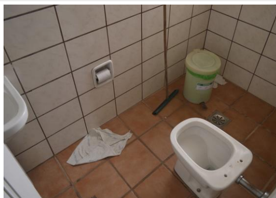
Pará de Minas Irmandade Nossa Senhora da Conceição – Hospital Piso cerâmico no banheiro de funcionários. (foto 36) Imagem: Mateus Fonseca – 18/09/2020
