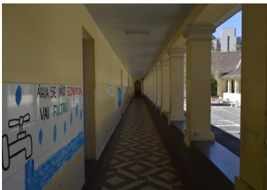
Pará de Minas Escola Estadual Governador Valadares Pilares e vigas das varandas. (foto 05) Imagem: Mateus Fonseca – 19/08/2020
