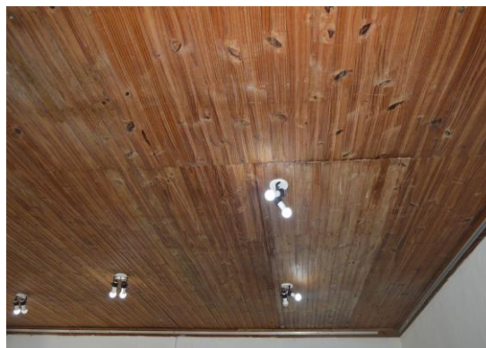
Pará de Minas Escola Municipal de Artes e Ofícios Raimundo Nogueira de Faria - SICA Forro de madeira de uma das salas de exposição. (foto 41) Imagem: Mateus Fonseca – 04/09/2020
