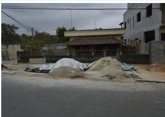
Pará de Minas Núcleo Histórico Urbano do Distrito de Ascensão Edificação à Avenida Abdon Senem de Araújo, 160. (foto 44)
