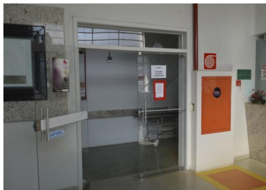
Pará de Minas Irmandade Nossa Senhora da Conceição – Hospital Porta de vidro no hall de entrada da maternidade.
