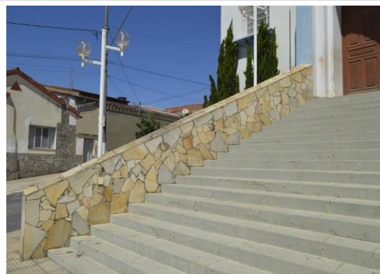
Pará de Minas Igreja Nossa Senhora das Graças Pedra são tomé que revestem o barrado e o guarda-corpo da escada principal. (foto 15) Imagem: Mateus Fonseca – 04/09/2020
