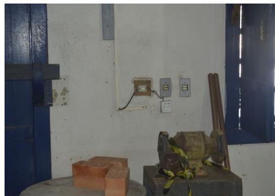
Pará de Minas Escola Municipal de Artes e Ofícios Raimundo Nogueira de Faria - SICA Instalações elétricas da oficina com fiação exposta. (foto 52) Imagem: Mateus Fonseca – 04/09/2020
