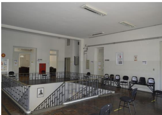
Pará de Minas Fórum Desembargador Pedro Nestor Quinas não apresenta nenhum sinal de fissuras ou trincas. (foto 05) Imagem: Mateus Fonseca – 06/08/2020
