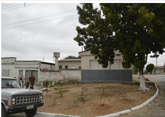
Pará de Minas Núcleo Histórico Urbano do Distrito de Ascensão Edificação à Praça Santo Antônio, SN (lateral nº039). (foto 76)
