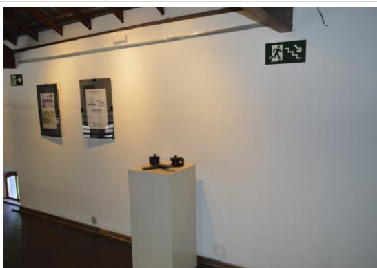
Pará de Minas Estação Ferroviária Reboco e pintura internos exibem ótimo estado. (foto 17) Imagem: Mateus Fonseca – 27/07/2020
