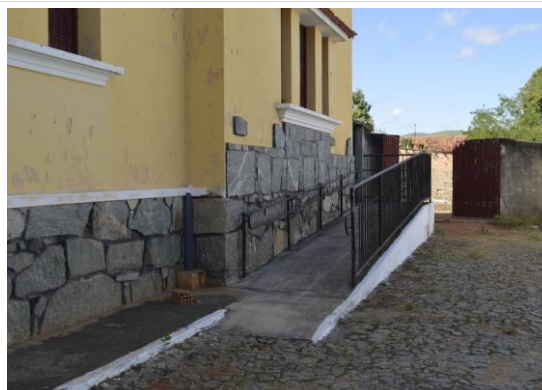
Pará de Minas Escola Estadual Fernando Otávio Trecho que o passeio dá lugar a uma rampa para acessibilidade. (foto 46) Imagem: Mateus Fonseca – 28/08/2020
