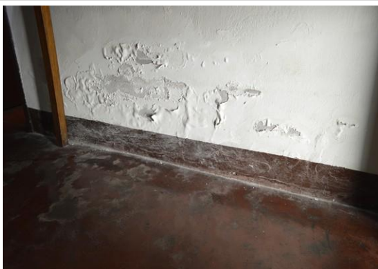
Pará de Minas MUSPAM Descolamento da pintura em parte da alvenaria interna. (foto 14) Imagem: Mateus Fonseca – 09/07/2020
