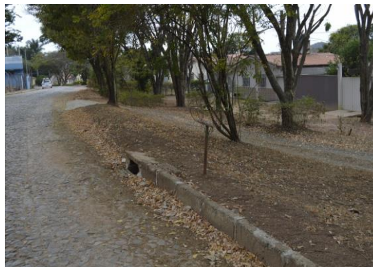
Pará de Minas Núcleo Histórico Urbano do Distrito de Ascensão Rua Raimundo Penaforte de Araújo, presença de boca de lobo. (foto 15) Imagem: Mateus Fonseca – 24/08/2020
