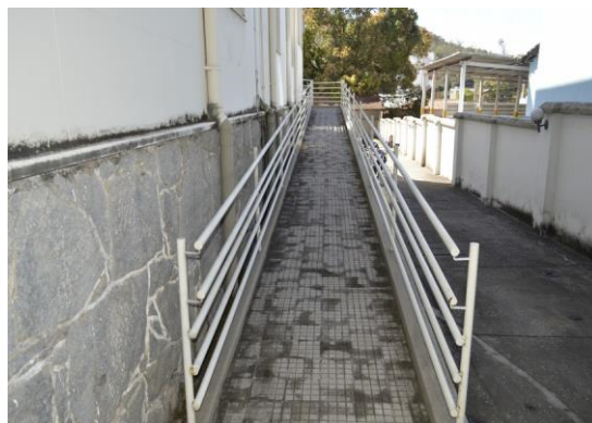
Pará de Minas Fórum Desembargador Pedro Nestor Rampa de acessibilidade na fachada lateral direita. (foto 43) Imagem: Mateus Fonseca – 06/08/2020
