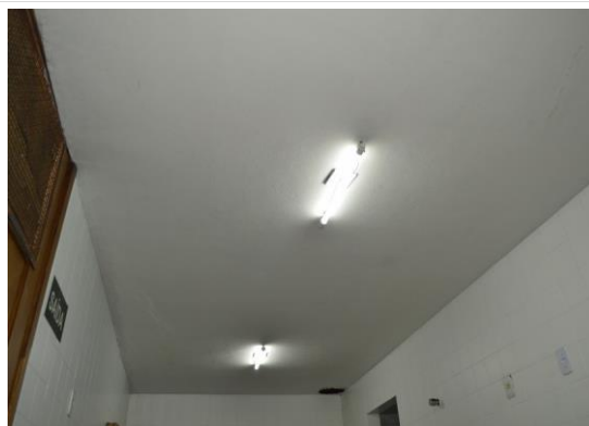
Pará de Minas Estação Ferroviária Iluminação interna em bom estado. (foto 64) Imagem: Mateus Fonseca – 27/07/2020
