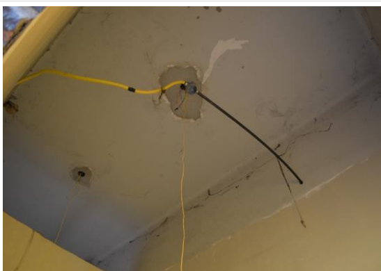
Pará de Minas Escola Estadual Fernando Otávio Instalações elétricas sem finalização. (foto 47) Imagem: Mateus Fonseca – 28/08/2020
