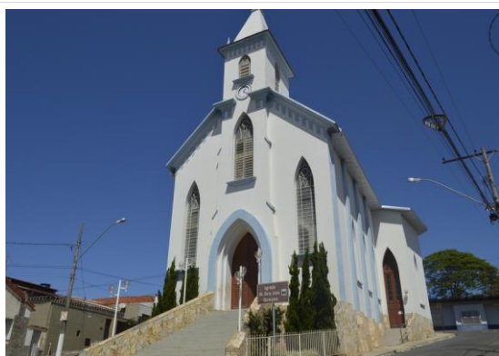
Pará de Minas Igreja Nossa Senhora das Graças Pintura externa aparentando desbotada. (foto 12) Imagem: Mateus Fonseca – 04/09/2020
