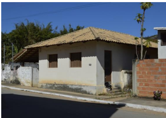
Pará de Minas Núcleo Histórico Urbano do Distrito de Carioca Edificação à Rua Dona Maria Lopes Cançado, 68 (foto 43) Imagem: Mateus Fonseca – 07/08/2020
