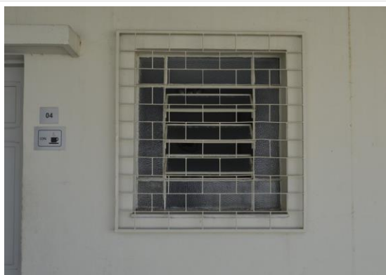
Pará de Minas Fórum Desembargador Pedro Nestor Janela em metal e vidro protegida por gradil localizada no porão. (foto 25) Imagem: Mateus Fonseca – 06/08/2020
