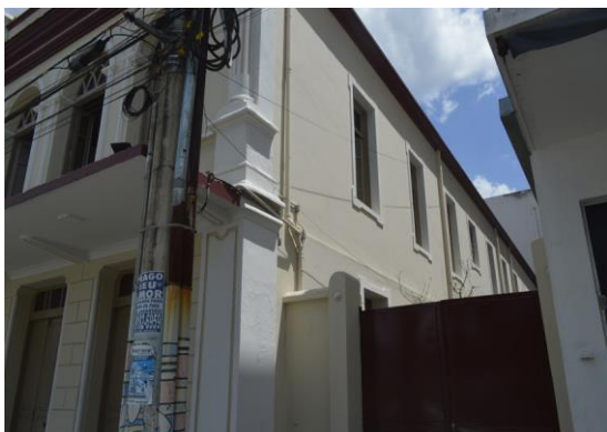
Pará de Minas Prédio Juscelino Kubitschek de Oliveira – Casa da Cultura Fachada lateral direita. (foto 02) Imagem: Mateus Fonseca – 27/10/2020
