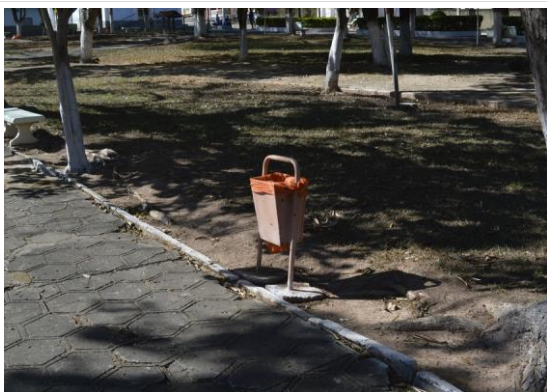
Pará de Minas Núcleo Histórico Urbano do Distrito de Carioca Lixeira em metal em bom estado de conservação necessitando apenas de renovação da camada pictórica.
