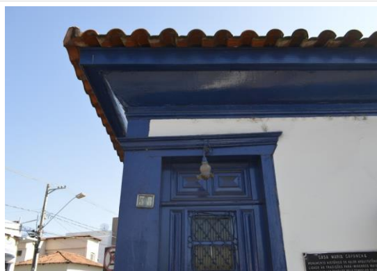
Pará de Minas Casa Maria Capanema Sobreverga em madeira restaurada exhibe bom estado de conservação. (foto 33) Imagem: Mateus Fonseca – 10/07/2020
