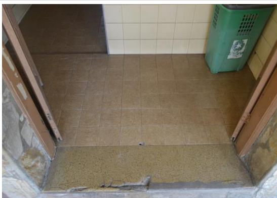
Pará de Minas Escola Estadual Torquato de Almeida Cerâmica comum aos banheiros da edificação. (foto 29) Imagem: Mateus Fonseca – 11/11/2020
