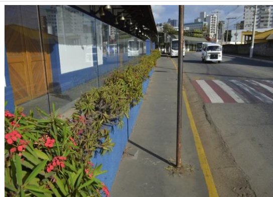
Pará de Minas Estação Ferroviária Passeio na fachada posterior da edificação apresenta sujidades naturais do uso. (foto 60) Imagem: Mateus Fonseca – 27/07/2020
