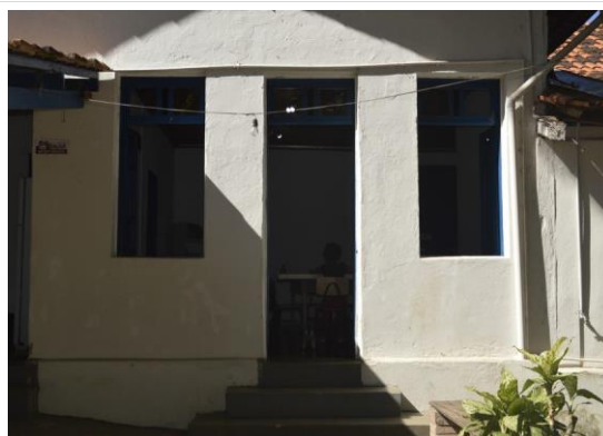
Pará de Minas Escola Municipal de Artes e Ofícios Raimundo Nogueira de Faria - SICA Escada de acesso à varanda e ao quintal. (foto 43) Imagem: Mateus Fonseca – 04/09/2020
