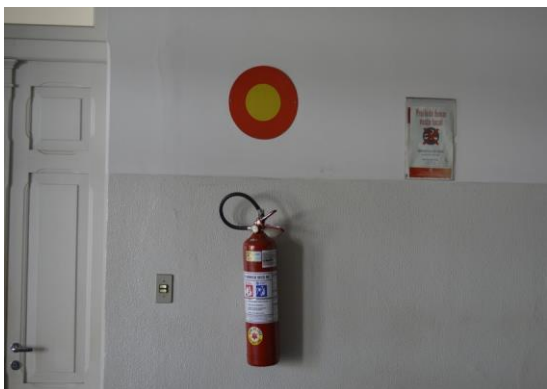
Pará de Minas Fórum Desembargador Pedro Nestor Extintor de incêndio instalados no 1º pavimento da edificação. (foto 51) Imagem: Mateus Fonseca – 06/08/2020
