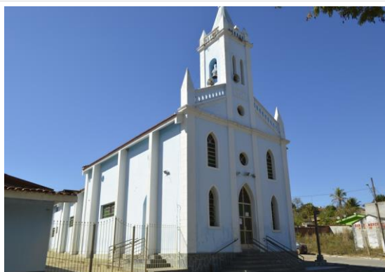
Pará de Minas Núcleo Histórico Urbano do Distrito de Carioca Fachada lateral esquerda da Igreja Nossa Senhora de Lourdes (foto 57) Imagem: Mateus Fonseca – 07/08/2020
