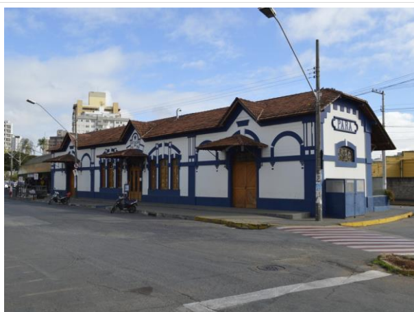
Pará de Minas Estação Ferroviária Fachada Frontal. (foto 01) Imagem: Mateus Fonseca – 27/07/2020
