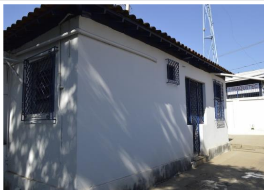
Pará de Minas Casa Maria Capanema Fachada lateral direita com camada pictórica apenas com algumas manchas de sujidade devido a exposição as intempéries (foto 14) Imagem: Mateus Fonseca – 10/07/2020
