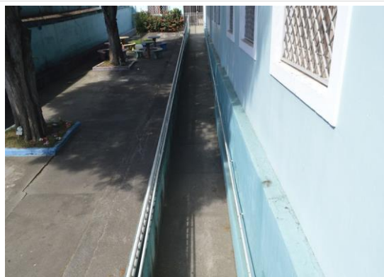
Pará de Minas Escola Estadual Torquato de Almeida Rampa na lateral direita que oferece acessibilidade ao bem. (foto 36) Imagem: Mateus Fonseca – 11/11/2020
