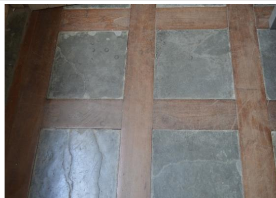
Pará de Minas Prédio Juscelino Kubitschek de Oliveira – Casa da Cultura Piso em ardósia presente em alguns cômodos do térreo. (foto 36) Imagem: Mateus Fonseca – 27/10/2020
