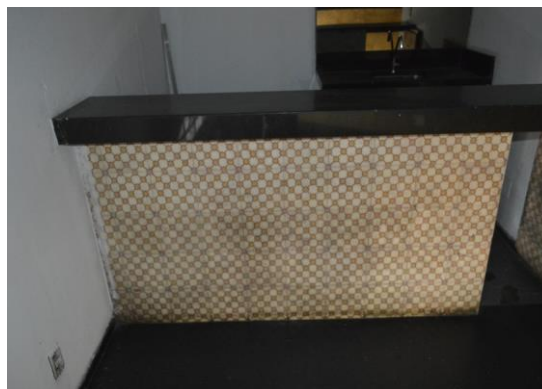
Pará de Minas Estação Ferroviária Ladrilhos no balcão do mezanino exibindo manchas permanentes porém em maior parte apresenta bom estado. (foto 24) Imagem: Mateus Fonseca – 27/07/2020
