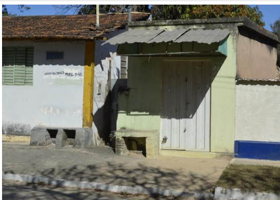
Pará de Minas Núcleo Histórico Urbano do Distrito de Carioca Bancos encostados nas edificações na Rua São Francisco. (foto 28) Imagem: Mateus Fonseca – 07/08/2020
