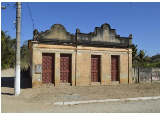
Pará de Minas Núcleo Histórico Urbano do Distrito de Carioca Edificação à Rua São Francisco, 101 (foto 53) Imagem: Mateus Fonseca – 07/08/2020
