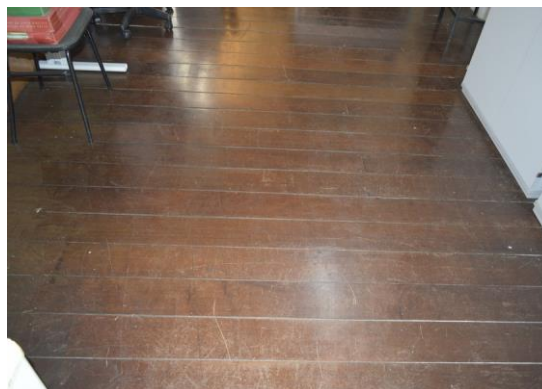
Pará de Minas Escola Estadual Torquato de Almeida Piso em madeira da biblioteca. (foto 28) Imagem: Mateus Fonseca – 11/11/2020
