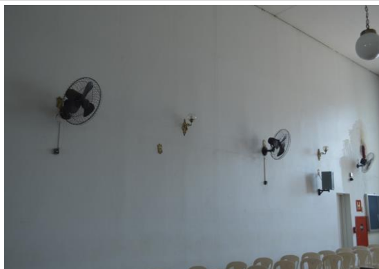
Pará de Minas Asilo Padre José Pereira Coelho Alvenarias do interior da Capela de Santo Antônio estão em bom estado de conservação. (foto 09) Imagem: Mateus Fonseca – 30/09/2020
