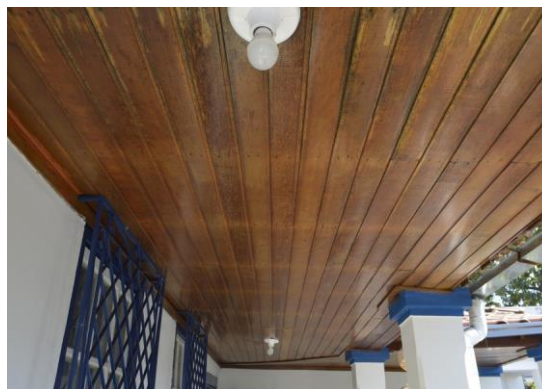
Pará de Minas Casa Maria Capanema Forro da varanda em bom estado de conservação. (foto 42) Imagem: Mateus Fonseca – 10/07/2020
