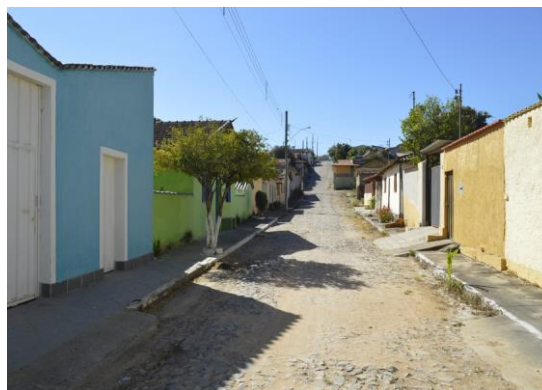
Pará de Minas Núcleo Histórico Urbano do Distrito de Carioca Vista da via Dom Bosco em pé de moleque, com acúmulo de terra e areia. (foto 07) Imagem: Mateus Fonseca – 07/08/2020
