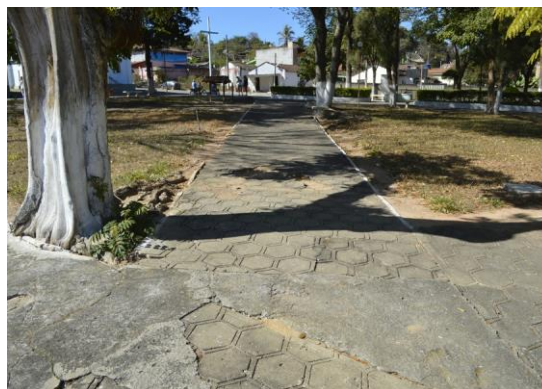
Pará de Minas Núcleo Histórico Urbano do Distrito de Carioca Piso em concreto com textura assemelhando-se ao intertravado na Pç N. Sra. de Lourdes. (foto 68) Imagem: Mateus Fonseca – 07/08/2020
