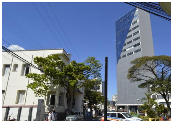
Pará de Minas Fórum Desembargador Pedro Nestor Grande edifício comercial no entorno do bem. (foto 53) Imagem: Mateus Fonseca – 06/08/2020
