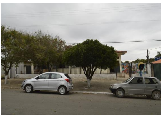
Pará de Minas Núcleo Histórico Urbano do Distrito de Ascensão Edificação à Avenida Abdon Senen de Araújo, 100. (foto 40)
