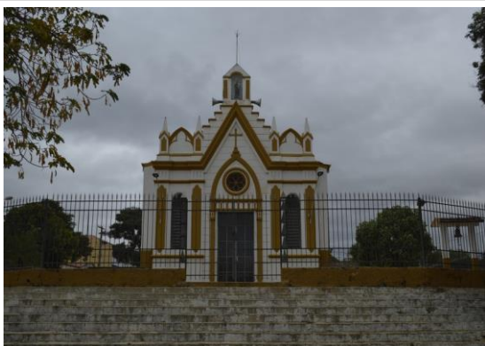
Pará de Minas Núcleo Histórico Urbano do Distrito de Ascensão Vista frontal da Igreja de Santo Antônio. (foto 102) Imagem: Mateus Fonseca – 24/08/2020
