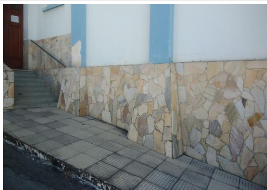
Pará de Minas Igreja Nossa Senhora das Graças Vista da alvenaria externa. (foto 09) Imagem: Mateus Fonseca – 04/09/2020
