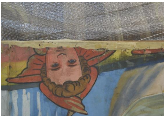
Pará de Minas Telas da Antiga Matriz de Nossa Senhora da Piedade Detalhe exibindo craquelês, desprendimentos rasgo no tecido e acúmulo de tinta. (foto 22) Imagem: Mateus Fonseca – 23/09/2020
