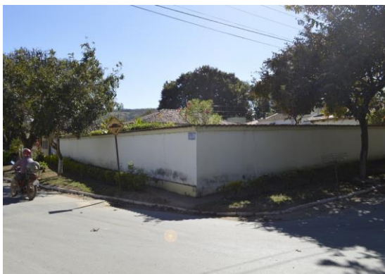
Pará de Minas Núcleo Histórico Urbano do Distrito de Carioca Trecho da Rua São Francisco exibindo paisagismo com arbustos e vegetação de médio porte. (foto 16) Imagem: Mateus Fonseca – 07/08/2020
