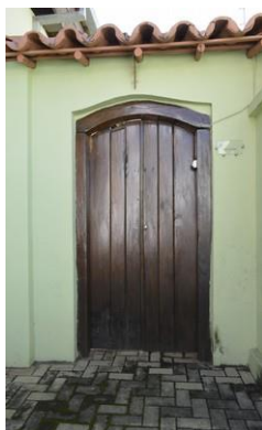
Pará de Minas MUSPAM Portão a direita na fachada frontal da edificação se encontra em bom estado de conservação. (foto 47) Imagem: Mateus Fonseca – 09/07/2020
