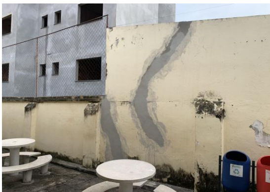
Pará de Minas Escola Estadual Governador Valadares Muro lateral direito exibindo trinca restaurada decorrente de abalo provocado pela construção vizinha. (foto 44) Imagem: Mateus Fonseca – 19/08/2020
