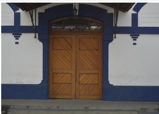
Pará de Minas Estação Ferroviária Porta de madeira ao lado esquerdo na fachada frontal exibe recortes nas folhas executados anteriormente a retomada do bem pelo município. (foto 27) Imagem: Mateus Fonseca – 27/07/2020
