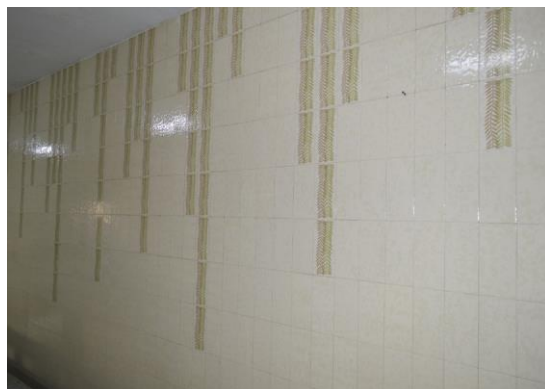
Pará de Minas Escola Estadual Torquato de Almeida Cerâmicas que revestem as paredes do refeitório. (foto 17) Imagem: Mateus Fonseca – 11/11/2020
