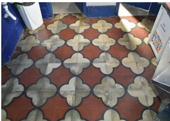
Pará de Minas Escola Municipal de Artes e Ofícios Raimundo Nogueira de Faria - SICA Ladrilho hidráulico no hall dos banheiros. (foto 33) Imagem: Mateus Fonseca – 04/09/2020
