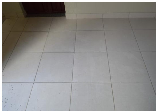
Pará de Minas Escola Estadual Fernando Otávio Piso cerâmico nos banheiros. (foto 36) Imagem: Mateus Fonseca – 28/08/2020
