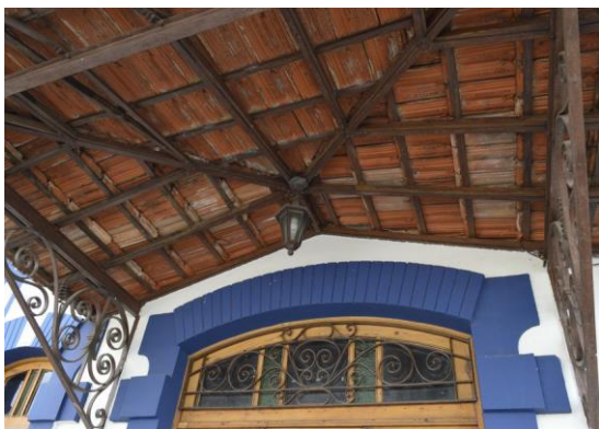
Pará de Minas Estação Ferroviária Iluminação externa em bom estado. (foto 65) Imagem: Mateus Fonseca – 27/07/2020
