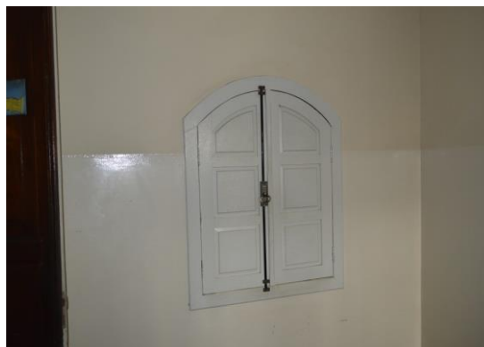
Pará de Minas Escola Estadual Governador Valadares Janela entre o hall de entrada e os claustros. (foto 21) Imagem: Mateus Fonseca – 19/08/2020
