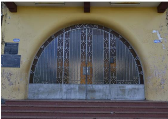
Pará de Minas Escola Estadual Fernando Otávio Porta de acesso principal à edificação em metal e vidro. (foto 21) Imagem: Mateus Fonseca – 28/08/2020
