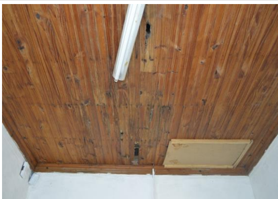
Pará de Minas Escola Municipal de Artes e Ofícios Raimundo Nogueira de Faria - SICA Forro de madeira apresentando pontos de apodrecimento do material. (foto 38) Imagem: Mateus Fonseca – 04/09/2020
