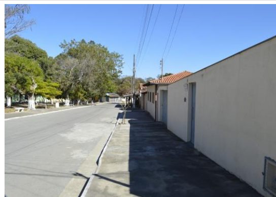
Pará de Minas Núcleo Histórico Urbano do Distrito de Carioca Passeio largo e rampa de acessibilidade na via Praça Nossa Senhora de Lourdes.. (foto 21) Imagem: Mateus Fonseca – 07/08/2020
