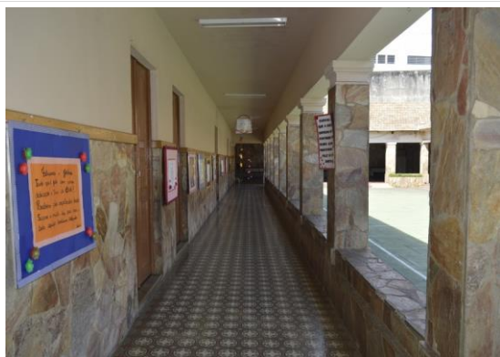
Pará de Minas Escola Estadual Torquato de Almeida Pintura a base de água nas alvenarias e na laje. (foto 13) Imagem: Mateus Fonseca – 11/11/2020
