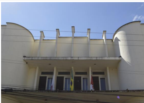
Pará de Minas Fórum Desembargador Pedro Nestor Sacada do primeiro pavimento pavimento exhibe apenas sujidades nos beirais. (foto 41) Imagem: Mateus Fonseca – 06/08/2020
