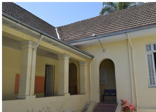
Pará de Minas Escola Estadual Governador Valadares Condutores de águas pluviais e guarda-pó. (foto 09) Imagem: Mateus Fonseca – 19/08/2020
