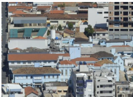
Pará de Minas Irmandade Nossa Senhora da Conceição – Hospital Manto de cobertura em telhas cerâmicas. (foto 06) Imagem: Mateus Fonseca – 18/09/2020
