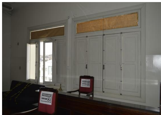
Pará de Minas Fórum Desembargador Pedro Nestor Janelas do primeiro pavimento em madeira. (foto 20) Imagem: Mateus Fonseca – 06/08/2020
