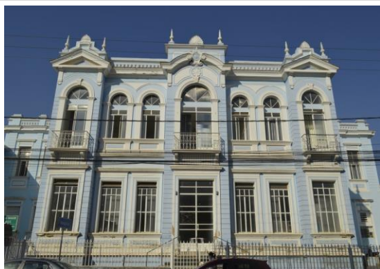
Pará de Minas Irmandade Nossa Senhora da Conceição – Hospital Vista externa da edificação. (foto 04) Imagem: Mateus Fonseca – 18/09/2020
