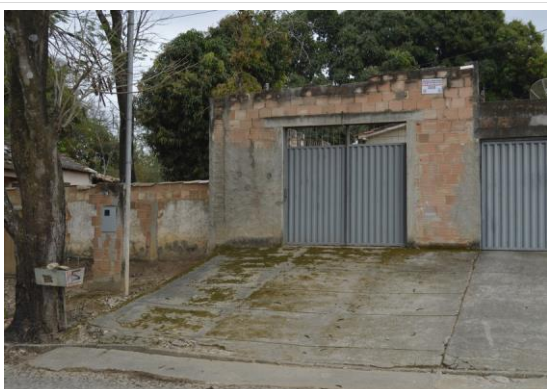
Par  de Minas N cleo Hist rico Urbano do Distrito de Ascens o Edifica o   Avenida Presidente Kubitschek, s/n (Lateral 210). (foto 60) Imagem: Mateus Fonseca – 24/08/2020
