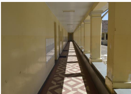
Pará de Minas Escola Estadual Governador Valadares Descolamento da pintura. (foto 14) Imagem: Mateus Fonseca – 19/08/2020
