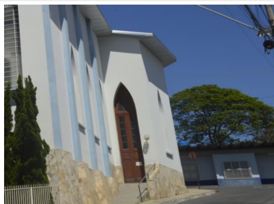
Pará de Minas Igreja Nossa Senhora das Graças Porta de entrada lateral em madeira e vidro. (foto 17) Imagem: Mateus Fonseca – 04/09/2020
