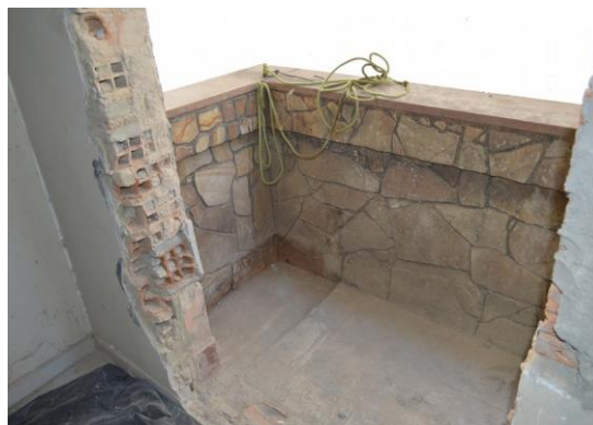
Pará de Minas Centro Literário Pedro Nestor Pedra ouro preto no guarda-corpo das sacadas. (foto 16)
