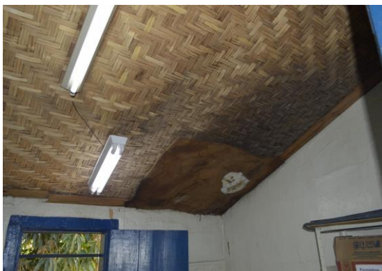
Pará de Minas Escola Municipal de Artes e Ofícios Raimundo Nogueira de Faria - SICA Forro em esteira trançada danificado por infiltração. (foto 40) Imagem: Mateus Fonseca – 04/09/2020
