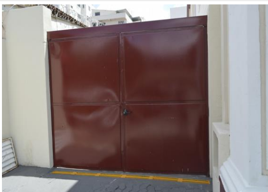
Pará de Minas Prédio Juscelino Kubitschek de Oliveira – Casa da Cultura Portão de metal de acesso a lateral esquerda. (foto 27) Imagem: Mateus Fonseca – 27/10/2020
