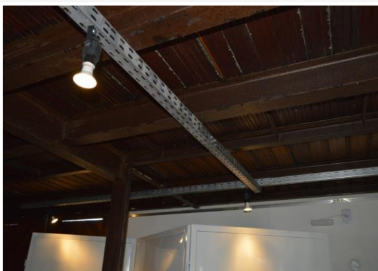
Pará de Minas Estação Ferroviária Iluminação direcionável feita através de eletrocalhas. (foto 63) Imagem: Mateus Fonseca – 27/07/2020
