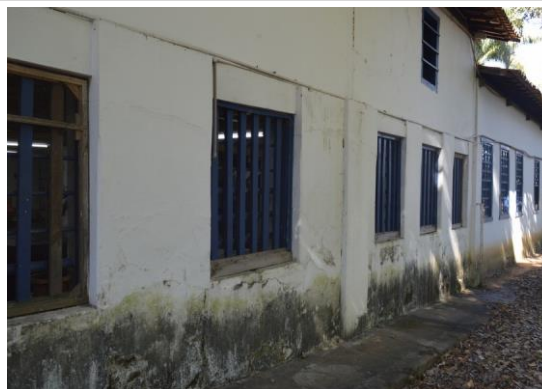
Pará de Minas Escola Municipal de Artes e Ofícios Raimundo Nogueira de Faria - SICA Alvenaria externa da fachada posterior. (foto 08) Imagem: Mateus Fonseca – 04/09/2020
