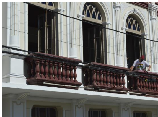
Pará de Minas Prédio Juscelino Kubitschek de Oliveira – Casa da Cultura Elementos artísticos da fachada recebem pintura a base de água e a óleo. (foto 16) Imagem: Mateus Fonseca – 27/10/2020
