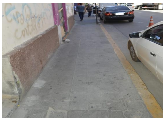
Pará de Minas Centro Literário Pedro Nestor Calçada com piso cimentício. (foto 33)
