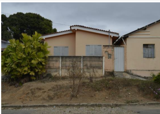
Par  de Minas N cleo Hist rico Urbano do Distrito de Ascens o Edifica o   Avenida Presidente Kubitschek, s/n (lateral 160). (foto 58) Imagem: Mateus Fonseca – 24/08/2020
