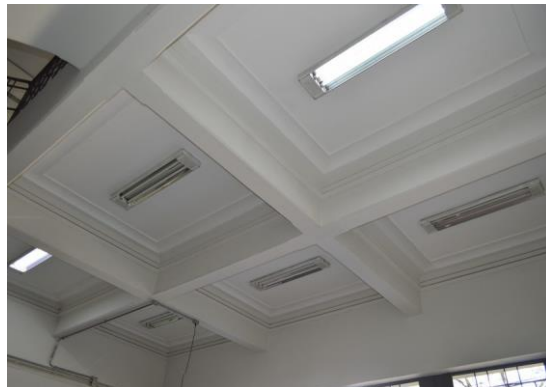
Pará de Minas Fórum Desembargador Pedro Nestor Pintura à base de água no forro do pavimento térreo. (foto 12) Imagem: Mateus Fonseca – 06/08/2020
