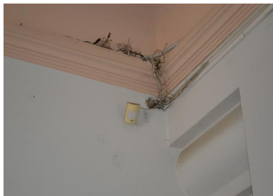
Pará de Minas Escola Estadual Fernando Otávio Sensor do alarme de segurança. (foto 50) Imagem: Mateus Fonseca – 28/08/2020
