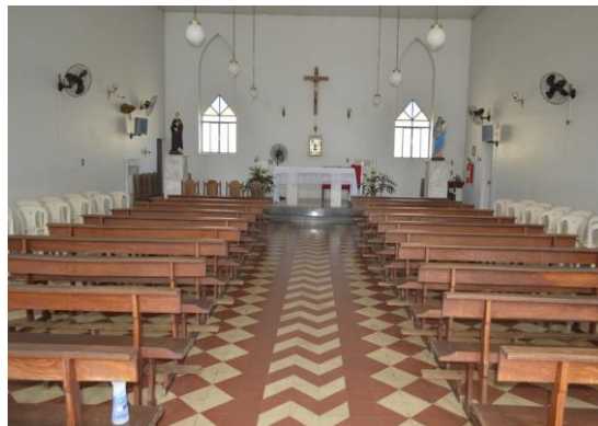
Pará de Minas Asilo Padre José Pereira Coelho Reboco e pinturas à base de água do interior da Capela em bom estado de conservação. (foto 12) Imagem: Mateus Fonseca – 30/09/2020
