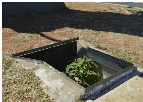
Pará de Minas Cristo Redentor Grades de proteção da iluminação se encontram danificadas ou ausentes, e tem crescido mato onde deveria haver iluminação. (foto 16) Imagem: Mateus Fonseca – 03/08/2020
