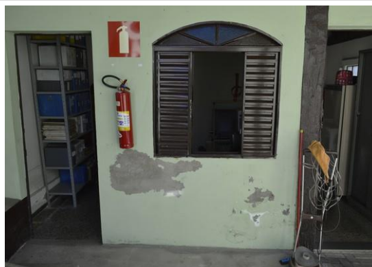
Pará de Minas MUSPAM Descolamento da pintura externa causado pela umidade. (foto 15) Imagem: Mateus Fonseca – 09/07/2020
