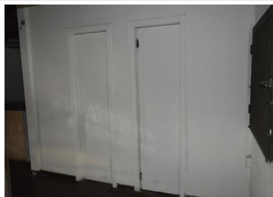
Pará de Minas Estação Ferroviária Portas dos banheiros do mezanino feitas em madeira e com enquadramento também em madeira em bom estado apenas com algumas sujidades na pintura na borda inferior. (foto 36) Imagem: Mateus Fonseca – 27/07/2020
