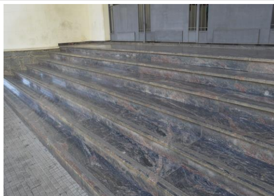
Pará de Minas Fórum Desembargador Pedro Nestor Detalhe da escada na fachada frontal do Fórum. (foto 42) Imagem: Mateus Fonseca – 06/08/2020
