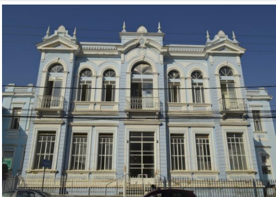
Pará de Minas Irmandade Nossa Senhora da Conceição – Hospital Portas e janelas em metal e vidro com enquadramento em massa na fachada frontal.
