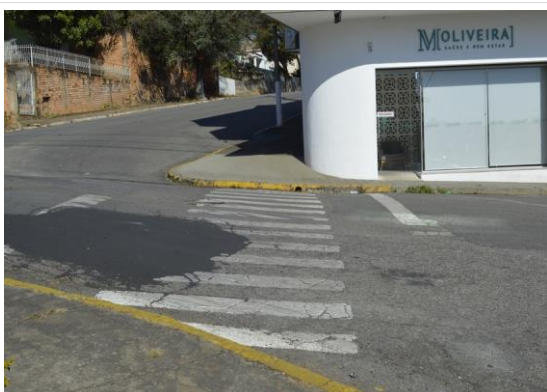
Pará de Minas Gruta de Nossa Senhora de Lourdes A única faixa de pedestre da Praça, na via Praça Francisco Valadares, não apresenta rampas de acessibilidade. (foto 21) Imagem: Mateus Fonseca – 10/07/2020
