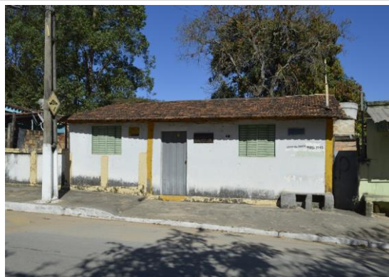
Pará de Minas Núcleo Histórico Urbano do Distrito de Carioca Edificação à Rua São Francisco, 7 (foto 50) Imagem: Mateus Fonseca – 07/08/2020
