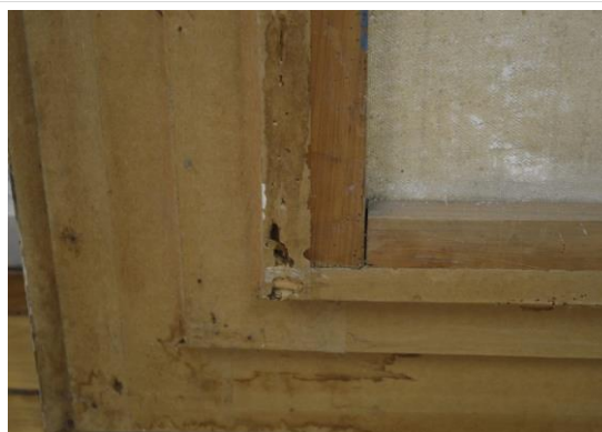
Pará de Minas Telas da Antiga Matriz de Nossa Senhora da Piedade Aplicação de cupinicida no Chassi com finalidade de controlar o ataque dos insetos. (foto 36) Imagem: Mateus Fonseca – 23/09/2020
