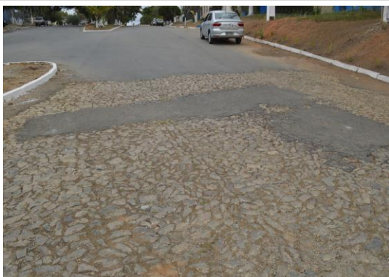
Pará de Minas Núcleo Histórico Urbano do Distrito de Ascensão Pavimentação asfáltica dá lugar ao pé de moleque na Rua Abdon Senen de Araújo remendos asfáltico sobre pé de moleque na Rua Raimundo Penaforte de Araújo. (foto 02) Imagem: Mateus Fonseca – 24/08/2020
