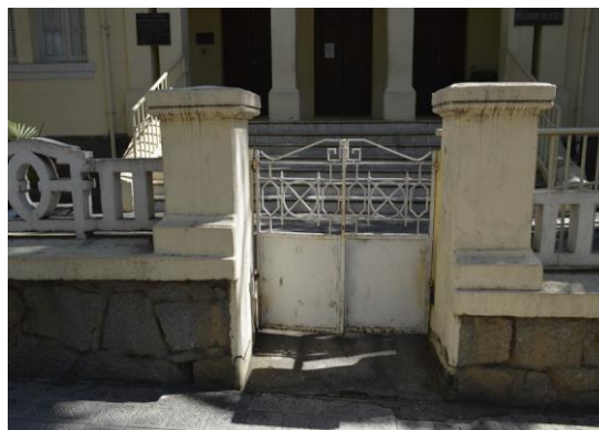
Pará de Minas Escola Estadual Governador Valadares Portal de metal na fachada frontal. (foto 47) Imagem: Mateus Fonseca – 19/08/2020
