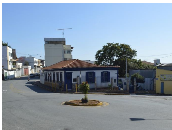
Pará de Minas Casa Maria Capanema Fachada Frontal e lateral Direita da edificação. (foto 01) Imagem: Mateus Fonseca – 10/07/2020
