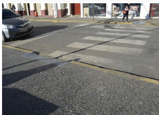
Pará de Minas Praças Torquato de Almeida e Francisco Torquato Faixa de pedestre que conecta as praças ao Prédio Juscelino Kubitschek de Oliveira (foto 17) Imagem: Mateus Fonseca – 29/07/2020
