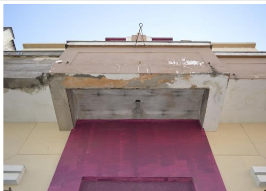
Pará de Minas Centro Literário Pedro Nestor Sacada necessitando de pintura. (foto 30) Imagem: Mateus Fonseca – 03/09/2020
