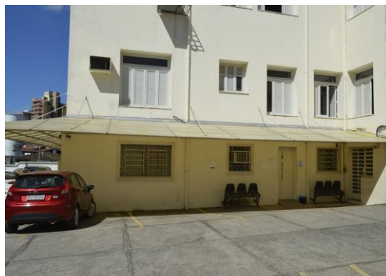
Pará de Minas Fórum Desembargador Pedro Nestor Vista das alvenarias externas, fachada lateral em esquerda. (foto 10) Imagem: Mateus Fonseca – 06/08/2020
