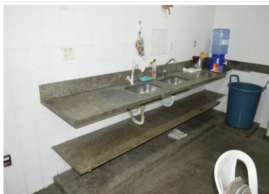
Pará de Minas Estação Ferroviária Instalações hidráulicas da cozinha em funcionamento. (foto 68) Imagem: Mateus Fonseca – 27/07/2020
