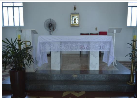
Pará de Minas Asilo Padre José Pereira Coelho Mármore revestindo altar e púlpito em bom estado de conservação.
