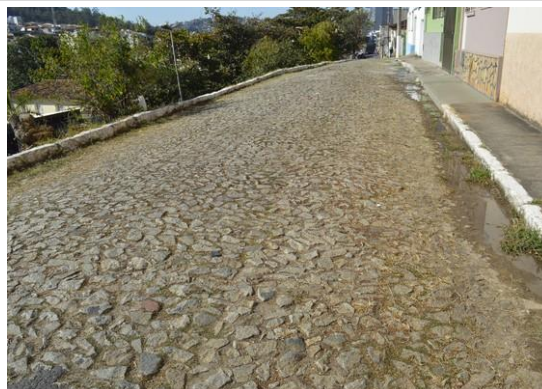
Pará de Minas Gruta de Nossa Senhora de Lourdes Via Praça Francisco Valadares exibindo via sem sarjetas. (foto 11) Imagem: Mateus Fonseca – 10/07/2020
