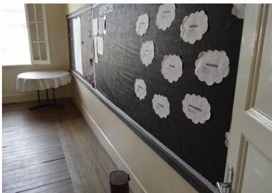
Pará de Minas Escola Estadual Governador Valadares Alvenarias internas. (foto 12) Imagem: Mateus Fonseca – 19/08/2020
