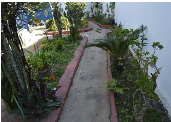
Pará de Minas Casa Maria Capanema Piso cimentado exibe trincas e manchas causadas pela exposição à umidade. (foto 35) Imagem: Mateus Fonseca – 10/07/2020
