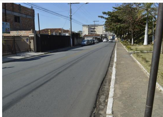
Pará de Minas Gruta de Nossa Senhora de Lourdes Sarjeta na Rua Fernando Otávio em bom estado de conservação. (foto 09) Imagem: Mateus Fonseca – 10/07/2020
