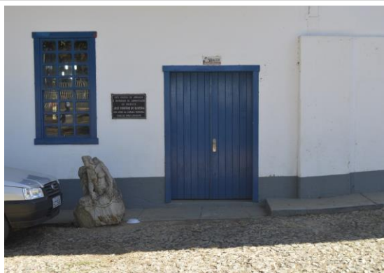
Pará de Minas Escola Municipal de Artes e Ofícios Raimundo Nogueira de Faria - SICA Porta de madeira de duas folhas de acesso direto às oficinas. (foto 23) Imagem: Mateus Fonseca – 04/09/2020
