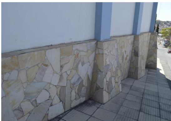
Pará de Minas Igreja Nossa Senhora das Graças A estrutura de concreto armado do bem se apresenta íntegra. (foto 05) Imagem: Mateus Fonseca – 04/09/2020
