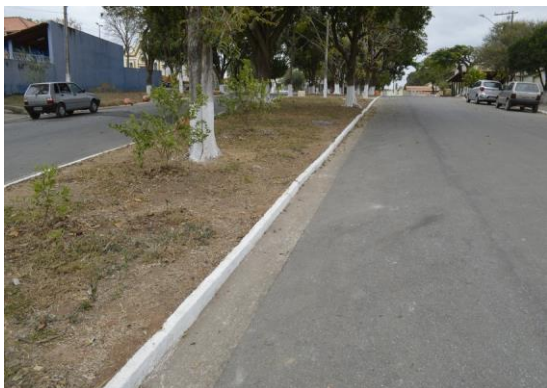
Pará de Minas Núcleo Histórico Urbano do Distrito de Ascensão Sarjetas da Rua Abdon Senem de Araújo.. (foto 14) Imagem: Mateus Fonseca – 24/08/2020
