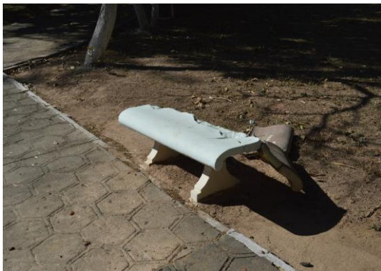
Pará de Minas Núcleo Histórico Urbano do Distrito de Carioca Banco em concreto com perda de material.
