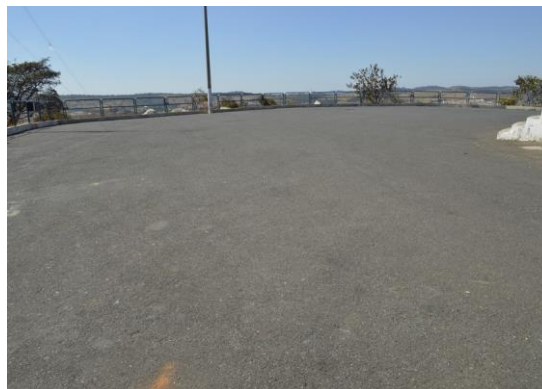
Pará de Minas Cristo Redentor Camada asfáltica do entorno bem conservada. (foto 18) Imagem: Mateus Fonseca – 03/08/2020
