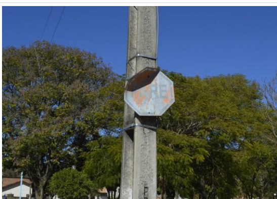
Pará de Minas Núcleo Histórico Urbano do Distrito de Carioca Placa de trânsito com alguma oxidação e desgaste da camada pictórica. (foto 10) Imagem: Mateus Fonseca – 07/08/2020
