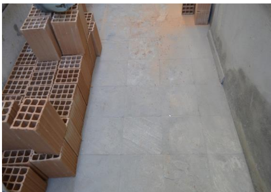
Pará de Minas Centro Literário Pedro Nestor Piso em pedra ouro preto nas áreas externas. (foto 23) Imagem: Mateus Fonseca – 03/09/2020
