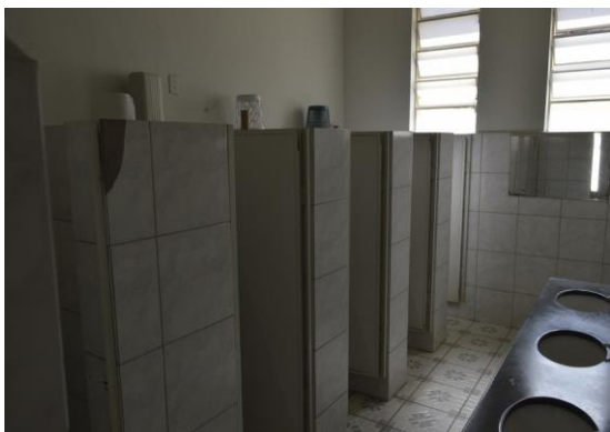
Pará de Minas Escola Estadual Governador Valadares Instalações hidráulicas em bom funcionamento. (foto 49) Imagem: Mateus Fonseca – 19/08/2020
