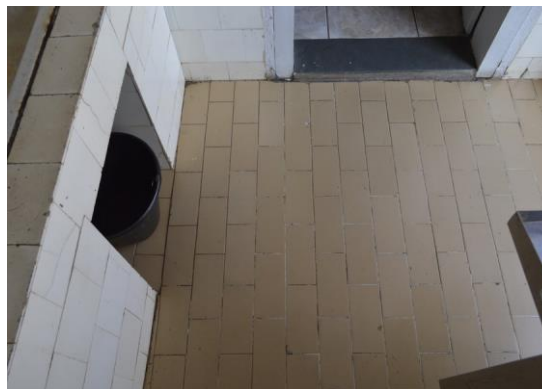
Pará de Minas Casa Maria Capanema Cerâmica em pequeno hall que dá acesso ao quintal nos fundos apresenta trinca e rejunte desgastado. (foto 36) Imagem: Mateus Fonseca – 10/07/2020
