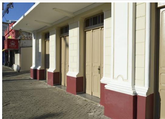
Pará de Minas Prédio Juscelino Kubitschek de Oliveira – Casa da Cultura Pintura da fachada frontal a base de água e a óleo. (foto 14) Imagem: Mateus Fonseca – 27/10/2020
