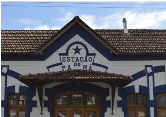
Pará de Minas Estação Ferroviária Frontão central em bom estado de conservação. (foto 09) Imagem: Mateus Fonseca – 27/07/2020
