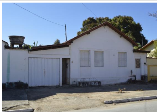
Pará de Minas Núcleo Histórico Urbano do Distrito de Carioca Edificação à Rua São Francisco, 56 (foto 52) Imagem: Mateus Fonseca – 07/08/2020
