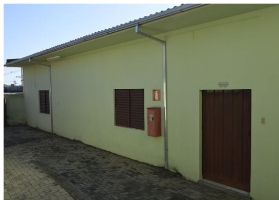
Pará de Minas MUSPAM Depósitos nos fundos o terreno do bem tombado foi feito nova pintura e apresenta bom estado de conservação. (foto 48) Imagem: Mateus Fonseca – 09/07/2020
