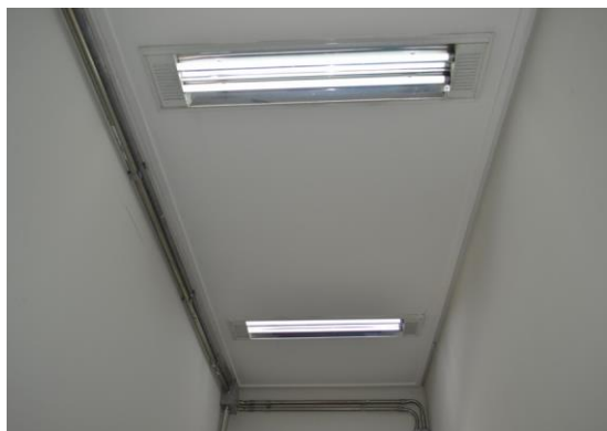
Pará de Minas Fórum Desembargador Pedro Nestor Instalações elétricas bem-acondicionadas, seguindo orientações de segurança e do Conselho do Patrimônio. (foto 47) Imagem: Mateus Fonseca – 06/08/2020
