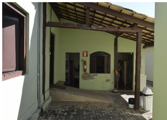
Pará de Minas MUSPAM Os condutores de águas pluviais se apresentam bem conservados. (foto 10) Imagem: Mateus Fonseca – 09/07/2020
