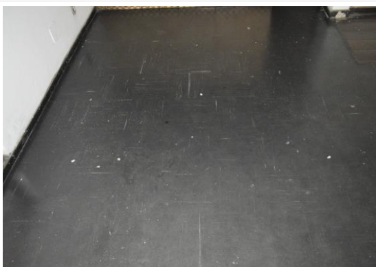
Pará de Minas Estação Ferroviária Piso emborrachado no mezanino exibindo leve desgaste. (foto 51) Imagem: Mateus Fonseca – 27/07/2020
