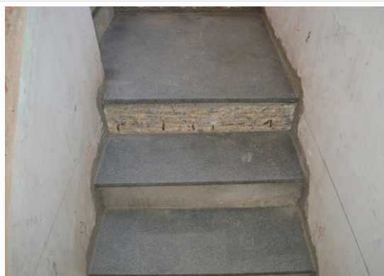
Pará de Minas Centro Literário Pedro Nestor Piso da escada em granito. (foto 26) Imagem: Mateus Fonseca – 03/09/2020
