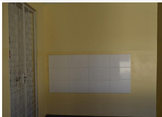
Pará de Minas Escola Estadual Governador Valadares Cerâmica nas paredes dos corredores, utilizadas para fixação de cartazes. (foto 15) Imagem: Mateus Fonseca – 19/08/2020
