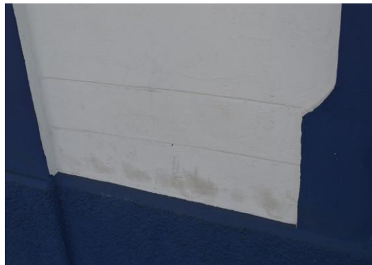
Pará de Minas Estação Ferroviária Detalhe das sujidades na fachada frontal. (foto 16) Imagem: Mateus Fonseca – 27/07/2020
