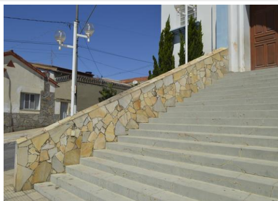
Pará de Minas Igreja Nossa Senhora das Graças Escada de acesso na fachada frontal. (foto 35) Imagem: Mateus Fonseca – 04/09/2020
