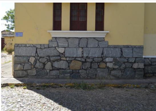
Pará de Minas Escola Estadual Fernando Otávio barrado em pedras marcam o baldrame na fachada. (foto 15) Imagem: Mateus Fonseca – 28/08/2020
