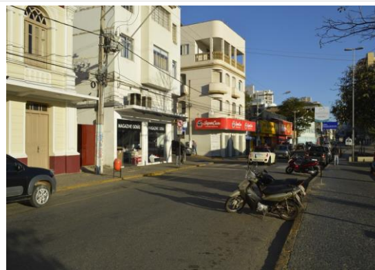
Pará de Minas Prédio Juscelino Kubitschek de Oliveira – Casa da Cultura Vista com sentido noroeste onde se observam edificações de até 15 pav. e trânsito intenso. (foto 55) Imagem: Mateus Fonseca – 27/10/2020
