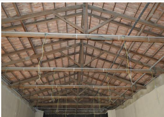
Pará de Minas Centro Literário Pedro Nestor Manto da cobertura e madeiramento em bom estado, exibe apenas manchas de umidade. (foto 05) Imagem: Mateus Fonseca – 03/09/2020
