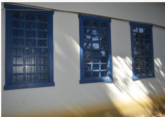
Pará de Minas Escola Municipal de Artes e Ofícios Raimundo Nogueira de Faria - SICA Vista da fachada posterior das janelas guilhotina das oficinas. (foto 27) Imagem: Mateus Fonseca – 04/09/2020
