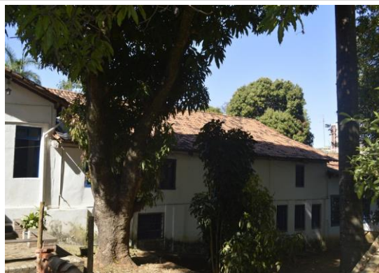
Pará de Minas Escola Municipal de Artes e Ofícios Raimundo Nogueira de Faria - SICA Fachada posterior (foto 04) Imagem: Mateus Fonseca – 04/09/2020
