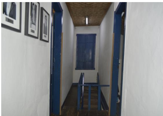
Pará de Minas Escola Municipal de Artes e Ofícios Raimundo Nogueira de Faria - SICA Reboco e pintura a base de água nas alvenarias e pintura a óleo nas madeiras de portas, janelas e guarda-corpo. (foto 17) Imagem: Mateus Fonseca – 04/09/2020
