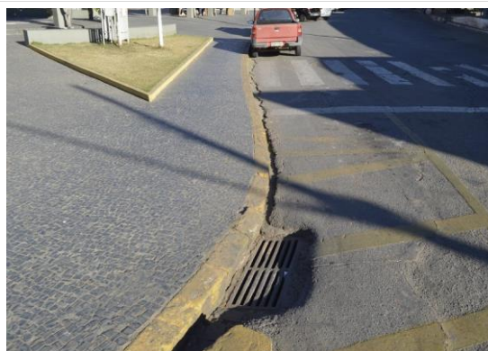
Pará de Minas Praças Torquato de Almeida e Francisco Torquato A cobertura asfáltica sobrepôs a sarjeta que se tonou uma canaleta. (foto 11) Imagem: Mateus Fonseca – 29/07/2020
