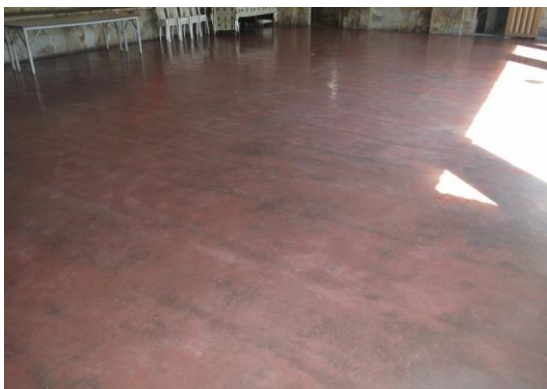
Pará de Minas Escola Estadual Torquato de Almeida Cimento vermelho do pátio coberto e palco. (foto 27) Imagem: Mateus Fonseca – 11/11/2020
