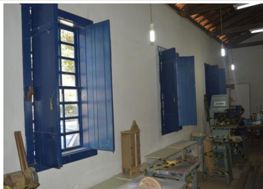
Pará de Minas Escola Municipal de Artes e Ofícios Raimundo Nogueira de Faria - SICA Vista interna das janelas guilhotina em madeira e vidro localizadas no porão. (foto 28) Imagem: Mateus Fonseca – 04/09/2020
