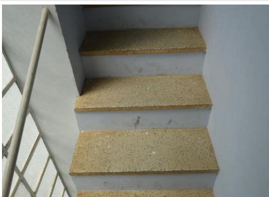
Pará de Minas Igreja Nossa Senhora das Graças Parte dos pisos da escada de acesso ao coro em marmorite. (foto 26) Imagem: Mateus Fonseca – 04/09/2020
