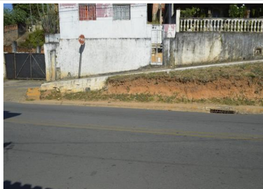
Pará de Minas Gruta de Nossa Senhora de Lourdes Extremo sul da Praça Francisco Valadares onde a cobertura necessita de intervenção. (foto 35) Imagem: Mateus Fonseca – 10/07/2020
