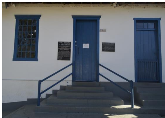
Pará de Minas Escola Municipal de Artes e Ofícios Raimundo Nogueira de Faria - SICA Pintura da fachada frontal. (foto 18) Imagem: Mateus Fonseca – 04/09/2020
