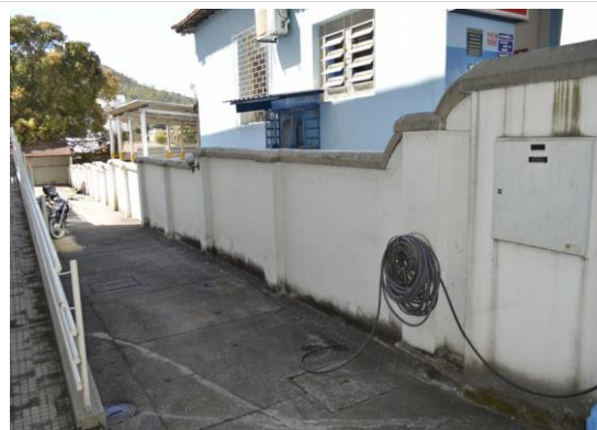
Pará de Minas Fórum Desembargador Pedro Nestor Muro da lateral direita exibindo mancha de limo na base. (foto 45) Imagem: Mateus Fonseca – 06/08/2020
