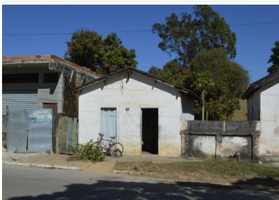
Pará de Minas Núcleo Histórico Urbano do Distrito de Carioca Edificação à via Praça Nossa Senhora de Lourdes, 76 (foto 39) Imagem: Mateus Fonseca – 07/08/2020
