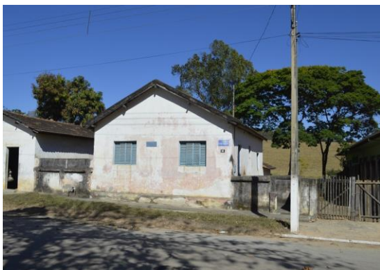
Pará de Minas Núcleo Histórico Urbano do Distrito de Carioca Edificação à via Praça Nossa Senhora de Lourdes, 66 (foto 37) Imagem: Mateus Fonseca – 07/08/2020
