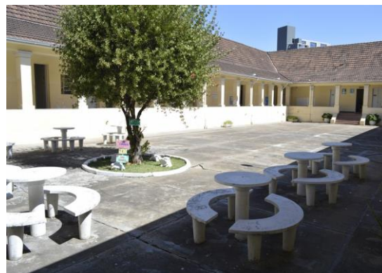
Pará de Minas Escola Estadual Governador Valadares Pátio interno com piso cimentado e mesas e bancos de concreto. (foto 43) Imagem: Mateus Fonseca – 19/08/2020
