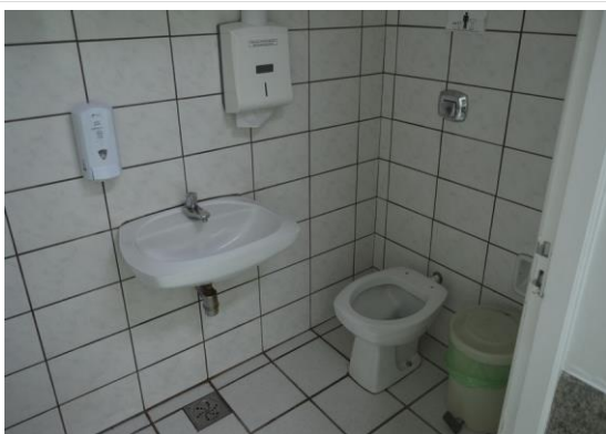
Pará de Minas Irmandade Nossa Senhora da Conceição – Hospital Revestimento cerâmico nos banheiros. (foto 11) Imagem: Mateus Fonseca – 18/09/2020
