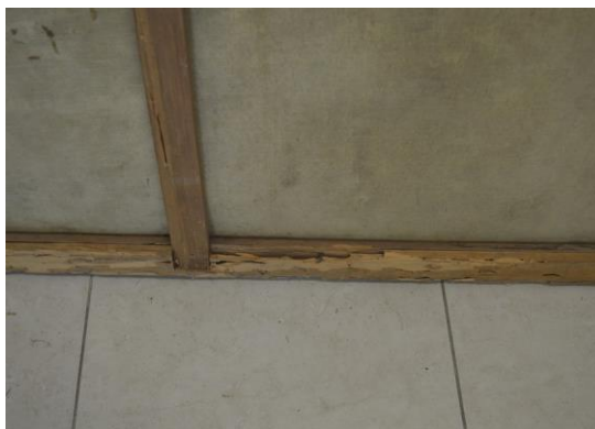
Pará de Minas Telas da Antiga Matriz de Nossa Senhora da Piedade Chassi sob ataque de insetos xilófagos reentelamento exibindo manchas e soltando do chassi. (foto 39) Imagem: Mateus Fonseca – 23/09/2020
