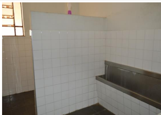
Pará de Minas Escola Estadual Fernando Otávio Revestimento cerâmico nos banheiros. (foto 18) Imagem: Mateus Fonseca – 28/08/2020
