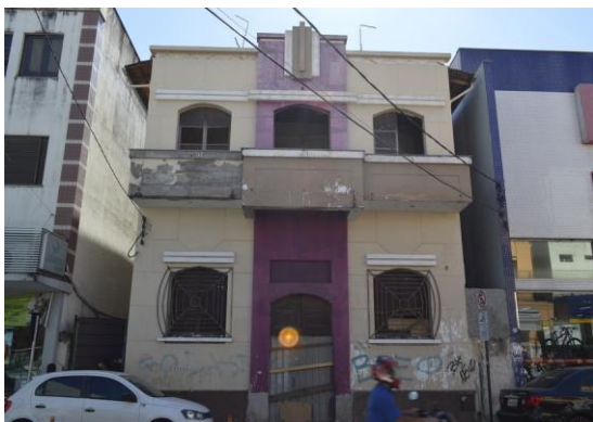
Pará de Minas Centro Literário Pedro Nestor Reboco da fachada frontal em bom estado. (foto 11) Imagem: Mateus Fonseca – 03/09/2020
