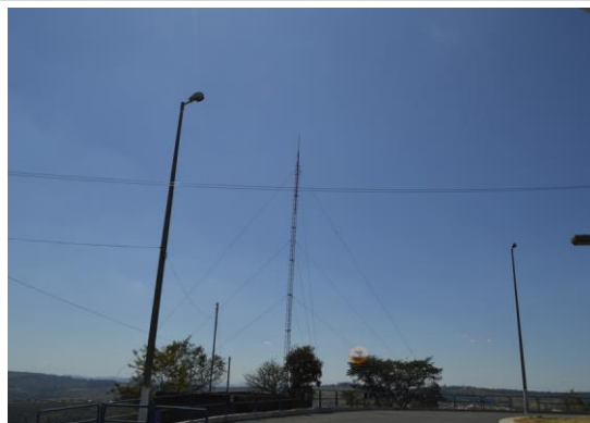
Pará de Minas Cristo Redentor Instalações elétricas dos posteamentos exibem em bom estado de conservação. (foto 23) Imagem: Mateus Fonseca – 03/08/2020
