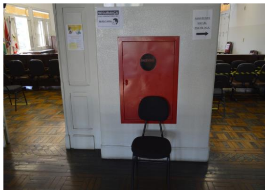
Pará de Minas Fórum Desembargador Pedro Nestor Hidrante instalado no 1º pavimento do bem. (foto 52) Imagem: Mateus Fonseca – 06/08/2020
