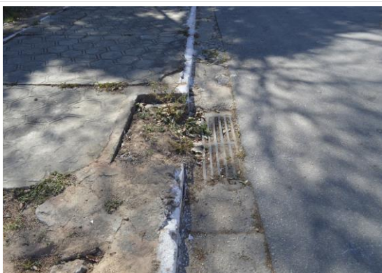
Pará de Minas Núcleo Histórico Urbano do Distrito de Carioca Detalhe da drenagem pluvial na Praça Nossa Senhora de Lourdes obstruída pelo acúmulo de terra. (foto 12) Imagem: Mateus Fonseca – 07/08/2020
