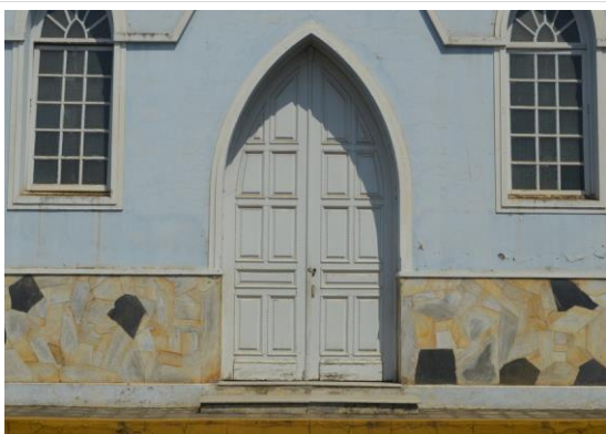
Pará de Minas Asilo Padre José Pereira Coelho Porta em madeira de acesso à Capela, exibindo leve desgaste na base.
