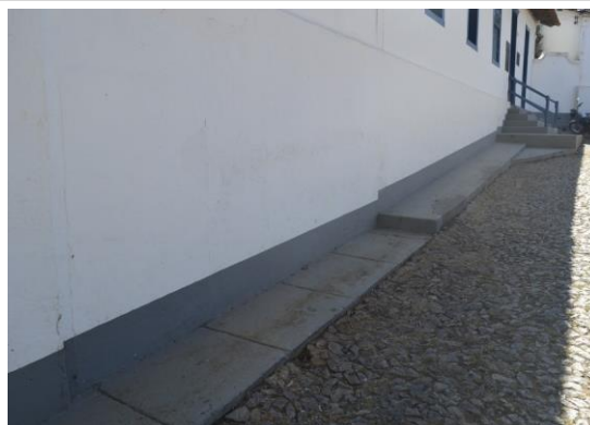
Pará de Minas Escola Municipal de Artes e Ofícios Raimundo Nogueira de Faria - SICA Calçada na fachada frontal do bem. (foto 50) Imagem: Mateus Fonseca – 04/09/2020
