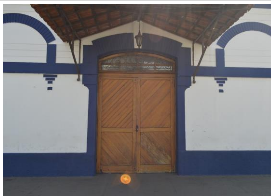
Pará de Minas Estação Ferroviária Porta de madeira ao lado direito na fachada frontal exibe desgaste do material. (foto 28) Imagem: Mateus Fonseca – 27/07/2020
