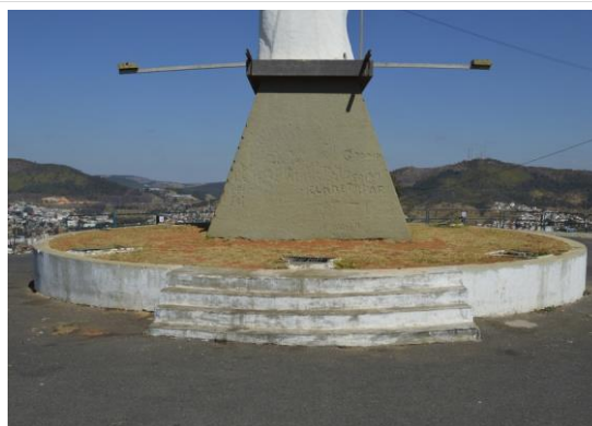
Pará de Minas Cristo Redentor A escada não apresenta danos na sua estrutura, mas exhibe sujidades e desgaste da pintura. (foto 14) Imagem: Mateus Fonseca – 03/08/2020
