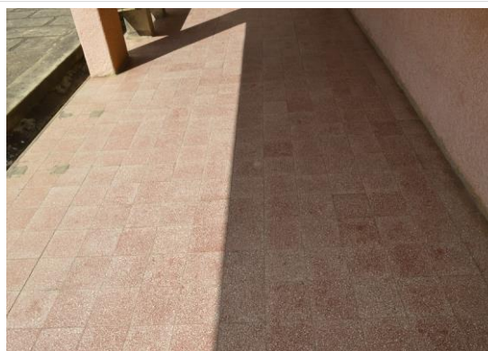
Pará de Minas Escola Estadual Fernando Otávio Piso em marmorite nos corredores que conformam o pátio central. (foto 34) Imagem: Mateus Fonseca – 28/08/2020
