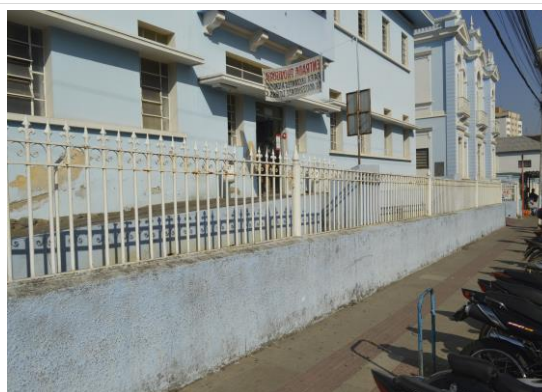
Pará de Minas Irmandade Nossa Senhora da Conceição – Hospital Vista externa das muretas e gradis da fachada frontal. (foto 46) Imagem: Mateus Fonseca – 18/09/2020
