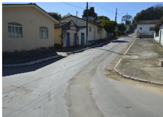
Pará de Minas Núcleo Histórico Urbano do Distrito de Carioca Vista da Rua N. Sra. Aparecida exibindo remendos no asfalto e um pouco de perda de material. (foto 05) Imagem: Mateus Fonseca – 07/08/2020
