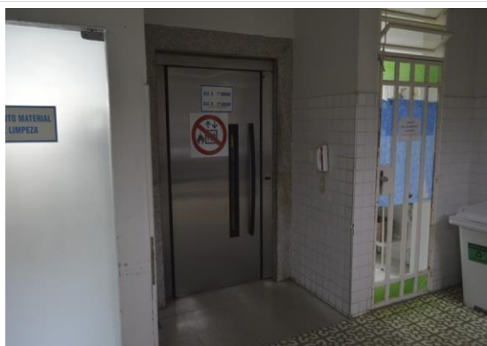
Pará de Minas Irmandade Nossa Senhora da Conceição – Hospital Porta do elevador. (foto 21) Imagem: Mateus Fonseca – 18/09/2020
