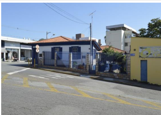
Pará de Minas Casa Maria Capanema Fachada Frontal da edificação. (foto 02)
