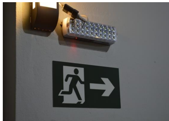
Pará de Minas Estação Ferroviária Iluminação e sinalização de emergência. (foto 70) Imagem: Mateus Fonseca – 27/07/2020
