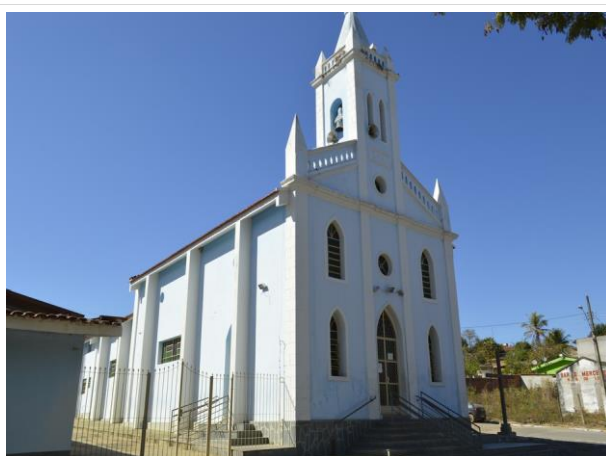
Pará de Minas Núcleo Histórico Urbano do Distrito de Carioca Igreja de Nossa Senhora de Lourdes. (foto 01) Imagem: Mateus Fonseca – 07/08/2020
