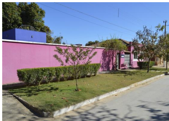
Pará de Minas Núcleo Histórico Urbano do Distrito de Carioca Área ajardinada em toda extensão da calçada em trecho da Rua São Francisco. (foto 23) Imagem: Mateus Fonseca – 07/08/2020
