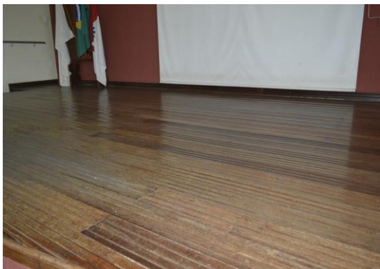
Pará de Minas Asilo Padre José Pereira Coelho Piso em madeira do palco do auditório apresentando algum desgaste pelo uso. (foto 34) Imagem: Mateus Fonseca – 30/09/2020
