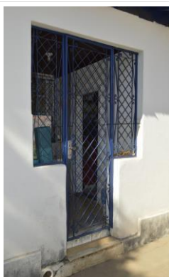
Pará de Minas Casa Maria Capanema Ferragens sem fechamentos em bom estado de conservação na fachada posterior do bem. (foto 26) Imagem: Mateus Fonseca – 10/07/2020
