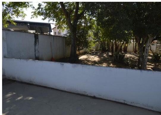
Pará de Minas Casa Maria Capanema Guarda corpo que divide a área cimentada da área de terra em bom estado de conservação. (foto 48) Imagem: Mateus Fonseca – 10/07/2020
