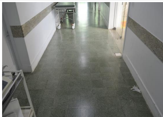
Pará de Minas Irmandade Nossa Senhora da Conceição – Hospital Piso em marmorite presente em alguns corredores e quartos. (foto 30) Imagem: Mateus Fonseca – 18/09/2020
