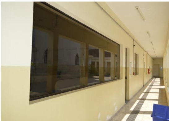
Pará de Minas Asilo Padre José Pereira Coelho Janelas dos corredores em metal e vidro. (foto 28) Imagem: Mateus Fonseca – 30/09/2020
