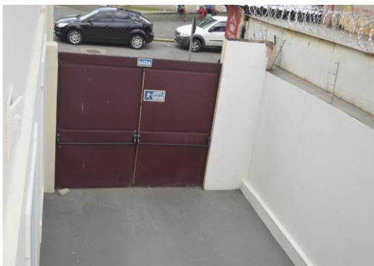
Pará de Minas Prédio Juscelino Kubitschek de Oliveira – Casa da Cultura Portão de acesso a lateral esquerda. (foto 45) Imagem: Mateus Fonseca – 27/10/2020
