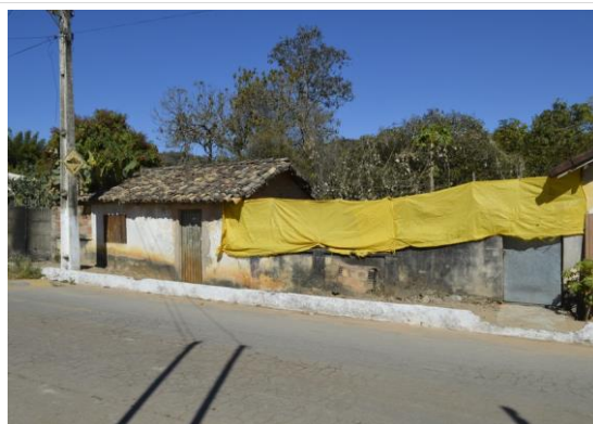
Pará de Minas Núcleo Histórico Urbano do Distrito de Carioca Edificação à Rua Dona Maria Lopes Cançado, 32 (foto 42) Imagem: Mateus Fonseca – 07/08/2020
