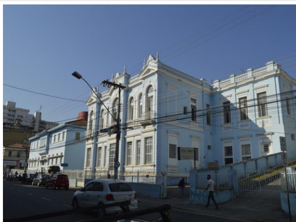
Pará de Minas Irmandade Nossa Senhora da Conceição – Hospital Fachada Frontal. (foto 01) Imagem: Mateus Fonseca – 18/09/2020
