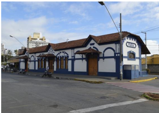
Pará de Minas Estação Ferroviária Reboco e pintura externos no geral exibem bom estado. (foto 15) Imagem: Mateus Fonseca – 27/07/2020
