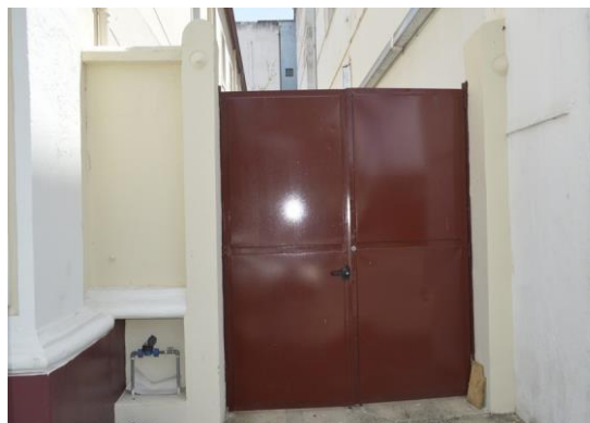
Pará de Minas Prédio Juscelino Kubitschek de Oliveira – Casa da Cultura Portão de acesso a lateral direita. (foto 46) Imagem: Mateus Fonseca – 27/10/2020
