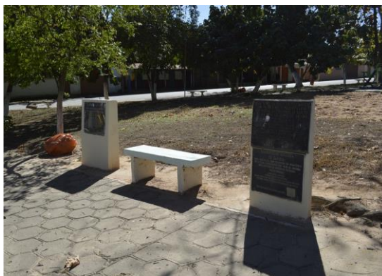
Pará de Minas Gruta de Nossa Senhora de Lourdes Placas na área da Praça Nossa Senhora de Lourdes, necessitando apenas de renovação da camada pictórica. (foto 77) Imagem: Mateus Fonseca – 10/07/2020
