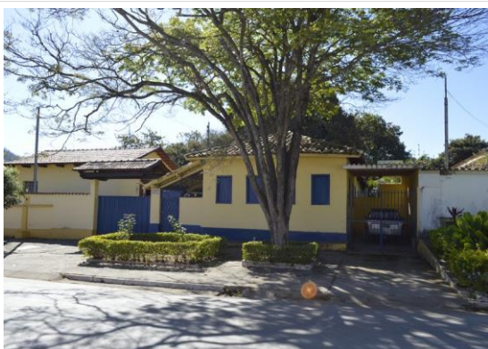
Pará de Minas Núcleo Histórico Urbano do Distrito de Carioca Edificação à Rua São Francisco, 36 (foto 51) Imagem: Mateus Fonseca – 07/08/2020
