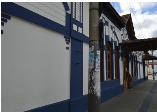
Pará de Minas Estação Ferroviária Fachada frontal exibindo alvenarias em bom estado de conservação. (foto 12) Imagem: Mateus Fonseca – 27/07/2020
