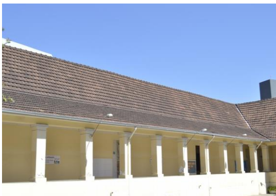
Pará de Minas Escola Estadual Governador Valadares Telhas francesas em bom estado de conservação exibindo apenas manchas de umidade. (foto 08) Imagem: Mateus Fonseca – 19/08/2020
