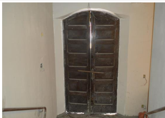
Pará de Minas Centro Literário Pedro Nestor Porta de entrada principal aguardando restauro. (foto 18) Imagem: Mateus Fonseca – 03/09/2020
