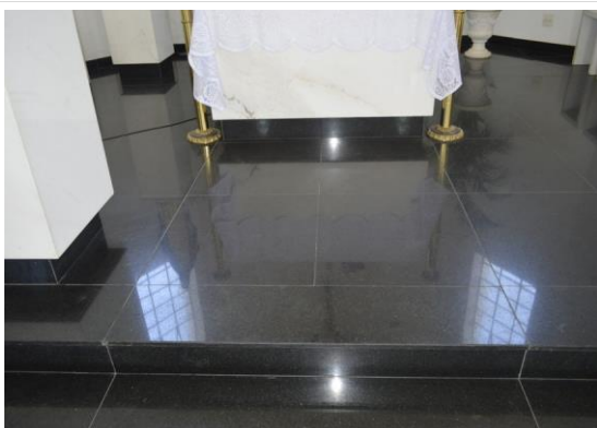
Pará de Minas Igreja Nossa Senhora das Graças Granito no piso do altar. (foto 25) Imagem: Mateus Fonseca – 04/09/2020
