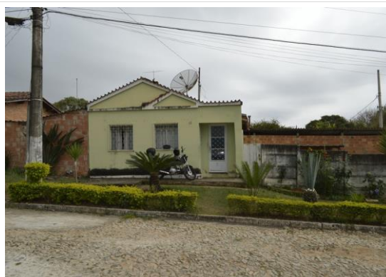
Pará de Minas Núcleo Histórico Urbano do Distrito de Ascensão Edificação à Rua Nova Serrana, 016. (foto 77)
