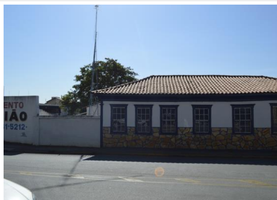
Pará de Minas Casa Maria Capanema O muro apresenta boas condições físicas, mas exhibe alguma sujidade por intempéries. (foto 46) Imagem: Mateus Fonseca – 10/07/2020
