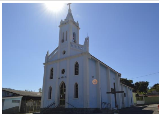
Pará de Minas Núcleo Histórico Urbano do Distrito de Carioca Fachada lateral direita da Igreja Nossa Senhora de Lourdes (foto 58) Imagem: Mateus Fonseca – 07/08/2020
