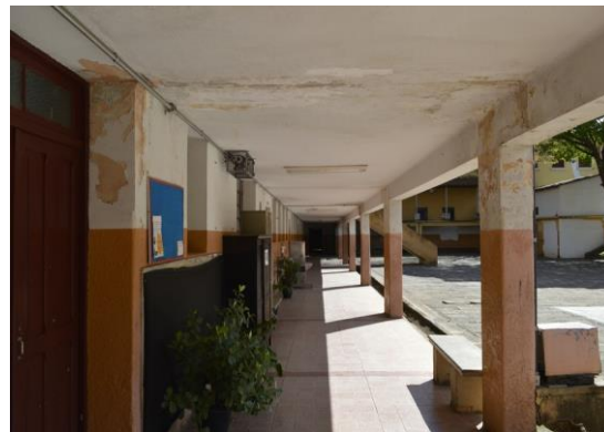
Pará de Minas Escola Estadual Fernando Otávio Laje que cobre os corredores que conformam o pátio central. (foto 38) Imagem: Mateus Fonseca – 28/08/2020
