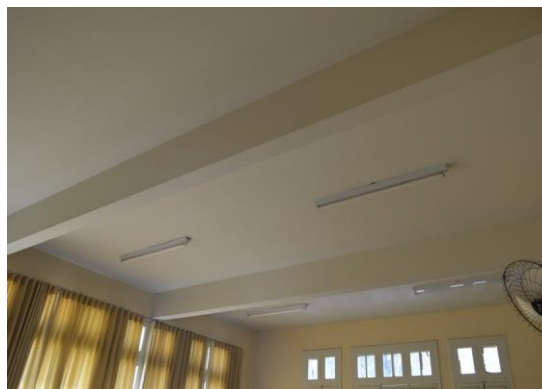
Pará de Minas Escola Estadual Governador Valadares As instalações elétricas de forma geral estão em boas condições. (foto 50) Imagem: Mateus Fonseca – 19/08/2020
