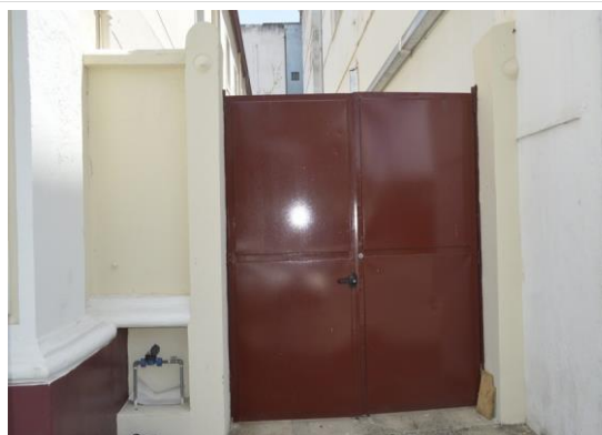
Pará de Minas Prédio Juscelino Kubitschek de Oliveira – Casa da Cultura Portão de metal de acesso a lateral direita. (foto 28) Imagem: Mateus Fonseca – 27/10/2020
