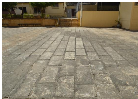
Pará de Minas Escola Estadual Fernando Otávio Piso cimentício no pátio interno. (foto 32)
