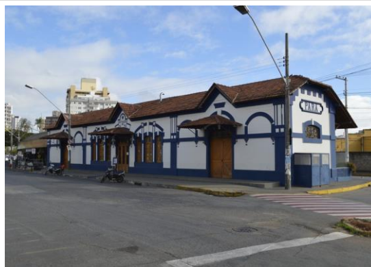
Pará de Minas Praças Torquato de Almeida e Francisco Torquato Estação Ferroviária, bem tombado, no entorno imediato das Praças exibe bom estado de conservação.
