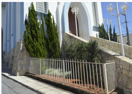
Pará de Minas Igreja Nossa Senhora das Graças Gradil que conforma os jardins. (foto 44) Imagem: Mateus Fonseca – 04/09/2020
