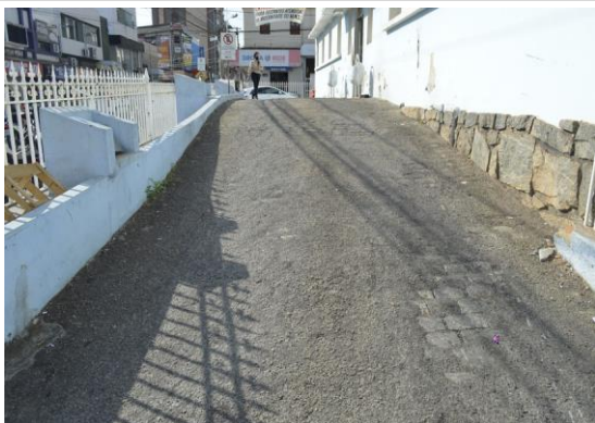
Pará de Minas Irmandade Nossa Senhora da Conceição – Hospital Manta asfáltica na rampa de acesso à entrada principal da maternidade. (foto 29) Imagem: Mateus Fonseca – 18/09/2020
