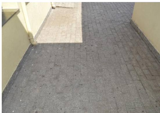
Pará de Minas Asilo Padre José Pereira Coelho Piso de pedra no pátio interno do bem em bom estado de conservação. (foto 30) Imagem: Mateus Fonseca – 30/09/2020
