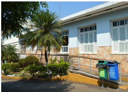
Pará de Minas Asilo Padre José Pereira Coelho Rampa de acesso à entrada secundária da faculdade. (foto 52) Imagem: Mateus Fonseca – 30/09/2020
