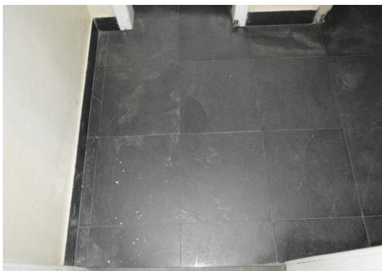
Pará de Minas Estação Ferroviária Cerâmicas dos banheiros do cinema bem conservadas apenas com sujidades. (foto 45) Imagem: Mateus Fonseca – 27/07/2020
