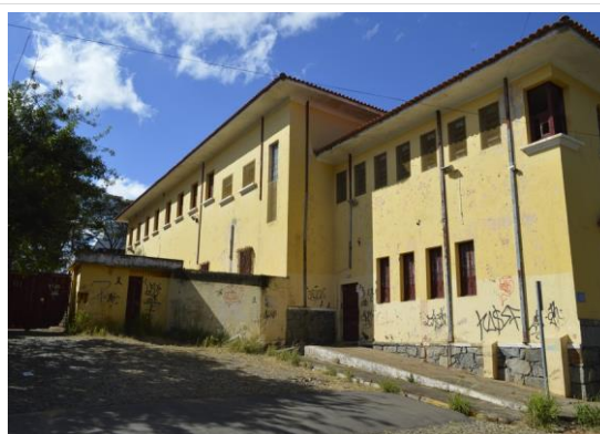
Pará de Minas Escola Estadual Fernando Otávio Fachada lateral esquerda. (foto 03)
