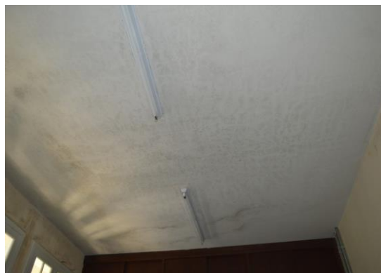
Pará de Minas Escola Estadual Governador Valadares Laje da recepção apresentando marcas de infiltração. (foto 36) Imagem: Mateus Fonseca – 19/08/2020
