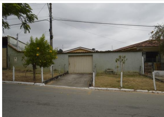
Pará de Minas Núcleo Histórico Urbano do Distrito de Ascensão Edificação à Avenida Abdon Senen de Araújo, 116. (foto 41)
