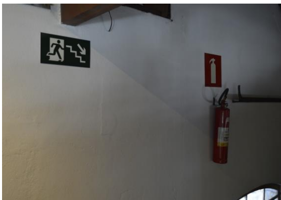
Pará de Minas Estação Ferroviária Extintor de incêndio e sinalização de emergência. (foto 69) Imagem: Mateus Fonseca – 27/07/2020
