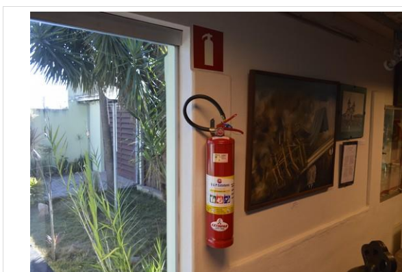
Pará de Minas MUSPAM Instalações de prevenção e combate a incêndio segundo normas do Corpo de Bombeiros. (foto 51) Imagem: Mateus Fonseca – 09/07/2020
