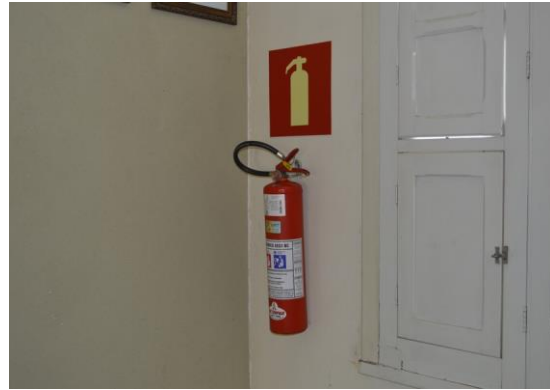
Pará de Minas Asilo Padre José Pereira Coelho Extintor de incêndio. (foto 57) Imagem: Mateus Fonseca – 30/09/2020
