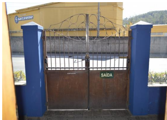
Pará de Minas Estação Ferroviária Vista interna do portão da varanda. (foto 62) Imagem: Mateus Fonseca – 27/07/2020
