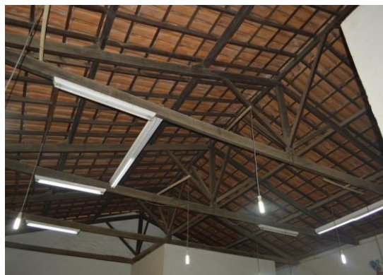
Pará de Minas Escola Municipal de Artes e Ofícios Raimundo Nogueira de Faria - SICA Madeiramento do telhado da oficina. (foto 10) Imagem: Mateus Fonseca – 04/09/2020
