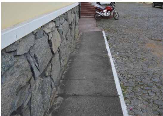
Pará de Minas Escola Estadual Fernando Otávio Cimentado nas calçadas. (foto 29)
