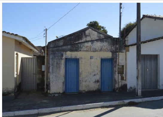
Pará de Minas Núcleo Histórico Urbano do Distrito de Carioca Edificação à Rua Nossa Senhora Aparecida, 115 (foto 46) Imagem: Mateus Fonseca – 07/08/2020
