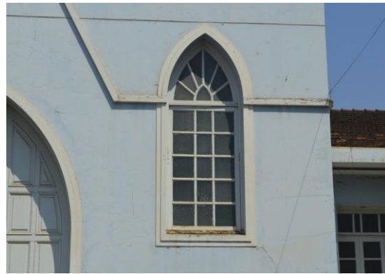
Pará de Minas Asilo Padre José Pereira Coelho Janela da fachada frontal em metal e vidro e enquadramento em massa bem conservadas, nota-se manchas de intempéries no peitoril. (foto 27) Imagem: Mateus Fonseca – 30/09/2020
