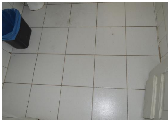
Pará de Minas Fórum Desembargador Pedro Nestor Piso cerâmico comum aos banheiros do bem. (foto 36) Imagem: Mateus Fonseca – 06/08/2020
