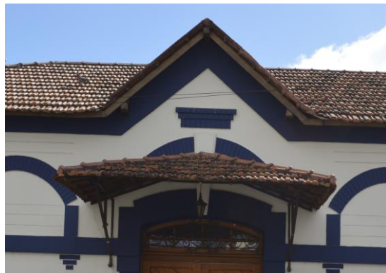
Pará de Minas Estação Ferroviária Frontão a esquerda na fachada frontal em bom estado. (foto 10) Imagem: Mateus Fonseca – 27/07/2020
