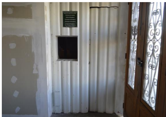
Pará de Minas Estação Ferroviária Porta de isolamento acústico de acesso à bilheteria do cinema exibindo bom estado. (foto 33) Imagem: Mateus Fonseca – 27/07/2020
