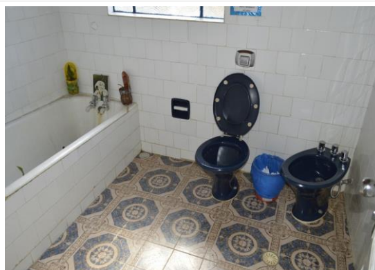
Pará de Minas Casa Maria Capanema Mesmo as peças mais antigas do sistema hidráulico ainda apresentam bom estado de conservação. (foto 50) Imagem: Mateus Fonseca – 10/07/2020
