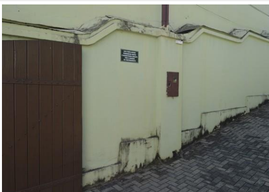
Pará de Minas MUSPAM Muro lateral direito em bom estado foi pintado a sua base. (foto 43) Imagem: Mateus Fonseca – 09/07/2020
