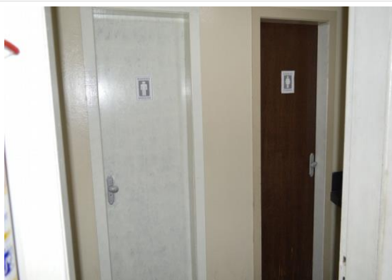
Pará de Minas Estação Ferroviária Portas dos banheiros do cinema que não tiveram pintura concluída. (foto 35) Imagem: Mateus Fonseca – 27/07/2020
