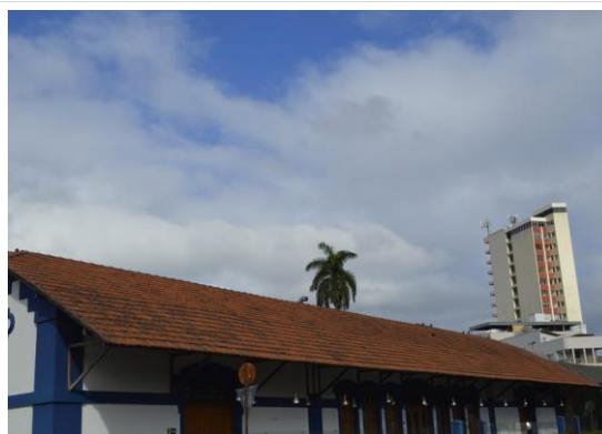
Pará de Minas Estação Ferroviária Telhas francesas exibem manchas causadas pela umidade. (foto 08) Imagem: Mateus Fonseca – 27/07/2020
