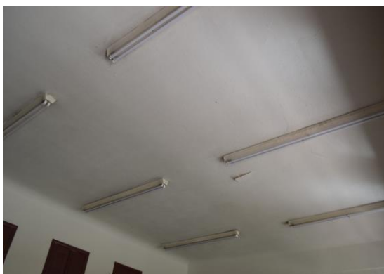
Pará de Minas Escola Estadual Fernando Otávio Laje das salas de aula. (foto 39) Imagem: Mateus Fonseca – 28/08/2020
