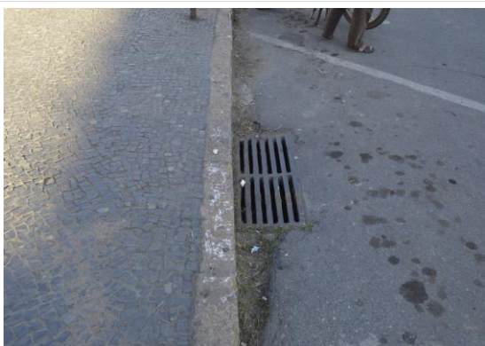
Pará de Minas Praças Torquato de Almeida e Francisco Torquato Boca de lobo em concreto exibindo bom estado. (foto 10) Imagem: Mateus Fonseca – 29/07/2020
