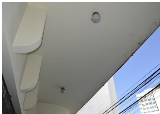
Pará de Minas Fórum Desembargador Pedro Nestor Laje de cobertura da entrada principal apresenta certos sinais de infiltração. (foto 40) Imagem: Mateus Fonseca – 06/08/2020
