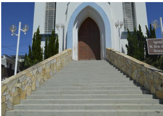
Pará de Minas Igreja Nossa Senhora das Graças Piso cimentado na escadaria de acesso principal à Igreja. (foto 27) Imagem: Mateus Fonseca – 04/09/2020
