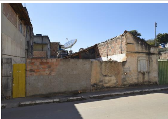
Pará de Minas Núcleo Histórico Urbano do Distrito de Carioca Edificação à Rua Dona Maria Lopes Cançado, 100' (foto 45) Imagem: Mateus Fonseca – 07/08/2020
