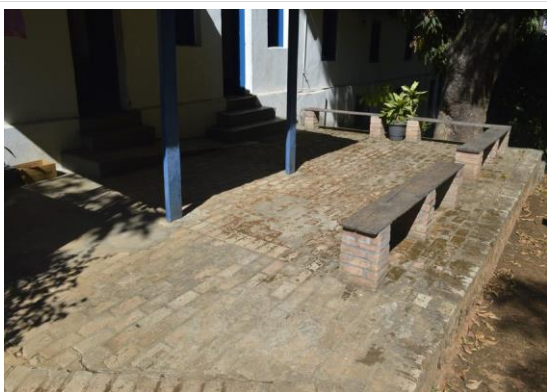
Pará de Minas Escola Municipal de Artes e Ofícios Raimundo Nogueira de Faria - SICA Piso em tijolo de barro na varanda da fachada posterior. (foto 35) Imagem: Mateus Fonseca – 04/09/2020
