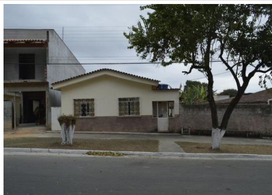
Pará de Minas Núcleo Histórico Urbano do Distrito de Ascensão Edificação à Avenida Abdon Senem de Araújo, 150. (foto 43)
