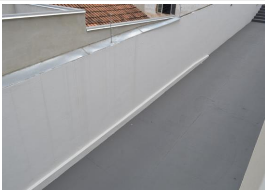
Pará de Minas Prédio Juscelino Kubitschek de Oliveira – Casa da Cultura Muro lateral esquerdo. (foto 43) Imagem: Mateus Fonseca – 27/10/2020
