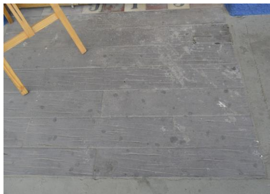
Pará de Minas Estação Ferroviária Porcelanato que imita madeira na entrada principal do bem. (foto 50) Imagem: Mateus Fonseca – 27/07/2020
