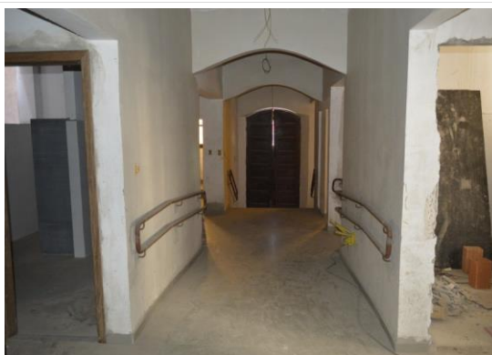
Pará de Minas Centro Literário Pedro Nestor A estrutura do bem encontra-se em bom estado. (foto 04)
