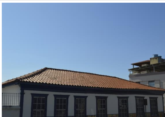
Pará de Minas Casa Maria Capanema A estrutura e a cobertura estão em bom estado de conservação. (foto 08) Imagem: Mateus Fonseca – 10/07/2020
