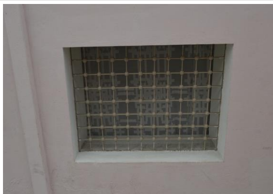
Pará de Minas Prédio Juscelino Kubitschek de Oliveira – Casa da Cultura Janela do porão com gradeamento. (foto 19) Imagem: Mateus Fonseca – 27/10/2020
