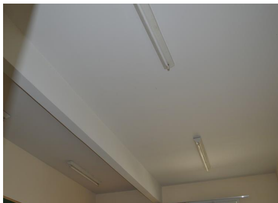
Pará de Minas Escola Estadual Governador Valadares Laje de uma das salas do bem. (foto 35) Imagem: Mateus Fonseca – 19/08/2020
