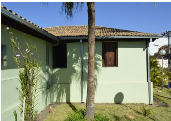
Pará de Minas MUSPAM Ripamento, beiral e guarda-pó em estado de conservação. (foto 09) Imagem: Mateus Fonseca – 09/07/2020
