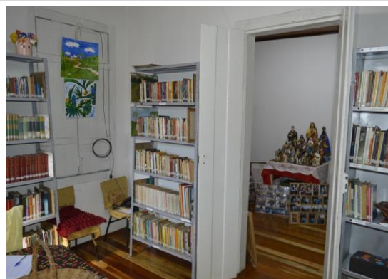
Pará de Minas Casa Maria Capanema Protegida das ações das intempéries estas portas em madeira exibem bom estado de conservação. (foto 23) Imagem: Mateus Fonseca – 10/07/2020
