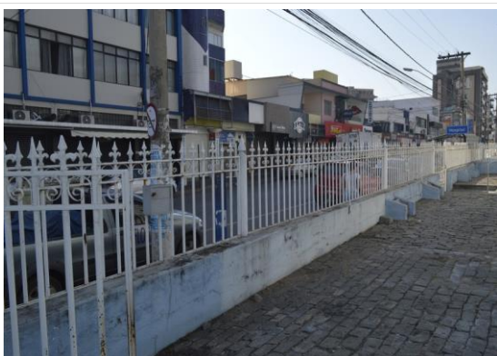
Pará de Minas Irmandade Nossa Senhora da Conceição – Hospital Vista interna das muretas e gradis da fachada frontal. (foto 45) Imagem: Mateus Fonseca – 18/09/2020
