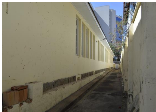
Pará de Minas Escola Estadual Governador Valadares Fachada lateral esquerda. (foto 03) Imagem: Mateus Fonseca – 19/08/2020
