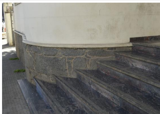
Pará de Minas Fórum Desembargador Pedro Nestor Pedras fazendo o barrado nas fachadas do bem. (foto 14) Imagem: Mateus Fonseca – 06/08/2020
