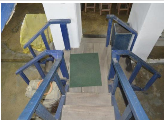
Pará de Minas Escola Municipal de Artes e Ofícios Raimundo Nogueira de Faria - SICA Pisos da escada de acesso às oficinas em madeira. (foto 36) Imagem: Mateus Fonseca – 04/09/2020
