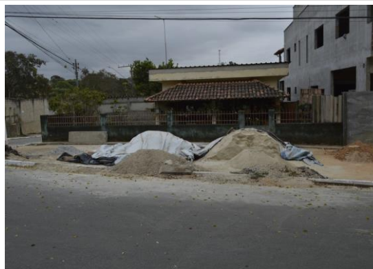
Pará de Minas Núcleo Histórico Urbano do Distrito de Ascensão Calçada em terra batida ocupada por material de obra, na Rua Abdon Senem de Araújo. (foto 21) Imagem: Mateus Fonseca – 24/08/2020
