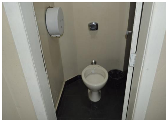
Pará de Minas Estação Ferroviária Instalações hidráulicas em funcionamento. (foto 66) Imagem: Mateus Fonseca – 27/07/2020
