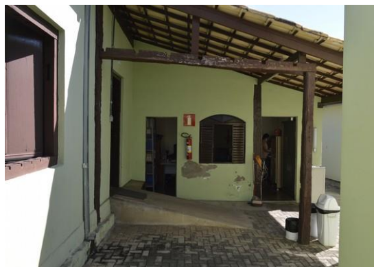
Pará de Minas MUSPAM Varanda nos fundos da edificação e seus elementos construtivos apresentam bom estado de conservação. (foto 42) Imagem: Mateus Fonseca – 09/07/2020
