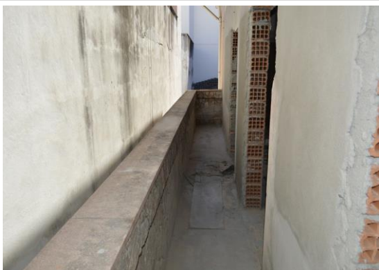
Pará de Minas Centro Literário Pedro Nestor Reboco externo ainda não finalizado. (foto 13) Imagem: Mateus Fonseca – 03/09/2020
