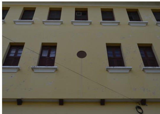
Pará de Minas Escola Estadual Fernando Otávio Janelas em madeira e vidro que compõem as fachadas. (foto 22) Imagem: Mateus Fonseca – 28/08/2020
