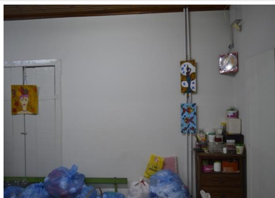
Pará de Minas Casa Maria Capanema Pintura à base de água das paredes internas da edificação em bom estado de conservação. (foto 16) Imagem: Mateus Fonseca – 10/07/2020
