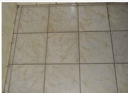
Pará de Minas Asilo Padre José Pereira Coelho Piso cerâmico dos banheiros em bom estado de conservação. (foto 39) Imagem: Mateus Fonseca – 30/09/2020
