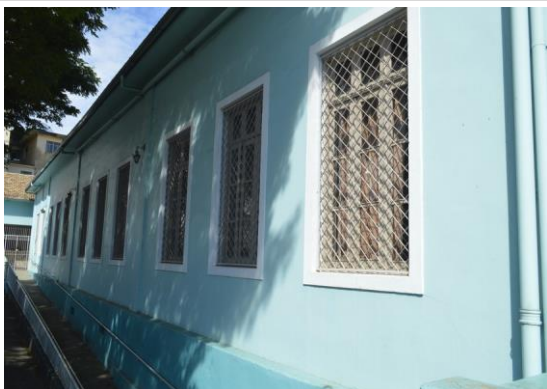
Pará de Minas Escola Estadual Torquato de Almeida Janela em madeira e vidro e grade em metal das fachadas laterais. (foto 22) Imagem: Mateus Fonseca – 11/11/2020
