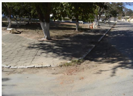
Pará de Minas Núcleo Histórico Urbano do Distrito de Carioca Sarjetas rasas na via da Praça Nossa Senhora de Lourdes apresentando acúmulo de areia. (foto 13) Imagem: Mateus Fonseca – 07/08/2020
