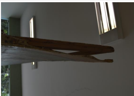
Pará de Minas Telas da Antiga Matriz de Nossa Senhora da Piedade Chassi apresenta severo ataque de insetos xilófagos e a tela desprendeu-se do mesmo. (foto 27) Imagem: Mateus Fonseca – 23/09/2020
