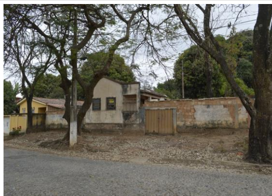
Par  de Minas N cleo Hist rico Urbano do Distrito de Ascens o Edifica o   Avenida Presidente Kubitschek, 210. (foto 59) Imagem: Mateus Fonseca – 24/08/2020
