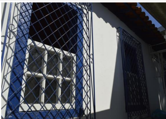
Pará de Minas Casa Maria Capanema Janela guilhotina em madeira e vidro e grade em metal em bom estado na fachada lateral esquerda. (foto 30) Imagem: Mateus Fonseca – 10/07/2020
