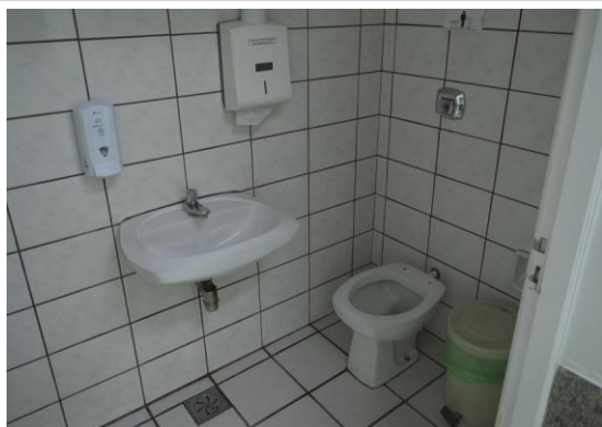
Pará de Minas Irmandade Nossa Senhora da Conceição – Hospital Instalações hidráulicas. (foto 49) Imagem: Mateus Fonseca – 18/09/2020
