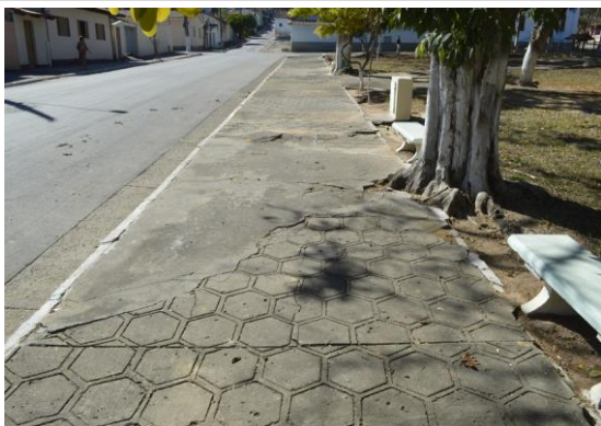
Pará de Minas Núcleo Histórico Urbano do Distrito de Carioca Piso em concreto com textura assemelhando-se ao intertravado na Pç N. Sra. de Lourdes. (foto 69) Imagem: Mateus Fonseca – 07/08/2020
