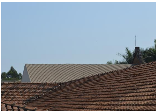
Pará de Minas Asilo Padre José Pereira Coelho O manto de cobertura necessita de intervenção para solucionar infiltrações. (foto 06) Imagem: Mateus Fonseca – 30/09/2020
