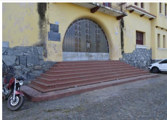
Pará de Minas Escola Estadual Fernando Otávio Escadaria que marca a entrada principal e portada com enquadramento curvo. (foto 42) Imagem: Mateus Fonseca – 28/08/2020
