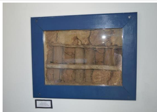
Pará de Minas Escola Municipal de Artes e Ofícios Raimundo Nogueira de Faria - SICA Detalhe que revela a alvenaria de pau a pique. (foto 16) Imagem: Mateus Fonseca – 04/09/2020
