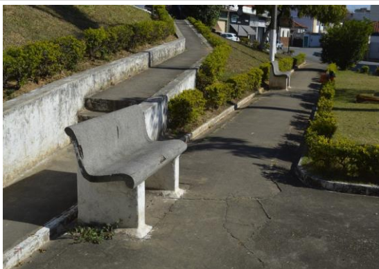
Pará de Minas Gruta de Nossa Senhora de Lourdes Banco em concreto exibindo bom estado de conservação. (foto 24) Imagem: Mateus Fonseca – 10/07/2020
