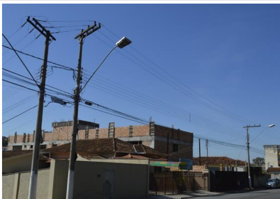
Pará de Minas Gruta de Nossa Senhora de Lourdes Fiação aparente em todo o entorno da Praça Francisco Valadares. (foto 29) Imagem: Mateus Fonseca – 10/07/2020
