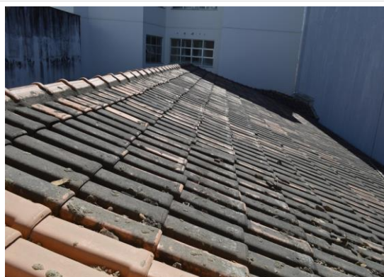
Pará de Minas Centro Literário Pedro Nestor Vista superior do telhado. (foto 08) Imagem: Mateus Fonseca – 03/09/2020
