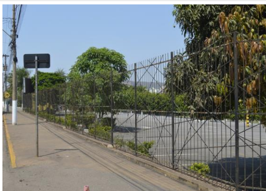
Pará de Minas Asilo Padre José Pereira Coelho Gradil frontal, muro lateral direito e passeio em bom estado de conservação. (foto 53) Imagem: Mateus Fonseca – 30/09/2020
