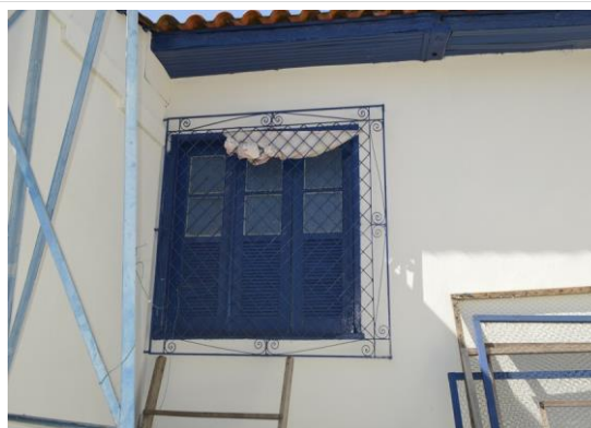
Pará de Minas Casa Maria Capanema Janela francesa em madeira e vidro e grade em metal na fachada posterior . (foto 29) Imagem: Mateus Fonseca – 10/07/2020
