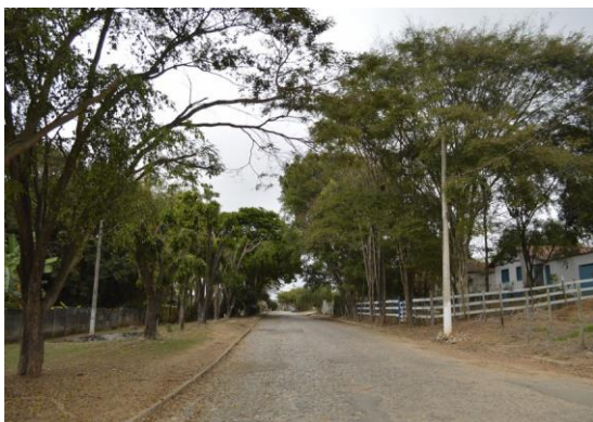
Pará de Minas Núcleo Histórico Urbano do Distrito de Ascensão Rua Raimundo Penaforte de Araújo com intensa arborização. (foto 18) Imagem: Mateus Fonseca – 24/08/2020
