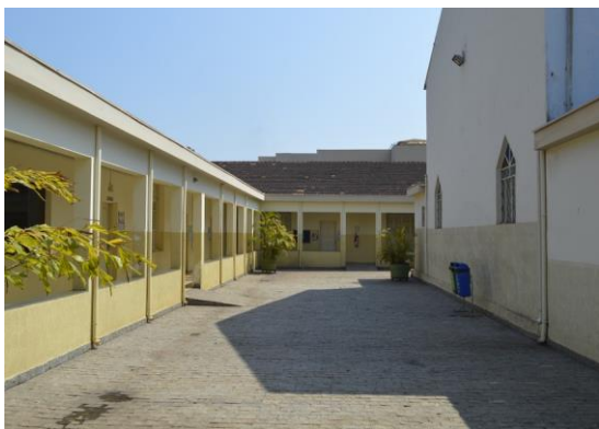
Pará de Minas Asilo Padre José Pereira Coelho Fachada posterior exibindo reboco e pintura em bom estado. (foto 13) Imagem: Mateus Fonseca – 30/09/2020
