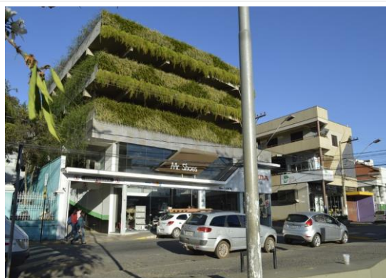
Pará de Minas Praças Torquato de Almeida e Francisco Torquato Edifício estacionamento com comércio no térreo.
