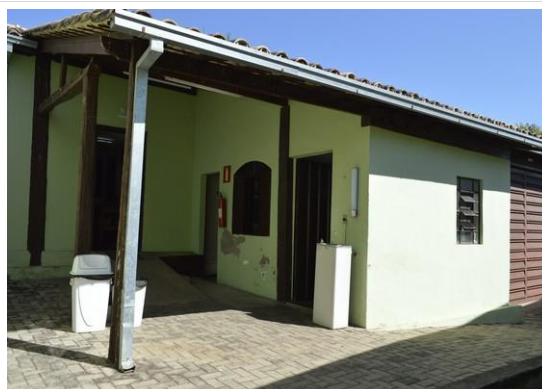
Pará de Minas MUSPAM Fachada posterior. (foto 04)
