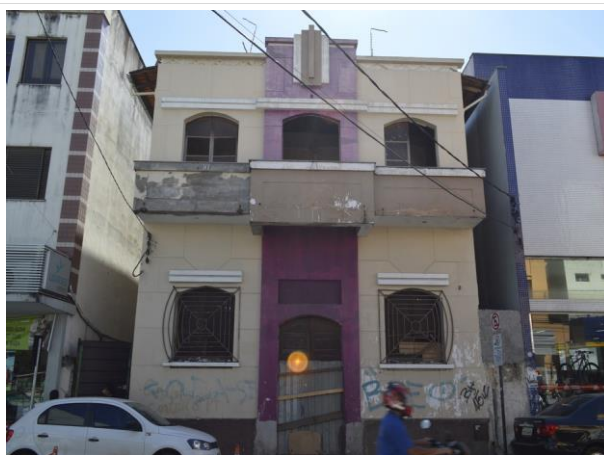
Pará de Minas Centro Literário Pedro Nestor Fachada Frontal (foto 01) Imagem: Mateus Fonseca – 03/09/2020
