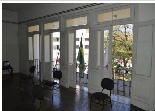
Pará de Minas Fórum Desembargador Pedro Nestor Janelas rasgadas no 1º pavimento. (foto 18) Imagem: Mateus Fonseca – 06/08/2020
