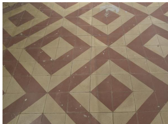
Pará de Minas Igreja Nossa Senhora das Graças Piso em ladrilho instalado no coro da igreja. (foto 24) Imagem: Mateus Fonseca – 04/09/2020
