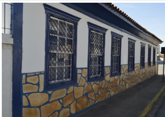
Pará de Minas Casa Maria Capanema Pintura a óleo na fachada frontal da edificação exhibe bom estado. (foto 15) Imagem: Mateus Fonseca – 10/07/2020
