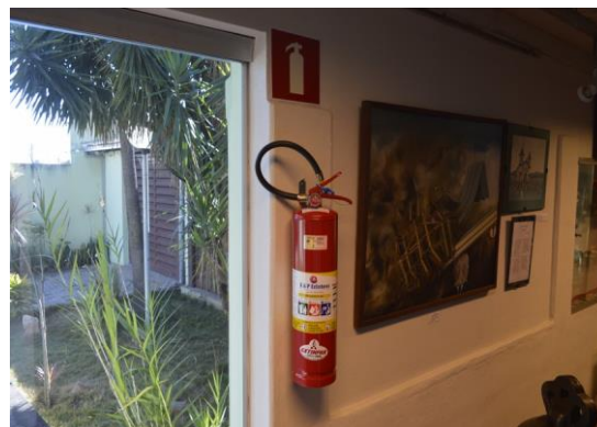
Pará de Minas Telas da Antiga Matriz de Nossa Senhora da Piedade Instalações de combate a incêndio no interior do MUSPAM. (foto 54) Imagem: Mateus Fonseca – 23/09/2020
