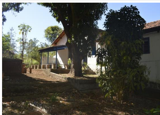
Pará de Minas Escola Municipal de Artes e Ofícios Raimundo Nogueira de Faria - SICA Vista do quintal para os fundos do bem. (foto 47) Imagem: Mateus Fonseca – 04/09/2020
