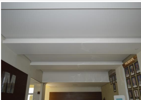
Pará de Minas Asilo Padre José Pereira Coelho Forro de gesso na recepção. (foto 43)
