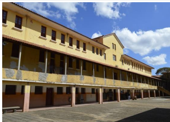
Pará de Minas Escola Estadual Fernando Otávio Fachada posterior (foto 04)
