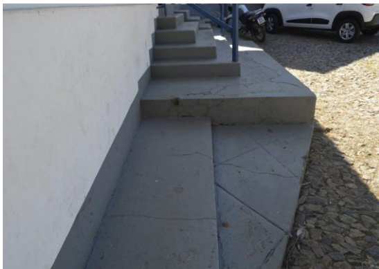
Pará de Minas Escola Municipal de Artes e Ofícios Raimundo Nogueira de Faria - SICA Piso cimentado da calçada e escada na fachada frontal. (foto 29) Imagem: Mateus Fonseca – 04/09/2020
