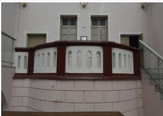
Pará de Minas Prédio Juscelino Kubitschek de Oliveira – Casa da Cultura Balaustre que perfaz o contorno do mezanino no átrio recebe pintura a base de água e a óleo. (foto 13) Imagem: Mateus Fonseca – 27/10/2020
