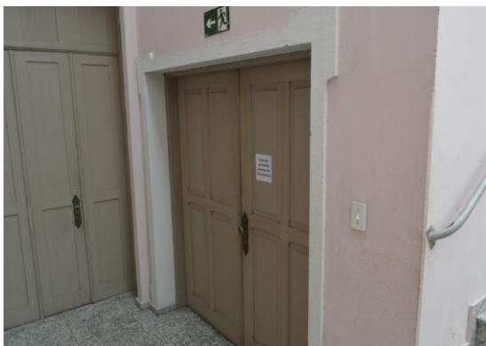
Pará de Minas Prédio Juscelino Kubitschek de Oliveira – Casa da Cultura Portas de madeira do térreo. (foto 21) Imagem: Mateus Fonseca – 27/10/2020
