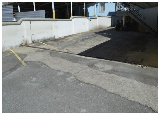
Pará de Minas Fórum Desembargador Pedro Nestor Camada asfáltica do estacionamento com remendos. (foto 30) Imagem: Mateus Fonseca – 06/08/2020
