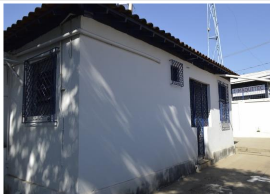
Pará de Minas Casa Maria Capanema Fachada posterior da Casa Maria Capanema. (foto 05)
