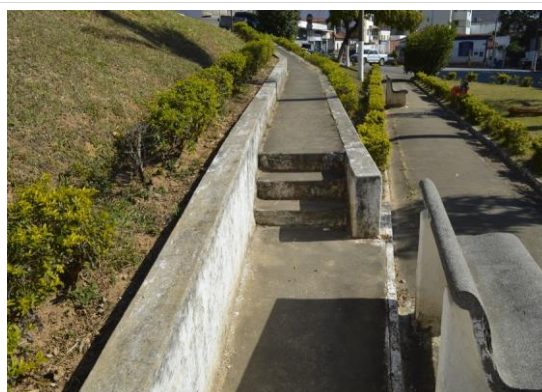
Pará de Minas Gruta de Nossa Senhora de Lourdes Rampa que conecta os dois níveis da Praça exibe degraus que impossibilitam a acessibilidade. (foto 22) Imagem: Mateus Fonseca – 10/07/2020
