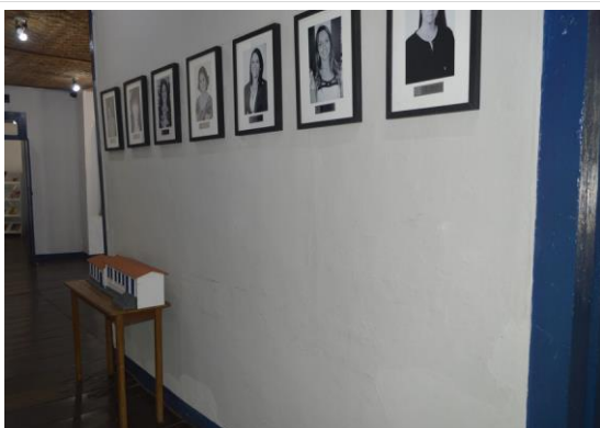
Pará de Minas Escola Municipal de Artes e Ofícios Raimundo Nogueira de Faria - SICA Alvenaria interna do pavimento térreo. (foto 15) Imagem: Mateus Fonseca – 04/09/2020
