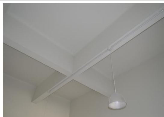
Pará de Minas Escola Estadual Fernando Otávio Laje do hall dos banheiros. (foto 40) Imagem: Mateus Fonseca – 28/08/2020
