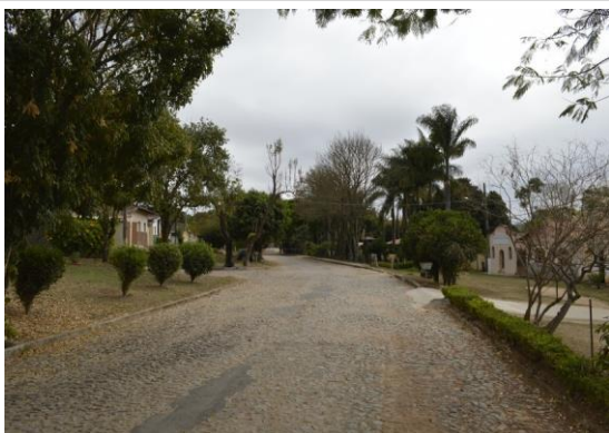
Pará de Minas Núcleo Histórico Urbano do Distrito de Ascensão Rua Raimundo Penaforte de Araújo exibindo remendos asfálticos. (foto 06) Imagem: Mateus Fonseca – 24/08/2020
