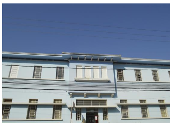
Pará de Minas Irmandade Nossa Senhora da Conceição – Hospital Beiral, cimalkas e cachorros na fachada frontal. (foto 08) Imagem: Mateus Fonseca – 27/07/2020
