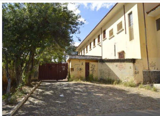
Pará de Minas Escola Estadual Fernando Otávio Portão em metal de acesso lateral. (foto 28) Imagem: Mateus Fonseca – 28/08/2020
