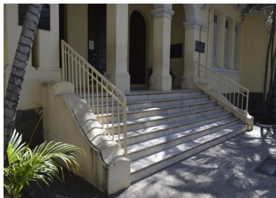
Pará de Minas Escola Estadual Governador Valadares Escada do acesso principal revestida por mármore. (foto 17) Imagem: Mateus Fonseca – 19/08/2020
