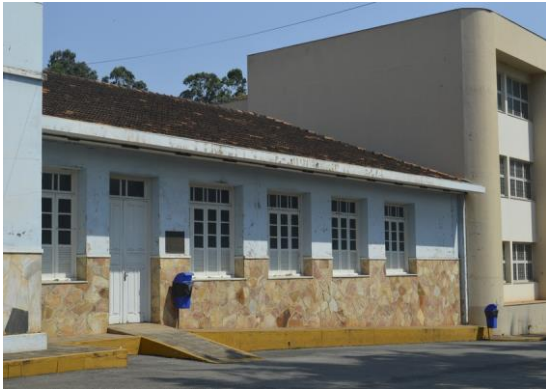
Pará de Minas Asilo Padre José Pereira Coelho Portas e janelas em madeira que recebem pintura a óleo na fachada frontal. (foto 22) Imagem: Mateus Fonseca – 30/09/2020
