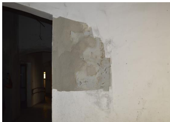
Pará de Minas Centro Literário Pedro Nestor Reparo no reboco interno. (foto 12) Imagem: Mateus Fonseca – 03/09/2020
