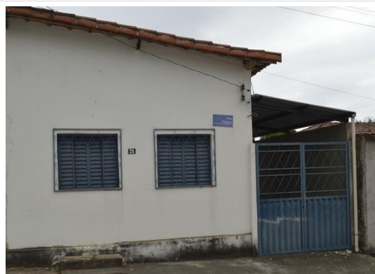
Pará de Minas Núcleo Histórico Urbano do Distrito de Ascensão Placas de logradouro na Rua Pompéu. (foto 13) Imagem: Mateus Fonseca – 24/08/2020
