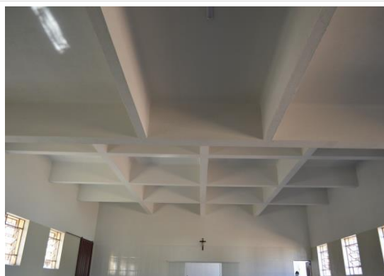
Pará de Minas Escola Estadual Fernando Otávio A estrutura em concreto armado (foto 06) Imagem: Mateus Fonseca – 28/08/2020
