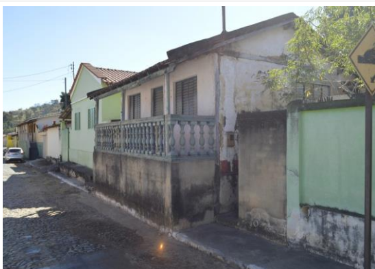
Pará de Minas Núcleo Histórico Urbano do Distrito de Carioca Edificação à Rua Nossa Senhora da Piedade avançando sobre a calçada. (foto 24) Imagem: Mateus Fonseca – 07/08/2020
