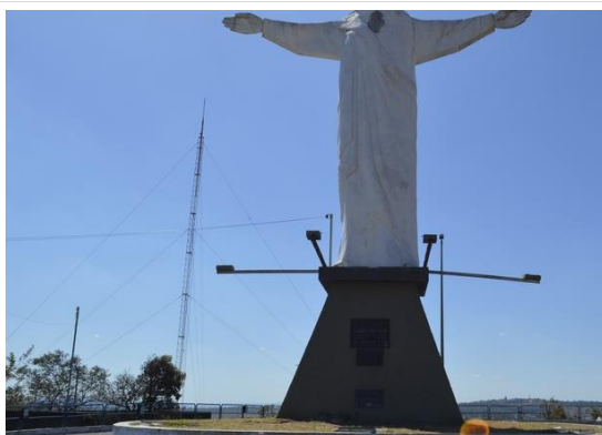
Pará de Minas Cristo Redentor Para-raios próximo ao bem tombado. (foto 24) Imagem: Mateus Fonseca – 03/08/2020
