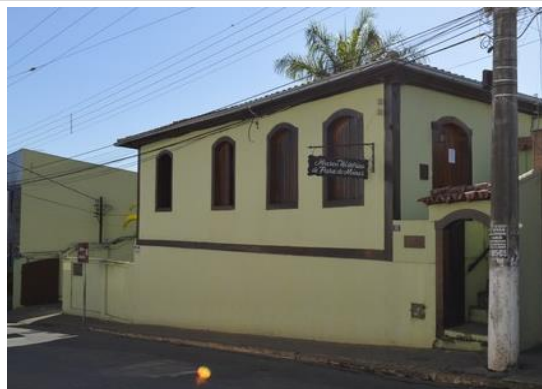
Pará de Minas MUSPAM Pintura externa do bem tombado se apresenta bem conservada. (foto 17) Imagem: Mateus Fonseca – 09/07/2020
