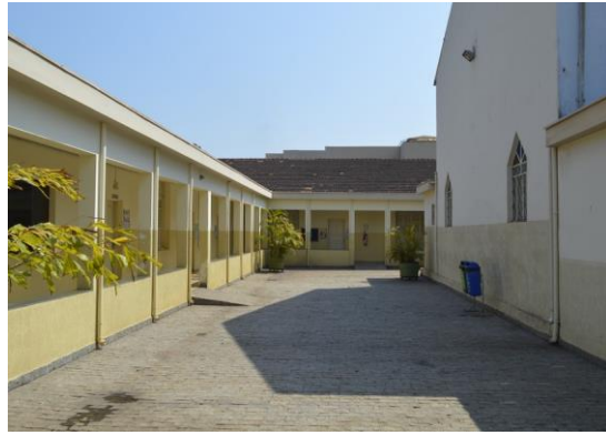
Pará de Minas Asilo Padre José Pereira Coelho A estrutura em vigas e pilares de concreto armado não apresenta danos. (foto 05) Imagem: Mateus Fonseca – 30/09/2020
