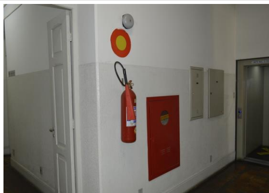
Pará de Minas Fórum Desembargador Pedro Nestor Equipamentos de combate a incêndio presentes no pavimento térreo. (foto 50) Imagem: Mateus Fonseca – 06/08/2020
