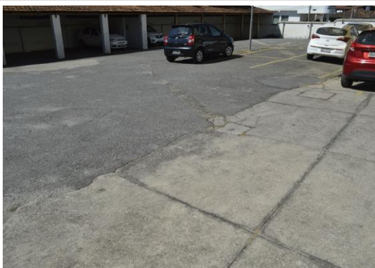
Pará de Minas Fórum Desembargador Pedro Nestor Piso cimentado no estacionamento do Fórum. (foto 29) Imagem: Mateus Fonseca – 06/08/2020
