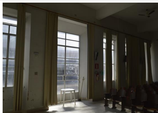
Pará de Minas Irmandade Nossa Senhora da Conceição – Hospital Vista interna da porta e janelas da fachada frontal. (foto 22) Imagem: Mateus Fonseca – 18/09/2020
