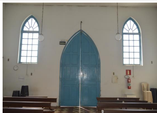
Pará de Minas Asilo Padre José Pereira Coelho Vista interna da porta principal da Capela em bom estado de conservação.
