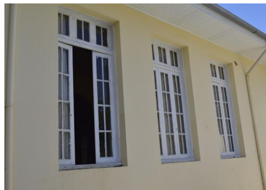
Pará de Minas Escola Estadual Governador Valadares Janela em madeira e vidro, enquadramento em massa nas laterais do bem. (foto 25) Imagem: Mateus Fonseca – 19/08/2020
