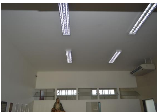
Pará de Minas Asilo Padre José Pereira Coelho Laje de uma das salas do bem. (foto 45)
