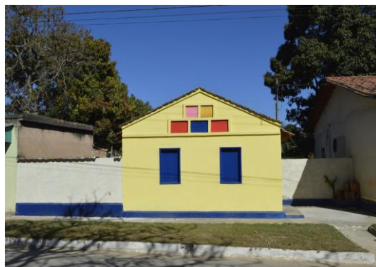
Pará de Minas Núcleo Histórico Urbano do Distrito de Carioca Edificação à Rua São Francisco, s/n (foto 54) Imagem: Mateus Fonseca – 07/08/2020
