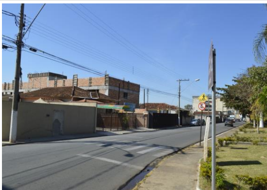
Pará de Minas Gruta de Nossa Senhora de Lourdes Edificação em construção na Rua Fernando Otávio, projeto previamente aprovado pelo conselho. (foto 54) Imagem: Mateus Fonseca – 10/07/2020
