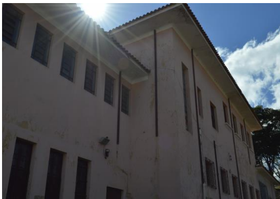
Pará de Minas Escola Estadual Fernando Otávio Condutores de águas pluviais em aço galvanizado. (foto 09) Imagem: Mateus Fonseca – 28/08/2020
