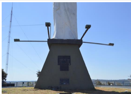
Pará de Minas Cristo Redentor Hastes que compõem a iluminação do bem em bom estado. (foto 22) Imagem: Mateus Fonseca – 03/08/2020
