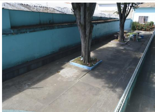
Pará de Minas Escola Estadual Torquato de Almeida Cimentado no quintal da lateral esquerda. (foto 26) Imagem: Mateus Fonseca – 11/11/2020
