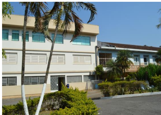
Pará de Minas Asilo Padre José Pereira Coelho Fachada lateral esquerda recebeu anexo. (foto 03) Imagem: Mateus Fonseca – 30/09/2020
