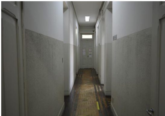
Pará de Minas Fórum Desembargador Pedro Nestor Reboco interno e camada pictórica à base de água e barrado a óleo. (foto 11) Imagem: Mateus Fonseca – 06/08/2020
