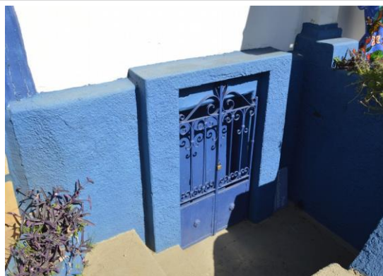
Pará de Minas Casa Maria Capanema Porta em madeira e portão em metal que dá acesso ao porão da Casa Maria Capanema. (foto 34) Imagem: Mateus Fonseca – 10/07/2020
