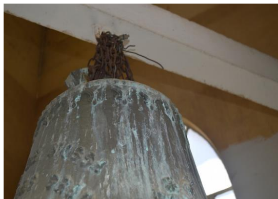
Pará de Minas Igreja Nossa Senhora das Graças Detalhe da fixação dos sinos feita por correntes. (foto 43) Imagem: Mateus Fonseca – 04/09/2020
