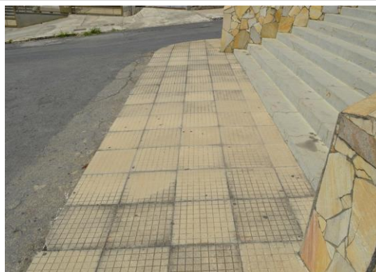
Pará de Minas Igreja Nossa Senhora das Graças Calçada com piso cimentício. (foto 45) Imagem: Mateus Fonseca – 04/09/2020
