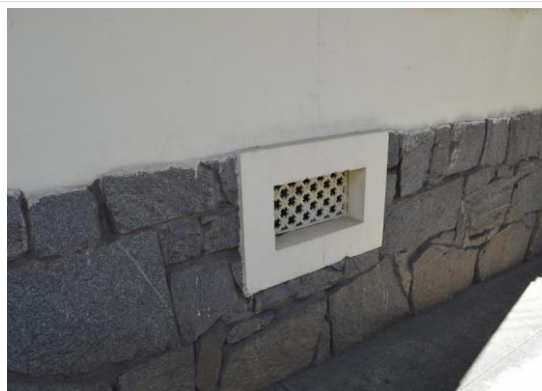
Pará de Minas Escola Estadual Governador Valadares Barrado em pedra bruta nas fachadas do bem. (foto 19) Imagem: Mateus Fonseca – 19/08/2020
