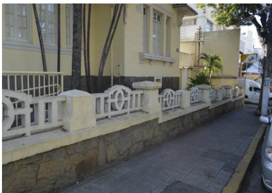
Pará de Minas Escola Estadual Governador Valadares Muro baixo com elemento vazado e revestido por pedras na fachada frontal. (foto 46) Imagem: Mateus Fonseca – 19/08/2020
