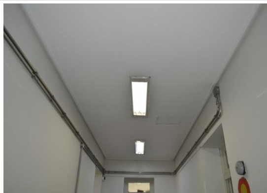
Pará de Minas Fórum Desembargador Pedro Nestor Forro de gesso em corredor do 1º pavimento. (foto 38) Imagem: Mateus Fonseca – 06/08/2020
