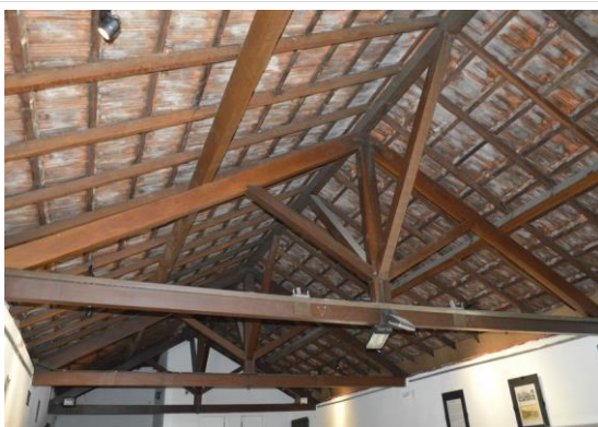
Pará de Minas Estação Ferroviária Madeiramento do telhado em bom estado. (foto 07) Imagem: Mateus Fonseca – 27/07/2020
