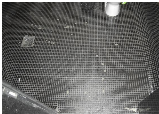
Pará de Minas Estação Ferroviária Pastilhas do banheiro PNE exibindo perda de algumas peças. (foto 46) Imagem: Mateus Fonseca – 27/07/2020
