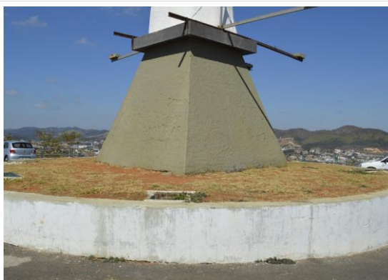
Pará de Minas Cristo Redentor O pedestal de tijolos exhibe bom estado de conservação. (foto 06) Imagem: Mateus Fonseca – 03/08/2020
