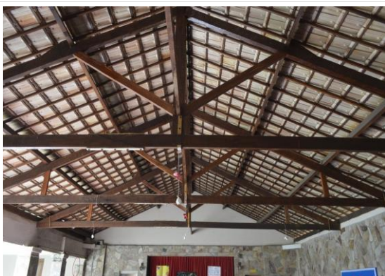
Pará de Minas Escola Estadual Torquato de Almeida Madeiramento do telhado. (foto 07) Imagem: Mateus Fonseca – 11/11/2020
