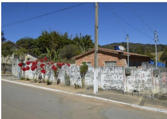
Pará de Minas Núcleo Histórico Urbano do Distrito de Carioca Trecho do passeio da Rua Dona Maria Lopes Cançado em terra compactada. (foto 22) Imagem: Mateus Fonseca – 07/08/2020
