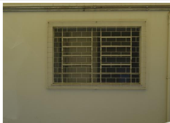
Pará de Minas Fórum Desembargador Pedro Nestor Janela em metal e vidro protegida por gradil localizada no porão. (foto 26) Imagem: Mateus Fonseca – 06/08/2020
