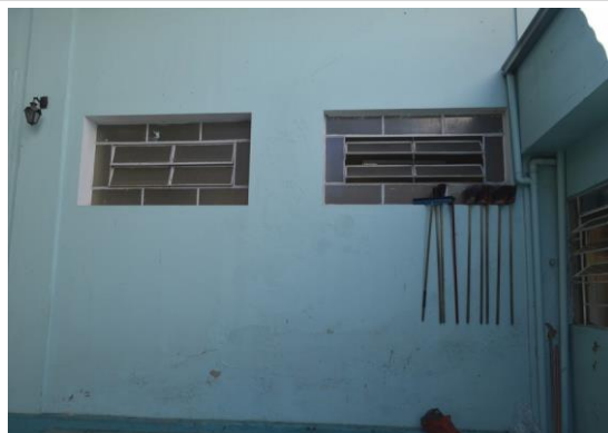
Pará de Minas Escola Estadual Torquato de Almeida Janelas em metal e vidro e enquadramento em massa nos banheiros na lateral esquerda do bem. (foto 23) Imagem: Mateus Fonseca – 11/11/2020
