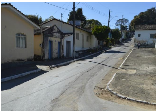
Pará de Minas Núcleo Histórico Urbano do Distrito de Carioca Rampas de acessibilidade entre as calçadas na Rua de Nossa Senhora de Aparecida. (foto 18) Imagem: Mateus Fonseca – 07/08/2020
