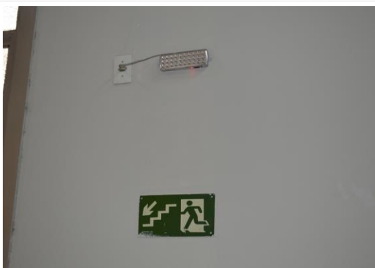
Pará de Minas Prédio Juscelino Kubitschek de Oliveira – Casa da Cultura Sistema de prevenção e combate a incêndio. (foto 52) Imagem: Mateus Fonseca – 27/10/2020
