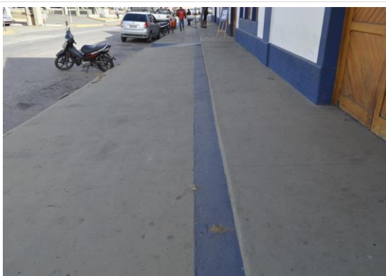
Pará de Minas Estação Ferroviária Passeio na fachada frontal do bem exibindo bom estado sujidades naturais do uso. (foto 59) Imagem: Mateus Fonseca – 27/07/2020
