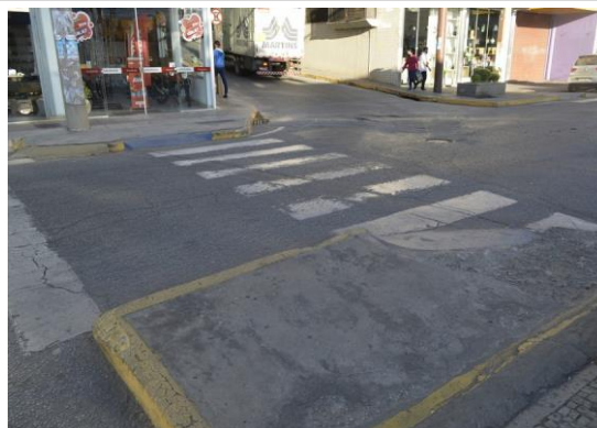
Pará de Minas Praças Torquato de Almeida e Francisco Torquato Manta asfáltica exibindo trincas e desgaste na pintura da sinalização horizontal. (foto 07) Imagem: Mateus Fonseca – 29/07/2020
