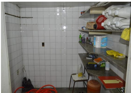
Pará de Minas Estação Ferroviária Revestimentos cerâmicos do depósito apresentam recortes e alguma perda de material. (foto 23) Imagem: Mateus Fonseca – 27/07/2020
