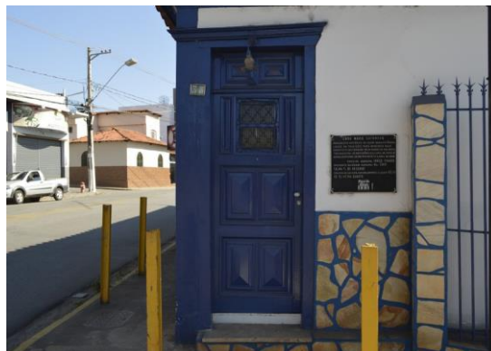
Pará de Minas Casa Maria Capanema Pilar de madeira na fachada do bem em bom estado de conservação. (foto 07) Imagem: Mateus Fonseca – 10/07/2020
