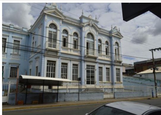
Pará de Minas Irmandade Nossa Senhora da Conceição – Hospital Sacadas e guarda-corpos em ferro forjado da fachada frontal da edificação. (foto 44) Imagem: Mateus Fonseca – 18/09/2020
