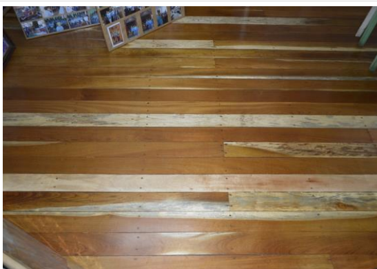
Pará de Minas Casa Maria Capanema Piso de madeira instalado em quase todas as dependências do bem em ótimo estado de conservação. (foto 39) Imagem: Mateus Fonseca – 10/07/2020
