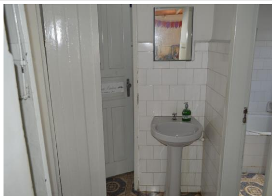
Pará de Minas Casa Maria Capanema Lavatório externo aos banheiros em pleno funcionamento. (foto 52) Imagem: Mateus Fonseca – 10/07/2020
