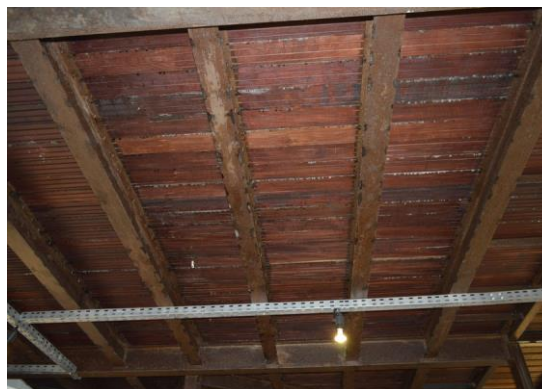
Pará de Minas Estação Ferroviária Estrutura de aço do mezanino sobre o salão principal bem conservada. (foto 54) Imagem: Mateus Fonseca – 27/07/2020
