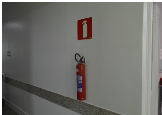
Pará de Minas Irmandade Nossa Senhora da Conceição – Hospital Equipamento de combate a incêndio. (foto 51) Imagem: Mateus Fonseca – 18/09/2020
