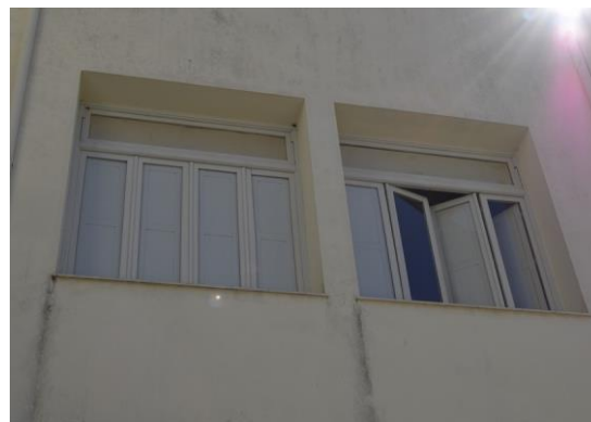
Pará de Minas Fórum Desembargador Pedro Nestor Janelas em madeira e enquadramento em massa na fachada lateral. (foto 24) Imagem: Mateus Fonseca – 06/08/2020
