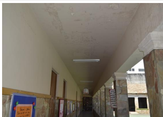
Pará de Minas Escola Estadual Torquato de Almeida As lajes da edificação apresentando manchas e estufamentos causados pela umidade (foto 32) Imagem: Mateus Fonseca – 11/11/2020
