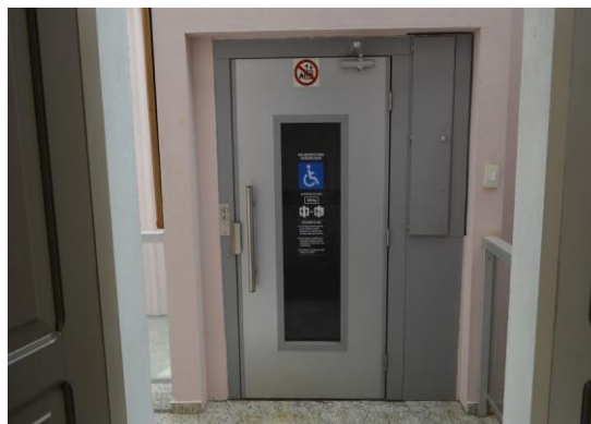
Pará de Minas Prédio Juscelino Kubitschek de Oliveira – Casa da Cultura Porta do elevador de acessibilidade. (foto 22) Imagem: Mateus Fonseca – 27/10/2020
