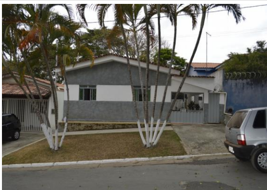
Pará de Minas Núcleo Histórico Urbano do Distrito de Ascensão Edificação à Avenida Abdon Senen de Araújo, 038. (foto 46)
