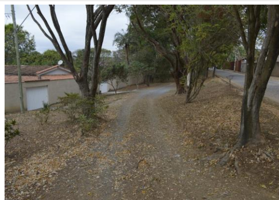
Pará de Minas Núcleo Histórico Urbano do Distrito de Ascensão Trecho de via lateral da Avenida Presidente Kubitschek, onde a pavimentação é em calcário. (foto 11) Imagem: Mateus Fonseca – 24/08/2020
