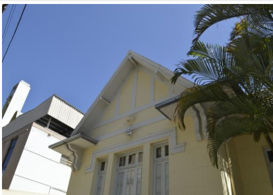
Pará de Minas Escola Estadual Governador Valadares Elementos artísticos na fachada frontal. (foto 18) Imagem: Mateus Fonseca – 19/08/2020
