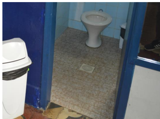
Pará de Minas Escola Municipal de Artes e Ofícios Raimundo Nogueira de Faria - SICA Piso cerâmico comum aos banheiros do bem. (foto 34) Imagem: Mateus Fonseca – 04/09/2020
