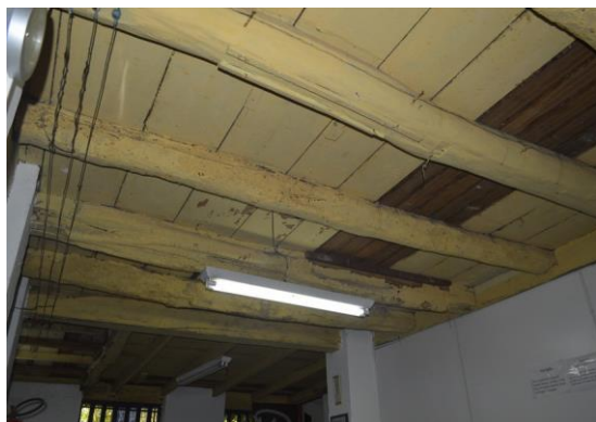
Pará de Minas Escola Municipal de Artes e Ofícios Raimundo Nogueira de Faria - SICA Madeiramento visto do porão. (foto 05) Imagem: Mateus Fonseca – 04/09/2020
