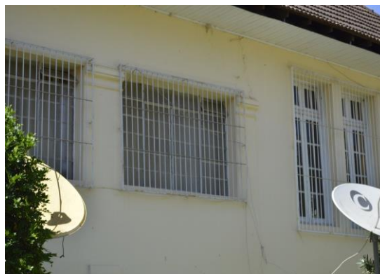
Pará de Minas Escola Estadual Governador Valadares Janelas em metal e vidro, enquadramento em massa e grades nos fundos do bem. (foto 26) Imagem: Mateus Fonseca – 19/08/2020
