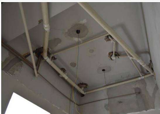
Pará de Minas Centro Literário Pedro Nestor Instalações hidráulicas ainda não finalizadas. (foto 34) Imagem: Mateus Fonseca – 03/09/2020
