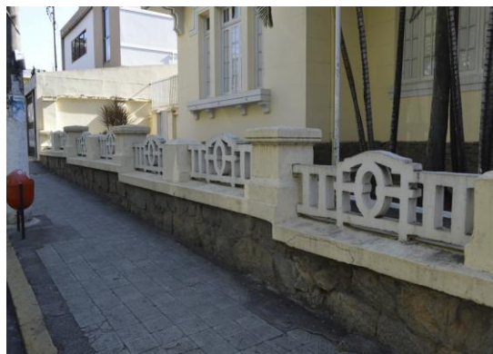
Pará de Minas Escola Estadual Governador Valadares Calçada com piso comentício com remendos em cimento. (foto 48) Imagem: Mateus Fonseca – 19/08/2020
