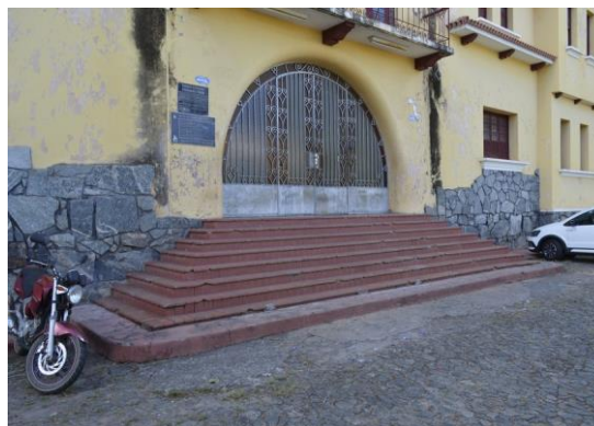
Pará de Minas Escola Estadual Fernando Otávio Escada da entrada principal revestida em cerâmica. (foto 30)
