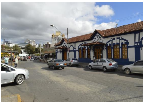
Pará de Minas Estação Ferroviária Via de trânsito intenso em frente ao bem, à esquerda as praças Torquato de Almeida e Francisco Torquato. (foto 71) Imagem: Mateus Fonseca – 27/07/2020
