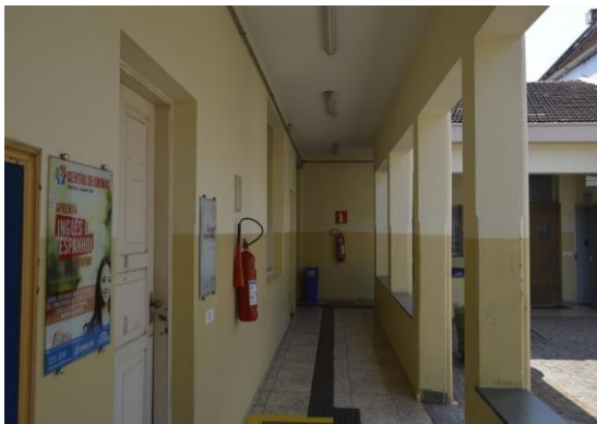
Pará de Minas Asilo Padre José Pereira Coelho Reboco e pintura a óleo e à base de água dos corredores em bom estado de conservação. (foto 11) Imagem: Mateus Fonseca – 30/09/2020
