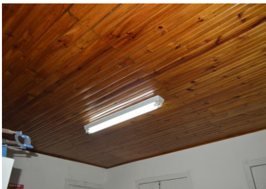
Pará de Minas Casa Maria Capanema Forro de madeira presente em todo interior do bem em bom estado de conservação. (foto 41) Imagem: Mateus Fonseca – 10/07/2020
