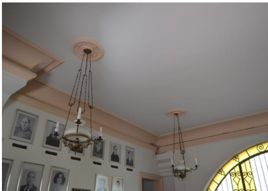
Pará de Minas Escola Estadual Fernando Otávio Forro de gesso com adornos no hall de entrada. (foto 37) Imagem: Mateus Fonseca – 28/08/2020
