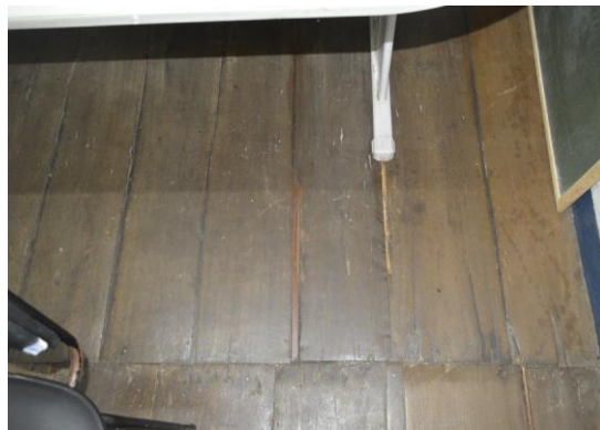
Pará de Minas Escola Municipal de Artes e Ofícios Raimundo Nogueira de Faria - SICA Assoalho de madeira acima do porão com remendos nas frestas. (foto 30) Imagem: Mateus Fonseca – 04/09/2020
