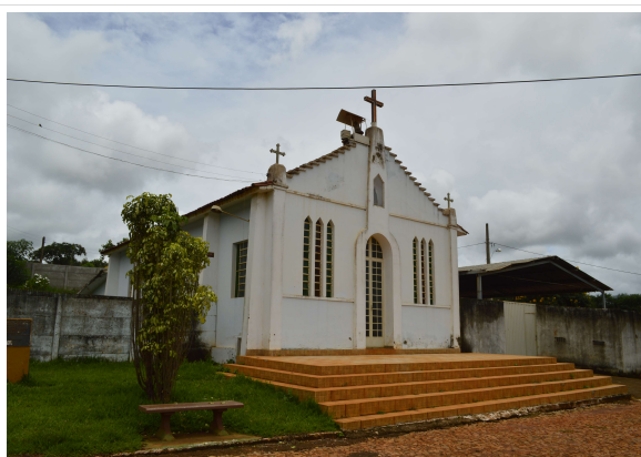
Pará de Minas Fachada com escadaria e rua com calçamento poliédrico (foto 01) Imagem: Júllia Gomes – 13/12/2021
