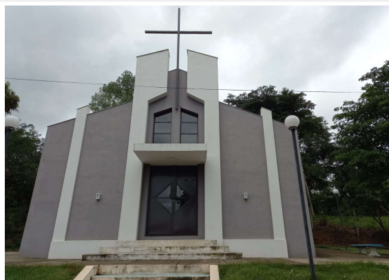
Pará de Minas Fachada Frontal totalmente restaurada
