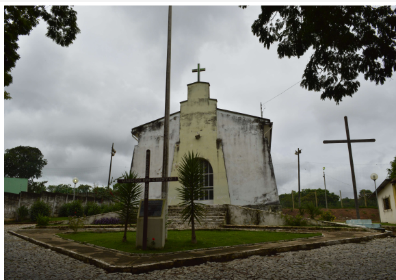
Pará de Minas Fachada Frontal da Igreja de Santa Efigênia (foto 07) Imagem: Júllia Gomes – 13/12/2021
