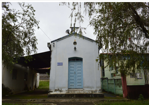
Pará de Minas Vista da Fachada Frontal (foto 07)
