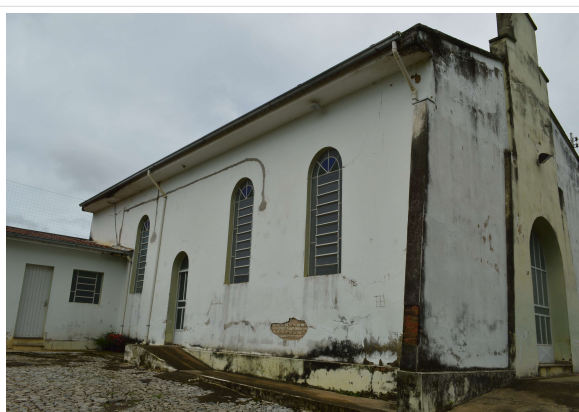
Pará de Minas Fachada lateral esquerda (foto 09) Imagem: Júllia Gomes – 13/12/2021
