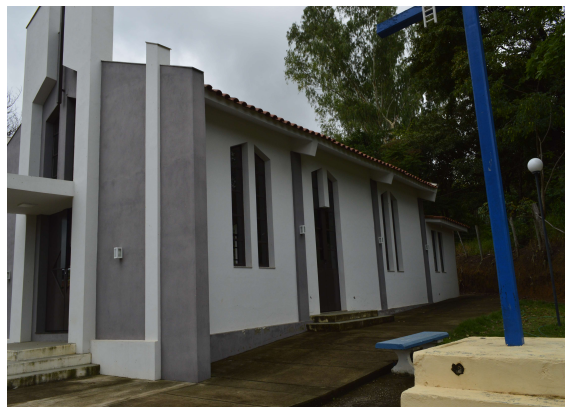
Pará de Minas Fachada Lateral da Igreja (foto 02) Imagem: Júllia Gomes – 13/12/2021
