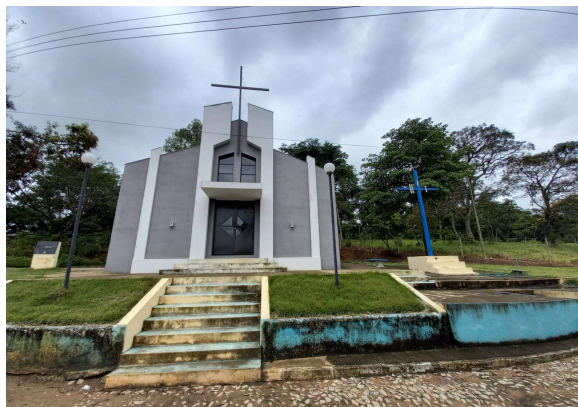
Pará de Minas Fachada Frontal da Igreja de Santa Terezinha (foto 01) Imagem: Júllia Gomes – 13/12/2021
