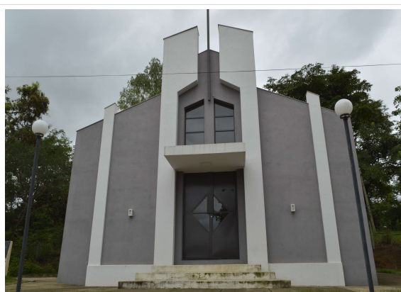
Pará de Minas Vista da Fachada Frontal (foto 05) Imagem: Júllia Gomes – 13/12/2021
