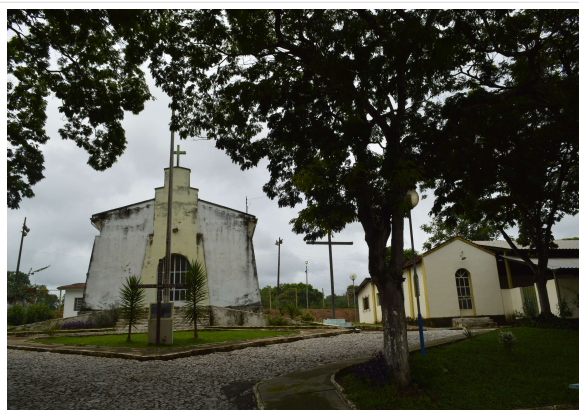
Pará de Minas Igreja de Santa Efigênia – Limas (foto 01) Imagem: Júllia Gomes – 13/12/2021
