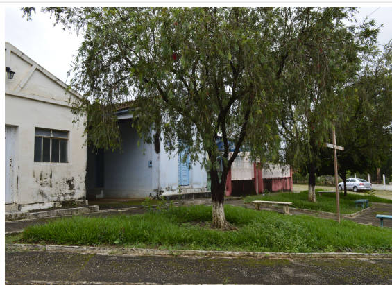
Pará de Minas Fachada Lateral da Capela (foto 02) Imagem: Júllia Gomes – 13/12/2021
