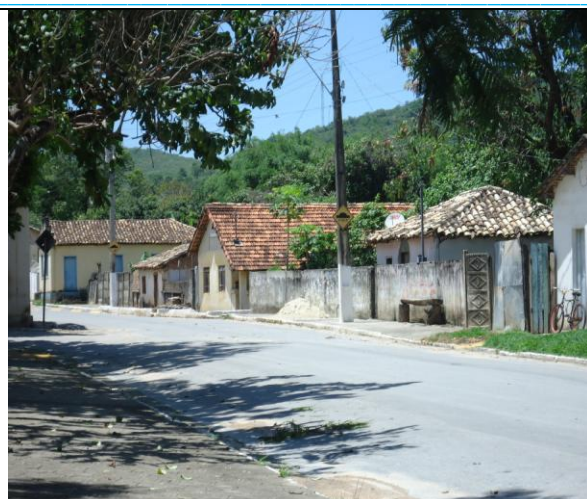
Edificações alinhadas á Rua São Francisco
