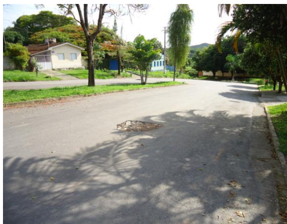
Danos na pavimentação na avenida Abdon Senen de Araújo IMAGEM: Daniele Barbosa, nov 2012
