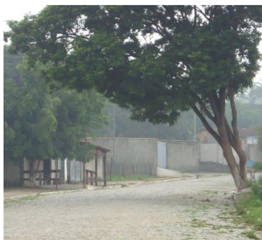
Pavimentação em pé de moleque no início da Praça Nossa de Senhora Lourdes.
