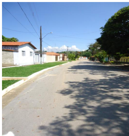
Fiação desordenada á Rua São Francisco. IMAGEM: Daniele Barbosa, nov 2012
