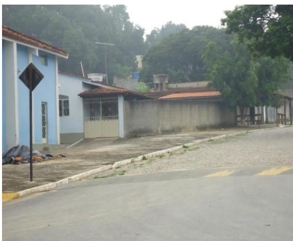
Pavimentação asfáltica em bom estado de conservação na Praça Nossa de Senhora Lourdes.
