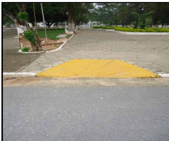
Rampa de acessibilidade á Praça Nossa Senhora de Lourdes IMAGEM: Daniele Barbosa, nov 2012..
