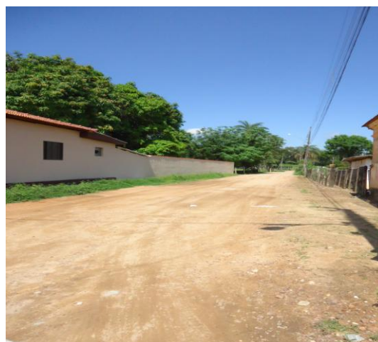
Estrada na esquina com a Rua São Francisco 101, sem pavimentação. IMAGEM: Daniele Barbosa, nov 2012.
