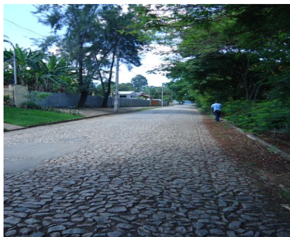
Remendos em asfalto na pavimentação em pé-de-moleque da Avenida Presidente.Kubitscheck. IMAGEM: Daniele Barbosa, nov 2012.
