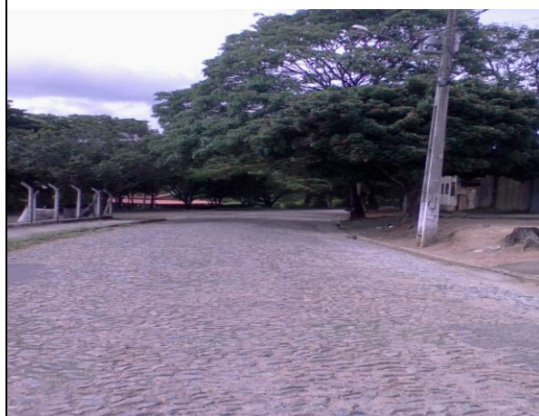
Vegetação obstruindo a visão das edificações na Avenida Presidente Kubitschek. IMAGEM: Daniele Barbosa, nov 2012
