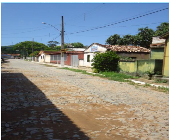
Pavimentação em pé-de-moleque remendas. IMAGEM: Daniele Barbosa ,nov 2012.
