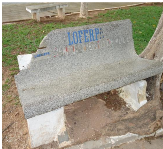
Banco com sinal de vandalismo . IMAGEM: Daniele Barbosa, nov 2012
