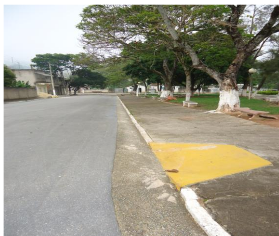
Pavimentação asfáltica com remendas. IMAGEM: Daniele Barbosa, nov 2012.
