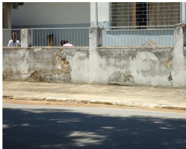
Passeio revestido com cimento , apresentando trincas IMAGEM: Daniele Barbosa, nov 2012
