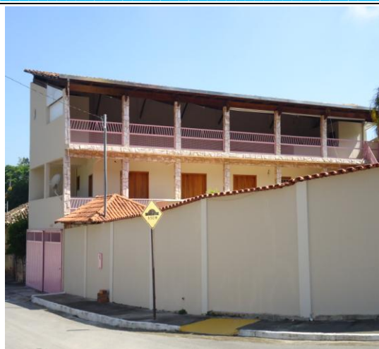
Edificação dita contemporânea na Rua Dona Maria Lopes Cançado.
