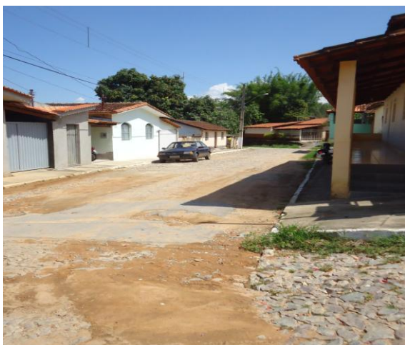
Pavimentação em pé-de-moleque com acúmulo de terra.
