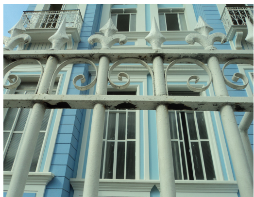
Pará de Minas - Hospital N S da Conceição Detalhe da corrosão por ferrugem (foto 29) Imagem: Isabel Garcia-13/11/2013
