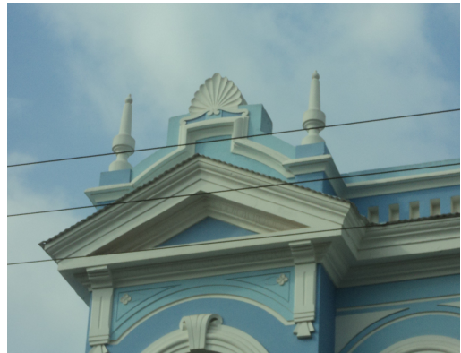
Pará de Minas - Hospital N S da Conceição Coroamento da cismalha (foto 06) Imagem: Isabel Garcia-13/11/2013
