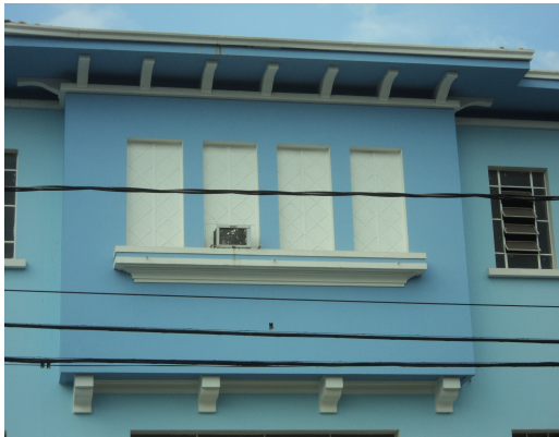
Pará de Minas - Hospital N S da Conceição Beiral em laje (foto 05) Imagem: Isabel Garcia-13/11/2013
