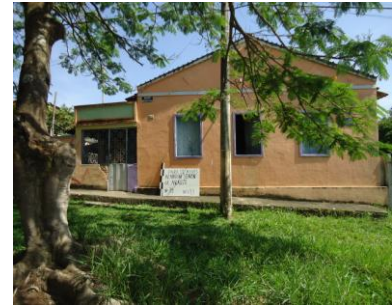
Pará de Minas Núcleo Histórico de Ascensão Avenida Abdon Senen de Araújo39 (foto18) Imagem: Isabel Garcia-12/11/2013
