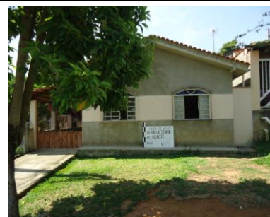
Pará de Minas Núcleo Histórico de Ascensão Avenida Abdon Senen de Araújo 66 (foto 22) Imagem: Isabel Garcia-12/11/2013
