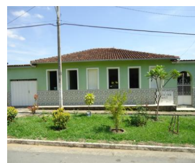
Pará de Minas Núcleo Histórico de Ascensão Avenida Abdon Senen de Araújo- 130 (foto 26) Imagem: Isabel Garcia-12/11/2013
