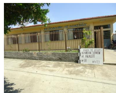
Pará de Minas Núcleo Histórico de Ascensão Avenida Abdon Senen de Araújo- 66 (foto 24) Imagem: Isabel Garcia-12/11/2013
