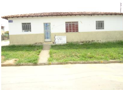
Pará de Minas Núcleo Histórico de Ascensão Praça Santo Antonio- 105 foto(53) Imagem: Isabel Garcia-12/11/2013
