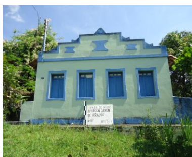
Pará de Minas Núcleo Histórico de Ascensão Avenida Abdon Senen de Araújo - 87 (foto 23) Imagem: Isabel Garcia -12/11/2013
