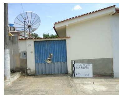
Pará de Minas Núcleo Histórico de Ascensão Rua Pompéu - 38 (foto 59) Imagem: Isabel Garcia-12/11/2013
