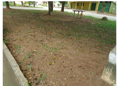
Pará de Minas Núcleo Histórico – Distrito de Ascensão Detalhe da falta do passeio e de grama -(foto 87) Imagem: Isabel Garcia Neto – 19/11/2013
