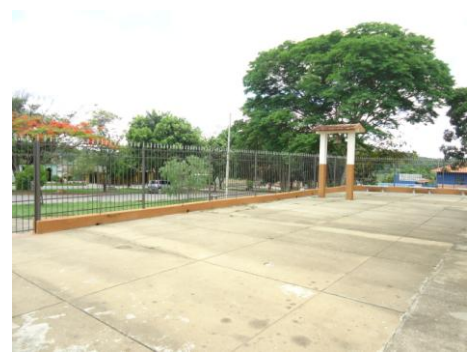
Pará de Minas Núcleo Histórico – Distrito de Ascensão Vista externa do pátio lateral da Igreja -(foto 16) Imagem: Isabel Garcia Neto – 19/11/2013
