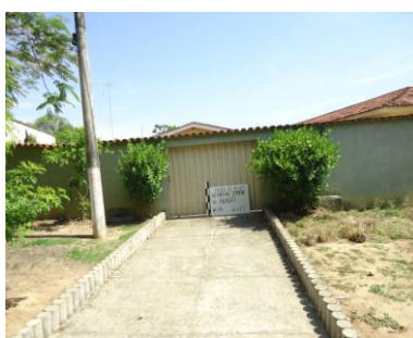
Pará de Minas Núcleo Histórico de Ascensão Avenida Abdon Senen de Araújo – 116 (foto 25) Imagem: Isabel Garcia -12/11/2013
