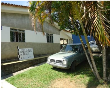
Pará de Minas Núcleo Histórico de Ascensão Avenida Abdon Senen de Araújo 38 (foto 17) Imagem: Isabel Garcia -12/11/2013
