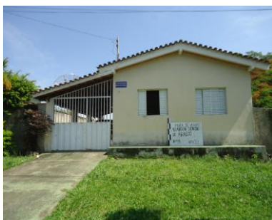
Pará de Minas Núcleo Histórico de Ascensão Avenida Abdon Senen de Araújo 49 (foto 21) Imagem: Isabel Garcia -12/11/2013
