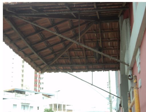
Pará de Minas-Antiga Estação Ferroviária Mão francesa com perda do detalhe aplicado (foto 22) Imagem: Isabel Garcia-13/11/2013
