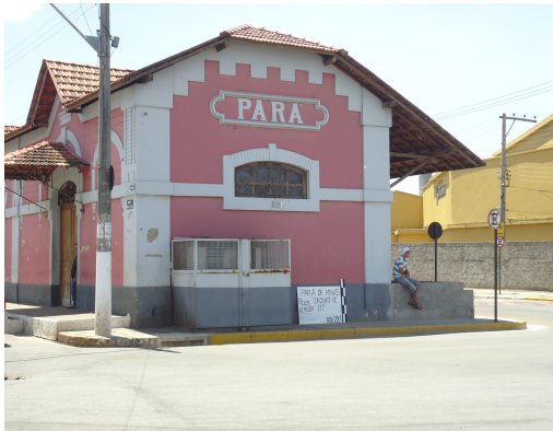
Par  de Minas-Antiga Est o Ferrovi ria Vista da fachada direita(foto 02) Imagem: Isabel Garcia-13/11/2013
