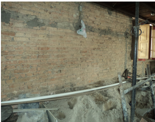
Pará de Minas-Antiga Estação Ferroviária Parede interna sem reboco e pintura (foto 08) Imagem: Isabel Garcia-13/11/2013
