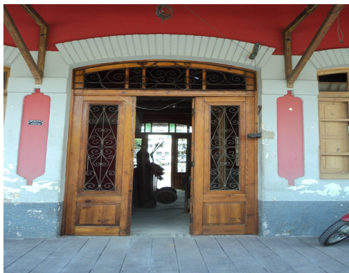
Pará de Minas-Antiga Estação Ferroviária Porta da varanda (foto 14) Imagem: Isabel Garcia-13/11/2013
