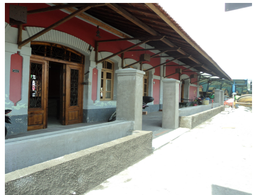
Pará de Minas-Antiga Estação Ferroviária Detalhe do passeio e guarda-corpo (foto 24) Imagem: Isabel Garcia-13/11/2013
