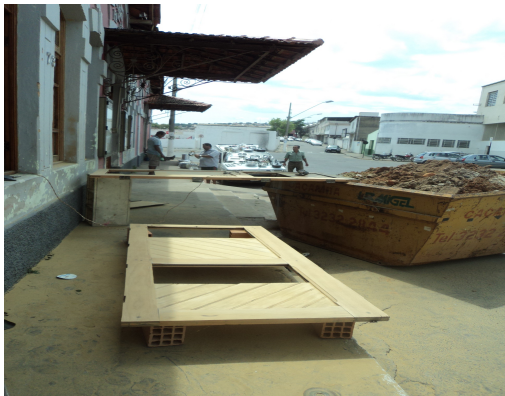
Pará de Minas-Antiga Estação Ferroviária Porta sendo reformada (foto 12) Imagem: Isabel Garcia-13/11/2013
