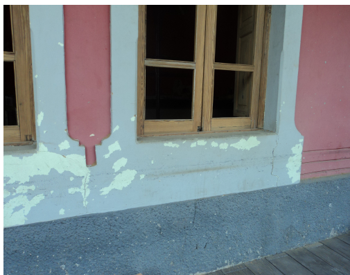
Pará de Minas-Antiga Estação Ferroviária Detalhe da trinca (foto 10) Imagem: Isabel Garcia-13/11/2013
