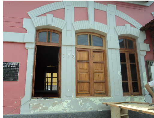
Pará de Minas-Antiga Estação Ferroviária Janelas já lixadas (foto 17) Imagem: Isabel Garcia-13/11/2013
