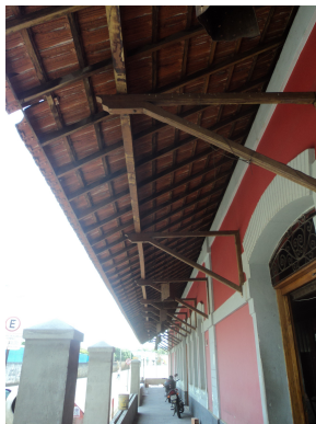
Pará de Minas-Antiga Estação Ferroviária Vista interna da cobertura da varanda (foto 06) Imagem: Isabel Garcia-13/11/2013
