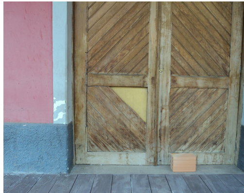
Pará de Minas-Antiga Estação Ferroviária Detalhe da perda de material na porta (foto 18) Imagem: Isabel Garcia-13/11/2013
