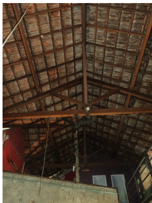
Par  de Minas-Antiga Est o Ferrovi ria Vista interna da cobertura (foto 04) Imagem: Isabel Garcia-13/11/2013
