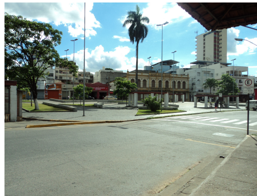
Par de Minas-Antiga Estao Ferroviria Entorno-Praa Torquato de Almeida (foto 26) Imagem: Isabel Garcia-13/11/2013
