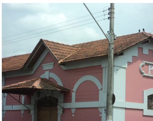
Pará de Minas-Antiga Estação Ferroviária Alvenaria em bom estado (foto 07) Imagem: Isabel Garcia-13/11/2013
