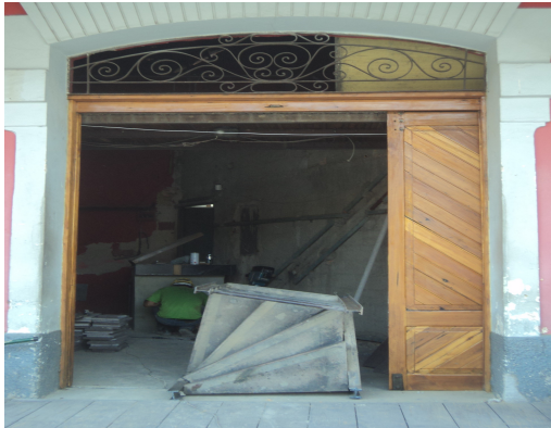
Pará de Minas-Antiga Estação Ferroviária Porta em reforma (foto 16) Imagem: Isabel Garcia-13/11/2013
