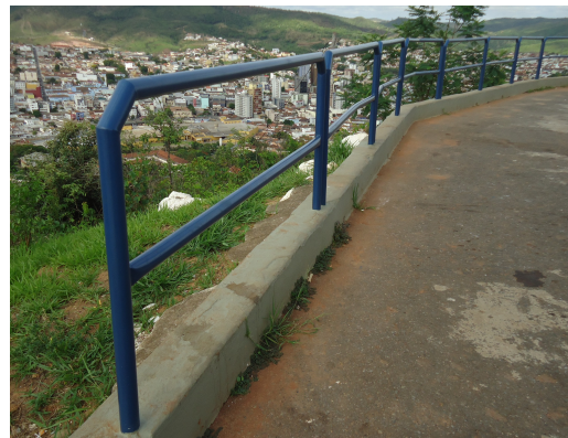
Pará de Minas-Cristo Redentor Guarda-corpo (foto 11)
