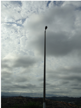
Pará de Minas-Cristo Redentor Poste de iluminação (foto 15) Imagem: Isabel Garcia-01/11/2013
