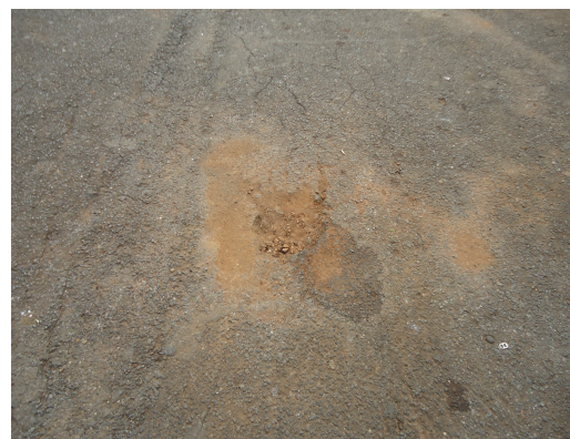
Pará de Minas-Cristo Redentor Buraco na pavimentação (foto 13)
