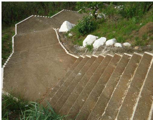
Pará de Minas-Cristo Redentor Acesso por escada (foto 10)
