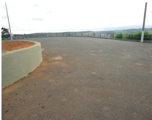
Pará de Minas-Cristo Redentor Pavimentação asfáltica ao redor (foto 12)
