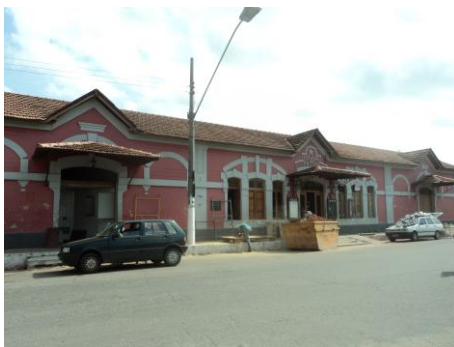
Pará de Minas Pças Torquato de Almeida e Francisco Torquato Entorno-Antiga Estação Ferroviária (foto 41) Imagem: Isabel Garcia-13/11/2013
