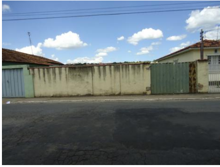
Pará de Minas Gruta Nossa Senhora de Lourdes Sujidades nos muros do entorno (foto 20) Imagem: Isabel Garcia-19/11/2013
