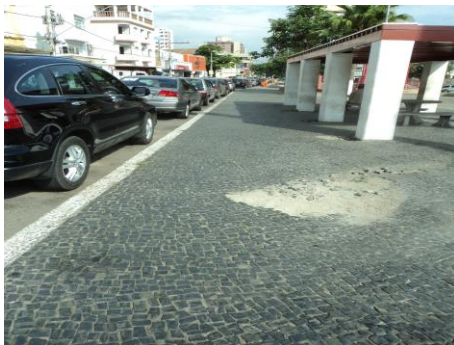
Pará de Minas Pças Torquato de Almeida e Francisco Torquato Perda de material no passeio (foto 09) Imagem: Isabel Garcia-13/11/2013
