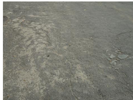
Pará de Minas Gruta Nossa Senhora de Lourdes Detalhe da junção do piso asfáltico com pé de moleque (foto 03) Imagem: Isabel Garcia-19/11/2013
