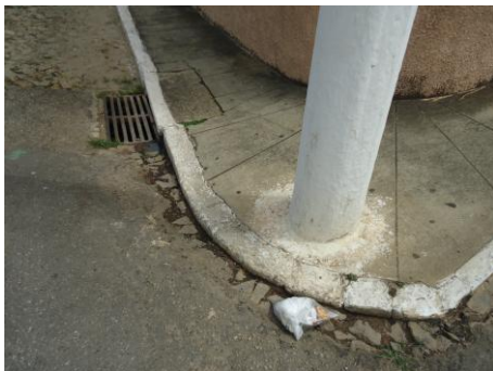
Pará de Minas Gruta Nossa Senhora de Lourdes Detalhe da boca de lobo ( foto 08) Imagem: Isabel Garcia-19/11/2013
