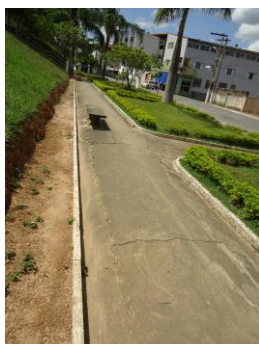
Pará de Minas Gruta Nossa Senhora de Lourdes Vista das rachaduras e trincas do passeio (foto 42) Imagem: Isabel Garcia-19/11/2013
