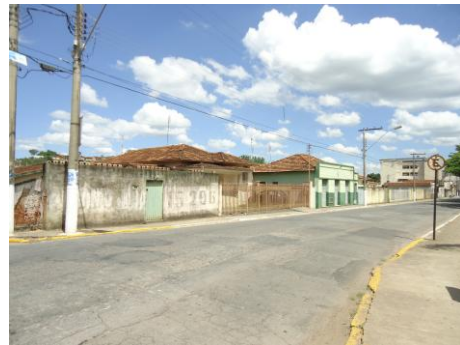
Pará de Minas Gruta Nossa Senhora de Lourdes Sujidade das edificações do entorno (foto 23 ) Imagem: Isabel Garcia-19/11/2013
