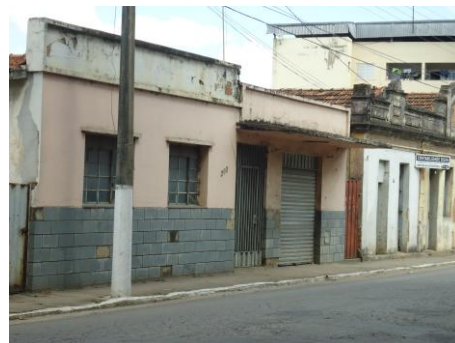
Pará de Minas Gruta Nossa Senhora de Lourdes Sujidades nas edificações (foto 19 ) Imagem: Isabel Garcia-19/11/2013
