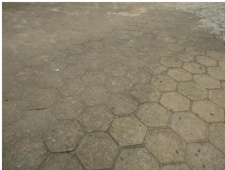
Pará de Minas Gruta Nossa Senhora de Lourdes Detalhe do afundamento do piso (foto52) Imagem: Isabel Garcia-19/11/2013
