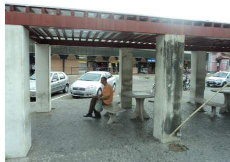
Pará de Minas Pças Torquato de Almeida e Francisco Torquato Detalhe das manchas de umidade e piso (foto 32) Imagem: Isabel Garcia-13/11/2013
