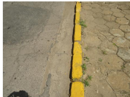
Pará de Minas Gruta Nossa Senhora de Lourdes Detalhe da sarjeta (foto 09) Imagem: Isabel Garcia-19/11/2013
