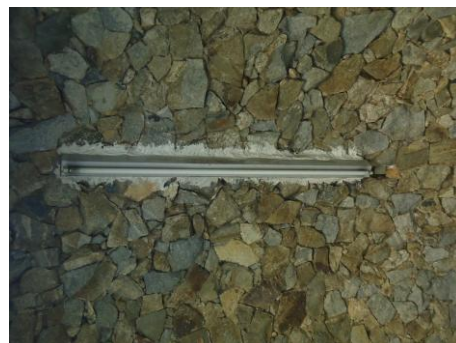
Pará de Minas Gruta Nossa Senhora de Lourdes Detalhe da fixação da luminária no teto (foto 37) Imagem: Isabel Garcia-19/11/2013
