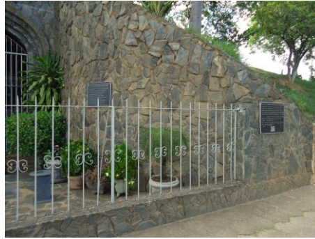
Pará de Minas Gruta Nossa Senhora de Lourdes Placas em ferro fundido (foto 07) Imagem: Isabel Garcia-19/11/2013
