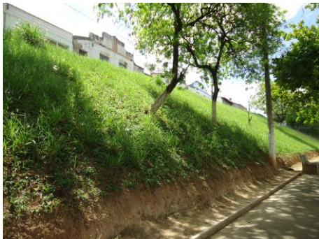
Pará de Minas Gruta Nossa Senhora de Lourdes Vista do talude e banco sujidade (foto 40) Imagem: Isabel Garcia-19/11/2013
