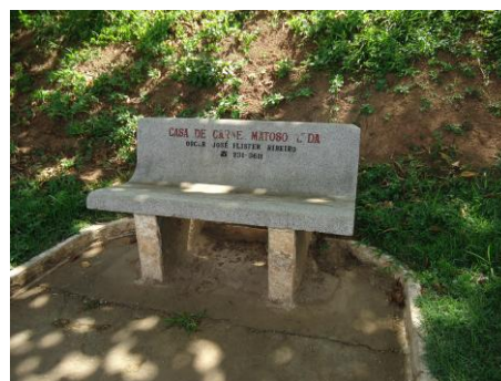
Pará de Minas Gruta Nossa Senhora de Lourdes Detalhe dos danos no piso e banco (foto 47) Imagem: Isabel Garcia-19/11/2013
