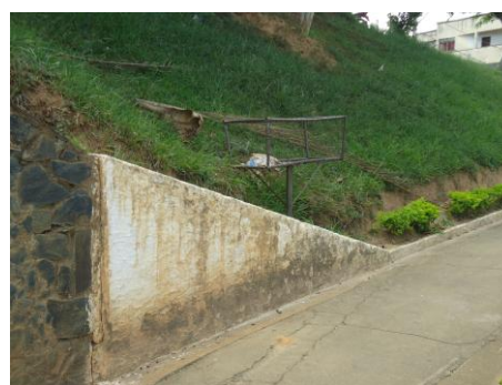
Pará de Minas Gruta Nossa Senhora de Lourdes Detalhe dos danos no arrimo (foto 49) Imagem: Isabel Garcia-19/11/2013
