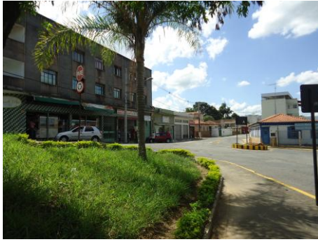
Pará de Minas Gruta Nossa Senhora de Lourdes Detalhe do afundamento do piso (foto60) Imagem: Isabel Garcia-19/11/2013
