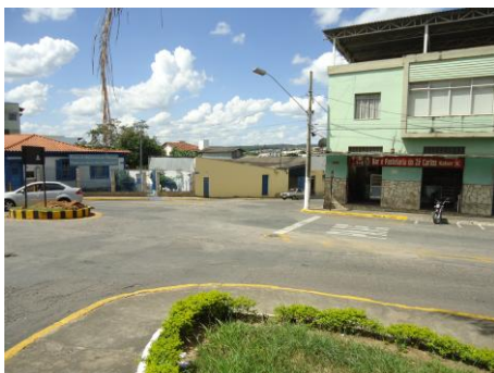
Pará de Minas Gruta Nossa Senhora de Lourdes Detalhe do afundamento do piso (foto58) Imagem: Isabel Garcia-19/11/2013
