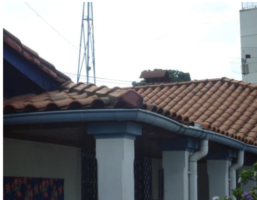
Para de Minas - Casa Maria Capanema Vista do telhado (foto 04)
