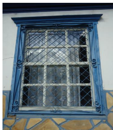
Para de Minas - Casa Maria Capanema Detalhe da janela e grade (foto 16)
