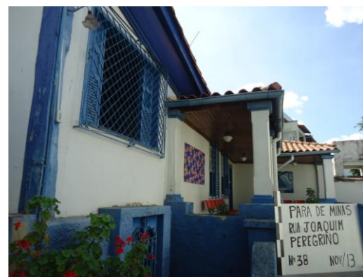
Para de Minas - Casa Maria Capanema detalhe dos danos da pintura externa (foto 10)
