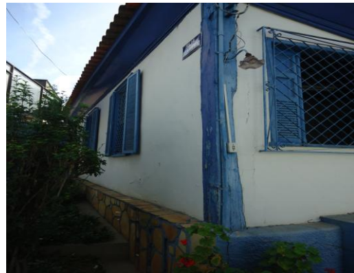
Para de Minas - Casa Maria Capanema Estrutura em madeira e atijolo autoportante(foto 03)
