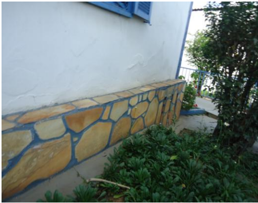
Para de Minas - Casa Maria Capanema Detalhe dos danos na pintura externa(foto 11) Imagem: Isabel C Garcia Neto-20/11/2013
