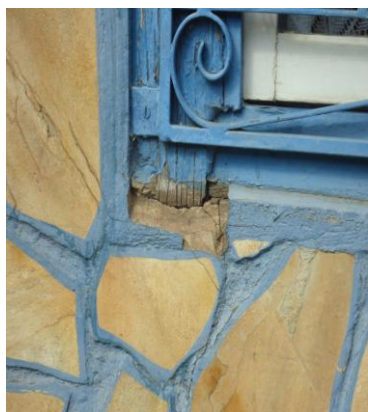
Para de Minas - Casa Maria Capanema Detalhe da janela (foto 17)
