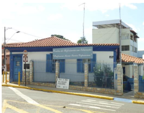
Para de Minas - Casa Maria Capanema Vista da pintura externa (foto 09)
