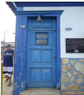
Para de Minas - Casa Maria Capanema Vista da porta (foto 13) Imagem: Isabel C Garcia Neto-20/11/2013
