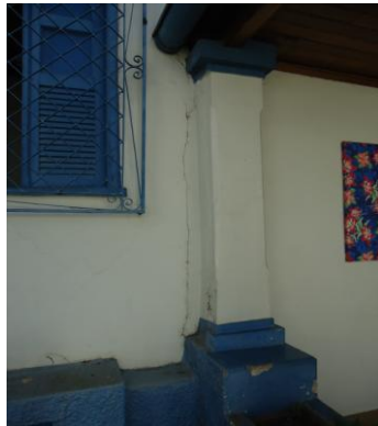
Para de Minas - Casa Maria Capanema Vista da alvenaria externa (foto 07)
