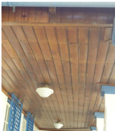
Para de Minas - Casa Maria Capanema Detalhe do forro em lambris (foto 22) Imagem: Isabel C Garcia Neto-20/11/2013
