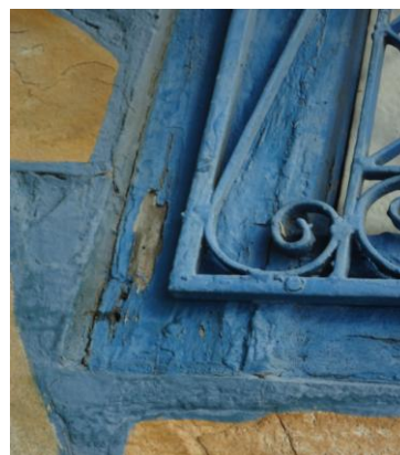
Para de Minas - Casa Maria Capanema Detalhe da janela e grade (foto 18)
