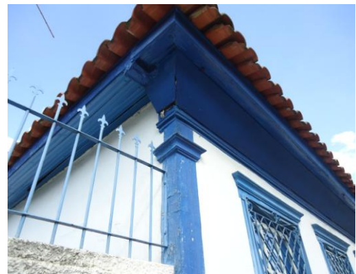
Para de Minas - Casa Maria Capanema Vista do beiral(foto 05)
