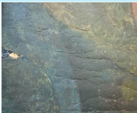
Detalhe do desprendimento na Tela “Ressurreição de Cristo” IMAGEM: Ana Leonídia, nov 2012.
