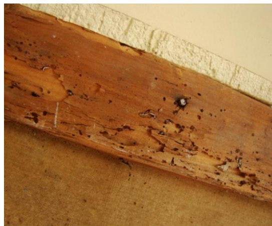
Detalhe do chassi que sofre com ataque de insetos
