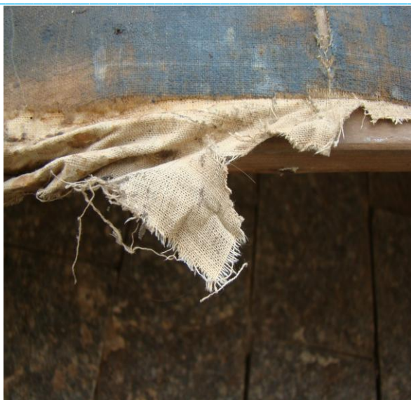
Detalhe do desprendimento da tela
