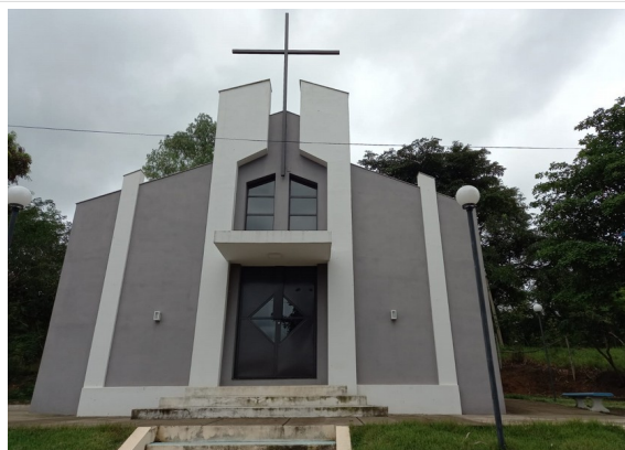
Pará de Minas Fachada Frontal totalmente restaurada
