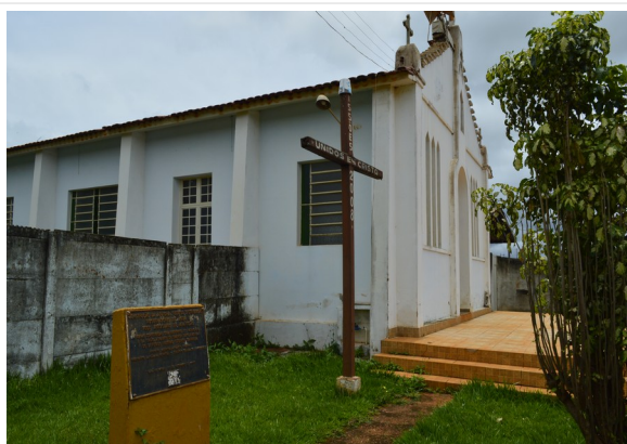
Pará de Minas Fachada Lateral Esquerda (foto 04) Imagem: Júlia Gomes – 13/12/2021
