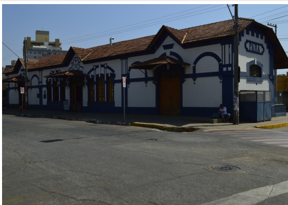
Pará de Minas Estação Ferroviária Reboco e pintura externos no geral exibem bom estado. (foto 15) Imagem: Júllia Gomes – 12/08/2021
