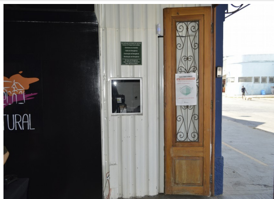
Pará de Minas Estação Ferroviária Porta de isolamento acústico de acesso à bilheteria do cinema exibindo bom estado. (foto 33) Imagem: Júllia Gomes – 12/08/2021
