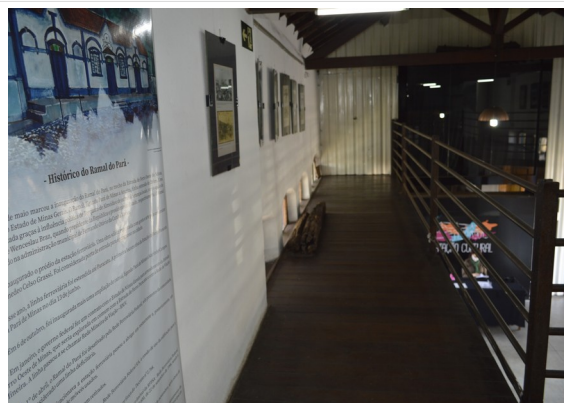
Pará de Minas Estação Ferroviária Alvenarias internas em bom estado de conservação. (foto 13) Imagem: Júlia Gomes – 12/08/2021
