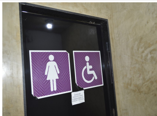
Pará de Minas Estação Ferroviária Porta do banheiro PNE no térreo feita em madeira laqueada exibindo bom estado. (foto 34) Imagem: Júllia Gomes – 12/08/2021
