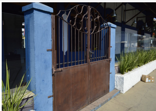
Pará de Minas Estação Ferroviária Portão de ferro que dá acesso à varanda em bom estado. (foto 61) Imagem: Júllia Gomes – 12/08/2021
