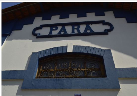
Pará de Minas Estação Ferroviária Janela da fachada lateral direita em ferro e vidro, enquadramento em massa sobreverga e elementos artísticos em bom estado. (foto 31) Imagem: Júllia Gomes – 12/08/2021
