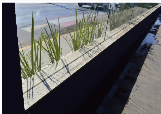
Pará de Minas Estação Ferroviária Muro em alvenaria e vidro com jardim na fachada posterior em bom estado de conservação. (foto 57) Imagem: Júllia Gomes – 12/08/2021
