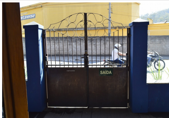
Pará de Minas Estação Ferroviária Vista interna do portão da varanda. (foto 62) Imagem: Júllia Gomes – 12/08/2021
