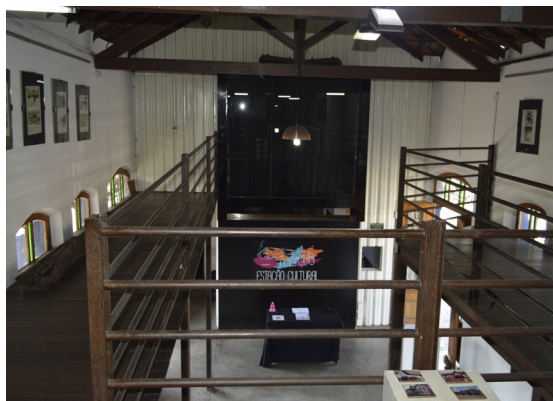
Pará de Minas Estação Ferroviária Parede metálica de isolamento acústico e janela que da vista a sala de projeção em bom estado. (foto 37) Imagem: Júllia Gomes – 12/08/2021
