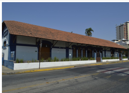
Pará de Minas Estação Ferroviária Fachada posterior com paisagismo novo (foto 04)
