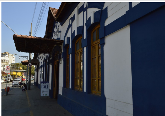
Pará de Minas Estação Ferroviária Fachada frontal exibindo alvenarias em bom estado de conservação. (foto 12) Imagem: Júlia Gomes – 12/08/2021
