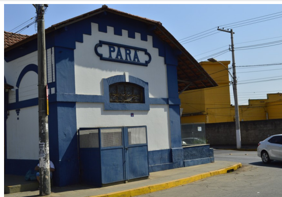
Pará de Minas Estação Ferroviária Fachada lateral esquerda. (foto 03)
