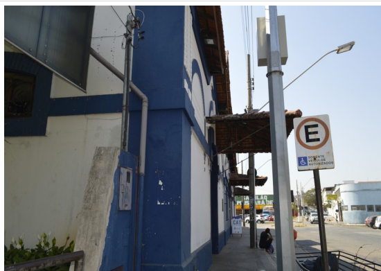
Pará de Minas Estação Ferroviária Fachada lateral direita. (foto 02)
