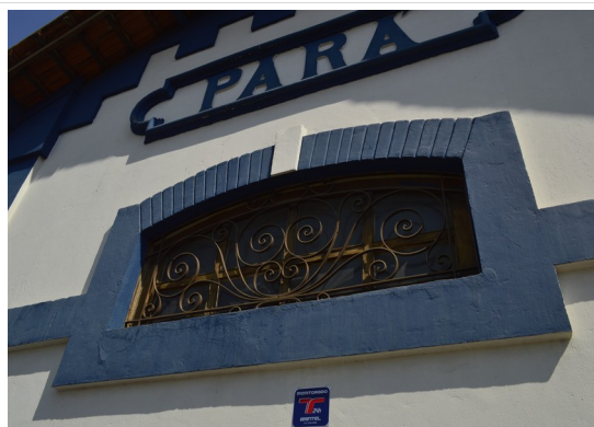
Pará de Minas Estação Ferroviária Janela da fachada lateral esquerda em ferro e vidro, enquadramento em massa sobreverga e elementos artísticos. (foto 32) Imagem: Júllia Gomes – 12/08/2021
