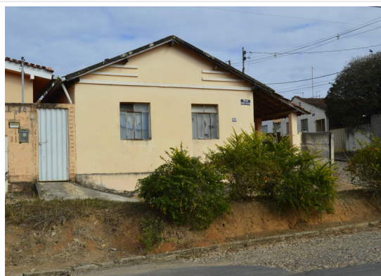
Pará de Minas Núcleo Histórico Urbano do Distrito de Ascensão Edificação à Avenida Presidente Kubitschek, 160. (foto 57)
