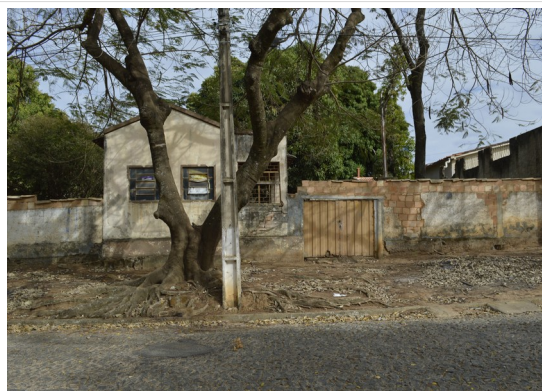
Pará de Minas Núcleo Histórico Urbano do Distrito de Ascensão Edificação à Avenida Presidente Kubitschek, 210. (foto 59)
