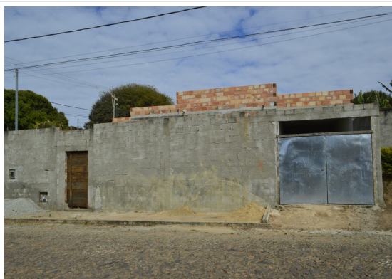
Pará de Minas Núcleo Histórico Urbano do Distrito de Ascensão Edificação à Avenida Presidente Kubitschek, 126. (foto 56)
