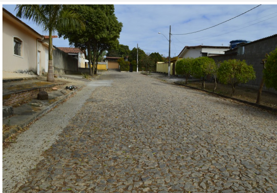
Par  de Minas N cleo Hist rico Urbano do Distrito de Ascens o Vista da Rua Pompeu em p  de moleque. (foto 10) Imagem: J llia Gomes – 06/08/2021
