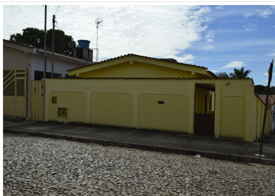
Pará de Minas Núcleo Histórico Urbano do Distrito de Ascensão Edificação à Avenida Presidente Kubitschek, 095. (foto 54)
