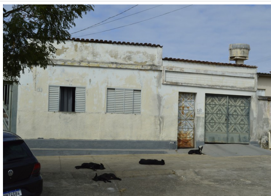
Par  de Minas N cleo Hist rico Urbano do Distrito de Ascens o Edif.   Pra a Santo Ant nio, 039.
