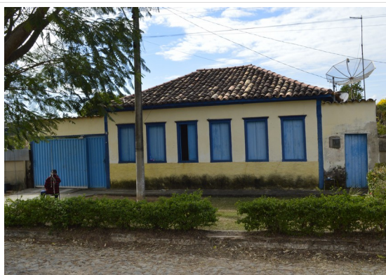
Pará de Minas Núcleo Histórico Urbano do Distrito de Ascensão Edificação à Rua Raimundo Penaforte de Araújo, 090. (foto 86)
