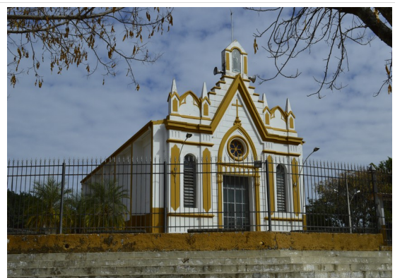
Pará de Minas Núcleo Histórico Urbano do Distrito de Ascensão Vista frontal da Igreja de Santo Antônio.
