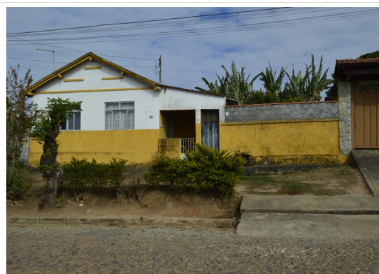
Pará de Minas Núcleo Histórico Urbano do Distrito de Ascensão Edificação à Avenida Presidente Kubitschek, 110. (foto 55)
