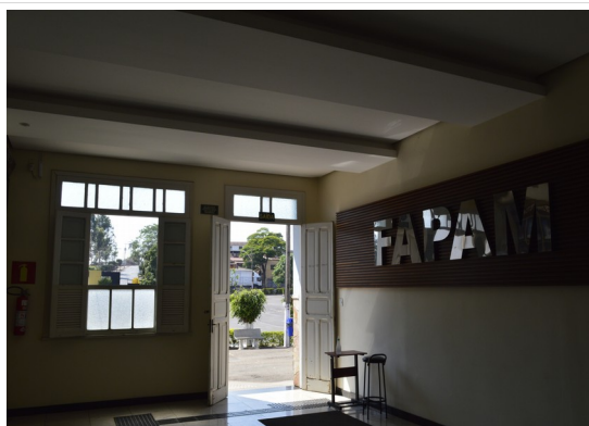
Pará de Minas Asilo Padre José Pereira Coelho Vista interna da porta e da janela existentes na fachada
