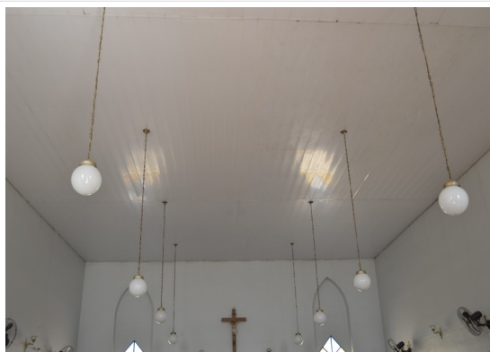
Pará de Minas Asilo Padre José Pereira Coelho Forro de PVC da Capela de Santo Antônio (foto 47) Imagem: Júllia Gomes– 01/10/2021
