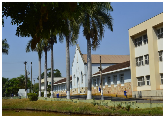
Pará de Minas Asilo Padre José Pereira Coelho Fachada lateral direita recebeu anexo. (foto 02) Imagem: Júllia Gomes– 01/10/2021
