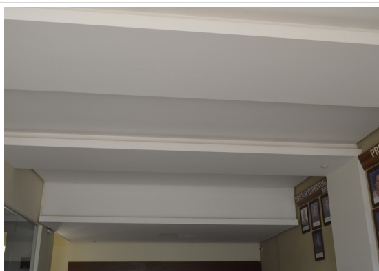
Pará de Minas Asilo Padre José Pereira Coelho Forro de gesso na recepção. (foto 43) Imagem: Júllia Gomes– 01/10/2021
