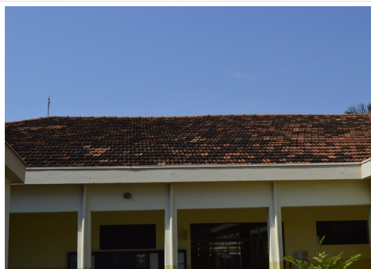
Pará de Minas Asilo Padre José Pereira Coelho Condutores de águas pluviais bem conservados. (foto 07) Imagem: Júllia Gomes– 01/10/2021
