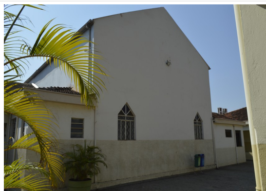
Pará de Minas Asilo Padre José Pereira Coelho Fachada posterior (foto 04) Imagem: Júllia Gomes– 01/10/2021
