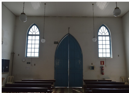
Pará de Minas Asilo Padre José Pereira Coelho Vista interna da porta principal da Capela em bom estado de conservação. (foto 21) Imagem: Júllia Gomes– 01/10/2021
