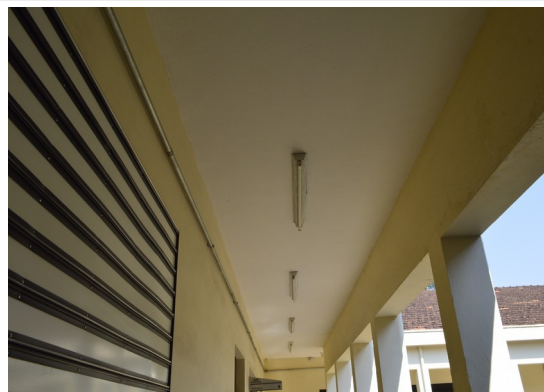
Pará de Minas Asilo Padre José Pereira Coelho Lajes dos corredores que conformam o pátio interno. (foto 46) Imagem: Júllia Gomes– 01/10/2021
