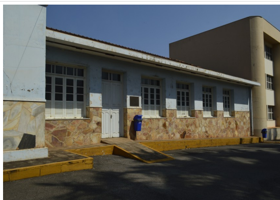
Pará de Minas Asilo Padre José Pereira Coelho Portas e janelas em madeira que recebem pintura a óleo na
