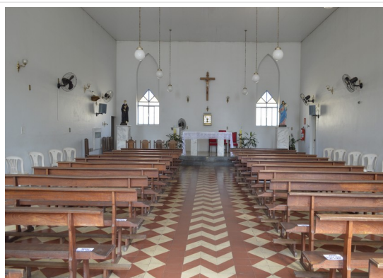
Pará de Minas Asilo Padre José Pereira Coelho Reboco e pinturas à base de água do interior da Capela em bom estado de conservação. (foto 12) Imagem: Júllia Gomes– 01/10/2021
