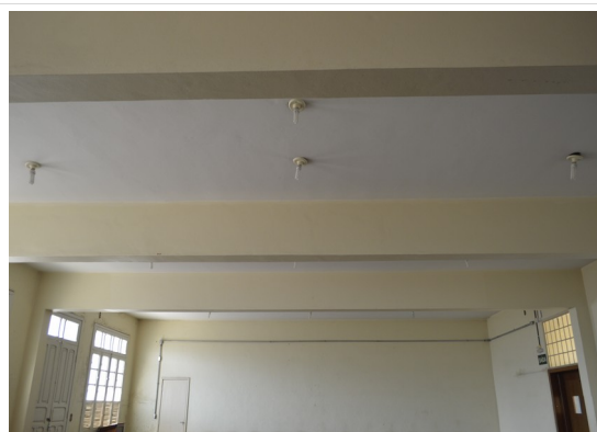
Pará de Minas Asilo Padre José Pereira Coelho Laje do auditório. (foto 44) Imagem: Júllia Gomes– 01/10/2021
