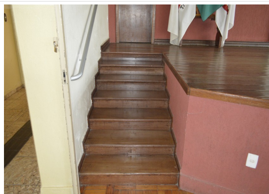
Pará de Minas Asilo Padre José Pereira Coelho Escada de acesso ao palco em madeira em bom estado de conservação. (foto 35) Imagem: Júllia Gomes– 01/10/2021
