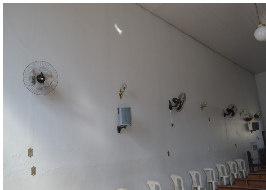
Pará de Minas Asilo Padre José Pereira Coelho Alvenarias do interior da Capela de Santo Antônio estão em bom estado de conservação. (foto 09) Imagem: Júllia Gomes– 01/10/2021
