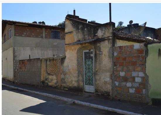
Pará de Minas Núcleo Histórico Urbano do Distrito de Carioca Edificação à Rua Dona Maria Lopes Cançado, 100' (foto 45)
