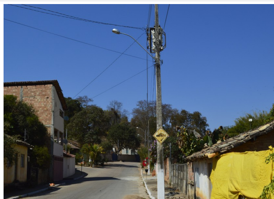
Pará de Minas Núcleo Histórico Urbano do Distrito de Carioca Poste de iluminação pública na Rua Dona Maria Lopes Cançado. (foto 29) Imagem: Júllia Gomes – 18/08/2021
