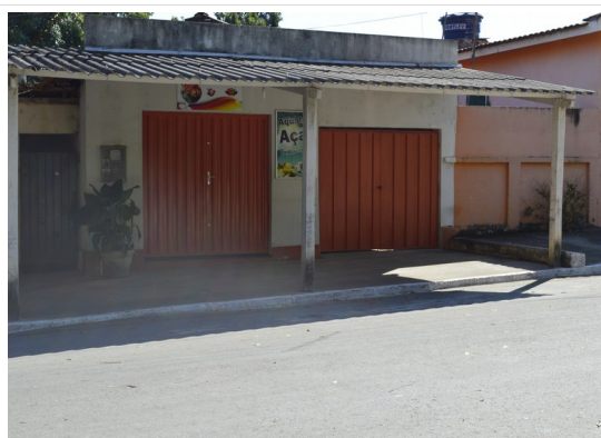
Pará de Minas Núcleo Histórico Urbano do Distrito de Carioca Sorveteria que também utiliza a calçada para dispor suas mesas e cadeiras, no momento encontrava-se fechada. (foto 33) Imagem: Júllia Gomes – 18/08/2021
