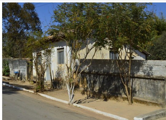
Pará de Minas Núcleo Histórico Urbano do Distrito de Carioca Edificação à Rua Dona Maria Lopes Cançado, 100 (foto 44)
