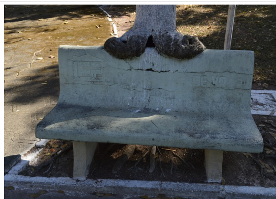
Pará de Minas Núcleo Histórico Urbano do Distrito de Carioca Banco em concreto exibindo algumas trincas devido ao esforço que a árvore está exercendo sobre o concreto. (foto 72) Imagem: Júllia Gomes – 18/08/2021
