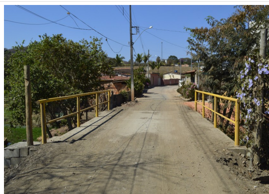
Pará de Minas Núcleo Histórico Urbano do Distrito de Carioca Ponte Nova de acesso para o Distrito de Carioca
