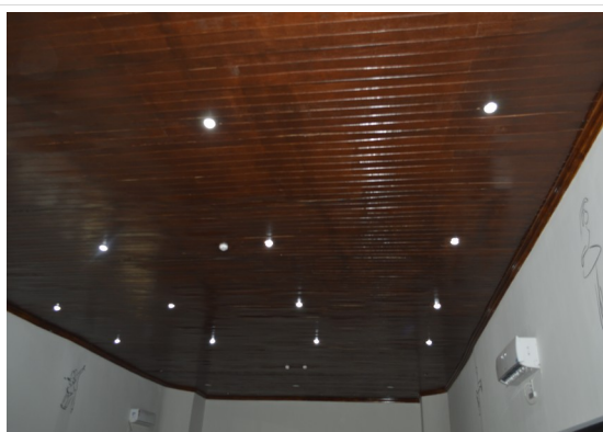
Pará de Minas Centro Literário Pedro Nestor Forro em madeira em bom estado. (foto 05) Imagem: Júllia Gomes – 24/09/2021
