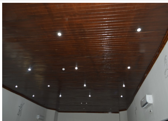
Pará de Minas Centro Literário Pedro Nestor Instalações elétricas finalizadas. (foto 35) Imagem: Júllia Gomes – 24/09/2021
