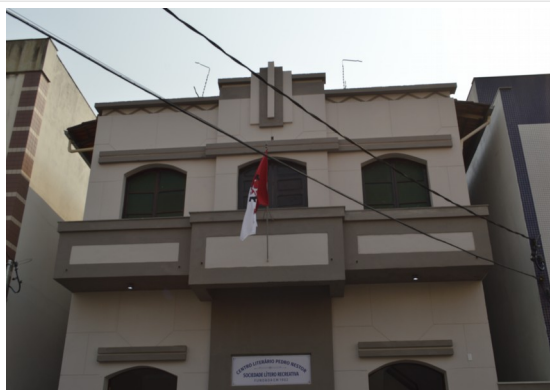
Pará de Minas Centro Literário Pedro Nestor Frontão da edificação. (foto 07) Imagem: Júllia Gomes – 24/09/2021
