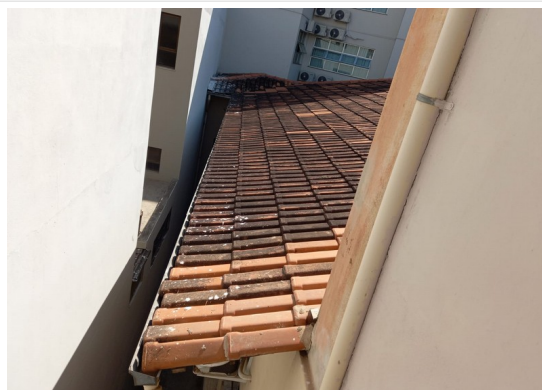
Pará de Minas Centro Literário Pedro Nestor Telhado do bem em bom estado de conservação. (foto 08) Imagem: Júllia Gomes – 29/09/2021
