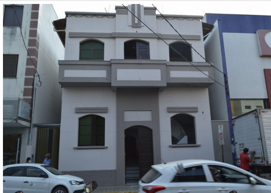
Pará de Minas Centro Literário Pedro Nestor Reboco da fachada frontal em bom estado. (foto 11) Imagem: Júllia Gomes – 24/09/2021
