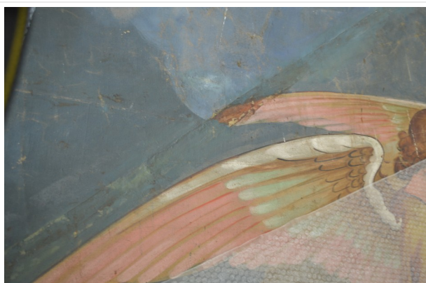
Pará de Minas Telas da Antiga Matriz de Nossa Senhora da Piedade Craquelês, perda de policromia e pontos com oxidação. (foto 38) Imagem: Júllia Gomes – 20/08/2021
