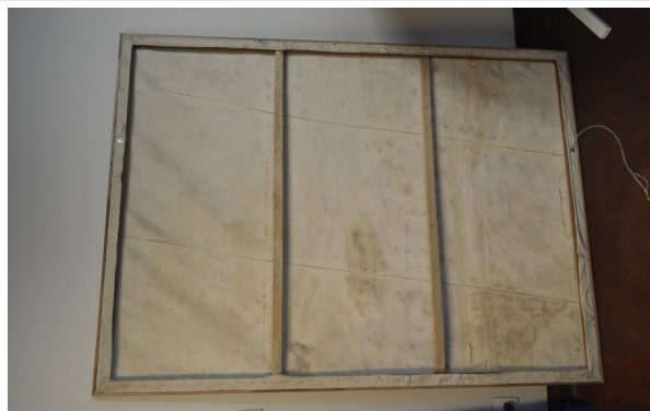
Pará de Minas Telas da Antiga Matriz de Nossa Senhora da Piedade Vista posterior da Tela Anjos com Incensórios 2 apresenta bom estado de conservação. (foto 17) Imagem: Júllia Gomes – 20/08/2021
