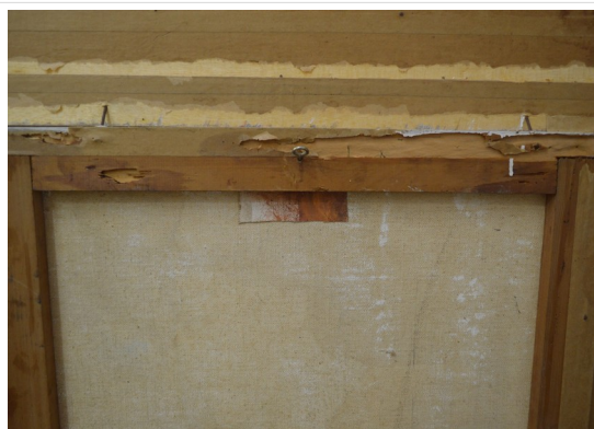
Pará de Minas Telas da Antiga Matriz de Nossa Senhora da Piedade Chassi apresenta descolamento posterior. (foto 36) Imagem: Júllia Gomes – 01/10/2021
