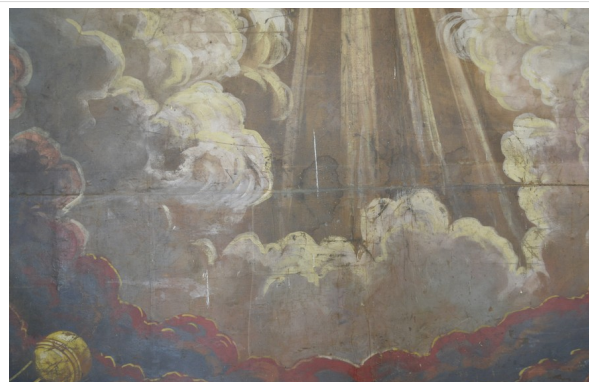
Pará de Minas Telas da Antiga Matriz de Nossa Senhora da Piedade Furos atravessando tela original e reentelamento, craquelês, manchas de tinta branca e perdas. (foto 31) Imagem: Júllia Gomes – 20/08/2021
