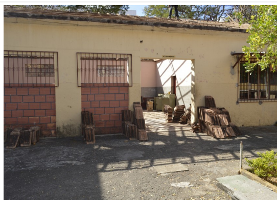
Pará de Minas Escola Estadual Fernando Otávio Refeitório em reforma conforme ata em anexo. (foto 24) Imagem: Júllia Gomes – 30/08/2021
