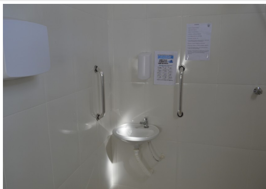
Pará de Minas Escola Estadual Fernando Otávio Revestimento cerâmico nos banheiros acessíveis. (foto 17) Imagem: Júllia Gomes – 30/08/2021
