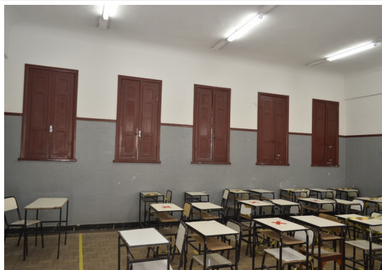
Pará de Minas Escola Estadual Fernando Otávio Pintura a base de água e barrado em tinta a óleo nas salas de aula. (foto 19) Imagem: Júllia Gomes – 30/08/2021
