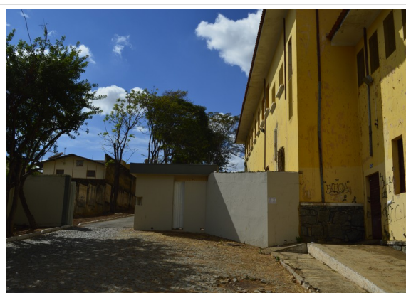
Pará de Minas Escola Estadual Fernando Otávio Fachada lateral esquerda. (foto 03) Imagem: Júlia Gomes – 30/08/2021
