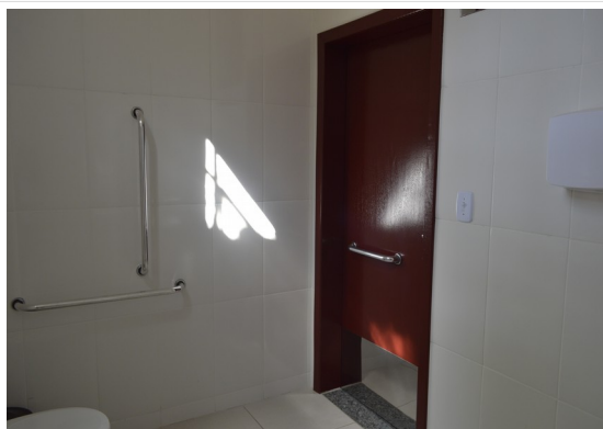
Pará de Minas Escola Estadual Fernando Otávio Porta prancheta dos banheiros acessíveis. (foto 25) Imagem: Júllia Gomes – 30/08/2021
