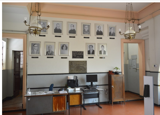
Pará de Minas Escola Estadual Fernando Otávio Alvenaria do hall de entrada. (foto 14) Imagem: Júllia Gomes – 30/08/2021
