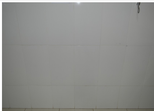
Pará de Minas Escola Estadual Fernando Otávio Revestimento cerâmico nos banheiros. (foto 18) Imagem: Júllia Gomes – 30/08/2021
