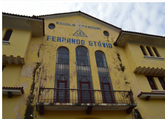
Pará de Minas Escola Estadual Fernando Otávio Pintura a base de água nas fachadas. (foto 20) Imagem: Júllia Gomes – 30/08/2021
