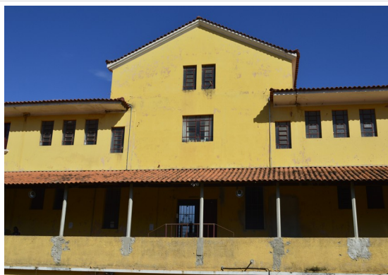
Pará de Minas Escola Estadual Fernando Otávio Alvenarias externas na fachada posterior. (foto 13) Imagem: Júllia Gomes – 30/08/2021
