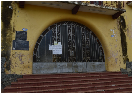
Pará de Minas Escola Estadual Fernando Otávio Porta de acesso principal à edificação em metal e vidro. (foto 21) Imagem: Júllia Gomes – 30/08/2021
