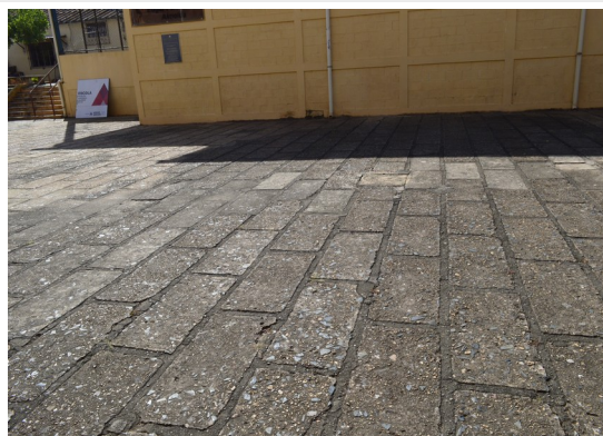
Pará de Minas Escola Estadual Fernando Otávio Piso cimentício no pátio interno. (foto 32) Imagem: Júllia Gomes – 30/08/2021
