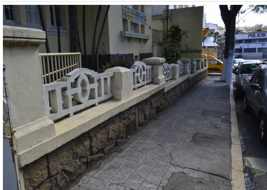
Pará de Minas Escola Estadual Governador Valadares Muro baixo com elemento vazado e revestido por pedras na fachada frontal. (foto 46) Imagem: Júllia Gomes– 02/09/2021
