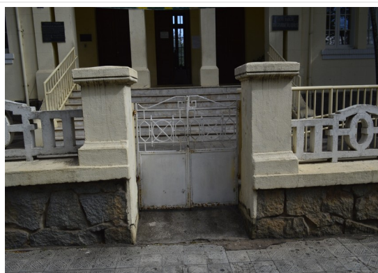
Pará de Minas Escola Estadual Governador Valadares Portal de metal na fachada frontal. (foto 47) Imagem: Júllia Gomes– 02/09/2021
