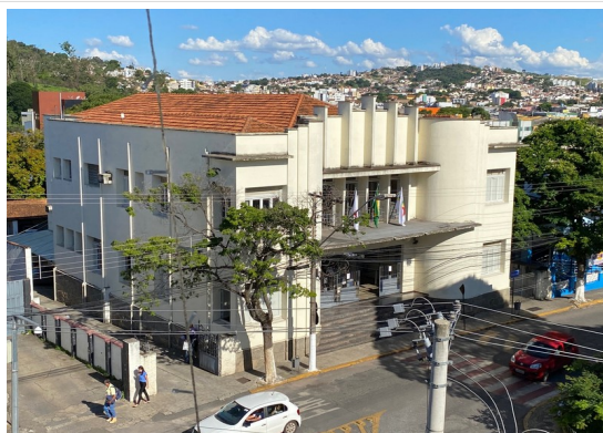
Pará de Minas Fórum Desembargador Pedro Nestor Manto de cobertura em telhas francesas. (foto 08) Imagem: Júllia Gomes – 01/09/2021
