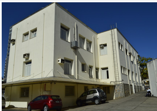
Pará de Minas Fórum Desembargador Pedro Nestor Fachada lateral esquerda da edificação. (foto 02) Imagem: Júllia Gomes – 01/09/2021
