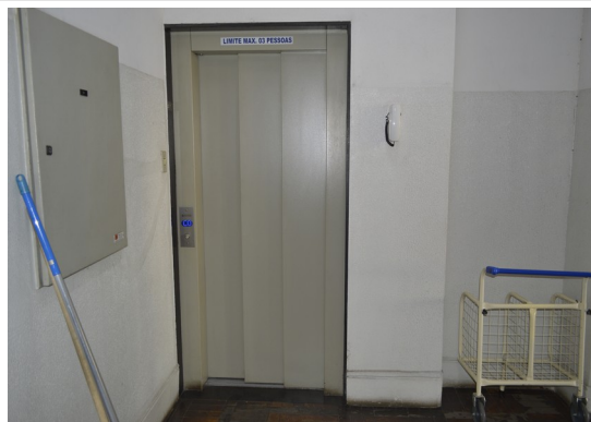
Pará de Minas Fórum Desembargador Pedro Nestor Porta de recolher em metal do elevador. (foto 22) Imagem: Júllia Gomes – 01/09/2021
