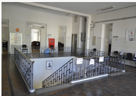
Pará de Minas Fórum Desembargador Pedro Nestor Quinas não apresenta nenhum sinal de fissuras ou trincas. (foto 05) Imagem: Júllia Gomes – 01/09/2021
