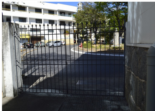
Pará de Minas Fórum Desembargador Pedro Nestor Portão em ferro na lateral direita da edificação. (foto 16) Imagem: Júllia Gomes – 01/09/2021
