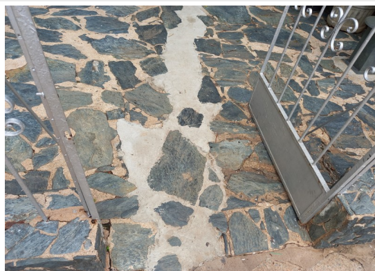
Pará de Minas Gruta de Nossa Senhora de Lourdes Piso interno em pedra bruta e bancos em ardósia no bem tombado. (foto 42) Imagem: Júllia Gomes – 10/11/2021
