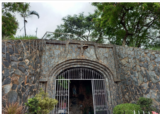
Pará de Minas Gruta de Nossa Senhora de Lourdes Portada ornamentada no único acesso à Gruta Nossa Senhora de Lourdes e guarda-corpo do terraço. (foto 41) Imagem: Júllia Gomes – 10/11/2021
