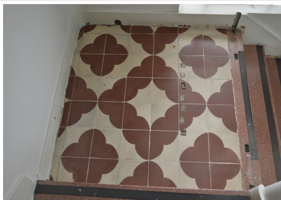
Pará de Minas Irmandade Nossa Senhora da Conceição – Hospital Ladrilho hidráulico em alguns corredores do bem. (foto 33) Imagem: Júllia Gomes – 14/10/2021
