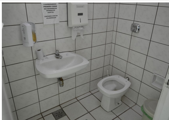
Pará de Minas Irmandade Nossa Senhora da Conceição – Hospital Revestimento cerâmico nos banheiros. (foto 11) Imagem: Júllia Gomes – 14/10/2021
