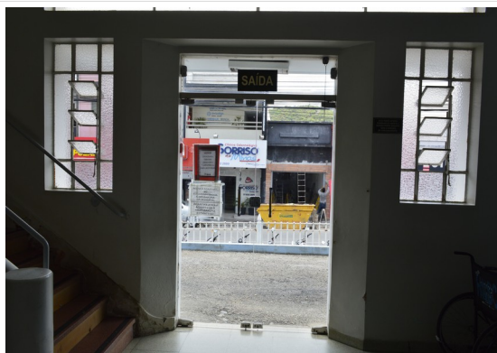
Pará de Minas Irmandade Nossa Senhora da Conceição – Hospital Porta de vidro com enquadramento em massa de acesso à maternidade. (foto 19) Imagem: Júllia Gomes – 14/10/2021
