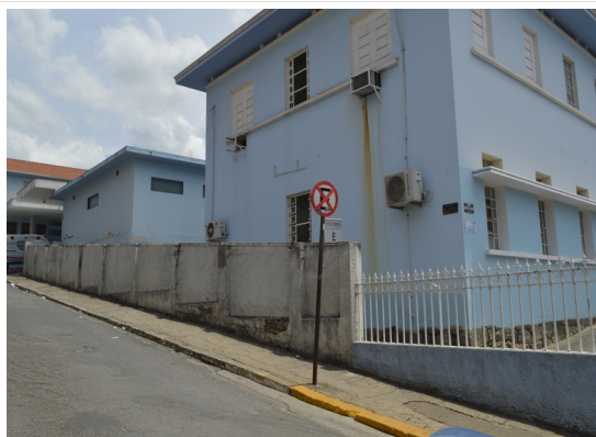
Pará de Minas Irmandade Nossa Senhora da Conceição – Hospital Muro na lateral esquerda da edificação. (foto 47) Imagem: Júllia Gomes – 14/10/2021
