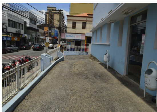
Pará de Minas Irmandade Nossa Senhora da Conceição – Hospital Manta asfáltica na rampa de acesso à entrada principal da maternidade. (foto 29) Imagem: Júllia Gomes – 14/10/2021
