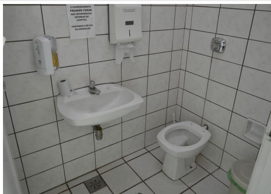
Pará de Minas Irmandade Nossa Senhora da Conceição – Hospital Instalações hidráulicas. (foto 49) Imagem: Júllia Gomes – 14/10/2021
