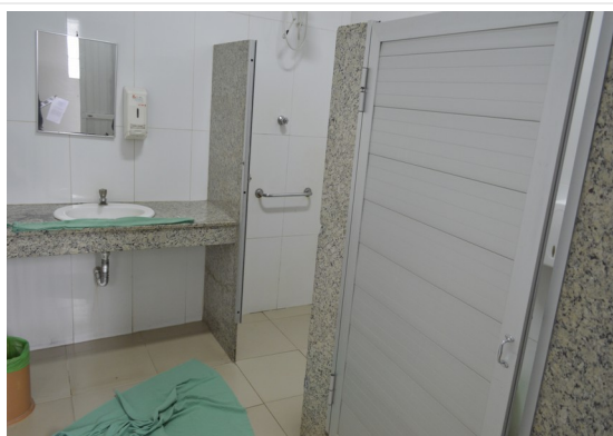
Pará de Minas Irmandade Nossa Senhora da Conceição – Hospital Revestimento cerâmico nos banheiros. (foto 13) Imagem: Júllia Gomes – 14/10/2021
