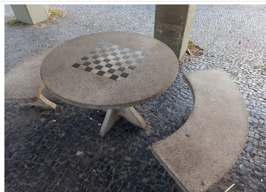
Pará de Minas Praças Torquato de Almeida e Francisco Torquato Bancos e mesas de jogos em concreto pré-moldado. (foto 52) Imagem: Júllia Gomes – 16/07/2021
