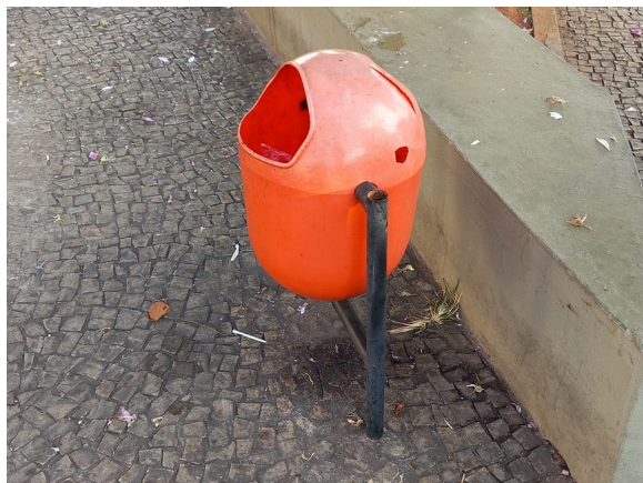
Pará de Minas Praças Torquato de Almeida e Francisco Torquato Lixeira apresentando trincas e com porções fragmentadas. (foto 20) Imagem: Júllia Gomes– 15/07/2021
