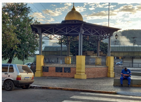
Pará de Minas Praças Torquato de Almeida e Francisco Torquato Vista lateral esquerda. (foto 39)
