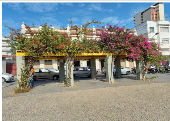
Pará de Minas Praças Torquato de Almeida e Francisco Torquato Caramanchão retangular em concreto pré-moldado em bom estado com vegetação (foto 24) Imagem: Júllia Gomes – 15/07/2021
