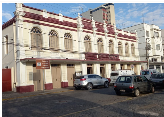
Pará de Minas Praças Torquato de Almeida e Francisco Torquato Prédio Juscelino Kubitschek de Oliveira – Casa da Cultura, bem tombado, no entorno imediato das praças. (foto 61)
