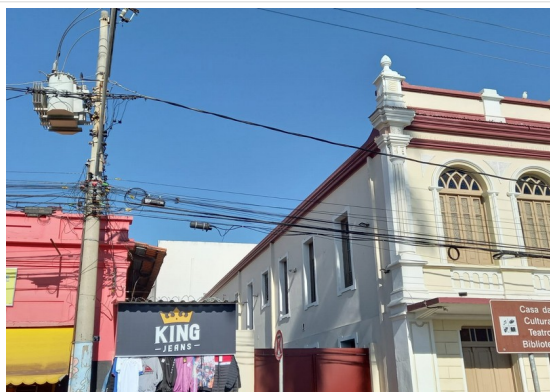
Pará de Minas Praças Torquato de Almeida e Francisco Torquato Fiação aparente no entorno do bem. (foto 34) Imagem: Júllia Gomes – 16/07/2021
