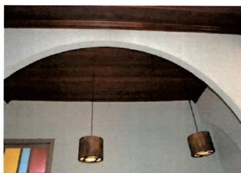
Pará de Minas Prédio Juscelino Kubitschek de Oliveira – Casa da Cultura Detalhe dos arcos que compõem a estrutura interna. (foto 05) Imagem: Laís Costa – 22/07/2022
