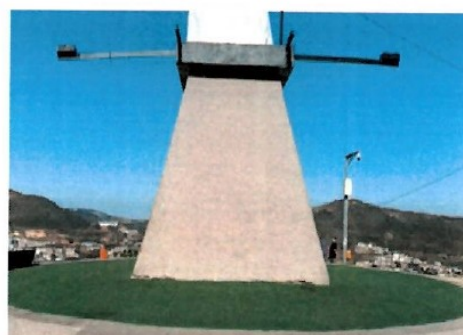
Pará de Minas Cristo Redentor Vista posterior do pedestal e da base, grama sintética foi instalada para compor o piso. (foto 12) Imagem: Laís Costa – 08/07/2022
