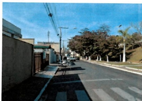
Pará de Minas Gruta de Nossa Senhora de Lourdes Fiação aparente em todo o entorno da Praça Francisco Valadares. (foto 29) Imagem: Laís Costa – 15/07/2022
