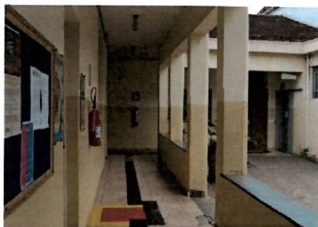
Pará de Minas Asilo Padre José Pereira Coelho Reboco e pintura a óleo e à base de água dos corredores em bom estado de conservação. (foto 11) Imagem: Lais Costa– 02/11/2022
