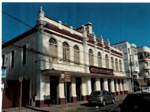
Pará de Minas Prédio Juscelino Kubitschek de Oliveira – Casa da Cultura Fachada Frontal. {foto 01} Imagem: Laís Costa – 22/07/2022
