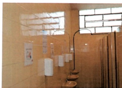
Pará de Minas Escola Estadual Torquato de Almeida Cerâmicas comuns aos banheiros. (foto 16) Imagem: Laís Costa – 18/08/2022
