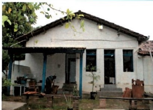
Pará de Minas Escola Municipal de Artes e Ofícios Raimundo Nogueira de Faria - SICA Varanda na fachada frontal em estrutura de madeira e cobertura em telhas cerâmicas.. (foto 42) Imagem: Laís Costa – 19/08/2022
