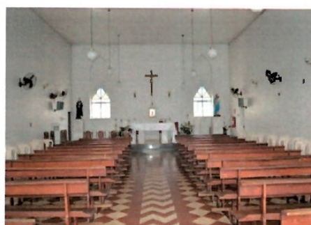
Pará de Minas Asilo Padre José Pereira Coelho Reboco e pinturas à base de água do interior da Capela em bom estado de conservação. (foto 12) Imagem: Lais Costa– 02/11/2022
