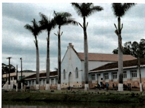
Pará de Minas Asilo Padre José Pereira Coelho Fachada Frontal (foto 01) Imagem: Laís Costa– 02/11/2022
