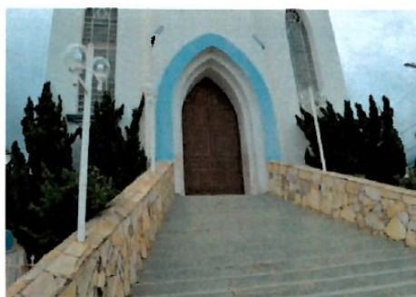
Pará de Minas Igreja Nossa Senhora das Graças Porta principal em madeira. (foto 16) Imagem: Laís Costa – 10/12/2022
