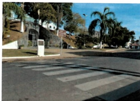
Pará de Minas Gruta de Nossa Senhora de Lourdes Faixa de pedestre em frente a gruta não apresenta rampa de acessibilidade. (foto 30) Imagem: Laís Costa– 15/07/2022
