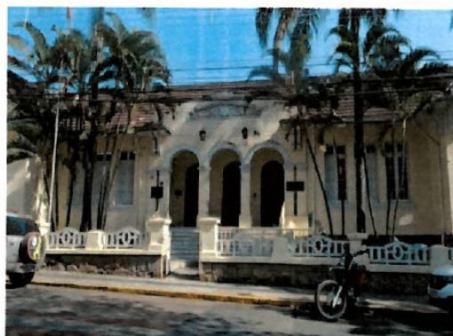
Pará de Minas Escola Estadual Governador Valadares Fachada Frontal (foto 01) Imagem: Laís Costa– 26/08/2022
