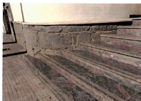
Pará de Minas Fórum Desembargador Pedro Nestor Pedras fazendo o barrado nas fachadas do bem. (foto 14) Imagem: Gabriela Conceição – 02/01/2023
