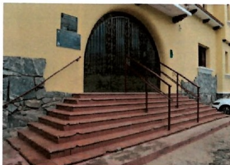
Pará de Minas Escola Estadual Fernando Otávio Porta de acesso principal à edificação em metal e vidro e novo guarda-corpo com corrimão. (foto 21) Imagem: Laís Costa – 09/11/2022
