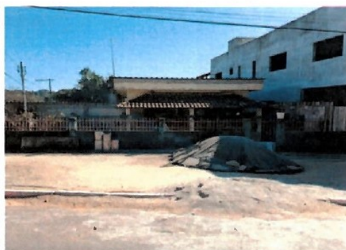
Pará de Minas Núcleo Histórico Urbano do Distrito de Ascensão Calçada em terra batida permanece ocupada por material de obra, na Rua Abdon Senem de Araújo. (foto 21) Imagem: Laís Costa – 26/07/2022
