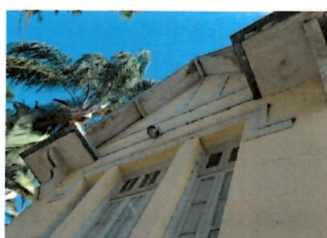
Pará de Minas Escola Estadual Governador Valadares Beiral em bom estado de conservação, exibindo apenas marcas de umidade. (foto 11) Imagem: Laís Costa– 26/08/2022
