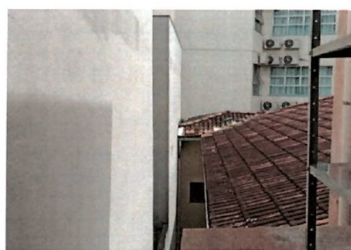
Pará de Minas Centro Literário Pedro Nestor Telhado do bem em bom estado de conservação. (foto 08) Imagem: Gabriela Conceição – 05/10/2022
