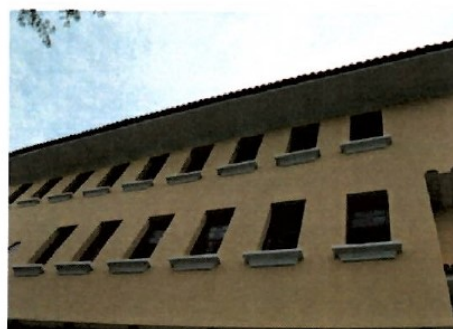
Pará de Minas Escola Estadual Fernando Otávio Janelas em madeira e vidro que compõem as fachadas. (foto 22) Imagem: Laís Costa – 09/11/2022
