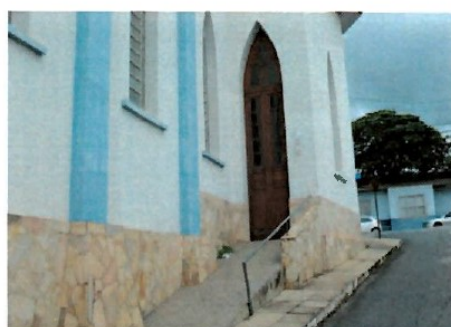
Pará de Minas Igreja Nossa Senhora das Graças Porta de entrada lateral em madeira e vidro. (foto 17) Imagem: Laís Costa – 10/12/2022
