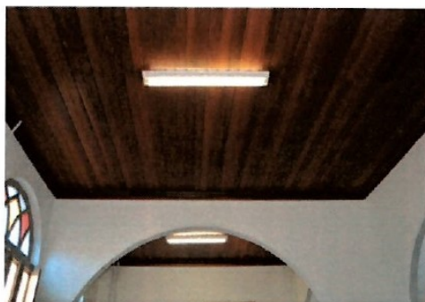
Pará de Minas Prédio Juscelino Kubitschek de Oliveira – Casa da Cultura Detalhe das vigas no 2º pavimento. (foto 04) Imagem: Laís Costa – 22/07/2022
