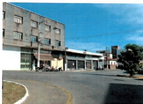
Pará de Minas Gruta de Nossa Senhora de Lourdes Placas comerciais de grandes dimensões no entorno imediato da Praça Francisco Valadares. (foto 28) Imagem: Laís costa – 15/07/2022
