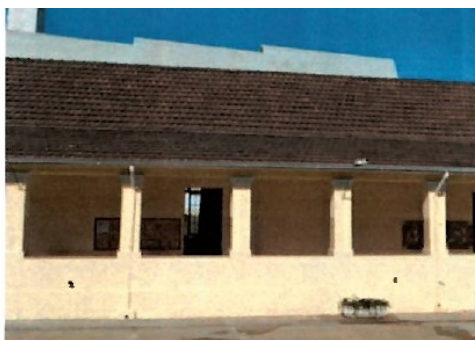
Pará de Minas Escola Estadual Governador Valadares Telhas francesas em bom estado de conservação exibindo apenas manchas de umidade. (foto 08) Imagem: Laís Costa– 26/08/2022
