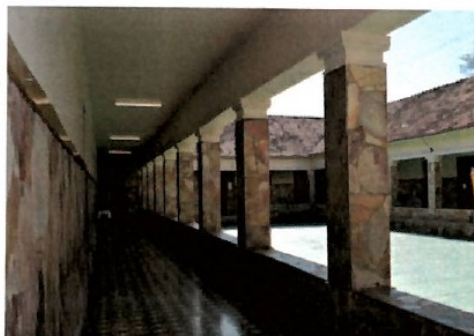
Pará de Minas Escola Estadual Torquato de Almeida Pintura a base de água nas alvenarias e na laje. (foto 13) Imagem: Laís Costa – 18/08/2022
