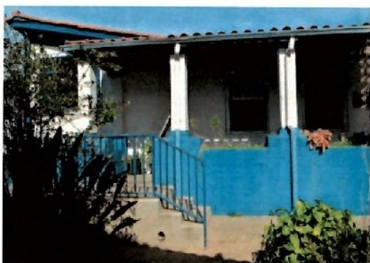
Pará de Minas Casa Maria Capanema Fachada lateral esquerda da edificação. (foto 04) Imagem: Laís Costa – 15/07/2022
