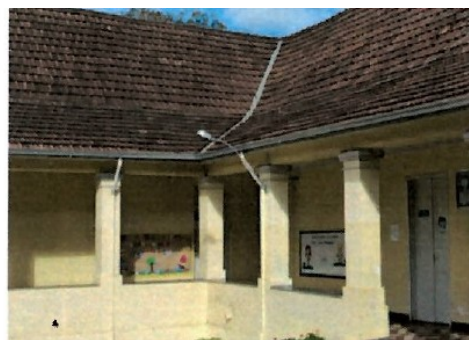
Pará de Minas Escola Estadual Governador Valadares Condutores de águas pluviais e guarda-pó. (foto 09) Imagem: Laís Costa– 26/08/2022
