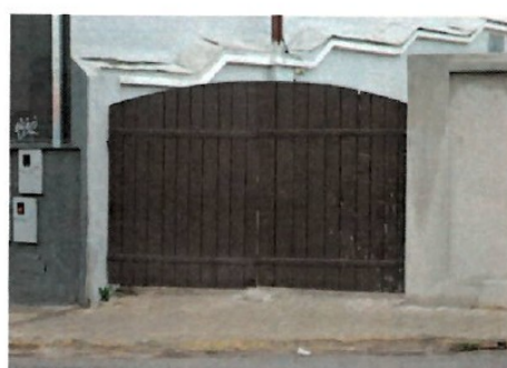
Pará de Minas MUSPAM Portão em madeira e duas folhas do acesso de veículos em bom estado. (foto 46) Imagem: Laís Costa – 11/10/2022
