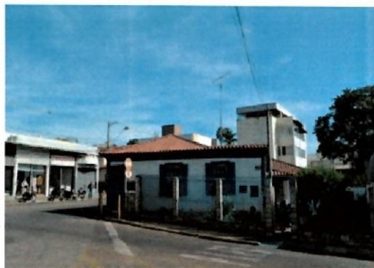
Pará de Minas Casa Maria Capanema Fachada Frontal da edificação. (foto 02) Imagem: Laís Costa – 15/07/2022
