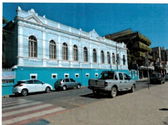
Pará de Minas Escola Estadual Torquato de Almeida Fachada Frontal. (foto 01) Imagem: Laís Costa – 18/08/2022
