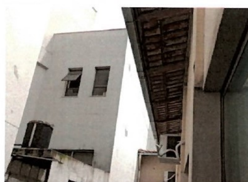
Pará de Minas Centro Literário Pedro Nestor Beiral e calha em bom estado de conservação. (foto 06) Imagem: Gabriela Conceição – 05/10/2022
