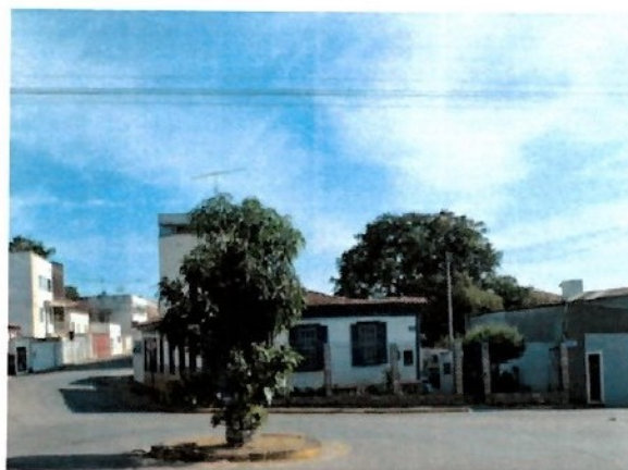
Pará de Minas Casa Maria Capanema Fachada Frontal e lateral Direita da edificação. (foto 01) Imagem: Laís Costa – 15/07/2022
