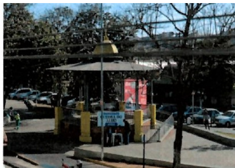
Pará de Minas Prédio Juscelino Kubitschek de Oliveira – Casa da Cultura A edificação está em frente as Praças Torquato de Almeida e Francisco Torquato, bem tombado. (foto 56) Imagem: Lais Costa – 22/07/2022
