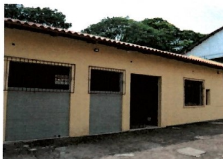
Pará de Minas Escola Estadual Fernando Otávio Refeitório finalizando reforma conforme ata em anexo. (foto 24) Imagem: Laís Costa – 09/11/2022
