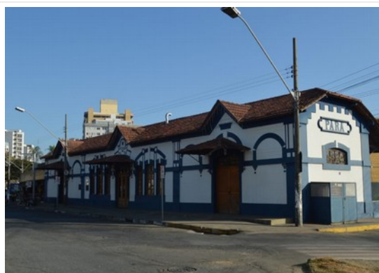
Pará de Minas Praças Torquato de Almeida e Francisco Torquato Estação Ferroviária, bem tombado, no entorno imediato das Praças exibe bom estado de conservação. (foto 66) Imagem: Laís Costa – 29/07/2022
