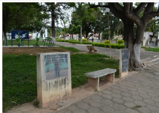
Pará de Minas Gruta de Nossa Senhora de Lourdes Placas na área da Praça Nossa Senhora de Lourdes, necessitando apenas de renovação da camada pictórica. (foto 77) Imagem: Laís Costa – 23/11/2022
