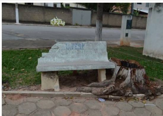
Pará de Minas Núcleo Histórico Urbano do Distrito de Carioca Banco em concreto com perda de material e árvores que foi suprimida. (foto 71) Imagem: Laís Costa – 23/11/2022
