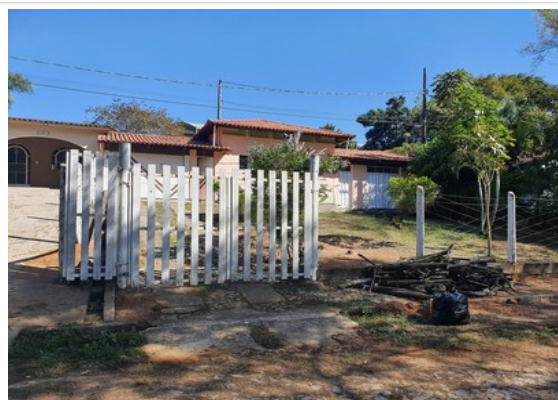
Pará de Minas Núcleo Histórico Urbano do Distrito de Ascensão Edificação à Rua Raimundo Penaforte de Araújo, 231. (foto 97)
