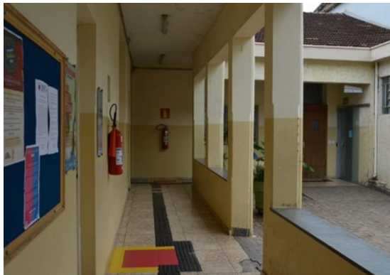
Pará de Minas Asilo Padre José Pereira Coelho Reboco e pintura a óleo e à base de água dos corredores em bom estado de conservação. (foto 11) Imagem: Laís Costa– 02/11/2022
