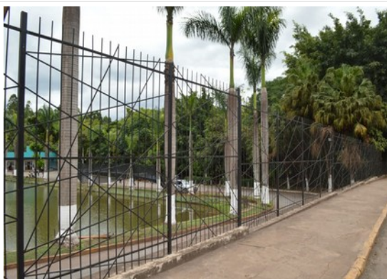
Pará de Minas Asilo Padre José Pereira Coelho Gradil frontal, muro lateral direito e passeio em bom estado de conservação. (foto 53) Imagem: Laís Costa– 02/11/2022
