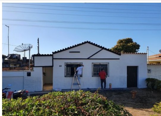
Pará de Minas Núcleo Histórico Urbano do Distrito de Ascensão Edificação sendo restaurada à Rua Raimundo Penaforte de Araújo, 074. (foto 85)
