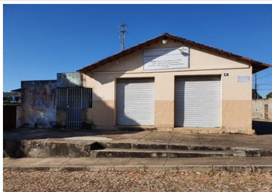
Pará de Minas Núcleo Histórico Urbano do Distrito de Ascensão Edificação à Rua Pompéu, 049. (foto 80) Imagem: Laís Costa – 26/07/2022
