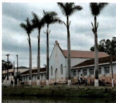
Pará de Minas Asilo Padre José Pereira Coelho Fachada Frontal (foto 01) Imagem: Laís Costa – 02/11/2022
