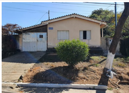
Pará de Minas Núcleo Histórico Urbano do Distrito de Ascensão Edificação à Avenida Abdon Senen de Araújo, 049. (foto 37) Imagem: Laís Costa – 26/07/2022
