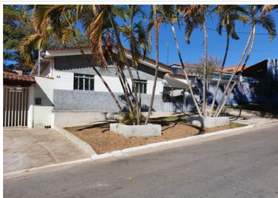
Pará de Minas Núcleo Histórico Urbano do Distrito de Ascensão Edificação à Avenida Abdon Senen de Araújo, 038. (foto 46) Imagem: Laís Costa – 26/07/2022
