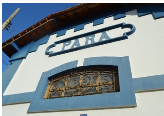
Pará de Minas Estação Ferroviária Janela da fachada lateral direita em ferro e vidro, enquadramento em massa sobreverga e elementos artísticos em bom estado. (foto 31) Imagem: Laís Costa – 21/07/2022
