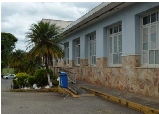
Pará de Minas Asilo Padre José Pereira Coelho Rampa de acesso à entrada secundária da faculdade. (foto 52) Imagem: Laís Costa– 02/11/2022
