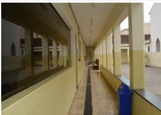
Pará de Minas Asilo Padre José Pereira Coelho Janelas dos corredores em metal e vidro. (foto 28) Imagem: Laís Costa–02/11/2022
