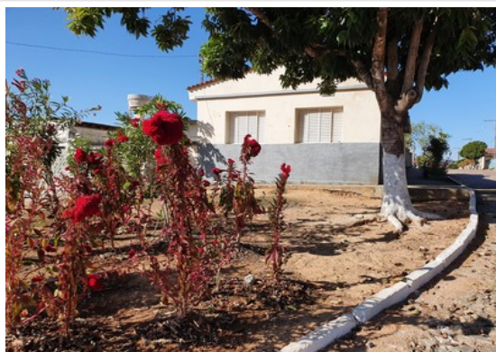
Pará de Minas Núcleo Histórico Urbano do Distrito de Ascensão Edificação à Praça Santo Antônio, SN (lateral nº039). (foto 76) Imagem: Laís Costa – 26/07/2022
