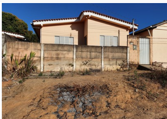
Pará de Minas Núcleo Histórico Urbano do Distrito de Ascensão Edificação à Avenida Presidente Kubitschek, s/n (lateral 160). (foto 58) Imagem: Laís Costa – 26/07/2022
