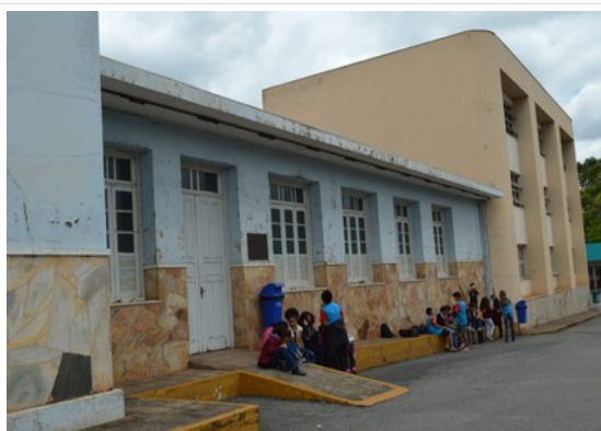
Pará de Minas Asilo Padre José Pereira Coelho Portas e janelas em madeira na fachada frontal. (foto 22) Imagem: Laís Costa–02/11/2022
