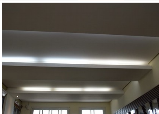
Pará de Minas Asilo Padre José Pereira Coelho Forro de gesso na recepção. (foto 43) Imagem: Laís Costa– 02/11/2022
