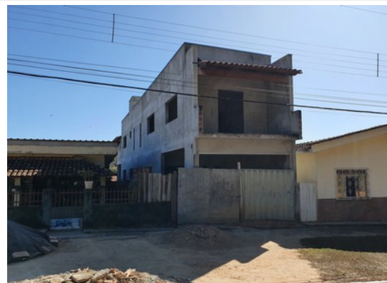
Pará de Minas Núcleo Histórico Urbano do Distrito de Ascensão Materiais de construção permanece sobre o passeio na Avenida Abdon Senem de Araújo. (foto 31) Imagem: Laís Costa – 26/07/2022
