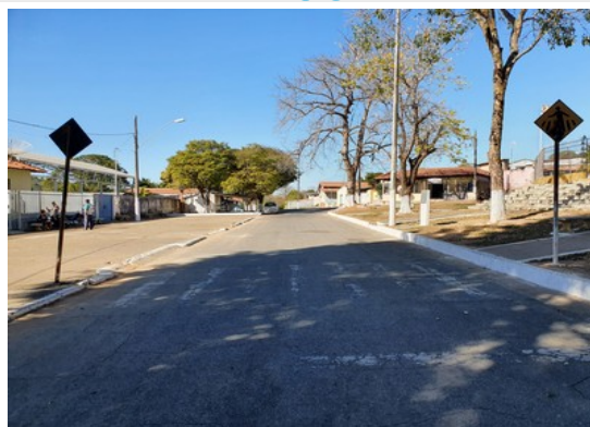
Pará de Minas Núcleo Histórico Urbano do Distrito de Ascensão Trecho da via Praça Santo Antônio, frente à Igreja de Santo de Antônio. (foto 05) Imagem: Laís Costa – 26/07/2022
