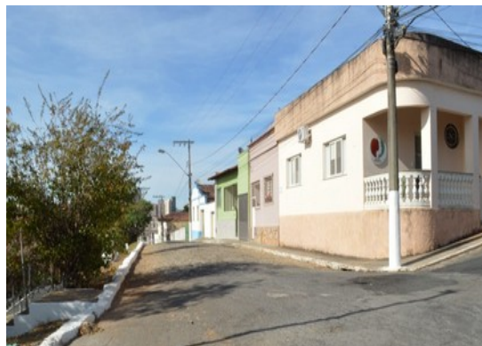
Pará de Minas Gruta de Nossa Senhora de Lourdes A via Praça Francisco Valadares também não apresenta arborização fora do perímetro da Praça. (foto 13) Imagem: Laís Costa – 15/07/2022
