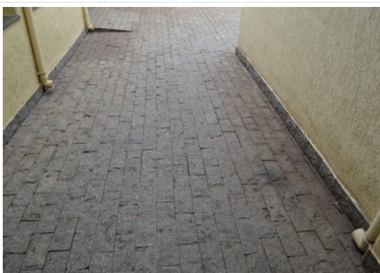
Pará de Minas Asilo Padre José Pereira Coelho Piso de pedra no pátio interno do bem em bom estado de conservação. (foto 30) Imagem: Laís Costa– 02/11/2022
