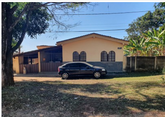
Pará de Minas Núcleo Histórico Urbano do Distrito de Ascensão Edificação à Rua Raimundo Penaforte de Araújo, 304. (foto 100)
