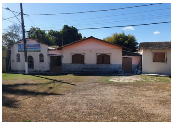
Pará de Minas Núcleo Histórico Urbano do Distrito de Ascensão Edificação à Rua Raimundo Penaforte de Araújo, 142. (foto 90)
