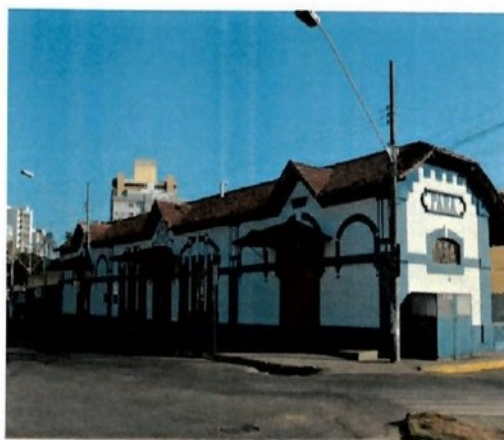
Pará de Minas Estação Ferroviária Fachada Frontal. (foto 01) Imagem: Laís Costa – 21/07/2022
