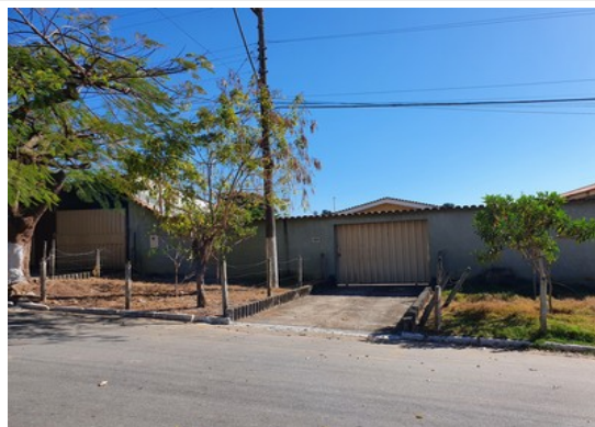
Pará de Minas Núcleo Histórico Urbano do Distrito de Ascensão Edificação à Avenida Abdon Senen de Araújo, 116. (foto 41) Imagem: Laís Costa – 26/07/2022
