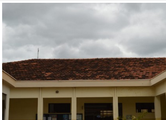
Pará de Minas Asilo Padre José Pereira Coelho Condutores de águas pluviais estão bem conservados. (foto 07) Imagem: Laís Costa – 02/11/2022
