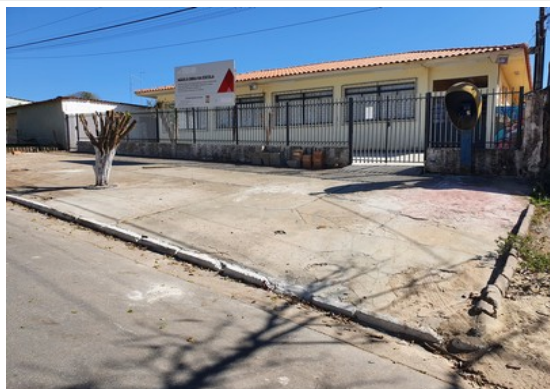
Pará de Minas Núcleo Histórico Urbano do Distrito de Ascensão Edificação à Avenida Abdon Senen de Araújo, 100. (foto 40) Imagem: Laís Costa – 26/07/2022
