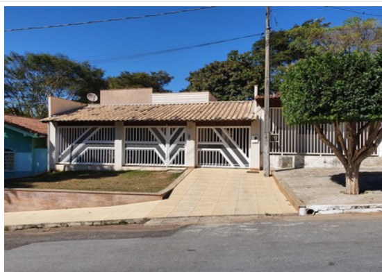
Pará de Minas Núcleo Histórico Urbano do Distrito de Ascensão Edificação à Avenida Abdon Senen de Araújo, 048. (foto 36) Imagem: Laís Costa – 26/07/2022
