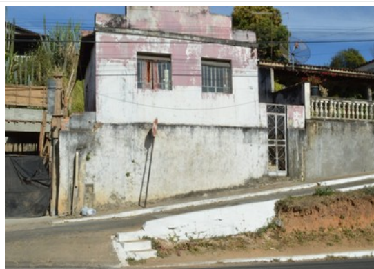
Pará de Minas Gruta de Nossa Senhora de Lourdes Extremo sul da Praça Francisco Valadares onde a cobertura necessita de intervenção. (foto 35) Imagem: Laís Costa – 15/07/2022
