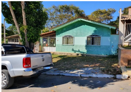
Pará de Minas Núcleo Histórico Urbano do Distrito de Ascensão Edificação à Avenida Abdon Senen de Araújo, 066. (foto 38) Imagem: Laís Costa – 26/07/2022
