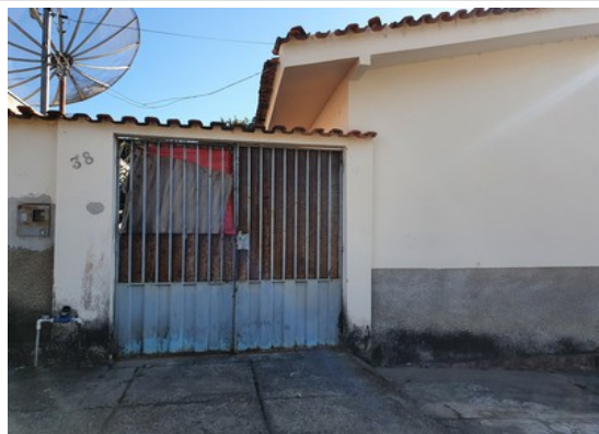
Pará de Minas Núcleo Histórico Urbano do Distrito de Ascensão Edificação à Rua Pompéu, 038. (foto 79) Imagem: Laís Costa – 26/07/2022
