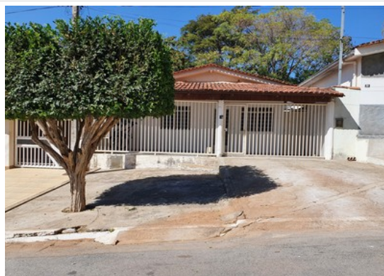
Pará de Minas Núcleo Histórico Urbano do Distrito de Ascensão Edificação à Avenida Abdon Senen de Araújo, 040. (foto 35) Imagem: Laís Costa – 26/07/2022
