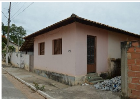
Pará de Minas Núcleo Histórico Urbano do Distrito de Carioca Edificação à Rua Dona Maria Lopes Cançado, 68 (foto 43)
