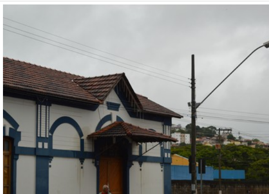
Pará de Minas Estação Ferroviária Frontão a direita na fachada frontal em bom estado. (foto 11) Imagem: Laís Costa – 21/07/2022
