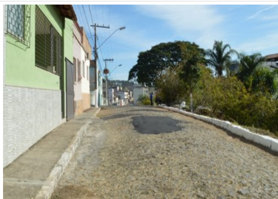
Pará de Minas Gruta de Nossa Senhora de Lourdes Edificações sem afastamento frontal e lateral na Via Praça Francisco Valadares exibindo camada pictórica em bom estado. (foto 52) Imagem: Laís Costa – 15/07/2022
