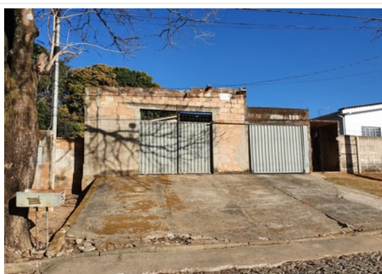
Pará de Minas Núcleo Histórico Urbano do Distrito de Ascensão Edif. à Avenida Presidente Kubitschek, 190. (foto 66) Imagem: Laís Costa – 26/07/2022
