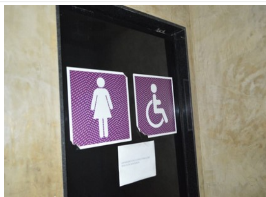
Pará de Minas Estação Ferroviária Porta do banheiro PNE no térreo feita em madeira laqueada exibindo bom estado. (foto 34) Imagem: Laís Costa – 21/07/2022
