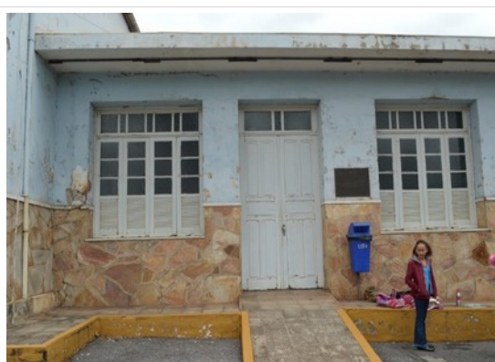
Pará de Minas Asilo Padre José Pereira Coelho Rampa de acesso à recepção da faculdade, (foto 51) Imagem: Laís Costa– 02/11/2022
