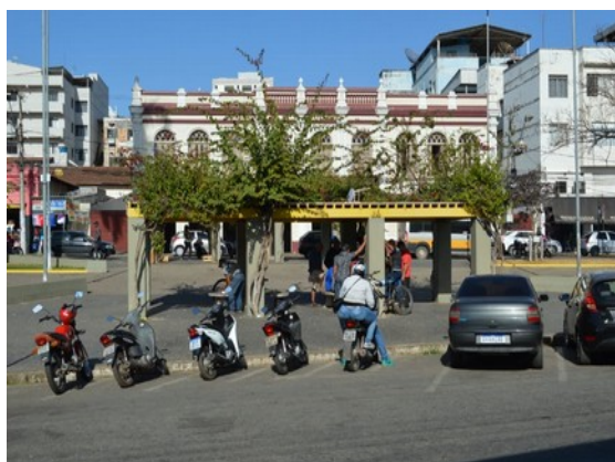
Pará de Minas Praças Torquato de Almeida e Francisco Torquato Único caramanchão que contém bancos e mesas em concreto pré-moldados (foto 26) Imagem: Laís Costa– 29/07/2022
