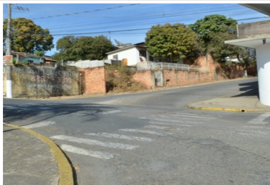
Pará de Minas Gruta de Nossa Senhora de Lourdes Trecho sem passeio da Praça Francisco Valadares não oferece acessibilidade. (foto 19) Imagem: Laís Costa – 15/07/2022
