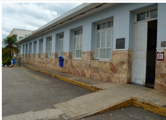
Pará de Minas Asilo Padre José Pereira Coelho Piso em concreto no passeio da fachada frontal bem conservado. (foto 42) Imagem: Laís Costa– 02/11/2022
