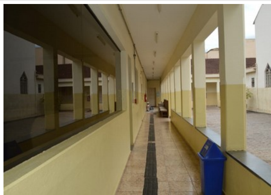
Pará de Minas Asilo Padre José Pereira Coelho Lajes dos corredores que conformam o pátio interno. (foto 46) Imagem: Laís Costa– 02/11/2022
