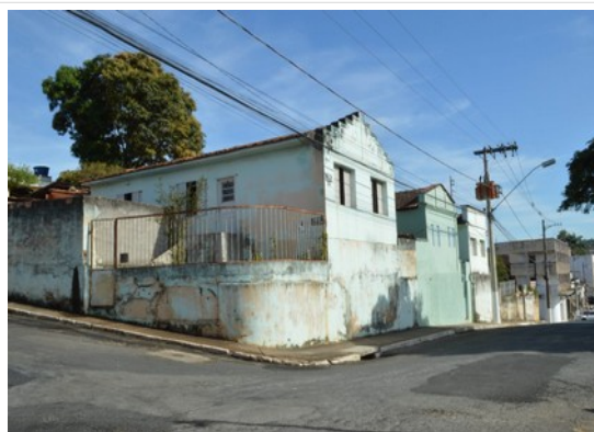
Pará de Minas Gruta de Nossa Senhora de Lourdes Edificação na Via Praça Francisco Valadares necessitando de renovação na camada pictórica. (foto 53) Imagem: Laís Costa – 15/07/2022
