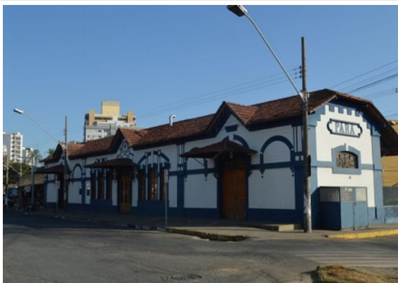
Pará de Minas Estação Ferroviária Reboco e pintura externos no geral exibem bom estado. (foto 15) Imagem: Laís Costa – 21/07/2022
