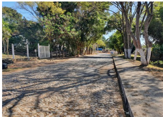
Pará de Minas Núcleo Histórico Urbano do Distrito de Ascensão Calçada da Rua Raimundo Penaforte de Araújo. (foto 25) Imagem: Laís Costa – 26/07/2022
