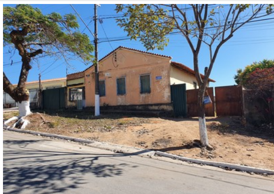
Pará de Minas Núcleo Histórico Urbano do Distrito de Ascensão Edificação à Avenida Abdon Senen de Araújo, 039. (foto 34) Imagem: Laís Costa – 26/07/2022
