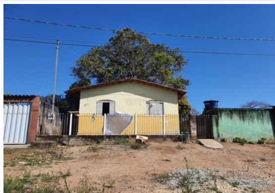
Pará de Minas Núcleo Histórico Urbano do Distrito de Ascensão Edificação à Rua Raimundo Penaforte de Araújo, 173. (foto 94)
