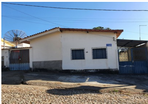
Pará de Minas Núcleo Histórico Urbano do Distrito de Ascensão Edificação à Rua Pompéu, 028. (foto 78) Imagem: Laís Costa – 26/07/2022
