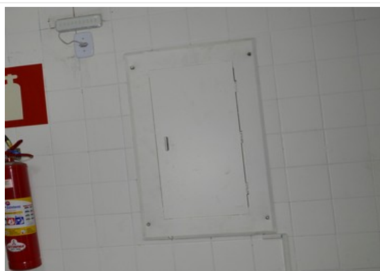
Pará de Minas Estação Ferroviária Revestimento cerâmico na copa exibe remendos feitos em cimento, todas as paredes em tinta epóxi para uniformizar. (foto 21) Imagem: Laís Costa – 21/07/2022
