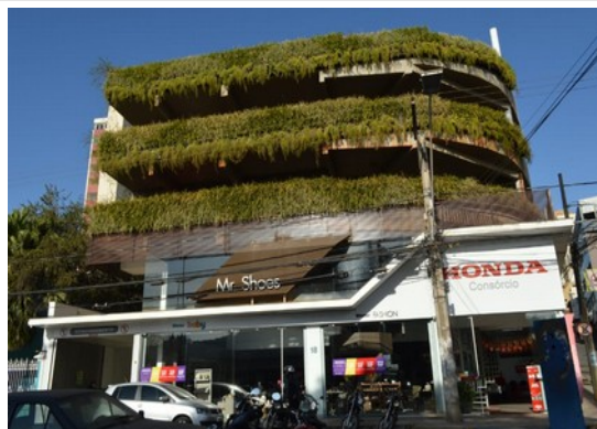
Pará de Minas Praças Torquato de Almeida e Francisco Torquato Edifício estacionamento com comércio no térreo. (foto 64) Imagem: Laís Costa – 29/07/2022
