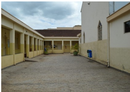
Pará de Minas Asilo Padre José Pereira Coelho Fachada posterior exibindo reboco e pintura em bom estado. (foto 13) Imagem: Laís Costa– 02/11/2022
