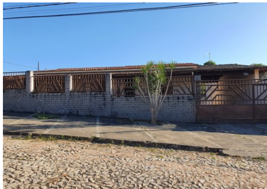
Pará de Minas Núcleo Histórico Urbano do Distrito de Ascensão Edif. à Avenida Presidente Kubitschek, 26. (foto 68) Imagem: Laís Costa – 26/07/2022
