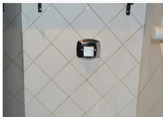
Pará de Minas Estação Ferroviária Cerâmicas dos banheiros do mezanino em bom estado de conservação. (foto 22) Imagem: Laís Costa – 21/07/2022
