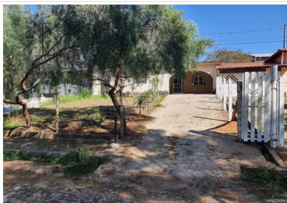
Pará de Minas Núcleo Histórico Urbano do Distrito de Ascensão Edificação à Rua Raimundo Penaforte de Araújo, 205. (foto 96)
