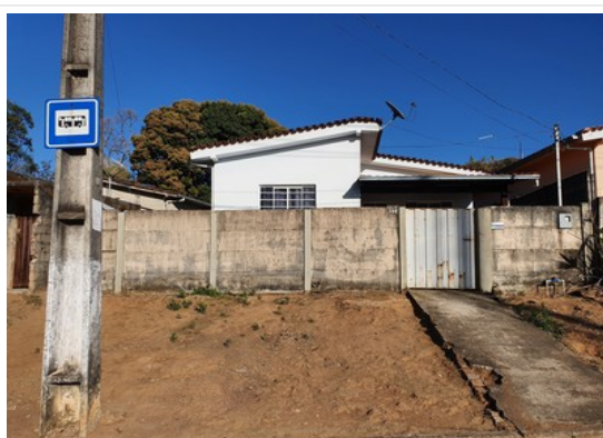
Pará de Minas Núcleo Histórico Urbano do Distrito de Ascensão Edif. à Avenida Presidente Kubitschek, 180. (foto 67) Imagem: Laís Costa – 26/07/2022
