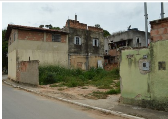
Pará de Minas Núcleo Histórico Urbano do Distrito de Carioca Edificação demolida à Rua Dona Maria Lopes Cançado, 100' (foto 45)
