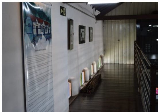
Pará de Minas Estação Ferroviária Reboco e pintura internos exibem ótimo estado. (foto 17) Imagem: Laís Costa – 21/07/2022
