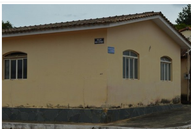
Pará de Minas Núcleo Histórico Urbano do Distrito de Carioca Placas de logradouro em bom estado na Rua Nossa Senhora Aparecida. (foto 09) Imagem: Laís Costa – 23/11/2022
