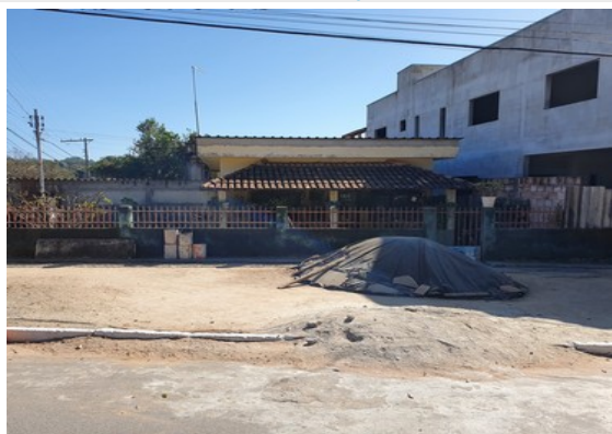
Pará de Minas Núcleo Histórico Urbano do Distrito de Ascensão Edificação à Avenida Abdon Senen de Araújo, 160. (foto 44) Imagem: Laís Costa – 26/07/2022
