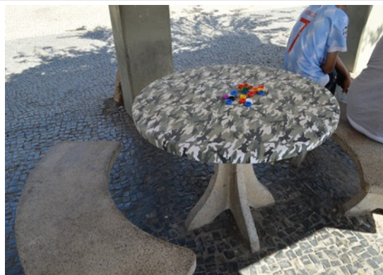
Pará de Minas Praças Torquato de Almeida e Francisco Torquato Bancos e mesas de jogos em concreto pré-moldado. (foto 52) Imagem: Laís Costa – 29/07/2022
