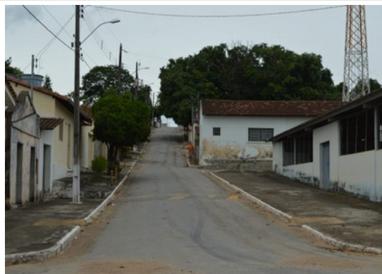
Pará de Minas Núcleo Histórico Urbano do Distrito de Carioca Vista da Rua N. Sra. Aparecida exibindo remendos no asfalto e sujidades. (foto 05) Imagem: Laís Costa – 23/11/2022
