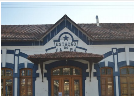
Pará de Minas Estação Ferroviária Frontão central em bom estado de conservação. (foto 09) Imagem: Laís Costa – 21/07/2022
