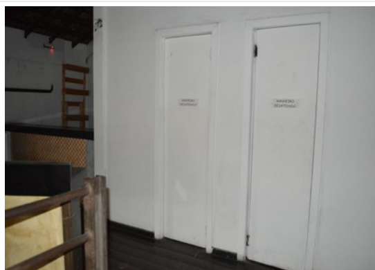
Pará de Minas Estação Ferroviária Portas dos banheiros do mezanino feitas em madeira e com enquadramento também em madeira em bom estado apenas com algumas sujidades na pintura na borda inferior. (foto 36) Imagem: Laís Costa – 21/07/2022
