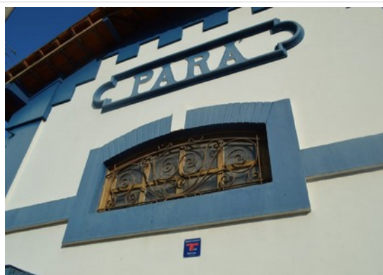
Pará de Minas Estação Ferroviária Janela da fachada lateral esquerda em ferro e vidro, enquadramento em massa sobreverga e elementos artísticos. (foto 32) Imagem: Laís Costa – 21/07/2022
