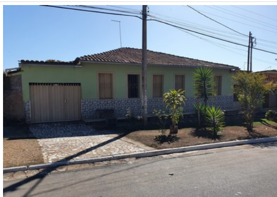
Pará de Minas Núcleo Histórico Urbano do Distrito de Ascensão Edificação à Avenida Abdon Senen de Araújo, 130. (foto 42) Imagem: Laís Costa – 26/07/2022
