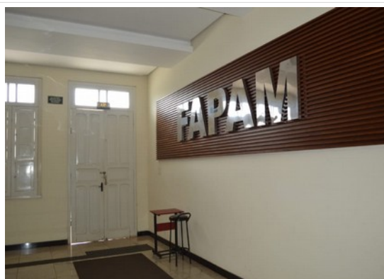
Pará de Minas Asilo Padre José Pereira Coelho Vista interna da porta existentes na fachada frontal. (foto 23) Imagem: Laís Costa– 02/11/2022
