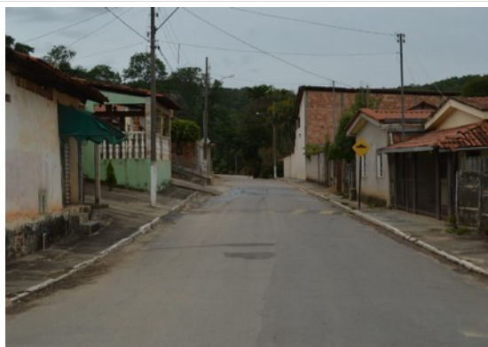
Pará de Minas Núcleo Histórico Urbano do Distrito de Carioca Vista da via Nossa Senhora da Piedade com pavimentação asfáltica em bom estado. (foto 02) Imagem: Laís Costa – 23/11/2022
