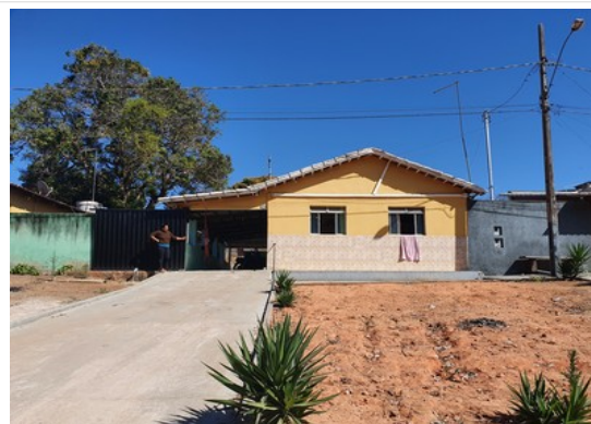
Pará de Minas Núcleo Histórico Urbano do Distrito de Ascensão Edificação à Rua Raimundo Penaforte de Araújo, 203. (foto 95)
