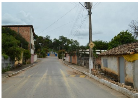
Pará de Minas Núcleo Histórico Urbano do Distrito de Carioca Vista da via Dona Maria Lopes Caçado com pavimentação asfáltica em bom estado. (foto 04) Imagem: Laís Costa– 23/11/2022
