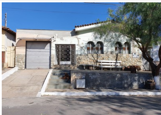
Pará de Minas Núcleo Histórico Urbano do Distrito de Ascensão Calçada em diferentes níveis, observada em frente a Edificação à Praça Santo Antônio, 121. (foto 74) Imagem: Laís Costa – 26/07/2022
