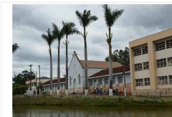
Pará de Minas Asilo Padre José Pereira Coelho Lagoa e jardins em frente à fachada frontal exibem boa manutenção de seus elementos. (foto 50) Imagem: Laís Costa– 02/11/2022
