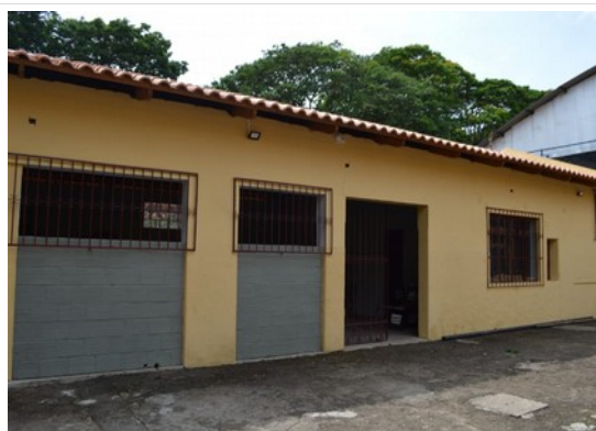
Pará de Minas Escola Estadual Fernando Otávio Refeitório finalizando reforma conforme ata em anexo. (foto 24) Imagem: Laís Costa – 09/11/2022
