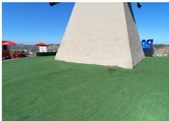
Pará de Minas Cristo Redentor O pedestal de tijolos apresenta bom estado de conservação, exibindo nova camada pictórica. (foto 06) Imagem: Laís Costa – 08/07/2022
