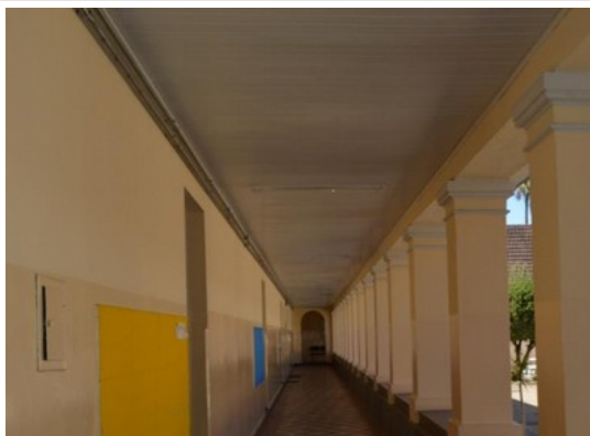
Pará de Minas Escola Estadual Governador Valadares Forro em pvc nos corredores que conformam o pátio interno. (foto 37) Imagem: Laís Costa–26/08/2022
