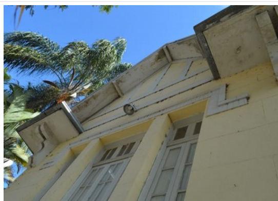
Pará de Minas Escola Estadual Governador Valadares Beiral em bom estado de conservação, exibindo apenas marcas de umidade. (foto 11) Imagem: Laís Costa– 26/08/2022
