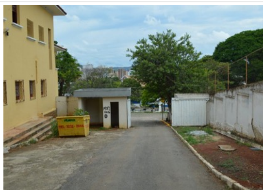
Pará de Minas Escola Estadual Fernando Otávio Portão em metal de acesso lateral. (foto 28) Imagem: Laís Costa – 09/11/2022
