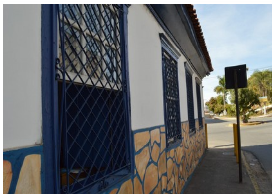
Pará de Minas Casa Maria Capanema Janela guilhotina em madeira e vidro e grade em metal em bom estado na fachada lateral esquerda. (foto 30) Imagem: Laís Costa – 15/07/2022
