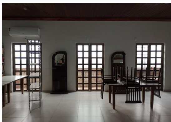
Pará de Minas Centro Literário Pedro Nestor Vão com reboco finalizado. (foto 19) Imagem: Gabriela Conceição – 05/10/2022
