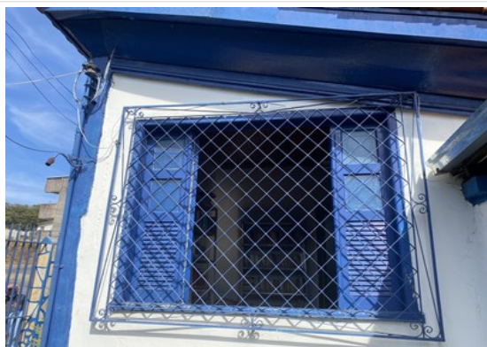
Pará de Minas Casa Maria Capanema Janela francesa em madeira e vidro na lateral esquerda apresenta pintura em bom estado de conservação. (foto 28) Imagem: Laís Costa – 15/07/2022
