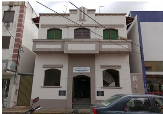
Pará de Minas Centro Literário Pedro Nestor Reboco da fachada frontal em bom estado. (foto 11) Imagem: Gabriela Conceição – 05/10/2022
