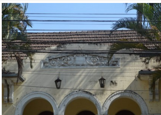
Pará de Minas Escola Estadual Governador Valadares Frontão com ornamentos em estuque. (foto 10) Imagem: Laís Costa– 26/08/2022
