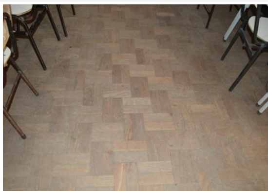
Pará de Minas Escola Estadual Fernando Otávio Piso em parquet de madeira comum às salas de aula. (foto 33) Imagem: Laís Costa – 09/11/2022
