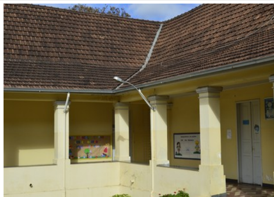
Pará de Minas Escola Estadual Governador Valadares Condutores de águas pluviais e guarda-pó. (foto 09) Imagem: Laís Costa– 26/08/2022
