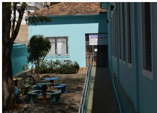
Pará de Minas Escola Estadual Torquato de Almeida Rampa na lateral direita que oferece acessibilidade ao bem. (foto 36) Imagem: Laís Costa – 18/08/2022
