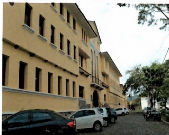
Pará de Minas Escola Estadual Fernando Otávio Fachada frontal (foto 01) Imagem: Laís Costa – 09/11/2022
