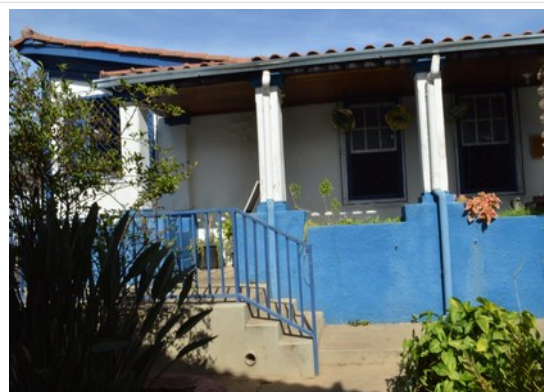
Pará de Minas Casa Maria Capanema Alvenarias do alpendre exibindo bom estado de conservação. (foto 12) Imagem: Laís Costa – 15/07/2022
