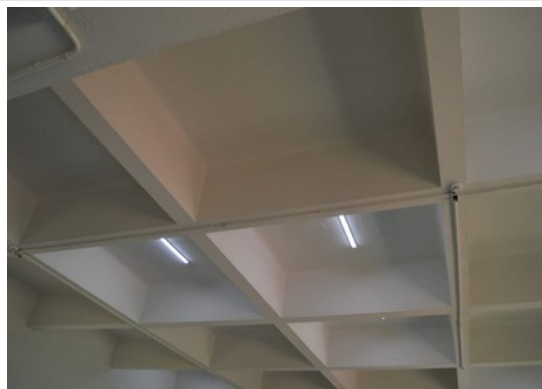
Pará de Minas Escola Estadual Fernando Otávio A estrutura em concreto armado (foto 06) Imagem: Laís Costa – 09/11/2022
