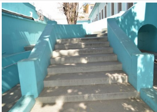
Pará de Minas Escola Estadual Torquato de Almeida Escadaria de acesso lateral. (foto 33) Imagem: Laís Costa – 18/08/2022
