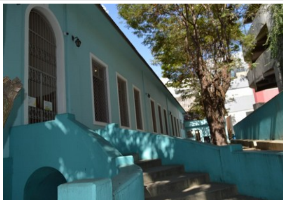
Pará de Minas Escola Estadual Torquato de Almeida Reboco e pintura da lateral direita do bem. (foto 15) Imagem: Laís Costa – 18/08/2022
