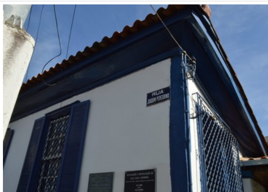
Pará de Minas Casa Maria Capanema Detalhe da compatibilização entre alvenaria e madeira. (foto 11) Imagem: Laís Costa – 15/07/2022
