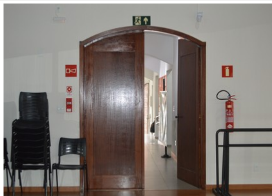
Pará de Minas Centro Literário Pedro Nestor Porta de madeira que compõe o primeiro andar. (foto 22) Imagem: Laís Costa – 05/10/2022
