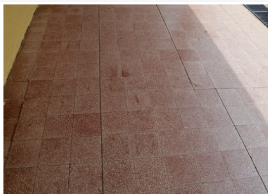
Pará de Minas Escola Estadual Fernando Otávio Piso em marmorite nos corredores que conformam o pátio central. (foto 34)
