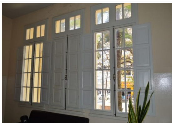
Pará de Minas Escola Estadual Governador Valadares Vista interna janela da fachada frontal em madeira. (foto 22) Imagem: Laís Costa– 26/08/2022
