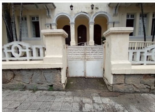
Pará de Minas Escola Estadual Governador Valadares Portal de metal na fachada frontal. (foto 47) Imagem: Gabriela Conceição– 26/08/2022
