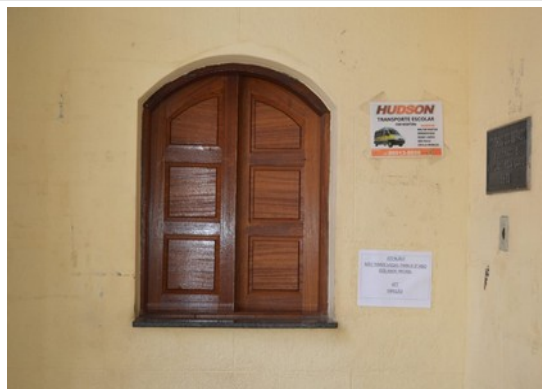
Pará de Minas Escola Estadual Governador Valadares Janela entre o hall de entrada e os claustros. (foto 21) Imagem: Laís Costa– 26/08/2022
