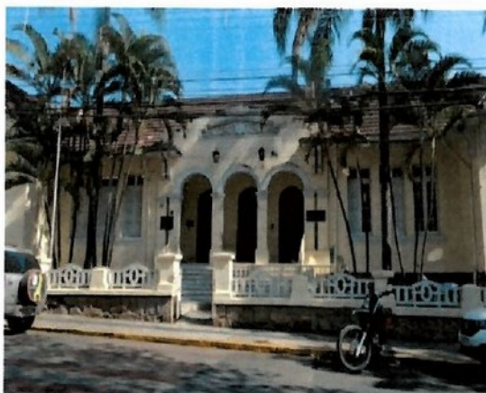
Pará de Minas Escola Estadual Governador Valadares Fachada Frontal (foto 01) Imagem: Laís Costa – 26/08/2022
