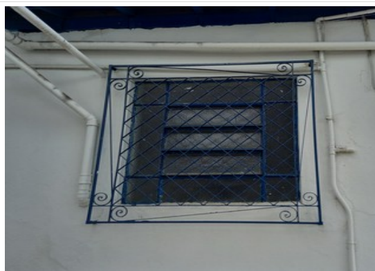
Pará de Minas Casa Maria Capanema Janelas em basculante em metal e vidro e grade na fachada lateral esquerda. (foto 31) Imagem: Laís Costa – 15/07/2022
