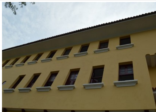
Pará de Minas Escola Estadual Fernando Otávio Janelas em madeira e vidro que compõem as fachadas. (foto 22) Imagem: Laís Costa – 09/11/2022
