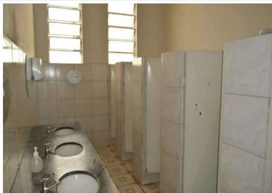
Pará de Minas Escola Estadual Governador Valadares Cerâmica comum aos banheiros. (foto 16) Imagem: Laís Costa– 26/08/2022
