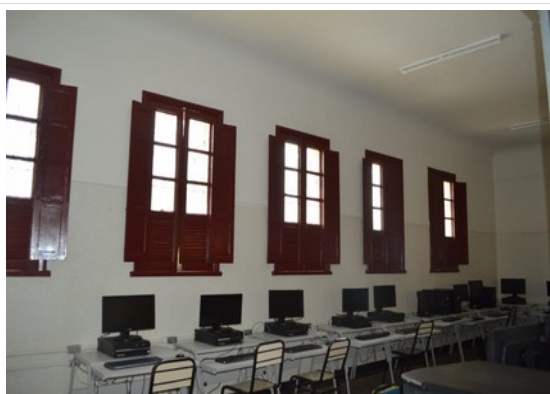
Pará de Minas Escola Estadual Fernando Otávio Pintura restaurada a base de água e barrado em tinta a óleo nas salas de aula. (foto 19) Imagem: Laís Costa – 09/11/2022
