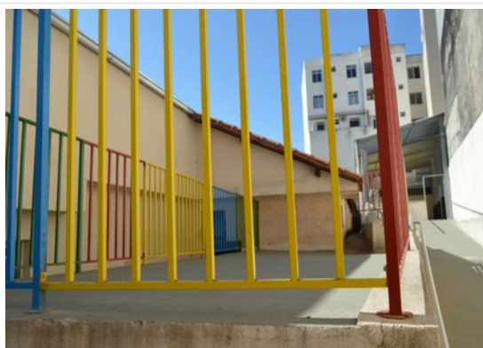
Pará de Minas Escola Estadual Torquato de Almeida Fachada posterior com a finalização da quadra. (foto 04) Imagem: Laís Costa – 18/08/2022
