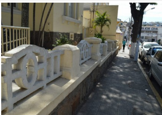
Pará de Minas Escola Estadual Governador Valadares Muro baixo com elemento vazado e revestido por pedras na fachada frontal. (foto 46) Imagem: Laís Costa– 26/08/2022
