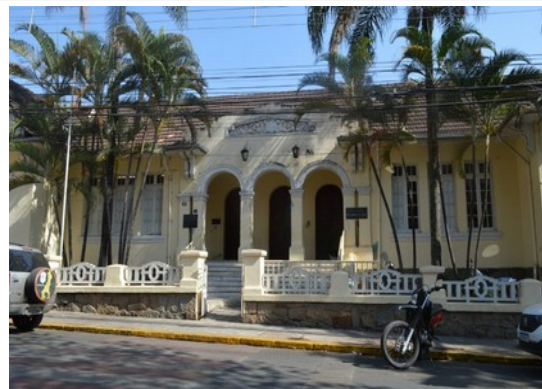
Pará de Minas Escola Estadual Governador Valadares Varanda que marca a entrada da fachada frontal. (foto 39) Imagem: Laís Costa– 26/08/2022
