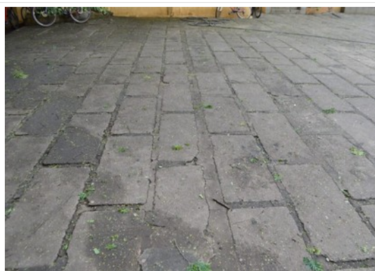
Pará de Minas Escola Estadual Fernando Otávio Piso cimentício no pátio interno. (foto 32) Imagem: Laís Costa – 09/11/2022
