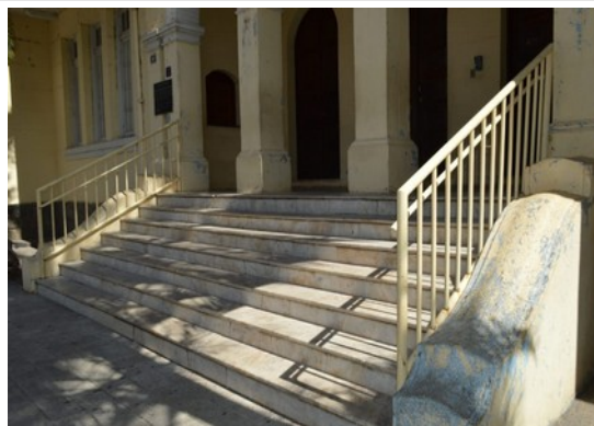
Pará de Minas Escola Estadual Governador Valadares Escadas do acesso principal a edificação. (foto 41) Imagem: Laís Costa– 26/08/2022
