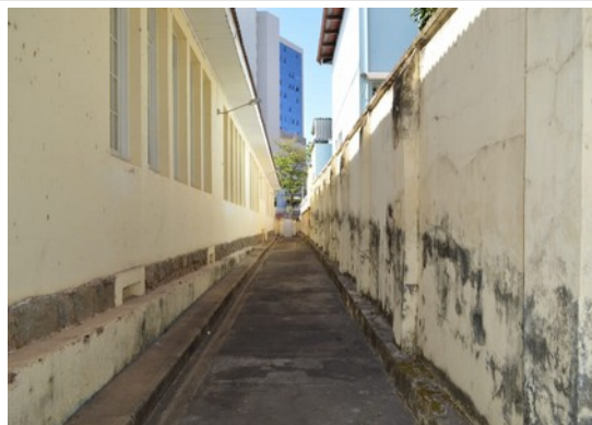
Pará de Minas Escola Estadual Governador Valadares Muro lateral esquerdo. (foto 45) Imagem: Laís Costa– 26/08/2022
