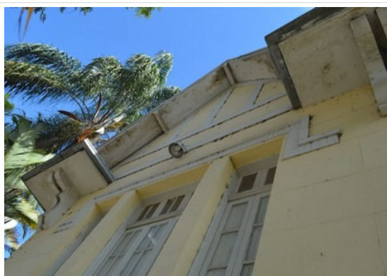
Pará de Minas Escola Estadual Governador Valadares Elementos artísticos na fachada frontal. (foto 18) Imagem: Laís Costa–26/08/2022
