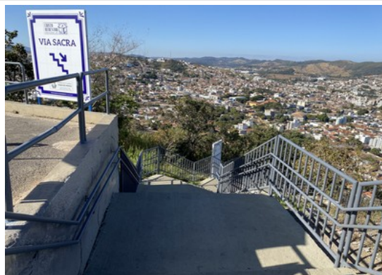
Pará de Minas Cristo Redentor Escadaria com mais de 670 degraus revitalizada e com novos guarda-corpos, exibindo a trajetória da Via Sacra, que dá acesso ao Cristo. (foto 22) Imagem: Laís Costa – 08/07/2022
