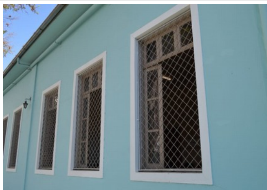
Pará de Minas Escola Estadual Torquato de Almeida Janela em madeira e vidro e grade em metal das fachadas laterais. (foto 22) Imagem: Laís Costa – 18/08/2022
