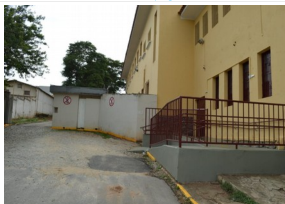
Pará de Minas Escola Estadual Fernando Otávio Fachada lateral esquerda com rampa de acessibilidade e nova pintura. (foto 03) Imagem: Laís Costa – 09/11/2022
