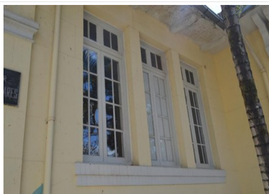
Pará de Minas Escola Estadual Governador Valadares Vista externa Janela com enquadramento e ornamentos em estuque. (foto 23) Imagem: Laís Costa– 26/08/2022
