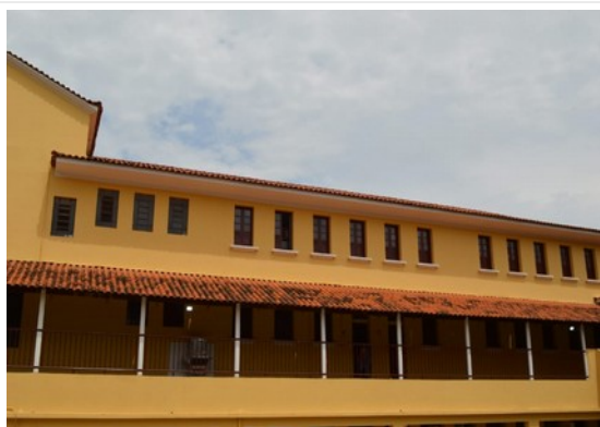
Pará de Minas Escola Estadual Fernando Otávio Manto de cobertura em telhas cerâmicas. (foto 07) Imagem: Laís Costa – 09/11/2022
