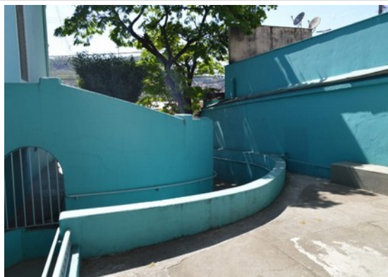
Pará de Minas Escola Estadual Torquato de Almeida Muro lateral esquerdo da edificação. (foto 37) Imagem: Laís Costa – 18/08/2022
