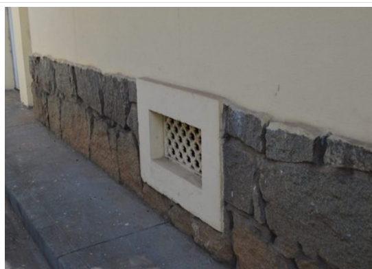
Pará de Minas Escola Estadual Governador Valadares Barrado em pedra bruta nas fachadas do bem. (foto 19) Imagem: Laís Costa– 26/08/2022
