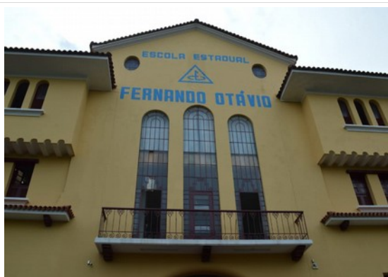
Pará de Minas Escola Estadual Fernando Otávio Janelões em metal e vidro que marcam o frontão. (foto 23) Imagem: Laís Costa – 09/11/2022
