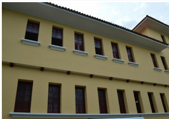
Pará de Minas Escola Estadual Fernando Otávio Alvenarias externas na fachada frontal. (foto 11) Imagem: Laís Costa – 09/11/2022
