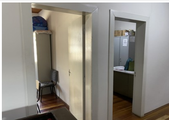
Pará de Minas Casa Maria Capanema Paredes e porta exibe camada pictórica em bom estado de conservação. (foto 24) Imagem: Laís Costa – 15/07/2022
