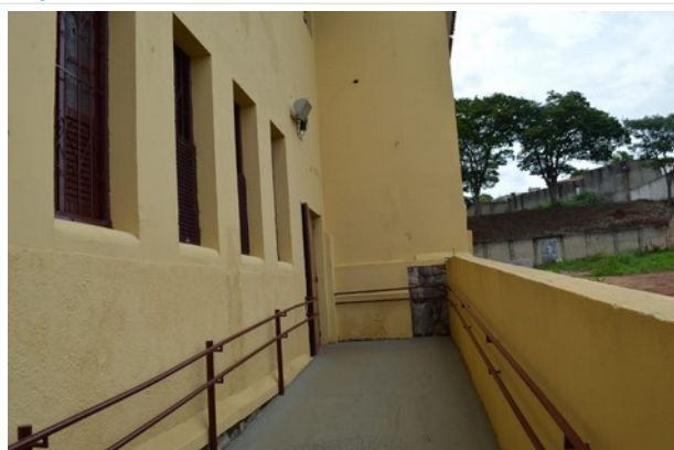
Pará de Minas Escola Estadual Fernando Otávio Fachada lateral direita com nova camada de pintura e rampa de acessibilidade. (foto 02) Imagem: Laís Costa – 09/11/2022
