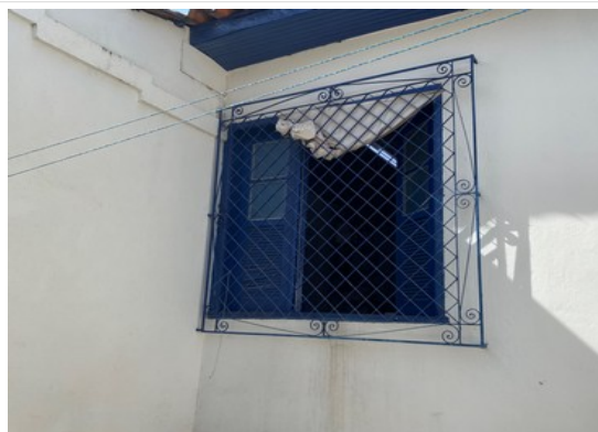
Pará de Minas Casa Maria Capanema Janela francesa em madeira e vidro e grade em metal na fachada posterior. (foto 29) Imagem: Laís Costa – 15/07/2022
