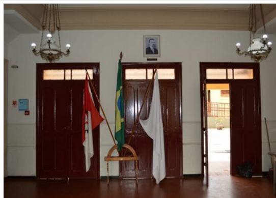
Pará de Minas Escola Estadual Fernando Otávio Portas de madeira e vidro que dão acesso ao pátio central. (foto 26) Imagem: Laís Costa – 09/11/2022
