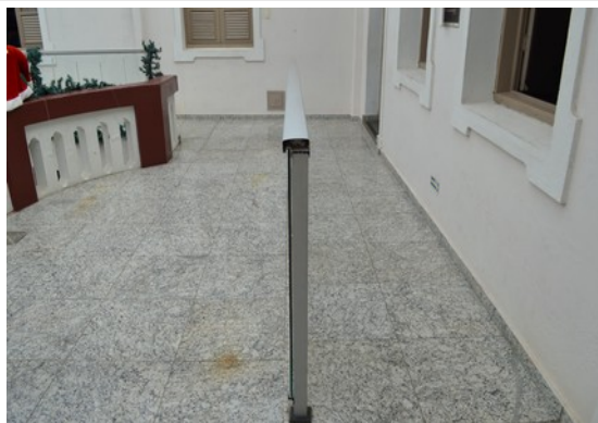
Pará de Minas Prédio Juscelino Kubitschek de Oliveira – Casa da Cultura Átrio revestido em granito arabesco. (foto 31) Imagem: Laís Costa – 22/07/2022
