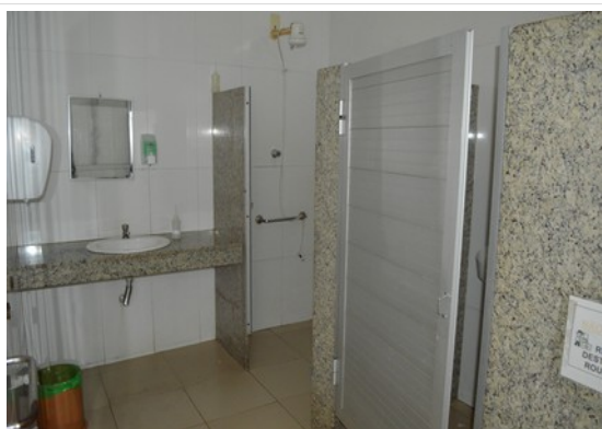
Pará de Minas Irmandade Nossa Senhora da Conceição – Hospital Revestimento cerâmico nos banheiros. (foto 13) Imagem: Laís Costa – 15/08/2022
