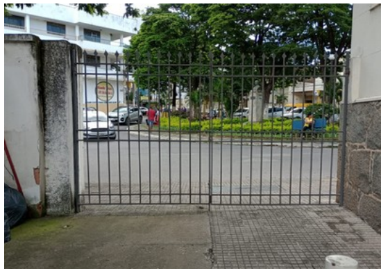
Pará de Minas Fórum Desembargador Pedro Nestor Portão em ferro na lateral direita da edificação. (foto 16)
