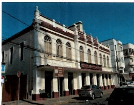
Pará de Minas Prédio Juscelino Kubitschek de Oliveira – Casa da Cultura Fachada Frontal. {foto 01} Imagem: Laís Costa – 22/07/2022
