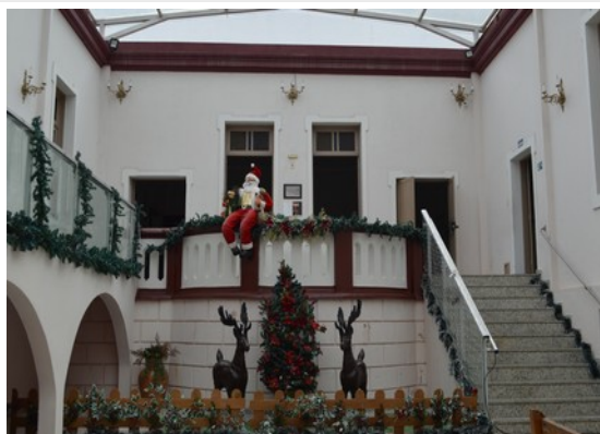
Pará de Minas Prédio Juscelino Kubitschek de Oliveira – Casa da Cultura Balaustre que perfaz o contorno do mezanino no átrio recebe pintura a base de água e a óleo. (foto 13) Imagem: Laís Costa – 22/07/2022
