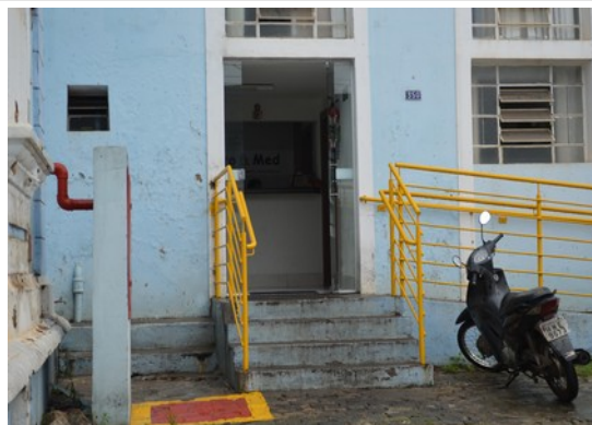
Pará de Minas Irmandade Nossa Senhora da Conceição – Hospital Escada da entrada secundária. (foto 42) Imagem: Laís Costa – 15/08/2022
