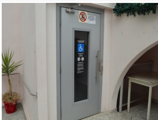
Pará de Minas Prédio Juscelino Kubitschek de Oliveira – Casa da Cultura Porta do elevador de acessibilidade. (foto 22) Imagem: Laís Costa – 22/07/2022
