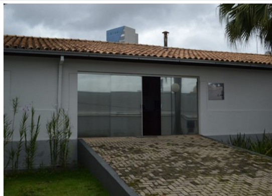
Pará de Minas MUSPAM Porta em vidro blindex no acesso principal ao bem e seu enquadramento em bom estado. (foto 21) Imagem: Laís Costa – 11/10/2022
