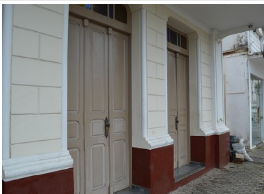
Pará de Minas Prédio Juscelino Kubitschek de Oliveira – Casa da Cultura Pintura da fachada frontal a base de água e a óleo. (foto 14) Imagem: Laís Costa – 22/07/2022
