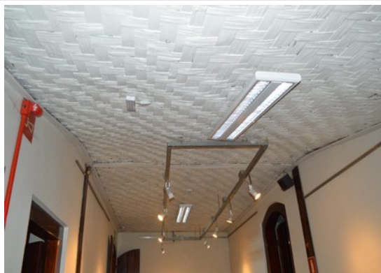
Pará de Minas MUSPAM As instalações do bem exibem bom estado de conservação. (foto 50) Imagem: Laís Costa – 11/10/2022
