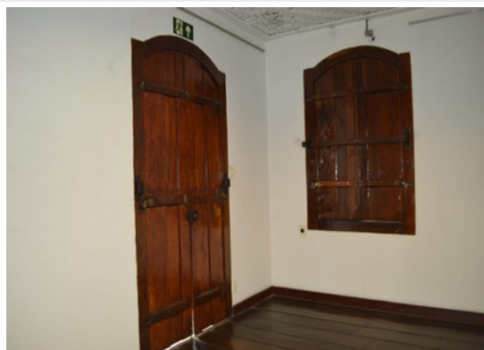
Pará de Minas MUSPAM Porta e enquadramento em madeira com verga curva apresentam bom estado de conservação (foto 23) Imagem: Laís Costa – 11/10/2022
