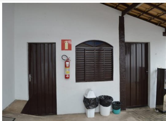
Pará de Minas MUSPAM Alvenaria apresenta nova camada pictórica. (foto 15) Imagem: Laís Costa – 11/10/2022
