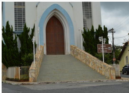
Pará de Minas Igreja Nossa Senhora das Graças Escada de acesso na fachada frontal. (foto 35) Imagem: Laís Costa – 10/12/2022
