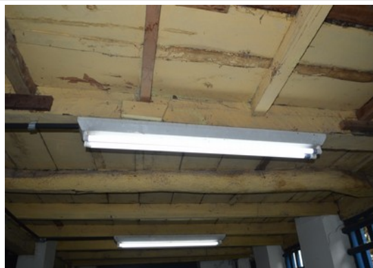
Pará de Minas Escola Municipal de Artes e Ofícios Raimundo Nogueira de Faria - SICA Madeiramento visto do porão. (foto 06) Imagem: Laís Costa – 19/08/2022
