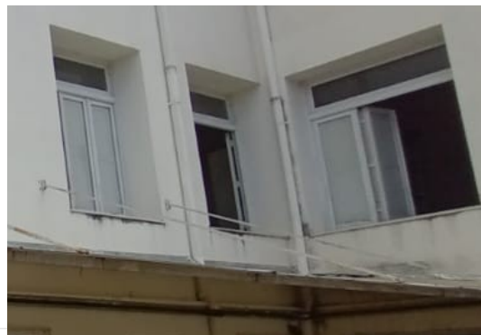
Pará de Minas Fórum Desembargador Pedro Nestor Janelas em madeira e enquadramento em massa na fachada
