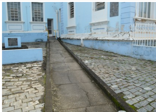
Pará de Minas Irmandade Nossa Senhora da Conceição – Hospital Caminho cimentado que leva ao bazar. (foto 28) Imagem: Laís Costa – 15/08/2022
