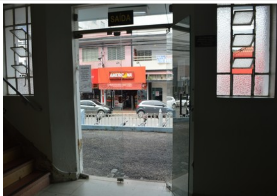
Pará de Minas Irmandade Nossa Senhora da Conceição – Hospital Porta de vidro com enquadramento em massa de acesso à maternidade. (foto 19) Imagem: Laís Costa – 15/08/2022
