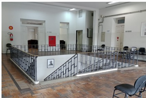
Pará de Minas Fórum Desembargador Pedro Nestor Quinas não apresenta nenhum sinal de fissuras ou trincas. (foto 05) Imagem: Gabriela Conceição – 02/01/2023
