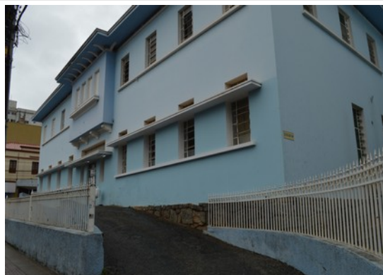
Pará de Minas Irmandade Nossa Senhora da Conceição – Hospital Vista externa das muretas e gradis da fachada frontal. (foto 46) Imagem: Laís Costa – 15/08/2022
