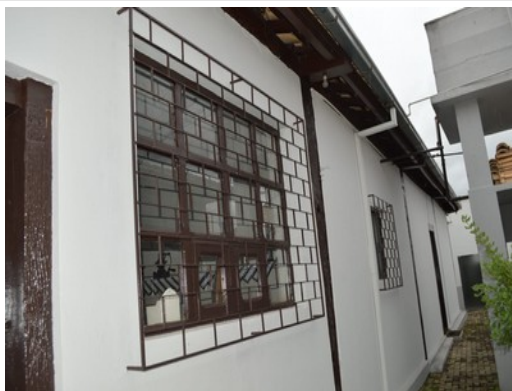
Pará de Minas MUSPAM Enquadramento das janelas em grade exibem bom estado de conservação. (foto 20) Imagem: Laís Costa – 11/10/2022
