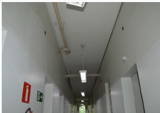
Pará de Minas Irmandade Nossa Senhora da Conceição – Hospital Forro de gesso no corredor do térreo. (foto 37) Imagem: Laís Costa – 15/08/2022
