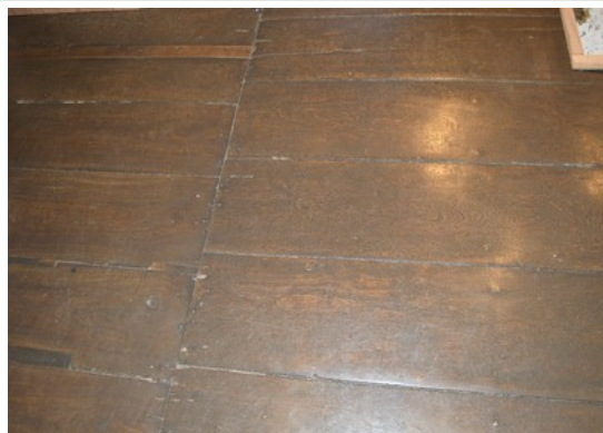
Pará de Minas Escola Municipal de Artes e Ofícios Raimundo Nogueira de Faria - SICA Assoalho de madeira acima do porão com marcas de uso . (foto 30) Imagem: Laís Costa– 19/08/2022
