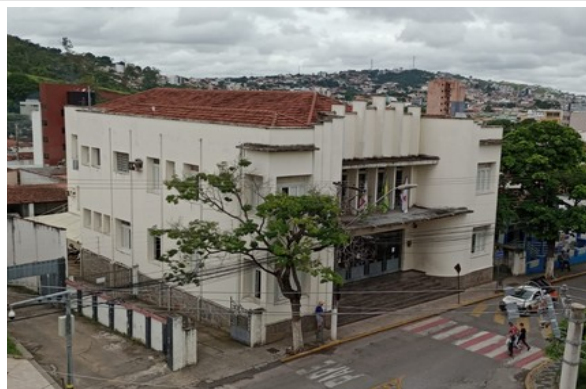
Pará de Minas Fórum Desembargador Pedro Nestor Manto de cobertura em telhas francesas. (foto 08) Imagem: Gabriela Conceição – 02/01/2023
