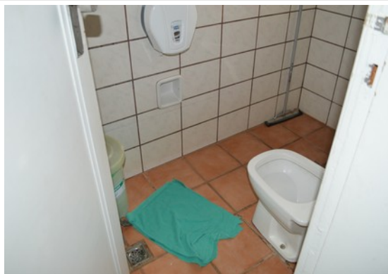
Pará de Minas Irmandade Nossa Senhora da Conceição – Hospital Revestimento cerâmico nos banheiros. (foto 11) Imagem: Laís Costa – 15/08/2022
