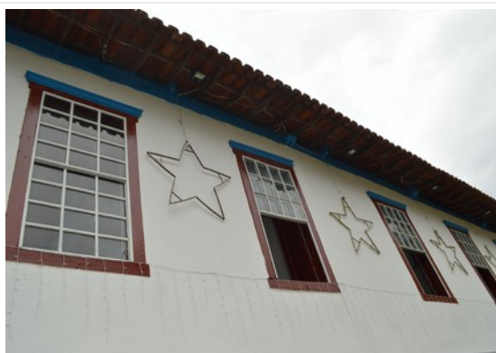
Pará de Minas Escola Municipal de Artes e Ofícios Raimundo Nogueira de Faria - SICA Alvenaria externa da fachada frontal. (foto 07) Imagem: Laís Costa – 19/08/2022
