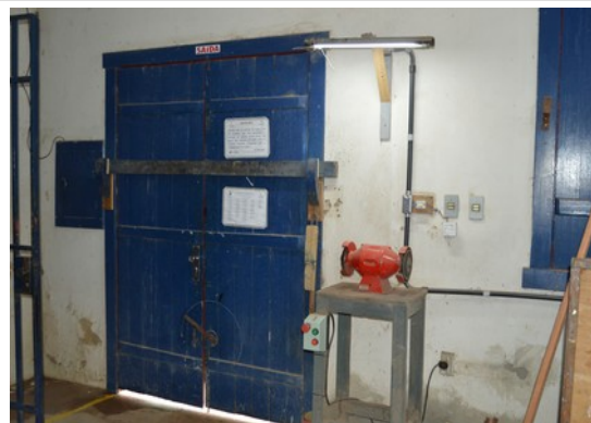
Pará de Minas Escola Municipal de Artes e Ofícios Raimundo Nogueira de Faria - SICA Instalações elétricas da oficina reformadas. (foto 52) Imagem: Laís Costa – 19/08/2022
