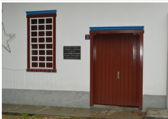
Pará de Minas Escola Municipal de Artes e Ofícios Raimundo Nogueira de Faria - SICA Porta de madeira de duas folhas de acesso direto às oficinas. (foto 23) Imagem: Laís Costa – 19/08/2022
