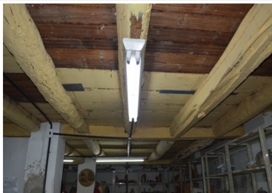
Pará de Minas Escola Municipal de Artes e Ofícios Raimundo Nogueira de Faria - SICA Madeiramento visto do porão. (foto 05) Imagem: Laís Costa – 19/08/2022
