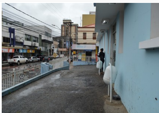
Pará de Minas Irmandade Nossa Senhora da Conceição – Hospital Manta asfáltica na rampa de acesso à entrada principal da maternidade. (foto 29) Imagem: Laís Costa – 15/08/2022
