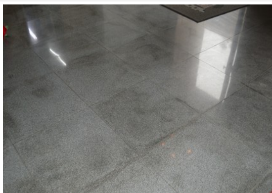
Pará de Minas Prédio Juscelino Kubitschek de Oliveira – Casa da Cultura Granito cinza, piso do hall de entrada. (foto 29) Imagem: Laís Costa – 22/07/2022
