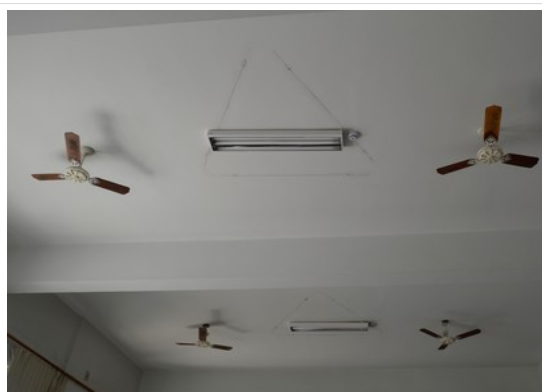
Pará de Minas Irmandade Nossa Senhora da Conceição – Hospital Laje com vigamento no salão. (foto 40) Imagem: Laís Costa – 15/08/2022
