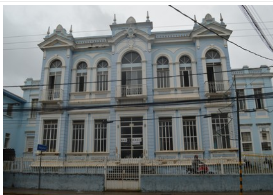
Pará de Minas Irmandade Nossa Senhora da Conceição – Hospital Vista externa da edificação. (foto 04) Imagem: Laís Costa – 15/08/2022
