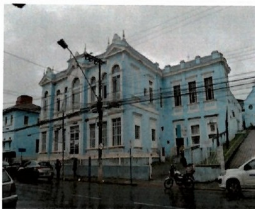
Pará de Minas Irmandade Nossa Senhora da Conceição – Hospital Fachada Frontal. (foto 01)
