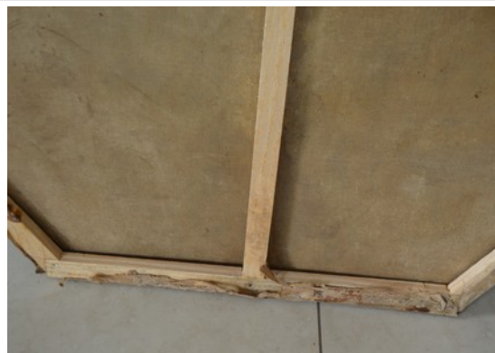
Pará de Minas Telas da Antiga Matriz de Nossa Senhora da Piedade Chassi sob ataque de insetos xilófagos e reentelamento desprendendo-se. (foto 45) Imagem: Laís Costa – 05/11/2022
