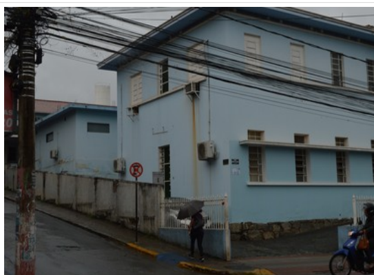
Pará de Minas Irmandade Nossa Senhora da Conceição – Hospital Muro na lateral esquerda da edificação. (foto 47) Imagem: Laís Costa – 15/08/2022
