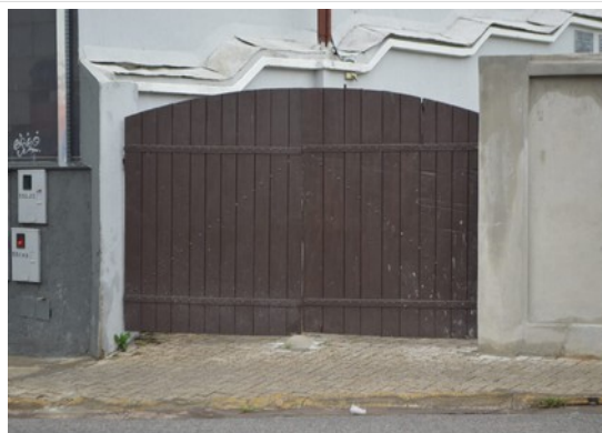
Pará de Minas MUSPAM Portão em madeira e duas folhas do acesso de veículos em bom estado. (foto 46) Imagem: Laís Costa – 11/10/2022
