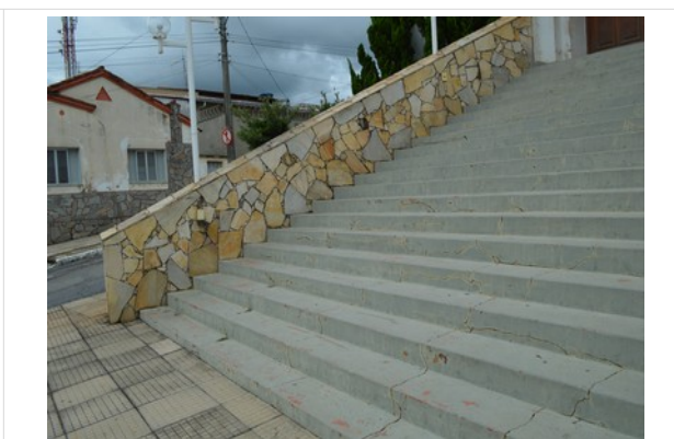
Pará de Minas Igreja Nossa Senhora das Graças Pedra são tomé que revestem o barrado e o guarda-corpo da escada principal. (foto 15) Imagem: Laís Costa – 10/12/2022
