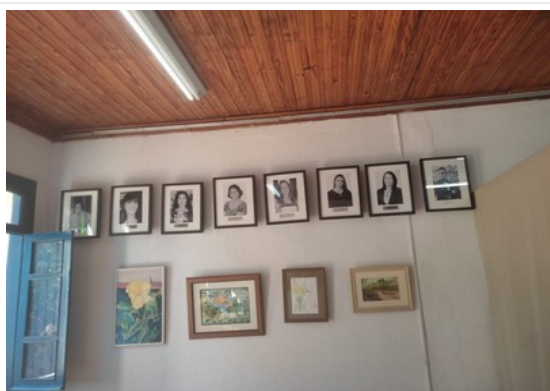
Pará de Minas Escola Municipal de Artes e Ofícios Raimundo Nogueira de Faria - SICA Alvenaria interna do pavimento térreo. (foto 15) Imagem: Laís Costa – 19/08/2022
