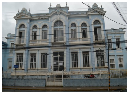
Pará de Minas Irmandade Nossa Senhora da Conceição – Hospital Sacadas e guarda-corpos em ferro forjado da fachada frontal da edificação. (foto 44) Imagem: Laís Costa – 15/08/2022
