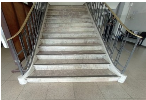
Pará de Minas Fórum Desembargador Pedro Nestor Escadaria do hall de entrada com pisos e espelhos em mármore. (foto 27) Imagem: Gabriela Conceição – 02/01/2023
