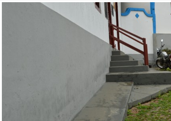
Pará de Minas Escola Municipal de Artes e Ofícios Raimundo Nogueira de Faria - SICA Piso cimentado da calçada e escada na fachada frontal. (foto 29) Imagem: Laís Costa – 19/08/2022
