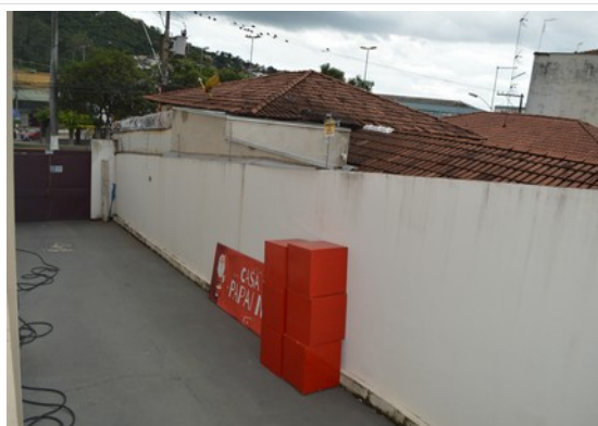
Pará de Minas Prédio Juscelino Kubitschek de Oliveira – Casa da Cultura Acesso lateral rampado de piso cimentado. (foto 35) Imagem: Laís Costa – 22/07/2022
