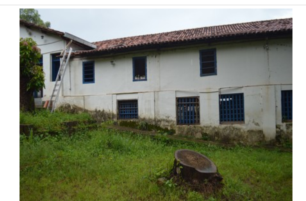
Pará de Minas Escola Municipal de Artes e Ofícios Raimundo Nogueira de Faria - SICA Vista do manto de cobertura em telhas francesas. (foto 12) Imagem: Laís Costa – 19/08/2022
