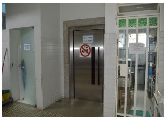
Pará de Minas Irmandade Nossa Senhora da Conceição – Hospital Porta do elevador. (foto 21) Imagem: Laís Costa – 15/08/2022
