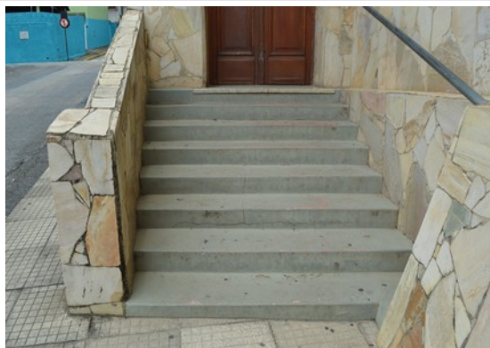
Pará de Minas Igreja Nossa Senhora das Graças Escada de acesso na lateral esquerda. (foto 34) Imagem: Laís Costa – 10/12/2022
