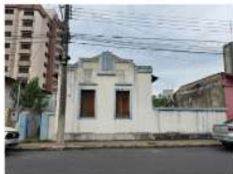
Fachada Frontal da edificação
