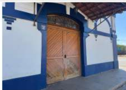
Pará de Minas Estação Ferroviária Porta de madeira ao lado direito na fachada frontal exibe desgaste do material. (foto 28) Imagem: Vitória Moraes - 09/09/2025
