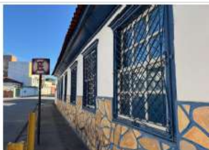
Pará de Minas Casa Maria Capanema Janelas tipo guilhotina em madeira e vidro e grade em metal com camada pictórica em bom estado. (foto 27) Imagem: Vitória Moraes – 30/07/2025
