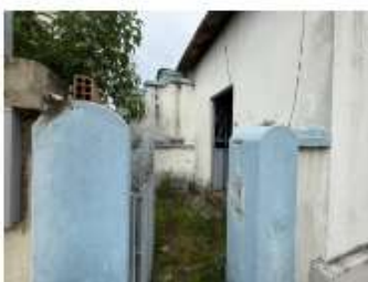
Hall de acesso a edificação
