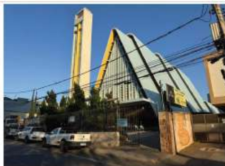
Pará de Minas Santuário Nossa Senhora da Piedade Fachada Frontal (foto 01) Imagem: Vitória Moraes – 18/08/2025
