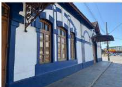
Pará de Minas Estação Ferroviária Janelas da fachada frontal da Estação em madeira e vidro, enquadramento em massa sobreverga e elementos artísticos em bom estado. (foto 29) Imagem: Vitória Moraes - 09/09/2025
