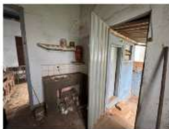
Detalhe da bancada da cozinha
