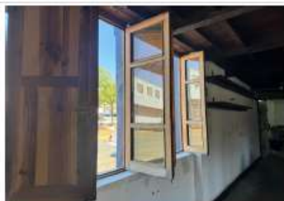
Pará de Minas Estação Ferroviária Vista interna das janelas da fachada frontal em madeira e vidro (vidro sob o piso do mezanino) enquadramento em massa. (foto 30) Imagem: Vitória Moraes - 09/09/2025
