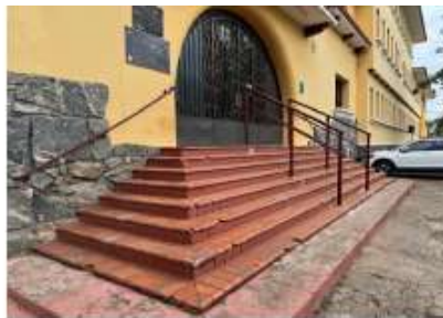
Pará de Minas Escola Estadual Fernando Otávio Escada da entrada principal revestida em cerâmica. (foto 30) Imagem: Vitória Moraes – 24/09/2025
