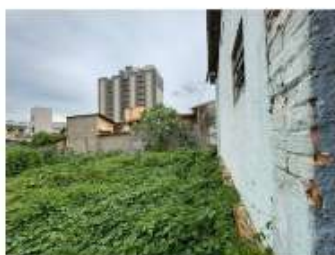
Vista da Fachada Posterior
