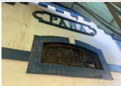
Pará de Minas Estação Ferroviária Janelas da fachada frontal da Estação em madeira e vidro, enquadramento em massa sobreverga e elementos artísticos em bom estado. (foto 29) Imagem: Vitória Moraes - 09/09/2025
