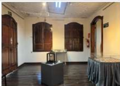
Pará de Minas MUSPAM Janela francesa e enquadramento em madeira e verga curva bem conservados. (foto 26) Imagem: Vitória Moraes – 08/08/2025
