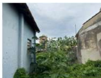
Vista da Fachada Lateral com parte do terreno não edificado.
