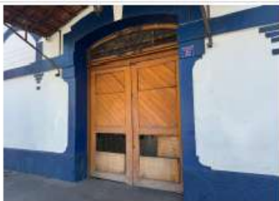
Pará de Minas Estação Ferroviária Porta de madeira ao lado esquerdo na fachada frontal exibe recortes nas folhas executados anteriormente a retomada do bem pelo município. (foto 27) Imagem: Vitória Moraes - 09/09/2025
