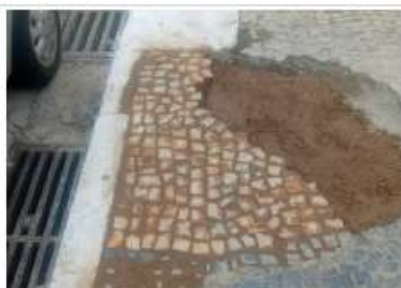
Praças Torquato de Almeida e Francisco Torquato Reparo realizado em trecho revestido por calçada portuguesa. (foto 20)
