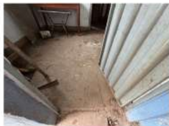
Piso da Cozinha em concreto
