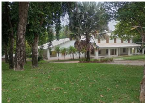
Pará de Minas Edificação à Avenida Presidente Vargas n° 875 Fachada lateral direita (foto 16) Imagem: Vitória Moraes - 18/12/2025
