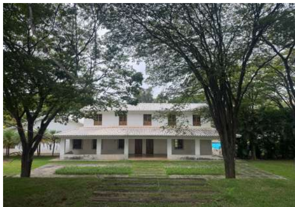
Pará de Minas Edificação à Avenida Presidente Vargas n° 875 Fachada frontal (foto 15) Imagem: Vitória Moraes - 18/12/2025
