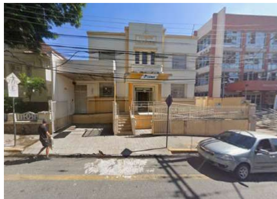
Pará de Minas Edificação à Rua Delfim Moreira n° 30. Fachada frontal (foto 12) Imagem: Google Maps - Maio/2023
