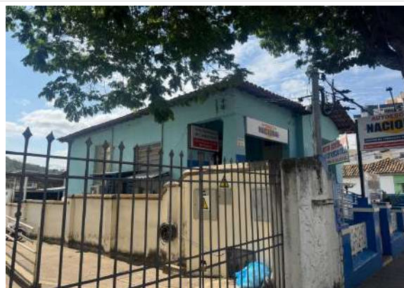
Pará de Minas Edificação à Praça Afonso Pena nº 11. Fachada lateral direita (foto 02) Imagem: Vitória Moraes - 10/10/2025
