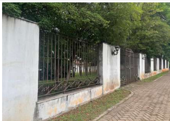
Pará de Minas Edificação à Avenida Presidente Vargas n° 875 Muro de fechamento (foto 18) Imagem: Vitória Moraes - 18/12/2025
