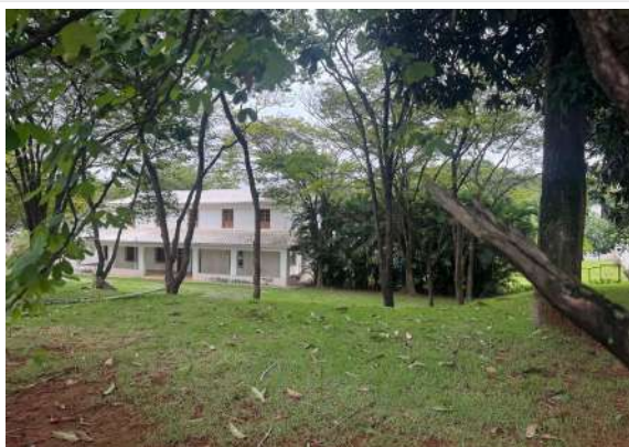
Pará de Minas Edificação à Avenida Presidente Vargas n° 875 Fachada lateral esquerda (foto 17) Imagem: Vitória Moraes - 18/12/2025
