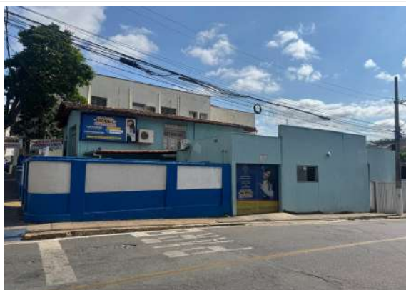
Pará de Minas Edificação à Praça Afonso Pena nº 11. Fachada lateral esquerda (foto 03) Imagem: Vitória Moraes - 10/10/2025
