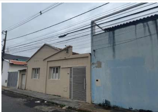
Fachada Frontal da Casa do Padre Libério com vista para o vizinho da direita (foto 03) Imagem: Vitória Moraes – 06/01/2026
