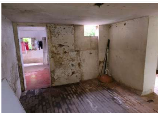
Vista da parte de baixo da casa (foto 15) Imagem: Vitória Moraes – 06/01/2026
