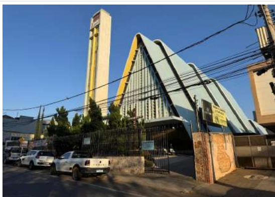
Fachada Frontal do Santuário Nossa Senhora da Piedade, em 18.08.2025. Fonte: Arquivo Secretaria de Cultura e Comunicação Institucional de Pará de Minas
