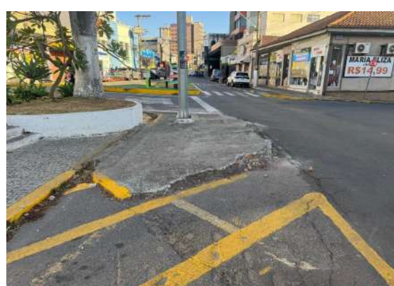
Pará de Minas Praças Torquato de Almeida e Francisco Torquato Parte da calçada exibindo rompimento e perca de parte do material. (foto 07) Imagem: Vitória Moraes - 31/07/2025
