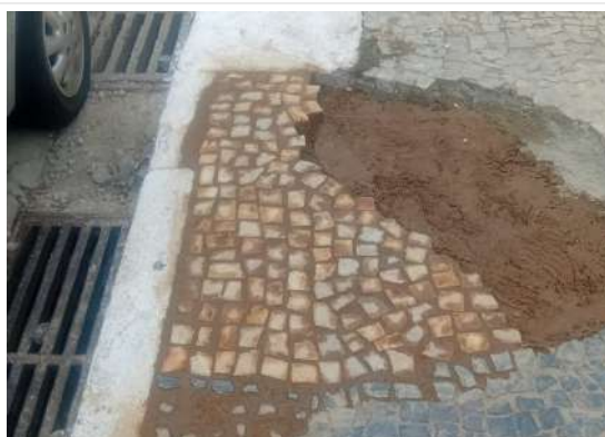
Praças Torquato de Almeida e Francisco Torquato Reparo realizado em trecho revestida por calçada portuguesa. (foto 20)
