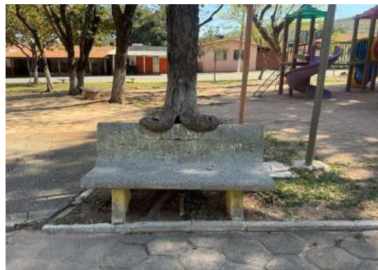
Pará de Minas Núcleo Histórico Urbano do Distrito de Carioca Banco em concreto exibindo algumas trincas devido ao esforço que a árvore está exercendo sobre o concreto. (foto 72) Imagem: Vitória Moraes - 30/09/2025
