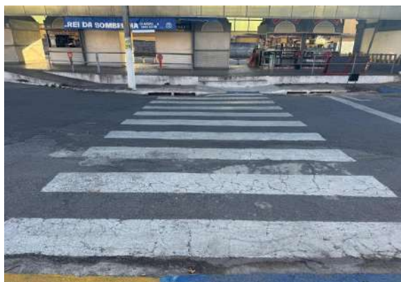
Pará de Minas Praças Torquato de Almeida e Francisco Torquato Instalação de faixa de pedestre, com rebaixo da calçada oposta a Praça. (foto 06) Imagem: Vitória Moraes - 31/07/2025
