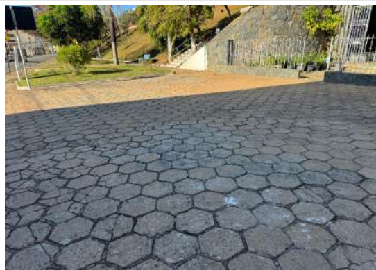
Pará de Minas Gruta de Nossa Senhora de Lourdes Piso de concreto intertravado apresenta algumas fissuras e pequenos desníveis devido a compactação irregular do terreno. (foto 18) Imagem: Imagem: Vitória Moraes – 30/07/2025
