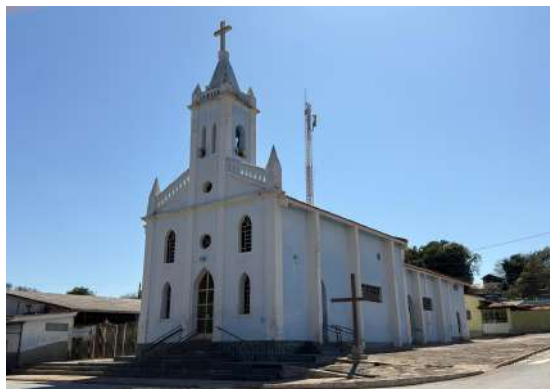
Pará de Minas Núcleo histórico Urbano do Distrito de Carioca Rampa de acessibilidade para a entrada na lateral direita da Igreja de Nossa Senhora de Lourdes. (foto 20) Imagem: Vitória Moraes - 30/09/2025
