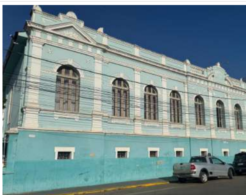
Pará de Minas Escola Estadual Torquato de Almeida Janelas em madeira e vidro da fachada frontal enquadramento em massa com adornos.
