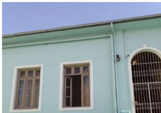
Pará de Minas Escola Estadual Torquato de Almeida Beiral e condutores de águas pluviais na lateral esquerda do bem. (foto 09) Imagem: Vitória Moraes – 07/08/2025
