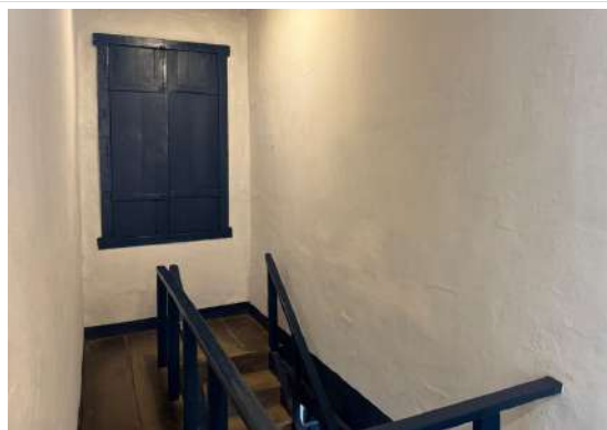
Pará de Minas Escola Municipal de Artes e Ofícios Raimundo Nogueira de Faria - SICA Reboco e pintura a base de água nas alvenarias e pintura a óleo nas madeiras de portas, janelas e guarda-corpo. (foto 18) Imagem: Vitoria Moraes – 21/08/2025
