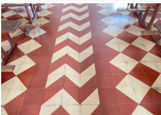
Pará de Minas Asilo Padre José Pereira Coelho Ladrilho hidráulico em diferentes paginações exibem alguns desgastes pela ação do tempo e uso. (foto 40) Imagem: Vitória Moraes - 22/09/2025
