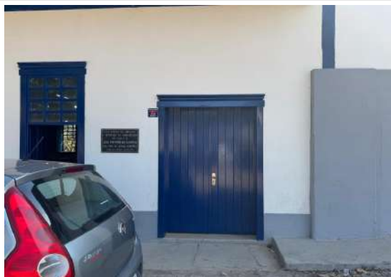
Pará de Minas Escola Municipal de Artes e Ofícios Raimundo Nogueira de Faria - SICA Porta de madeira de duas folhas de acesso direto às oficinas, exibindo nova camada pictórica. (foto 25) Imagem: Vitoria Moraes – 21/08/2025
