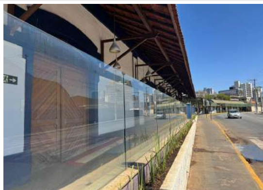
Pará de Minas Estação Ferroviária Vista externa do muro da fachada posterior em alvenaria e vidro bem conservados. (foto 58) Imagem: Vitória Moraes - 09/09/2025
