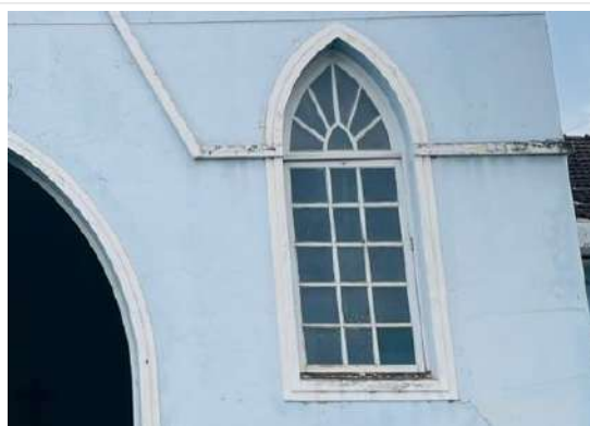
Pará de Minas Asilo Padre José Pereira Coelho Janela da fachada frontal em metal e vidro e enquadramento em massa bem conservadas, nota-se manchas de intempéries no peitoril. (foto 27) Imagem: Vitória Moraes - 22/09/2025
