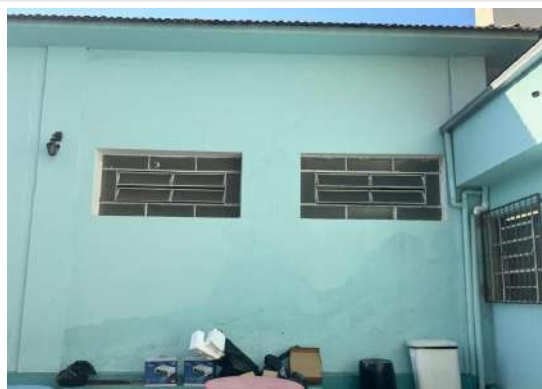
Pará de Minas Escola Estadual Torquato de Almeida Janelas em metal e vidro e enquadramento em massa nos banheiros na lateral esquerda do bem. (foto 23) Imagem: Vitória Moraes – 07/08/2025
