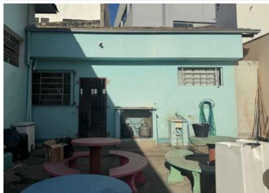
Pará de Minas Escola Estadual Torquato de Almeida Janelas em metal e vidro e enquadramento em massa na cozinha. (foto 21) Imagem: Vitória Moraes – 07/08/2025
