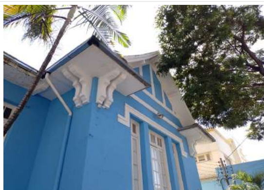
Pará de Minas Escola Estadual Governador Valadares Beiral em bom estado de conservação, exibindo nova camada pictórica. (foto 11) Imagem: Vitória Moraes – 07/08/2025
