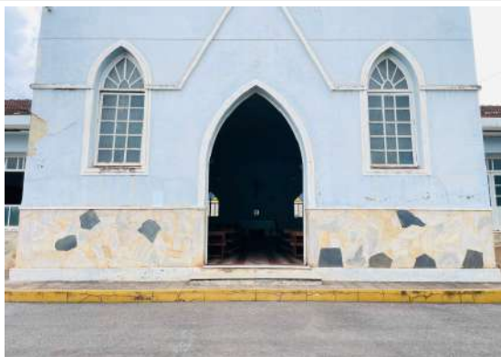
Pará de Minas Asilo Padre José Pereira Coelho Fachada da Capela exibindo desgaste na pintura e perda de material. (foto 20) Imagem: Vitória Moraes - 22/09/2025
