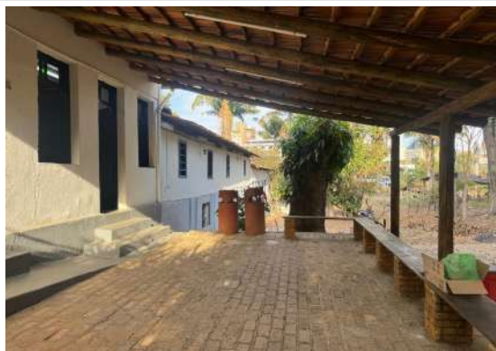
Pará de Minas Escola Municipal de Artes e Ofícios Raimundo Nogueira de Faria - SICA Piso em tijolo de barro na varanda da fachada posterior. (foto 38) Imagem: Vitoria Moraes – 21/08/2025
