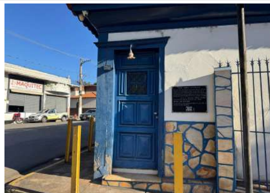
Pará de Minas Casa Maria Capanema Pilar de madeira na fachada do bem em bom estado de conservação. (foto 07) Imagem: Vitória Moraes – 30/07/2025
