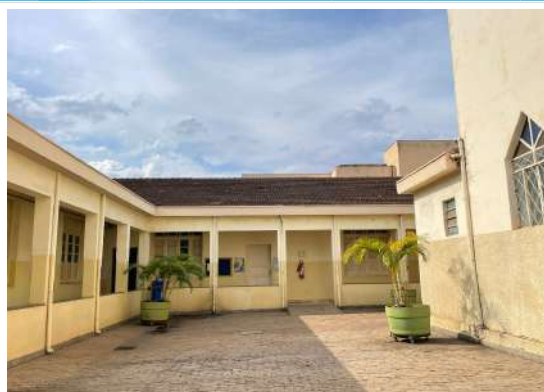
Pará de Minas Asilo Padre José Pereira Coelho A estrutura em vigas e pilares de concreto armado não apresenta danos. (foto 05) Imagem: Vitória Moraes - 22/09/2025
