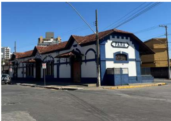
Pará de Minas Estação Ferroviária Reboco e pintura externos no geral exibem bom estado. (foto 15) Imagem: Vitória Moraes - 09/09/2025
