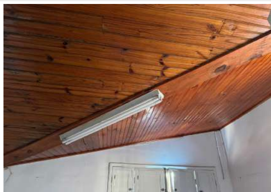
Pará de Minas Casa Maria Capanema Forro de madeira presente em todo interior do bem em bom estado de conservação. (foto 41) Imagem: Vitória Moraes – 30/07/2025
