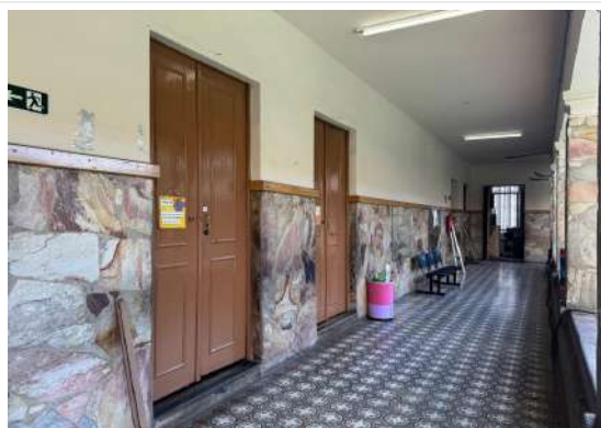
Pará de Minas Escola Estadual Torquato de Almeida Porta das salas de aula em madeira pintada com tinta a óleo. (foto 18) Imagem: Vitória Moraes – 07/08/2025
