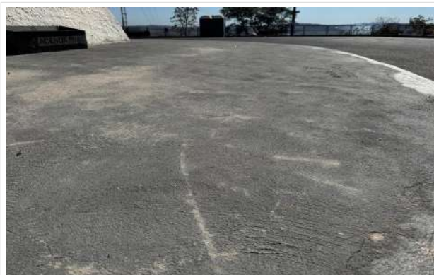
Pará de Minas Cristo Redentor Cobertura da base em grama sintética removida, permanecendo apenas a estrutura de base em concreto. (foto 15) Imagem: Vitória Moraes - 26/08/2025
