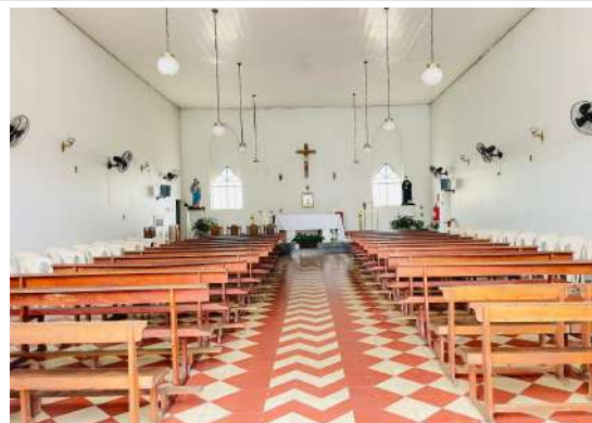
Pará de Minas Asilo Padre José Pereira Coelho Reboco e pinturas à base de água do interior da Capela em bom estado de conservação.
