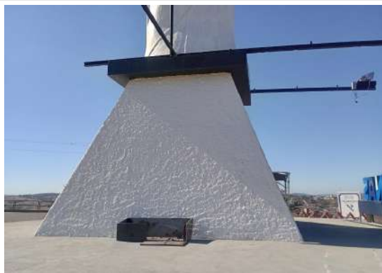
Pará de Minas Cristo Redentor O pedestal de tijolos apresenta bom estado de conservação, exibindo nova camada pictórica. (foto 06) Imagem: Vitória Moraes - 26/08/2025
