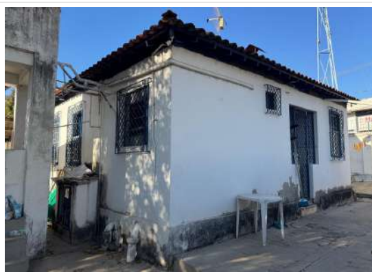
Pará de Minas Casa Maria Capanema Fachada lateral direita com camada pictórica apenas com algumas manchas de sujeira devido a exposição as intempéries (foto 14) Imagem: Vitória Moraes – 30/07/2025
