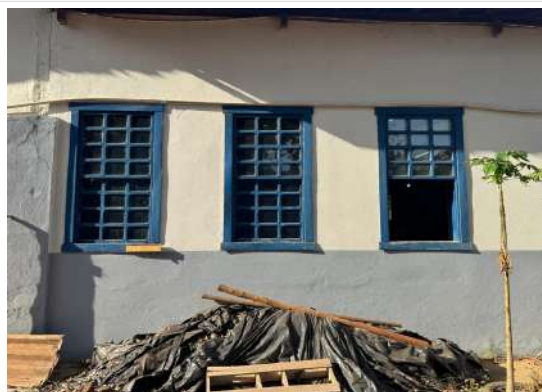
Pará de Minas Escola Municipal de Artes e Ofícios Raimundo Nogueira de Faria - SICA Janelas guilhotina em madeira e vidro localizadas no porão. (foto 28) Imagem: Vitoria Moraes – 21/08/2025
