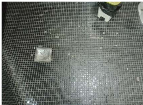
Pará de Minas Estação Ferroviária Pastilhas do banheiro PNE exibindo perda de algumas peças. (foto 46) Imagem: Vitória Moraes - 09/09/2025
