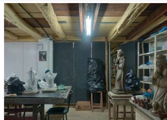
Pará de Minas Escola Municipal de Artes e Ofícios Raimundo Nogueira de Faria - SICA Instalação de divisória em MDF, para resguardo de obras de arte e troca das peças de madeira que estavam comprometidas. (foto 17) Imagem: Vitoria Moraes – 21/08/2025
