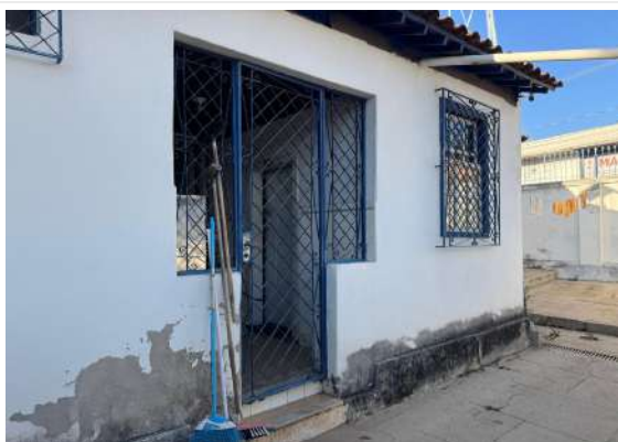
Pará de Minas Casa Maria Capanema Grades de fechamentos em bom estado de conservação na fachada posterior do bem. (foto 26) Imagem: Vitória Moraes – 30/07/2025
