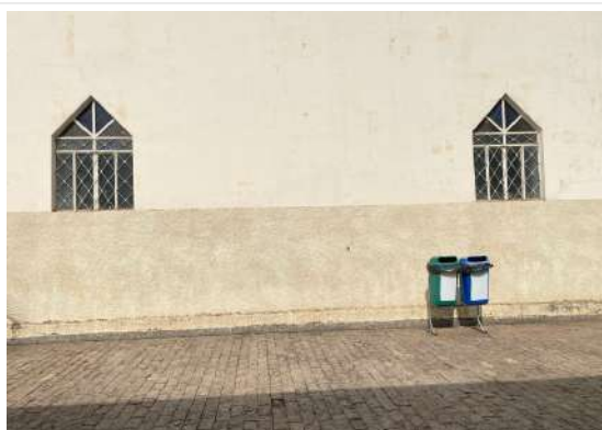
Pará de Minas Asilo Padre José Pereira Coelho Vista externa das janelas do altar da capela, feitas em metal e vidro e enquadramento em massa. (foto 26) Imagem: Vitória Moraes - 22/09/2025
