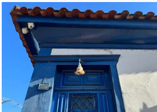
Pará de Minas Casa Maria Capanema Cimalhas apresentando bom estado de conservação. (foto 10) Imagem: Vitória Moraes – 30/07/2025
