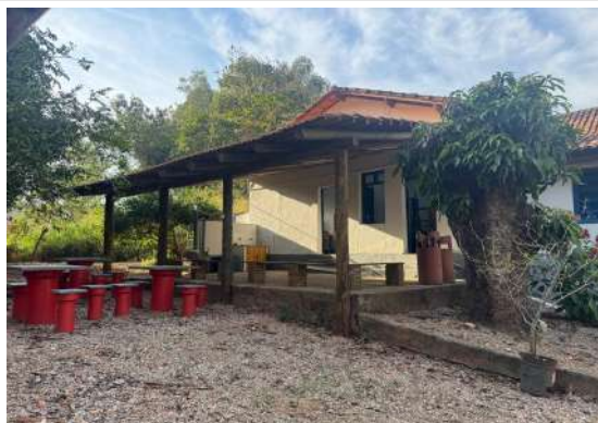
Pará de Minas Escola Municipal de Artes e Ofícios Raimundo Nogueira de Faria - SICA Varanda na fachada frontal em estrutura de madeira e cobertura em telhas cerâmicas.. (foto 45) Imagem: Vitoria Moraes – 21/08/2025
