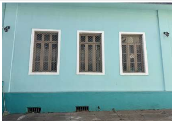
Pará de Minas Escola Estadual Torquato de Almeida Janela em madeira e vidro e grade em metal das fachadas laterais. (foto 22) Imagem: Vitória Moraes – 07/08/2025
