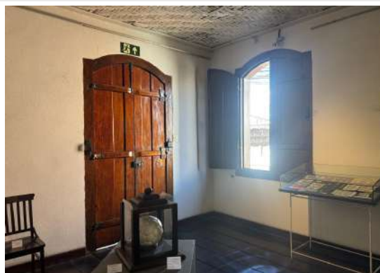
Pará de Minas MUSPAM Porta e enquadramento em madeira com verga curva apresentam bom estado de conservação (foto 23) Imagem: Vitória Moraes – 08/08/2025
