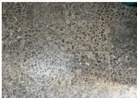
Pará de Minas MUSPAM Marmorite de algumas salas do bem, apresenta desgaste em decorrência do uso constante. (foto 36) Imagem: Vitória Moraes – 08/08/2025
