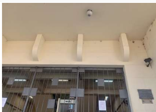
Pará de Minas Fórum Desembargador Pedro Nestor Laje de cobertura da entrada principal apresenta alguns sinais de infiltração. (foto 40) Imagem: Vitória Moraes – 13/08/2025
