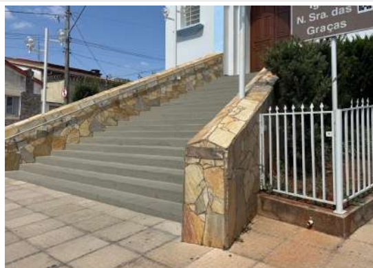
Pará de Minas Igreja Nossa Senhora das Graças Pedra são tomé que revestem o barrado e o guarda-corpo da escada principal. (foto 15) Imagem: Vitória Moraes – 08/09/2025
