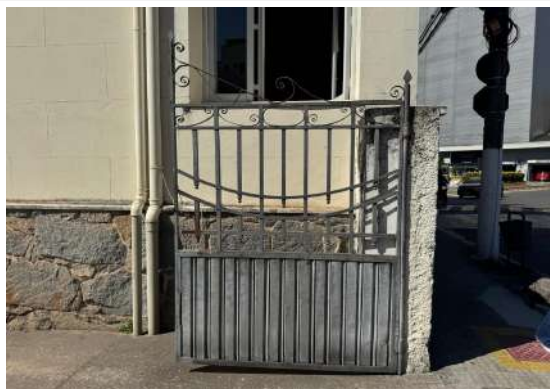
Pará de Minas Fórum Desembargador Pedro Nestor Portão em ferro na lateral esquerda da edificação apresenta nova barra. (foto 17) Imagem: Vitória Moraes – 13/08/2025
