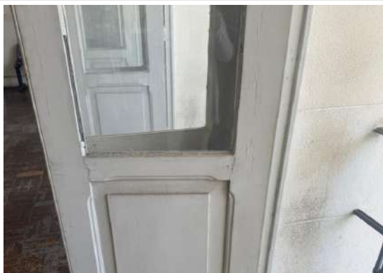
Pará de Minas Fórum Desembargador Pedro Nestor Deterioração contínua da massa no vidro de fechamento das janelas do 1º pavimento. (foto 19) Imagem: Vitória Moraes – 13/08/2025
