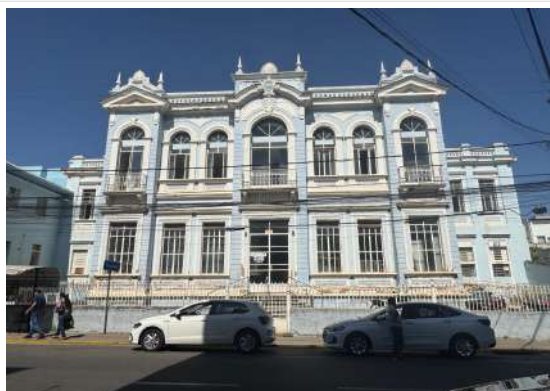
Pará de Minas Irmandade Nossa Senhora da Conceição – Hospital Portas e janelas em metal e vidro com enquadramento em massa na fachada frontal. (foto 17) Imagem: Vitória Moraes – 28/08/2025
