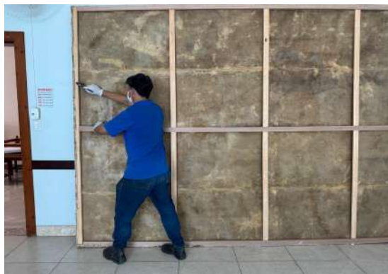
Pará de Minas Processo de avaliação dos chassis e limpeza da mesma na Antiga Igreja Matriz (foto 59) Imagem: Vitória Moraes – 28/11/2025
