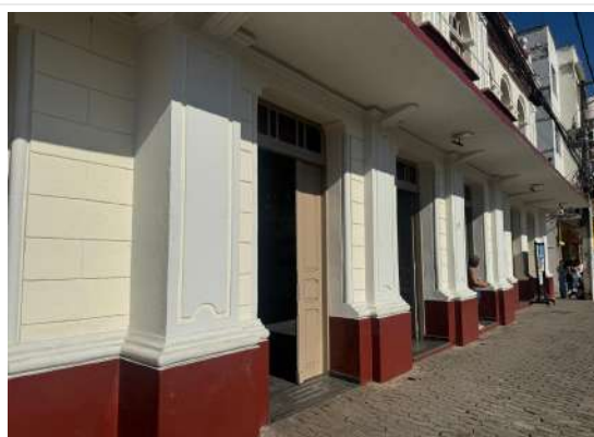
Pará de Minas Prédio Juscelino Kubitschek de Oliveira – Casa da Cultura Nova pintura da fachada frontal a base de água e a óleo. (foto 14) Imagem: Vitória Moraes – 06/08/2025
