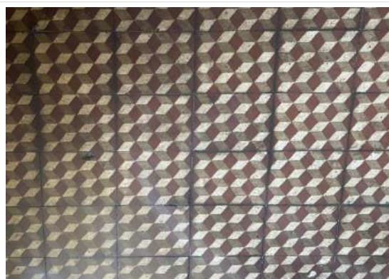
Pará de Minas MUSPAM Ladrilho hidráulico no banheiro apresenta alguns desgastes. (foto 38)
