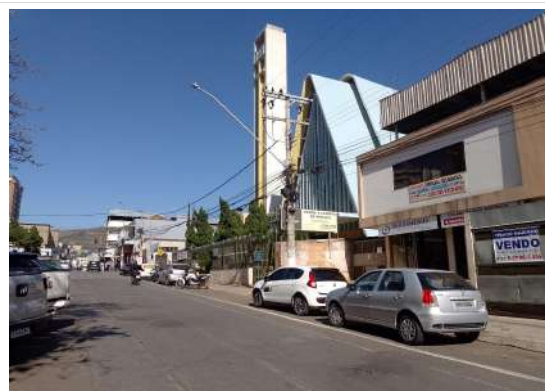
Pará de Minas Santuário Nossa Senhora da Piedade Rua lateral esquerda do bem. (foto 50) Imagem: Vitória Moraes – 18/08/2025
