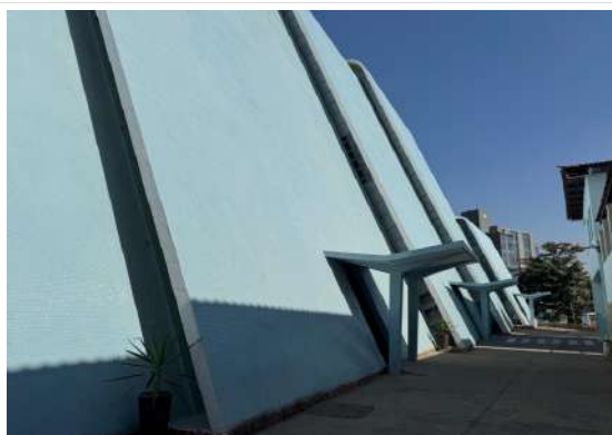
Pará de Minas Santuário Nossa Senhora da Piedade Vista da alvenaria externa. (foto 09) Imagem: Vitória Moraes – 18/08/2025
