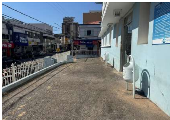
Pará de Minas Irmandade Nossa Senhora da Conceição – Hospital Manta asfáltica na rampa de acesso à entrada principal da maternidade. (foto 29) Imagem: Vitória Moraes – 28/08/2025
