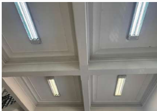
Pará de Minas Fórum Desembargador Pedro Nestor Artesoado no salão de entrada do pavimento térreo. (foto 37) Imagem: Vitória Moraes – 13/08/2025
