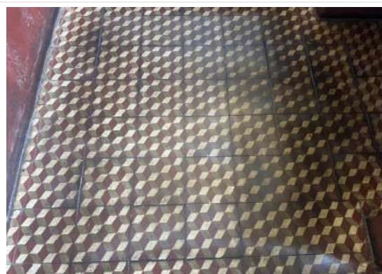
Pará de Minas MUSPAM Antigas cerâmicas do banheiro antigo apresenta rejuntas escurecidas e alguma perda de material. (foto 19) Imagem: Vitória Moraes – 08/08/2025
