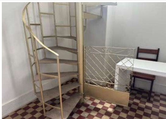
Pará de Minas Igreja Nossa Senhora das Graças Parte dos pisos da escada de acesso ao coro em metal com pisos revestidos por carpete. (foto 29) Imagem: Vitória Moraes – 08/09/2025
