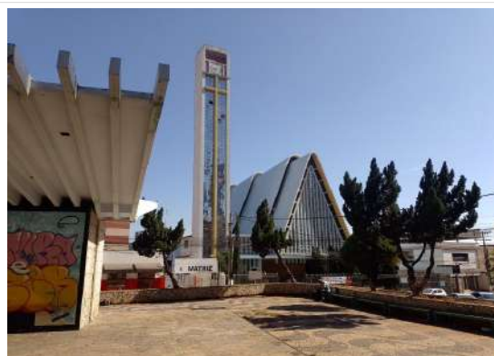
Pará de Minas Santuário Nossa Senhora da Piedade Instalação de proteção contra descargas atmosféricas no alto da torre. (foto 48) Imagem: Vitória Moraes – 18/08/2025
