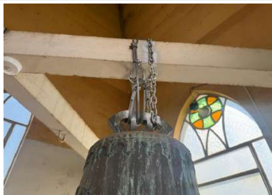
Pará de Minas Igreja Nossa Senhora das Graças Detalhe da fixação dos sinos feita por correntes. (foto 43) Imagem: Vitória Moraes – 08/09/2025
