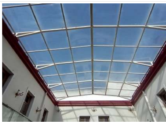
Pará de Minas Prédio Juscelino Kubitschek de Oliveira – Casa da Cultura Cobertura em policarbonato estruturado em perfil metálico. (foto 07) Imagem: Vitória Moraes – 06/08/2025
