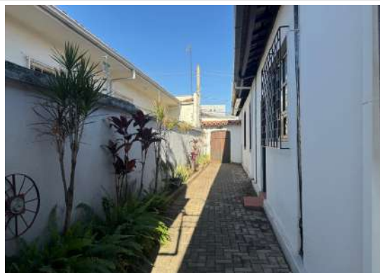
Par  de Minas MUSPAM Fachada lateral esquerda. (foto 03)
