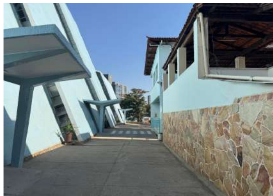
Pará de Minas Santuário Nossa Senhora da Piedade Detalhe da laje entrecortada do santuário. (foto 08) Imagem: Vitória Moraes – 18/08/2025
