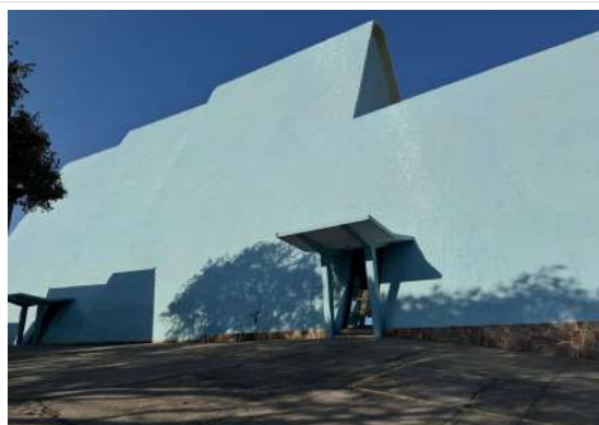
Pará de Minas Santuário Nossa Senhora da Piedade Troca das pastilhas já finalizada. (foto 30) Imagem: Vitória Moraes – 18/08/2025
