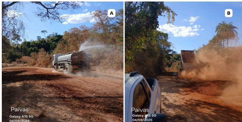
Figura 17 - (A e B): Patrolamento e cascalhamento nas estradas rurais.
